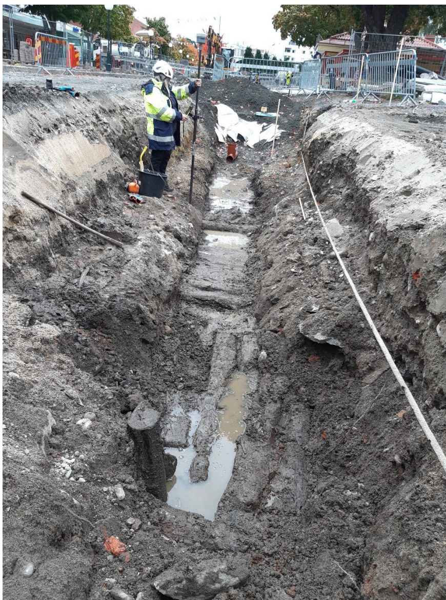
Figur 11. Rustbädden framrensad i OS1030. Schaktet fylldes snabbt med vatten då det var mycket blött i marken. Längst ner i bild är den stående stocken som samlades in för dendrokronologisk analys.
