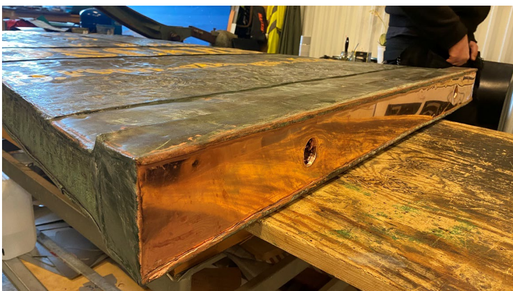
Figur 12. Träarbetena är färdigställda och plättäckningen har falsats och lösts ihop. Understycket har fått en helt ny kopparplåt. Foto: Ulrika Olsson, 2023-03-17.
