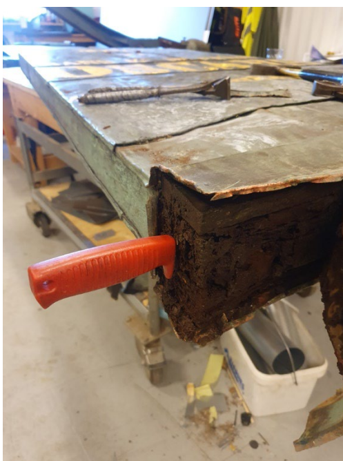
Figur 9. Minnestavlan är inne på verkstad och dess nedre del har öppnats upp. Bottenstycket är rötskadat. Foto: Henrik Lingman, mars 2023.
