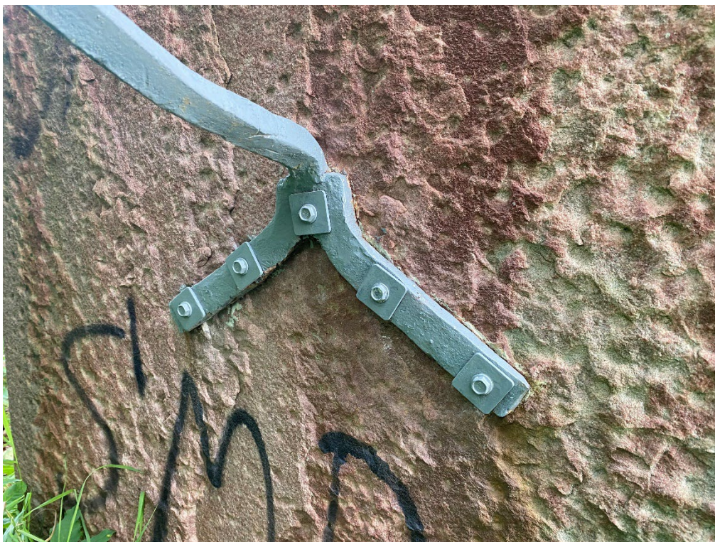
Figur 18. Minnestavlan är återmonterad på fundamentet. Smidesjärnet på baksidan har fått nya infästningar i stenen. De tidigare hålen är tätade med Ankarsmassa innan de nya rostfria skruvarna har dragits i. Foto: Ulrika Olsson, 2023-09-26.
