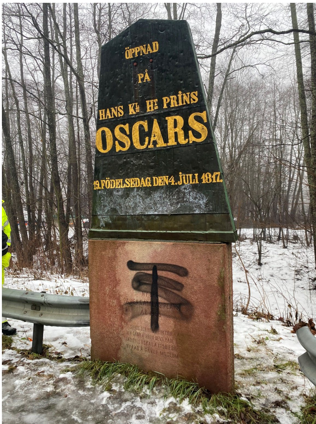
Figur 7. Minnestavlan hade också skador i form av skotthål från luftpistol eller liknande. Fundamentets framsida var klottrad. Foto: Ulrika Olsson, 2023-01-09.
