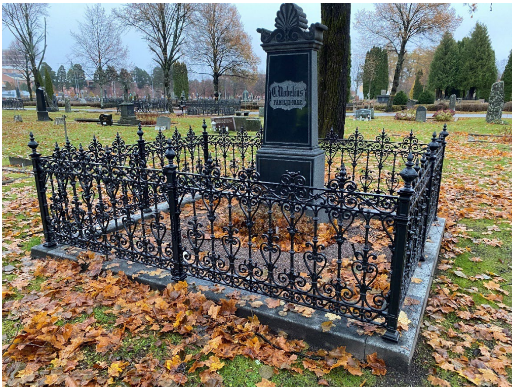
Figur 24. GK06 0177 efter åtgärd. Stensockeln har riktats och gjutjärnsstaketet har renoverats. Foto: Ulrika Olsson, 2023-11-07.
