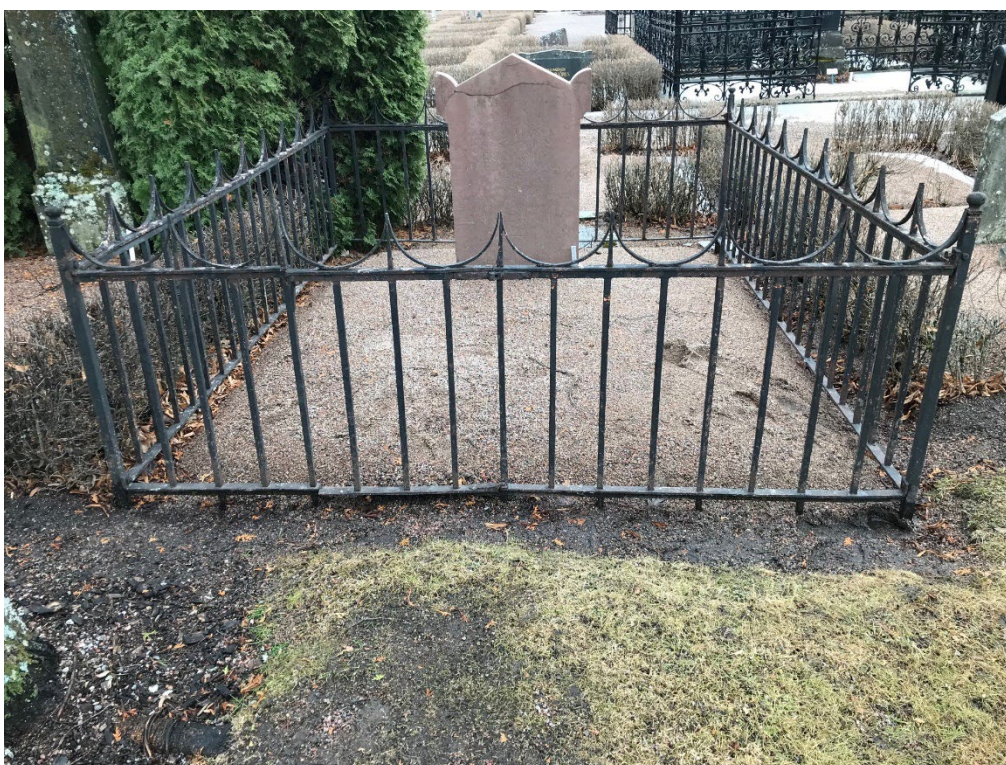
Figur 5. GK03 0075 före åtgärd. Smidesstaket i behov av renovering. Stensockel i behov av riktning. Foto: Pirab, våren 2023.
