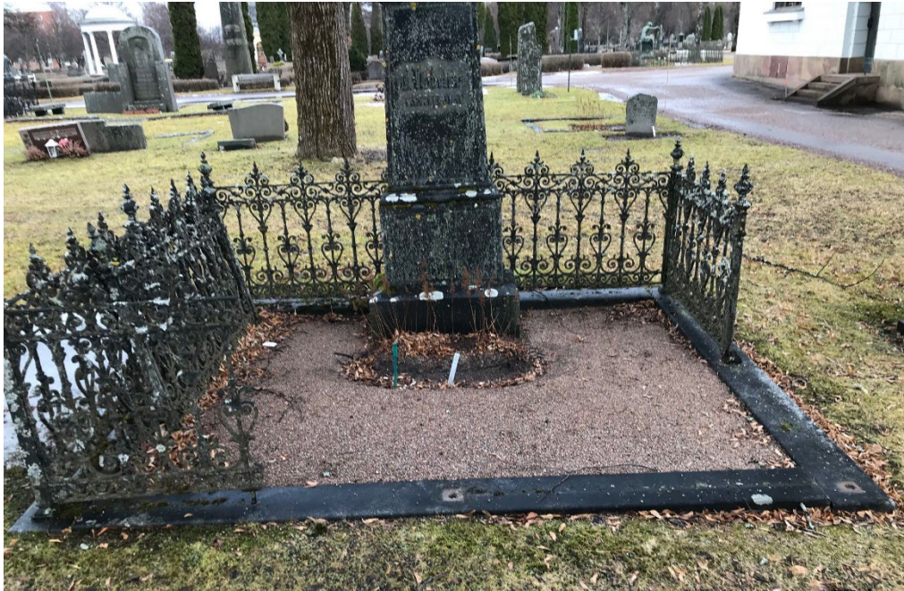
Figur 23. GK06 0177 före åtgärd. Gjutjärnsstaket i behov av renovering. Staketet var i flera olika delar. Samtliga sektioner fanns kvar, men vissa detaljer saknades. Stensockel i behov av riktning. Foto: Pirab, våren 2023.
