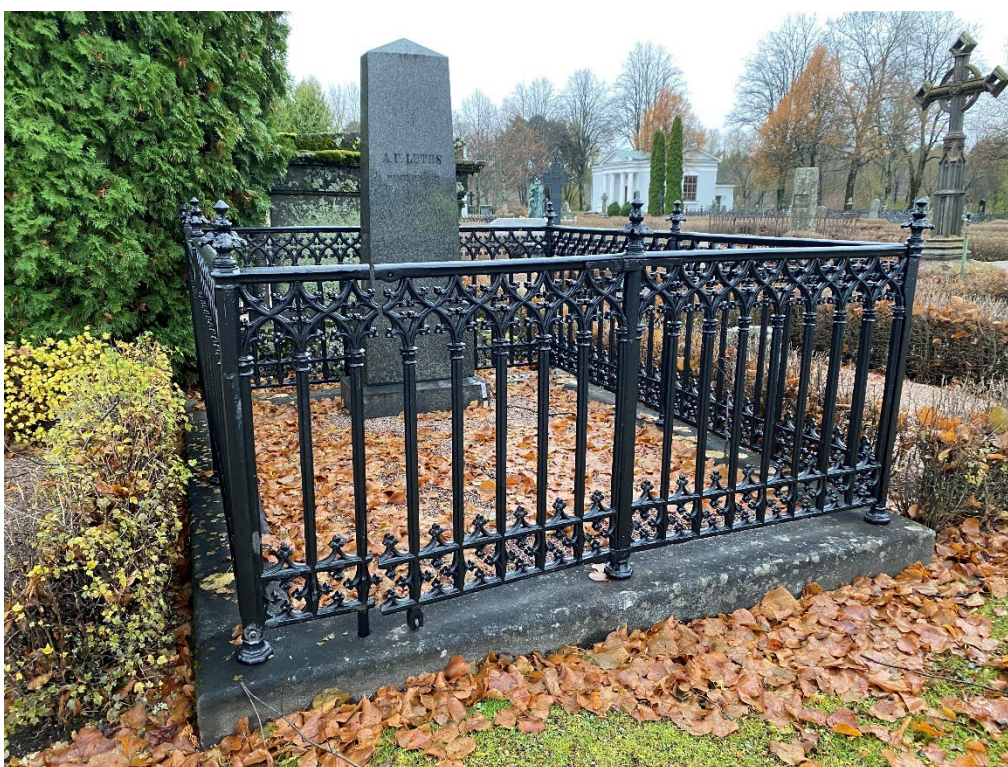
Figur 11. K5 007 efter åtgärd. Stensockeln har riktats och gjutjärnsstaketet har renoverats. Foto: Ulrika Olsson, 2023-11-07.
