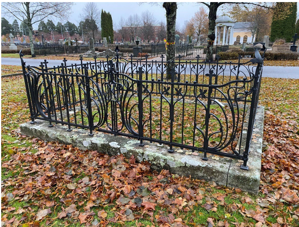
Figur 21. GK06 0061 efter åtgärd. Stensockeln har riktats och smidesstaketet har renoverats. Foto: Ulrika Olsson, 2023-11-07.
