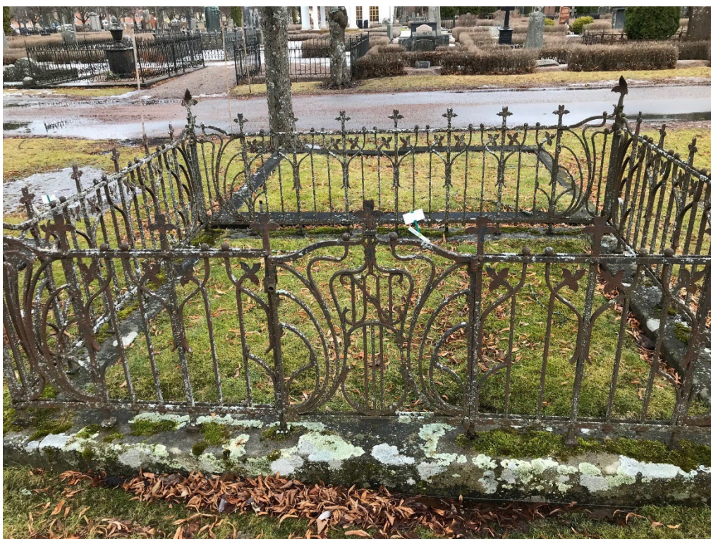
Figur 20. GK06 0061 före åtgärd. Smidesstaket i behov av renovering. Stensockel i behov av riktning. Foto: Pirab, våren 2023.
