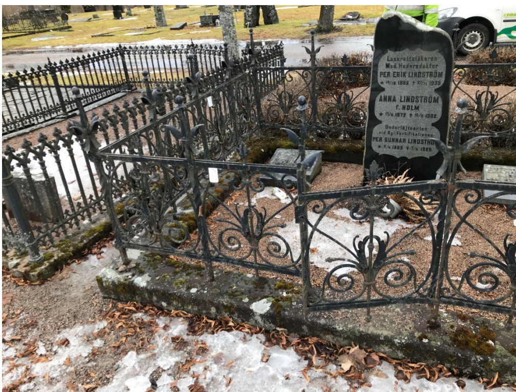
Figur 13. GK05 0124 före åtgärd. Smidesstaket i behov av renovering. Stensockel i behov av riktning. Foto: Pirab, våren 2023.
