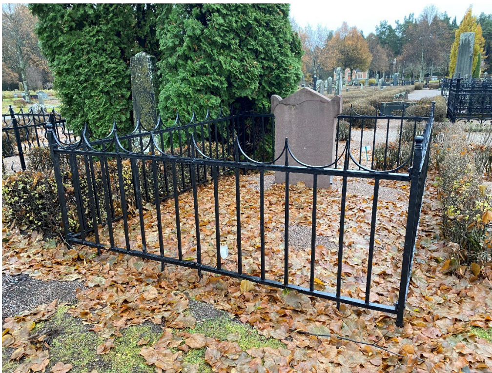
Figur 6. GK03 0075 efter åtgärd. Stensockeln har riktats och smidesstaketet har renoverats. Foto: Ulrika Olsson, 2023-11-07.
