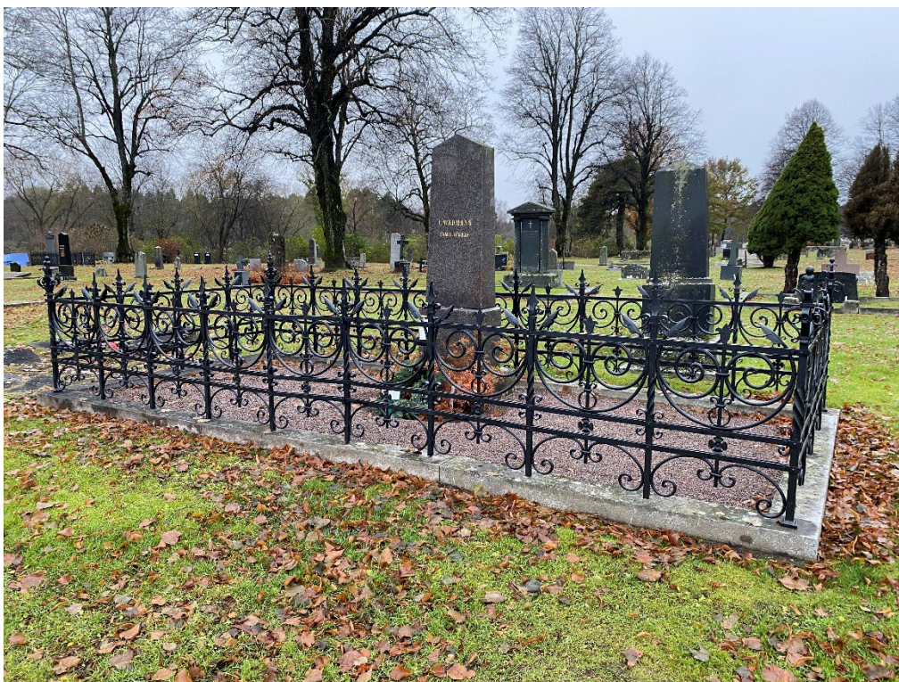
Figur 18. GK06 0038–0039 efter åtgärd. Stensockeln har riktats och smidesstaketet har renoverats. Gravplatsens ursprungliga markbeläggning med grus har återskapats. Foto: Ulrika Olsson, 2023-11-07.
