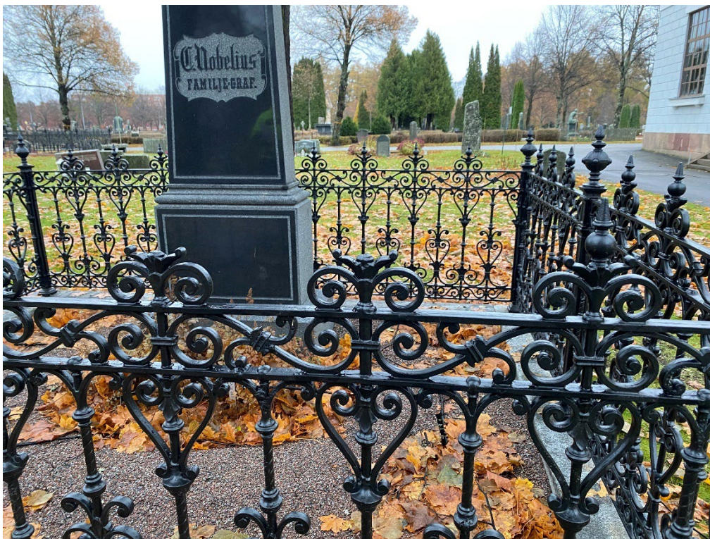
Figur 25. GK06 0177 efter åtgärd. Dekorationer som saknades sedan tidigare har inte rekonstruerats utan lämnats utan åtgärd. Foto: Ulrika Olsson, 2023-11-07.
