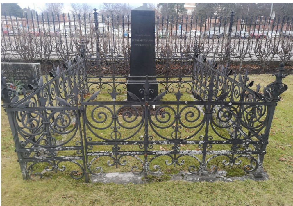
Figur 7. GK03 0096 före åtgärd. Smidesstaket i behov av renovering. Stensockel i behov av riktning. Gravens ursprungliga grusbeläggning har med tiden övergått till gräs. Foto: Kyrkogårdsenheten, Gävle församling, våren 2023.
