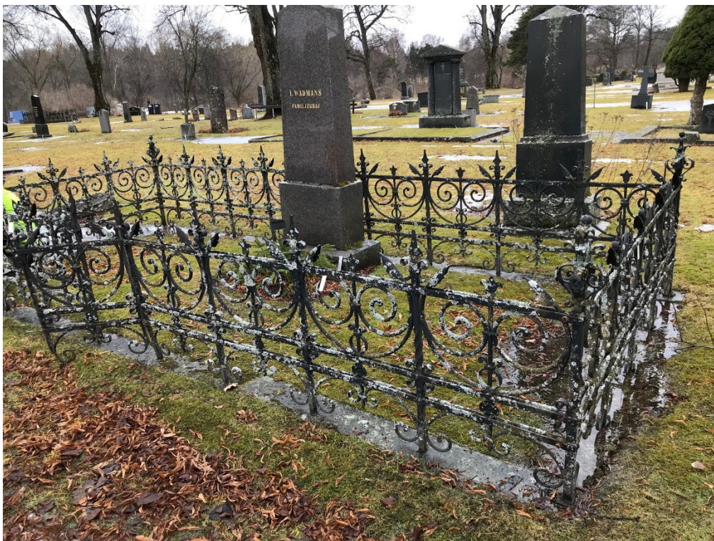
Figur 17. GK06 0038–0039 före åtgärd. Smidesstaket i behov av renovering. Stensockel i behov av riktning. Gravens ursprungliga grusbeläggning har med tiden övergått till gräs. Foto: Pirab, våren 2023.
