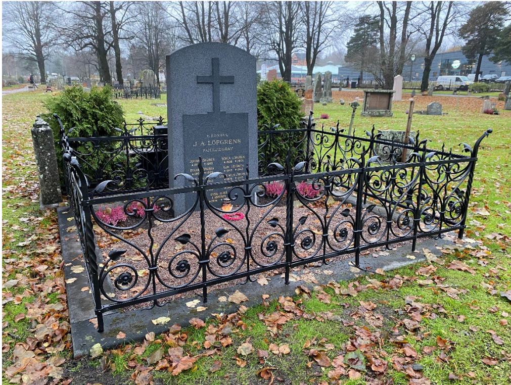
Figur 29. GK06 0323 efter åtgärd. Stensockeln har riktats och smidesstaketet har renoverats. Gravplatsens ursprungliga markbeläggning med grus har återskapats. Foto: Ulrika Olsson, 2023-11-07.
