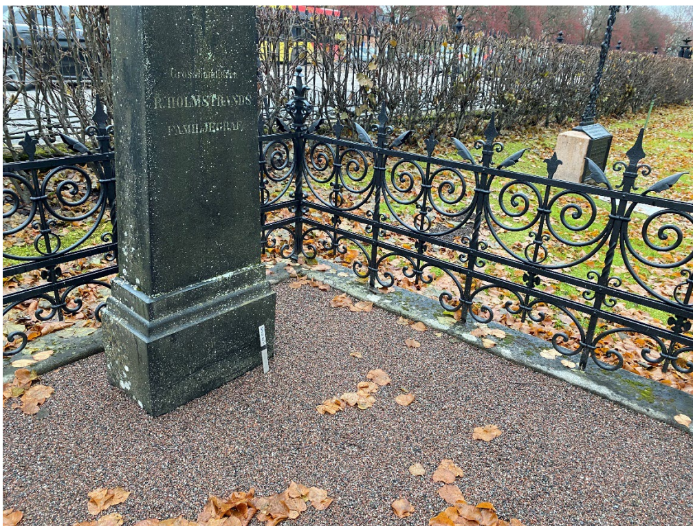
Figur 9. GK03 0096 efter åtgärd. Stensockelns kramlingar ligger dolda under gruset. Foto: Ulrika Olsson, 2023-11-07.
