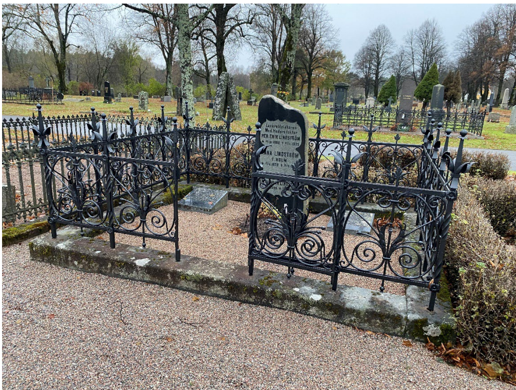
Figur 15. GK05 0124 efter åtgärd. Stensockeln har riktats och smidesstaketet har renoverats. Foto: Ulrika Olsson, 2023-11-07.
