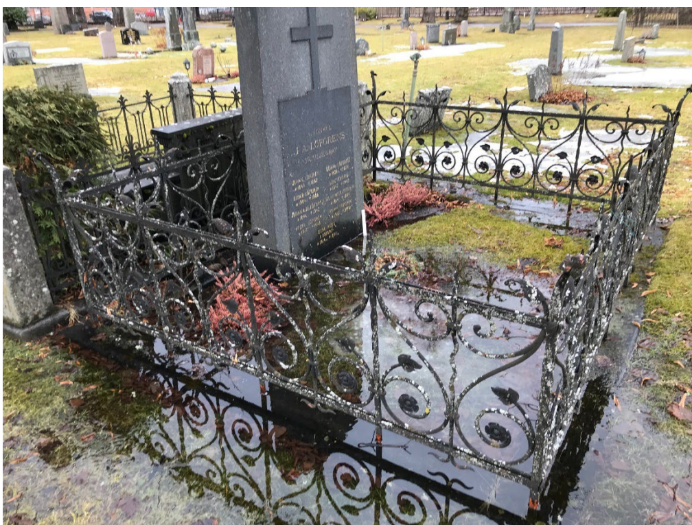
Figur 28. GK06 0323 före åtgärd. Smidesstaketet i behov av renovering. Stensockel i behov av riktning. Gravens ursprungliga grusbeklägning har med tiden övergått till gräs. Foto: Pirab, våren 2023.
