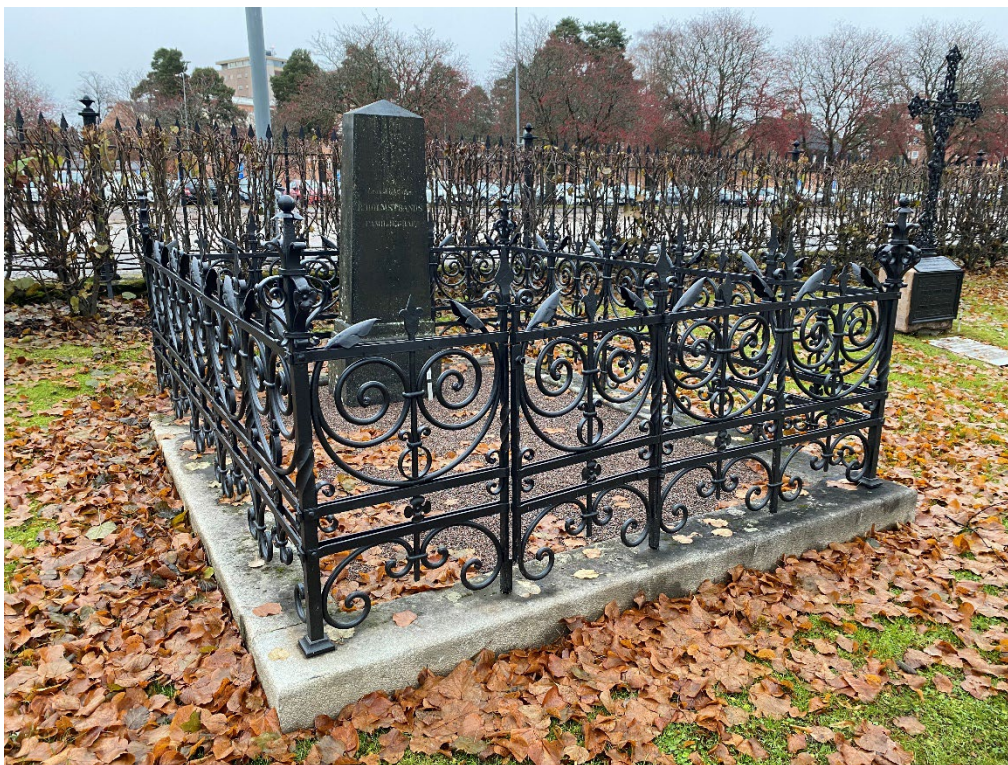
Figur 8. GK03 0096 efter åtgärd. Stensockeln har riktats och smidesstaketet har renoverats. Gravplatsens ursprungliga markbeläggning med grus har återskapats. Foto: Ulrika Olsson, 2023-11-07.
