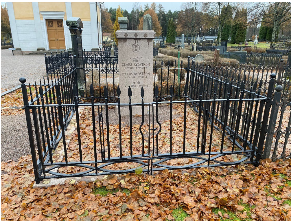
Figur 4. GK03 0070 efter åtgärd. Stensockeln har riktats och smidesstaketet har renoverats. Foto: Ulrika Olsson, 2023-11-07.
