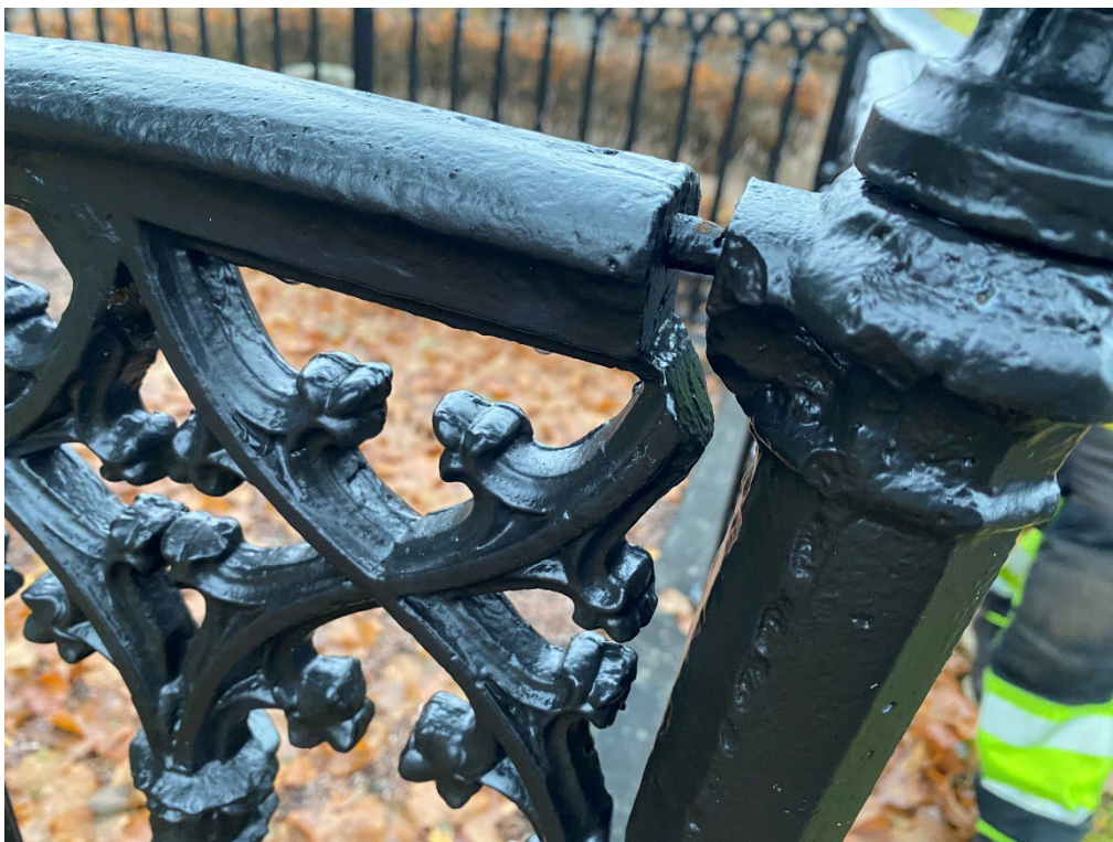
Figur 12. K5 007 efter åtgärd. Närbild på gjutjärnsstaketets konstruktion. Sidostyckena sitter förankrade i fram- och bakstycke endast genom stift. Foto: Ulrika Olsson, 2023-11-07.
