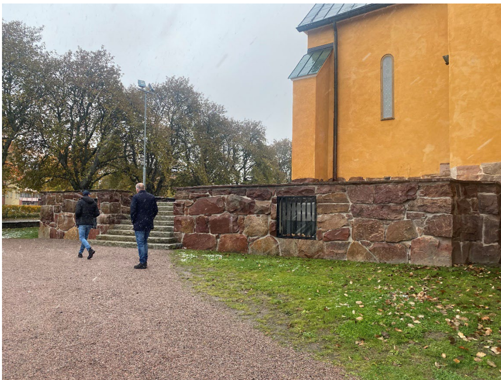
Figur 20. Muren söder om koret. Denna mur var åtgärdad sedan tidigare men saknade ännu några lock. Dessa har åtgärdats inom denna etapp. Foto: Ulrika Olsson, 2023-10-19.
