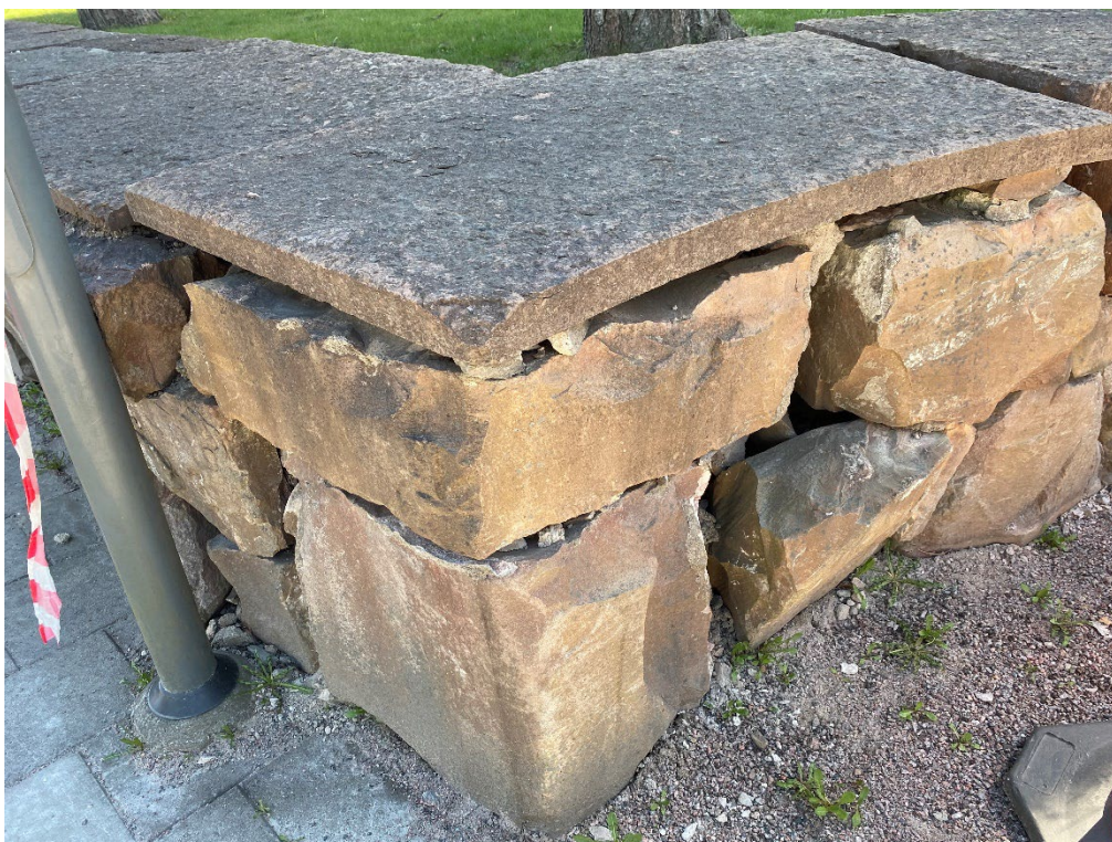
Figur 6. Innan påbörjade arbeten. Urlakad fog, kalvade stenar och avsaknad av skolsten i muröppningen mot norr. Foto: Ulrika Olsson, 2023-05-11.
