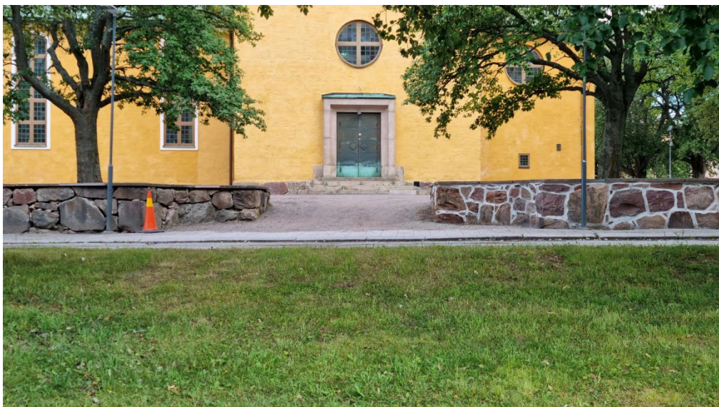
Figur 14. Under pågående arbeten. Foto från norr. Fogningen är färdig på den högra muren. Den vänstra muren är åtgärdad så när som på fogningen. Foto: Robert Edman, 2023-07-05.
