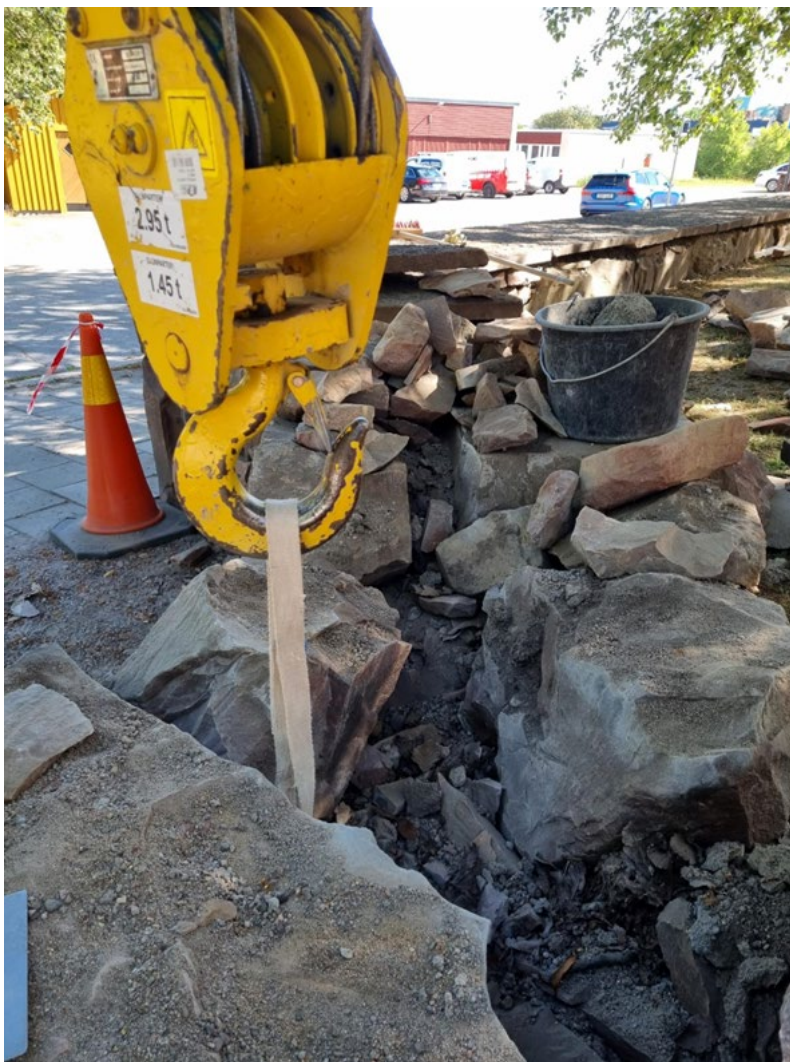
Figur 12. Under pågående arbeten. Muren kring öppningen mot norr var i mycket dåligt skick och har till största del lagts om. Foto: Robert Edman, 2023-06-26.
