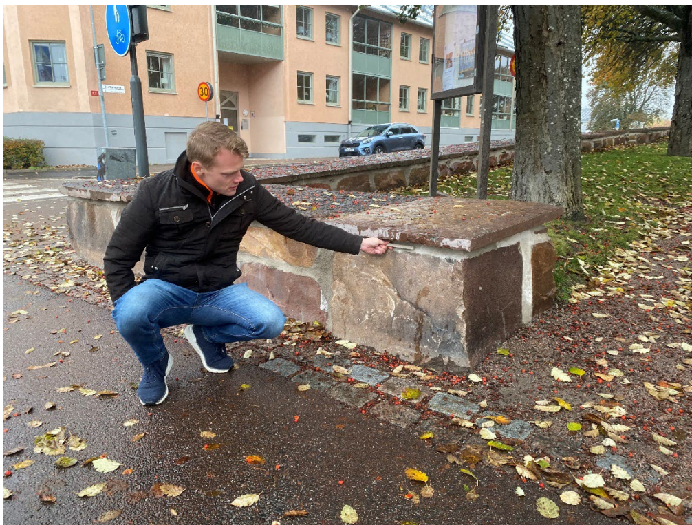
Figur 18. Den sydvästra muren vid slutbesiktningen. Robert Edman, KFSAB, jämför kulörstickan med fogarna. Foto: Ulrika Olsson, 2023-10-19.
