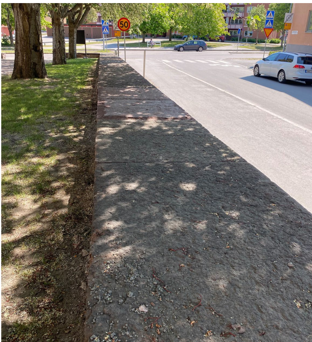
Figur 15. Under pågående arbeten. Åtgärdad mur mot väster. De nya bällarna är lite ljusare/rödare än de gamla. Fogningen är ännu inte utförd här. Foto: Ulrika Olsson, 2023-07-06.
