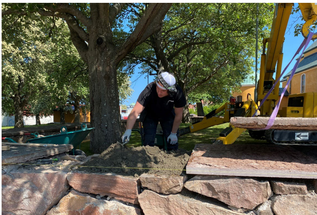
Figur 10. Under pågående arbeten med att återställa locken. Dessa läggs i läggbruk. På bilden syns David Deutsch från Belfor. Foto: Ulrika Olsson, 2023-06-07.
