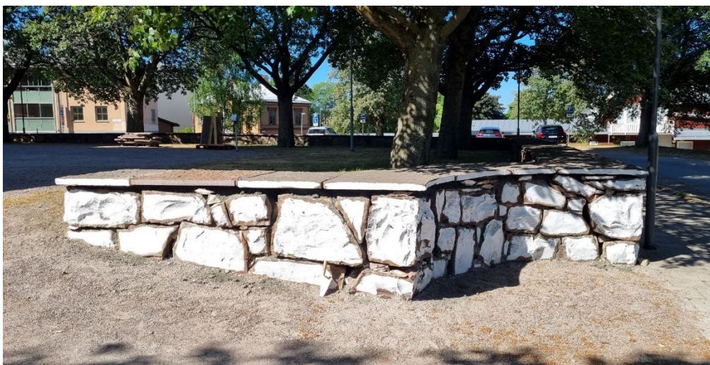
Figur 13. Under pågående arbeten. En liten mursträcka i sydvästra hörnet står inför fogning. Stenarna har strukits med krita för att fogen inte ska fastna på dem. Efter fogningen spolats krittstrykningen bort. Foto: Robert Edman, 2023-06-26.
