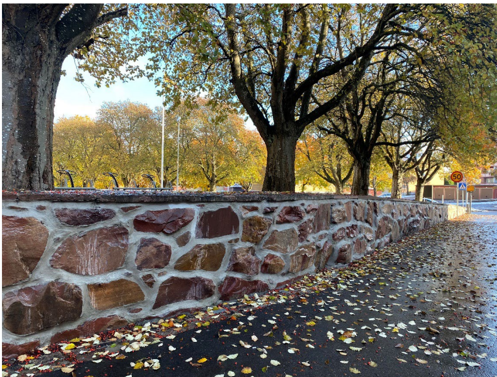
Figur 16. Den västra muren vid slutbesiktningen. Här är fogarna fuktiga efter ett regn och upplevs därför något mörka. Foto: Ulrika Olsson, 2023-10-19.
