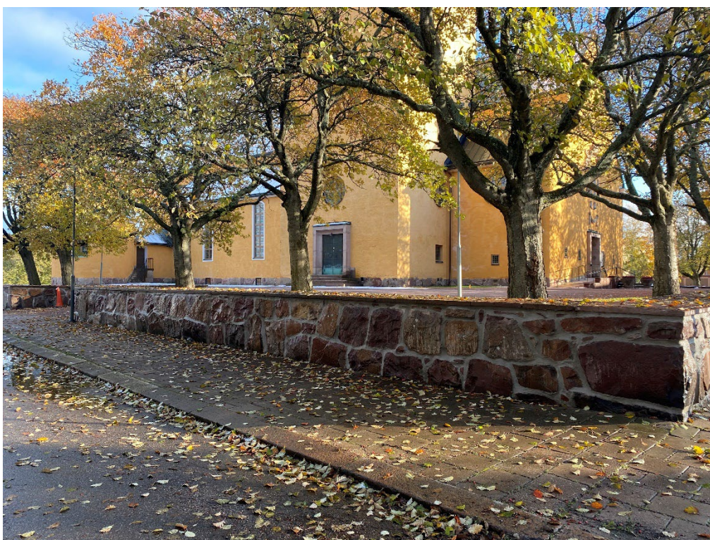
Figur 17. Den norra muren vid slutbesiktningen. Här har muren rätats upp och locken ligger i en rak linje. Foto: Ulrika Olsson, 2023-10-19.
