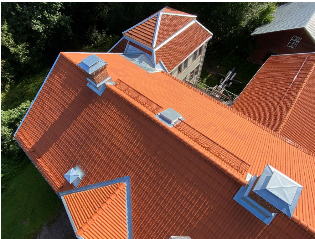
Figur 24. Slutbesiktning av takarbetena från skylift. Närmast i bild syns huvudbyggnadens tak, högst upp i bild den nordöstra flygelns tak och till höger taket på flygeln utmed Korsikanvägen. Foto: Ulrika Olsson, 2023-08-31.
