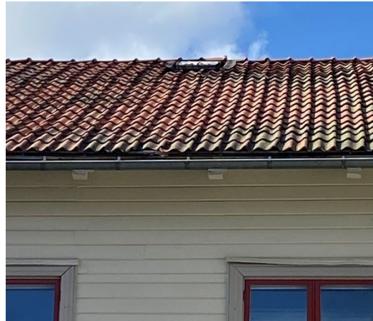
Figur 2 och 3. Stora byggnadskroppens västra takfall 2022-04-12. Teglet hade hamnat ur läge och flera takpannor var söndervittrade. Läckage fanns vid ventilationsbuven och takfönstret. Foto: Ulrika Olsson, 2022-04-12.
