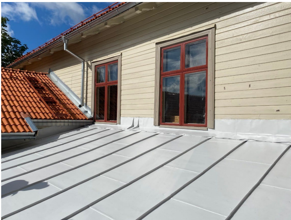
Figur 12. Här syns det norra takfallet på flygeln utmed Korsikavägen. Notera takstegen som leder upp till nockrället. Foto: Ulrika Olsson, 2023-08-31.
