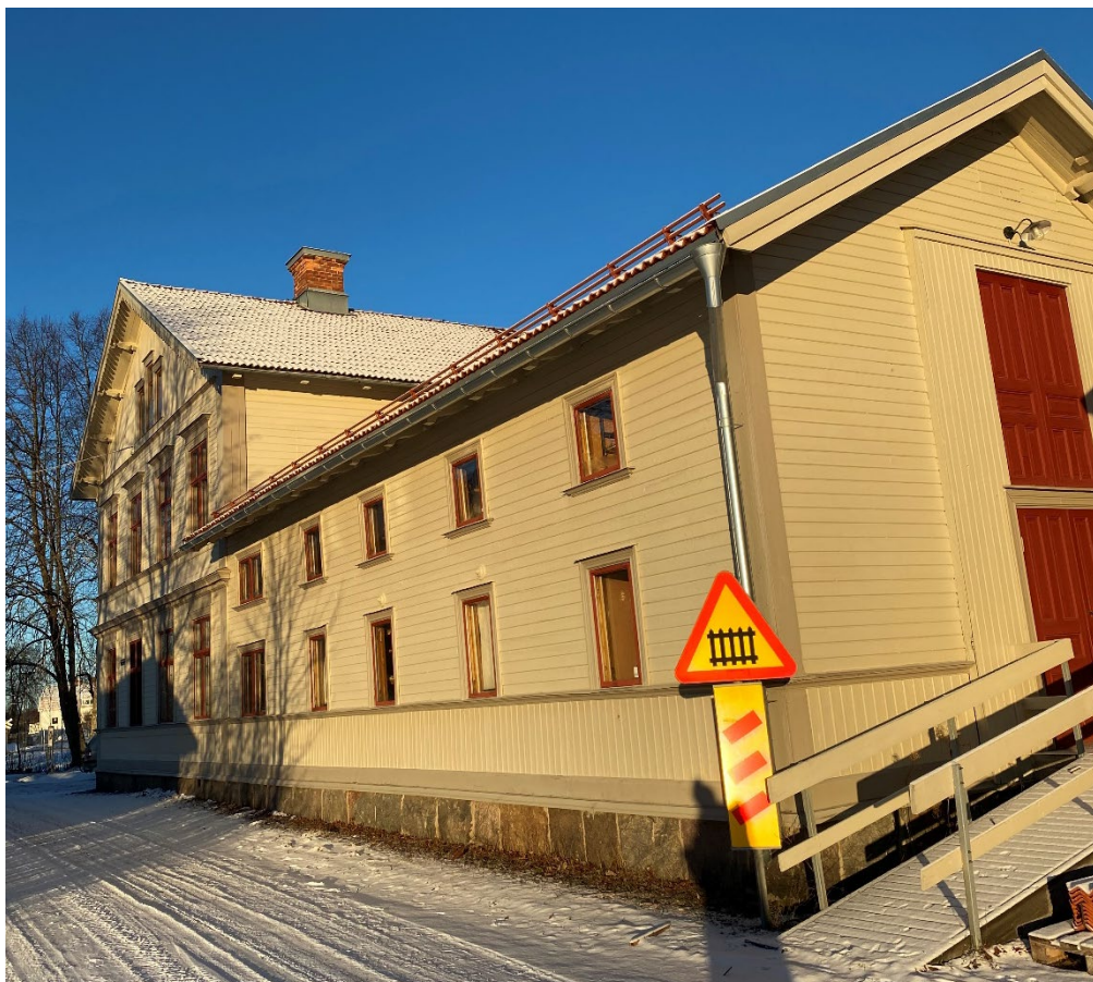
Figur 10. Slutbesiktning av takarbetena på flygeln utmed Korsikavägen. Taket har lagts om med nytt tvåkupigt lertegel från Monier och försetts med nya vindskivebeslag, hängrännor och stuprör i zinkmagnesium. Snörasskydden är återanvända. Foto: 2023-01-03.
