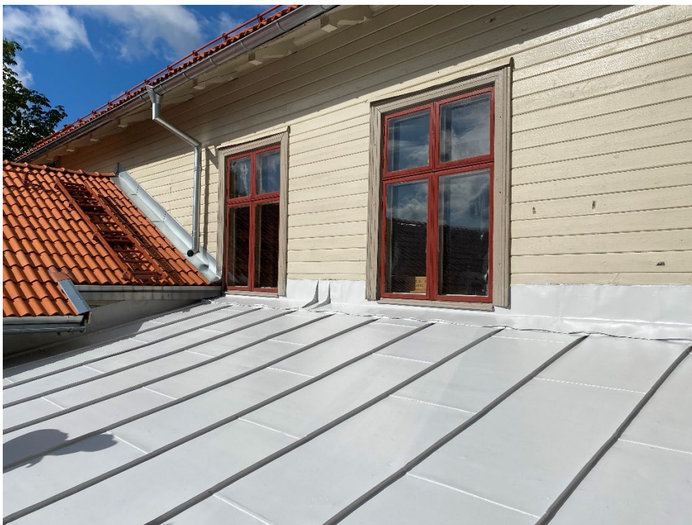
Figur 28. Pulpettaket som binder samman de båda flyglarna. Plåten är målad i kulör zinkgrå. Foto: Ulrika Olsson, 2023-08-31.
