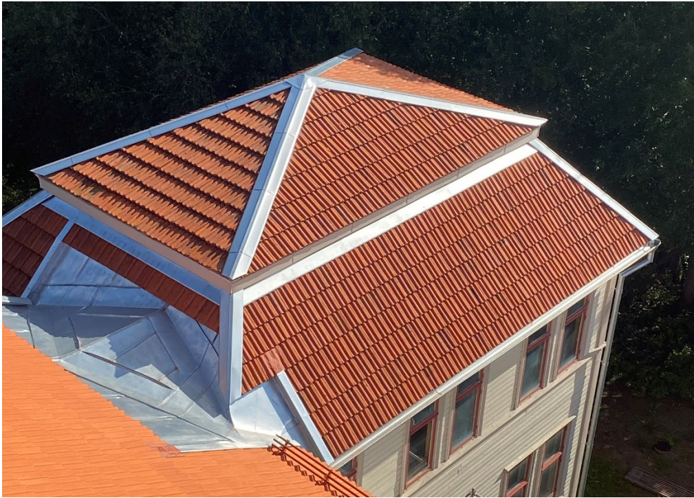
Figur 25. Rengjorda takpannor räckte till alla takfall utom det nedre takfallet på baksidan. Nockplåtar liksom plättäckningen mellan flygeln och huvudbyggnaden är utförda i zinkmagnesium. Foto: Ulrika Olsson, 2023-08-31.
