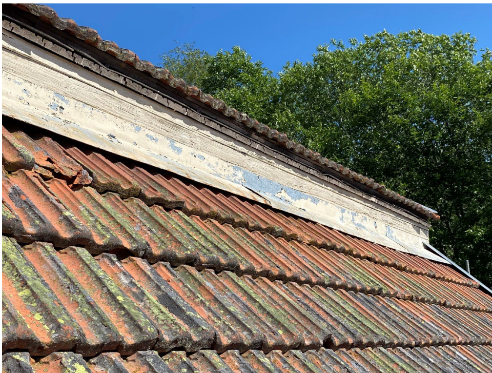
Figur 5. Den nordöstra flygelns takfall med pressat tegel tillverkat på Nyrönninges tegelbruk i Stornik. Ytan som förenar de båda takfallen var panelklädd. Ett plåtbeslag var uppdraget mot panelen. Foto: Ulrika Olsson, 2023-06-12.
