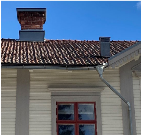
Figur 2 och 3. Stora byggnadskroppens västra takfall 2022-04-12. Teglet hade hamnat ur läge och flera takpannor var söndervittrade. Läckage fanns vid ventilationsbuven och takfönstret. Foto: Ulrika Olsson, 2022-04-12.
