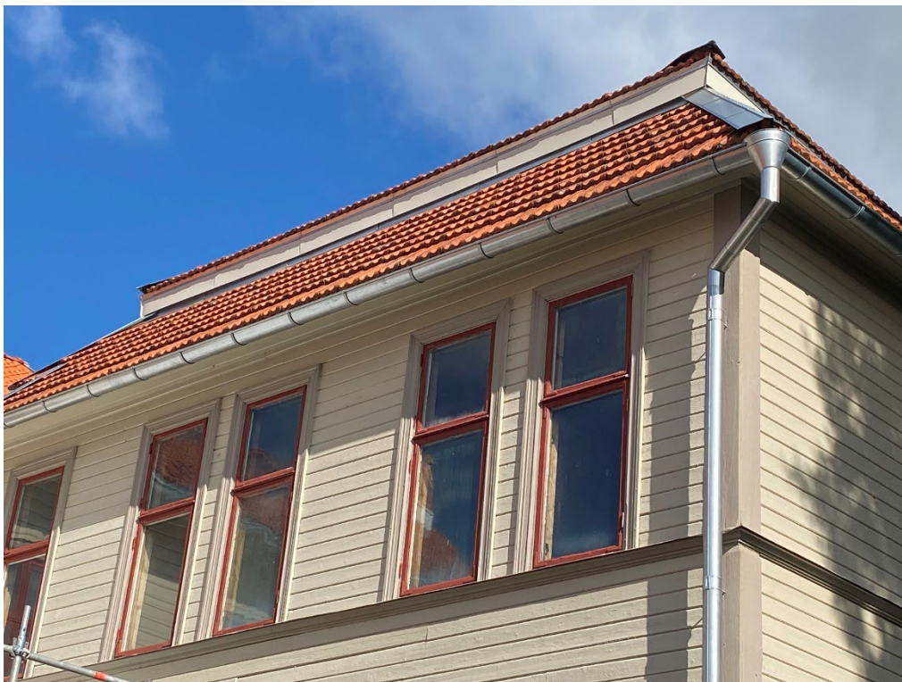
Figur 26. Panelen mellan de båda taken har klätts in med falsad plåt som är målad i samma kulör som panelen tidigare hade. Foto: Ulrika Olsson, 2023-08-31.
