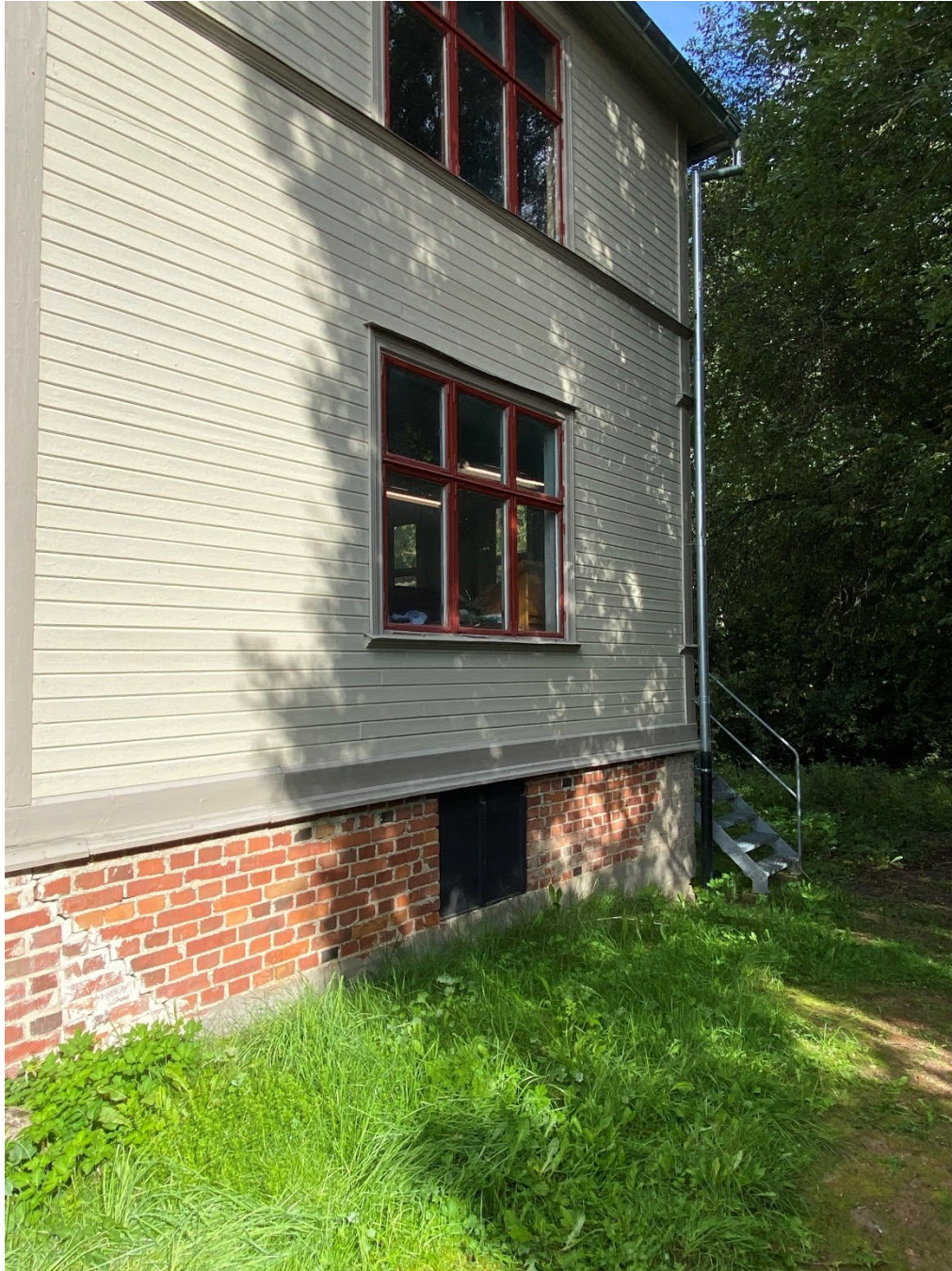
Figur 30. Den östra gaveln på den nordöstra flygeln. Här syns ett av stuprören som är anslutna till markrör. Foto: Ulrika Olsson, 2023-08-31.
