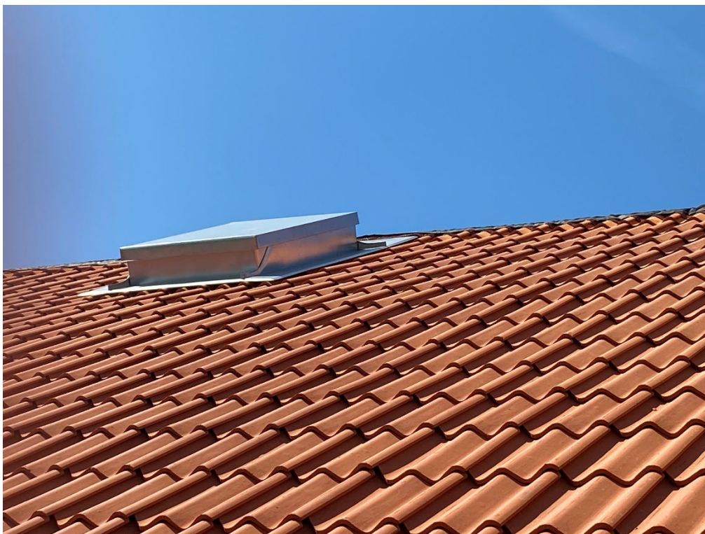
Figur 20. Tidigare fanns på det östra takfallet ett litet takfönster. Detta har nu ersatts med en taklucka i godkända mått. Vid fototillfället har takbryggan ännu inte monterats. Foto: Ulrika Olsson, 2023-06-12.
