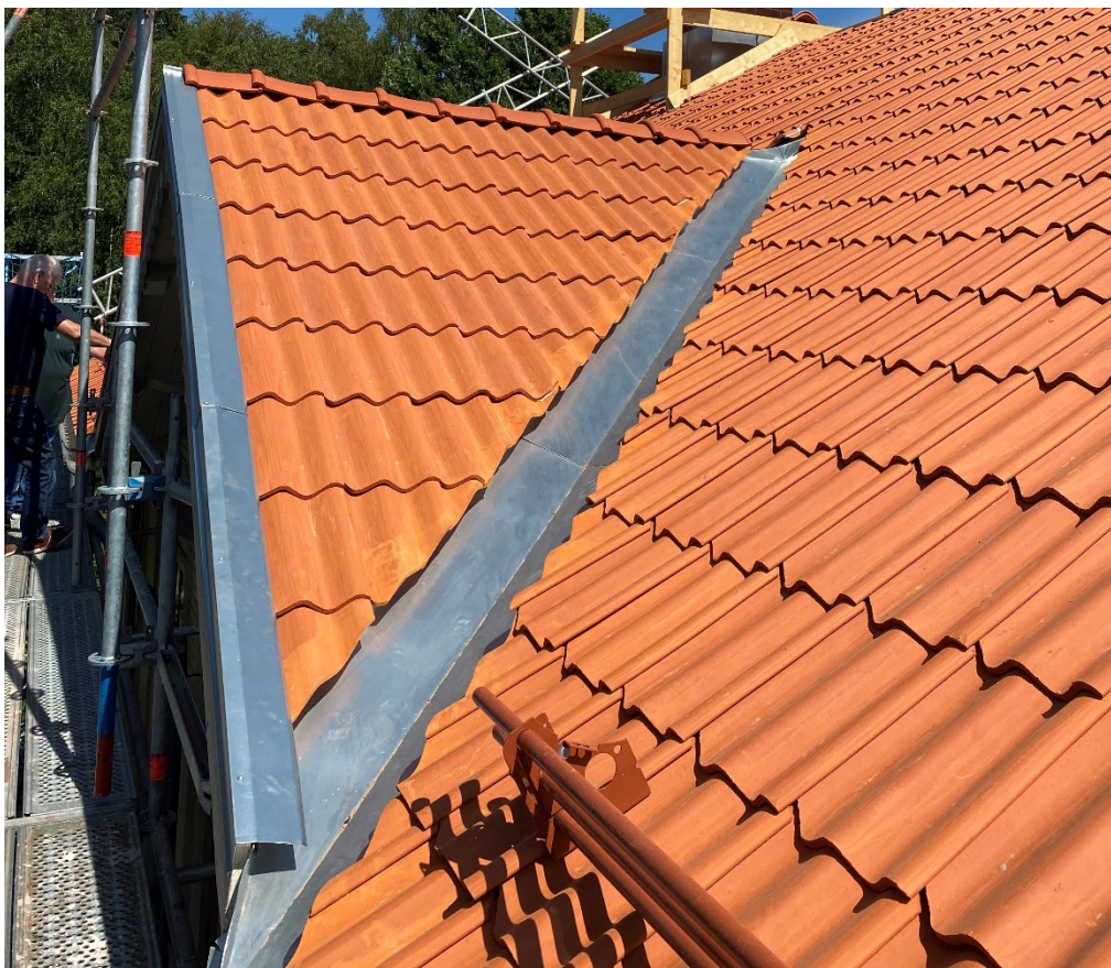
Figur 22. Rännदार och vindskivebeslag är i zinkmagnesium. Foto: Urika Olsson, 2023-06-12.
