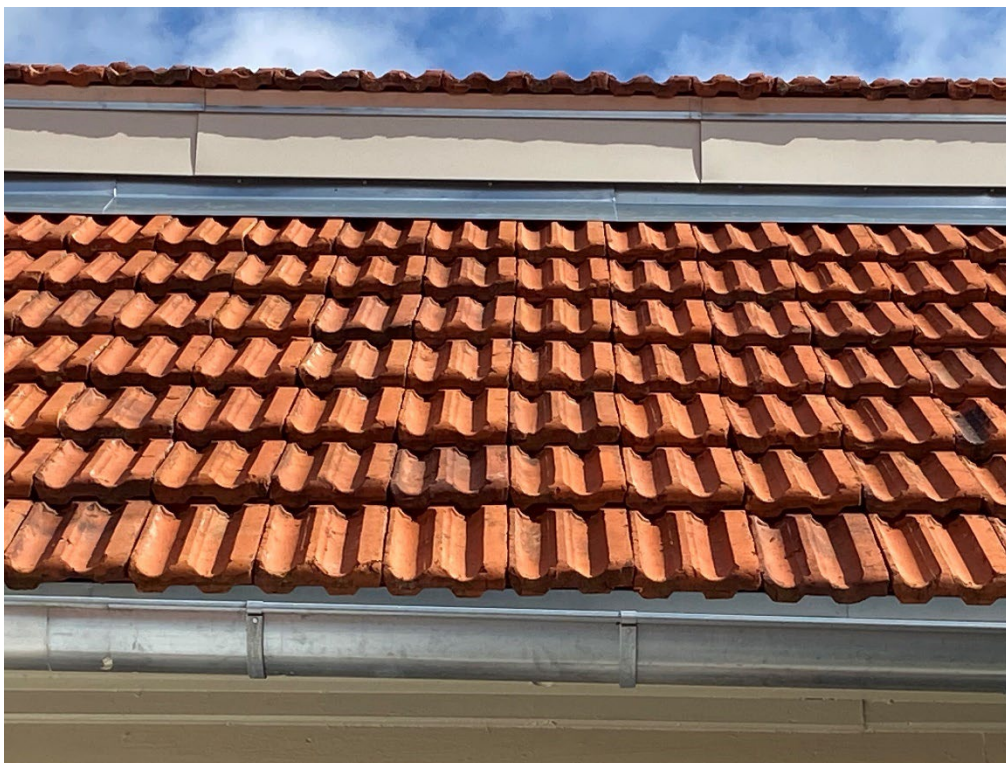
Figur 27. Närbild på rengjort pressat taktegel samt på plåtinklädnaden mellan de båda takfallen. Foto: Ulrika Olsson, 2023-08-31.
