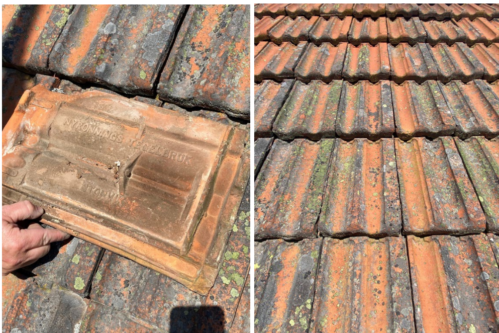
Figur 6 och 7. Närbilder på det pressade takteglet på den nordöstra flygeln. Foto: Ulrika Olsson, 2023-06-12.
