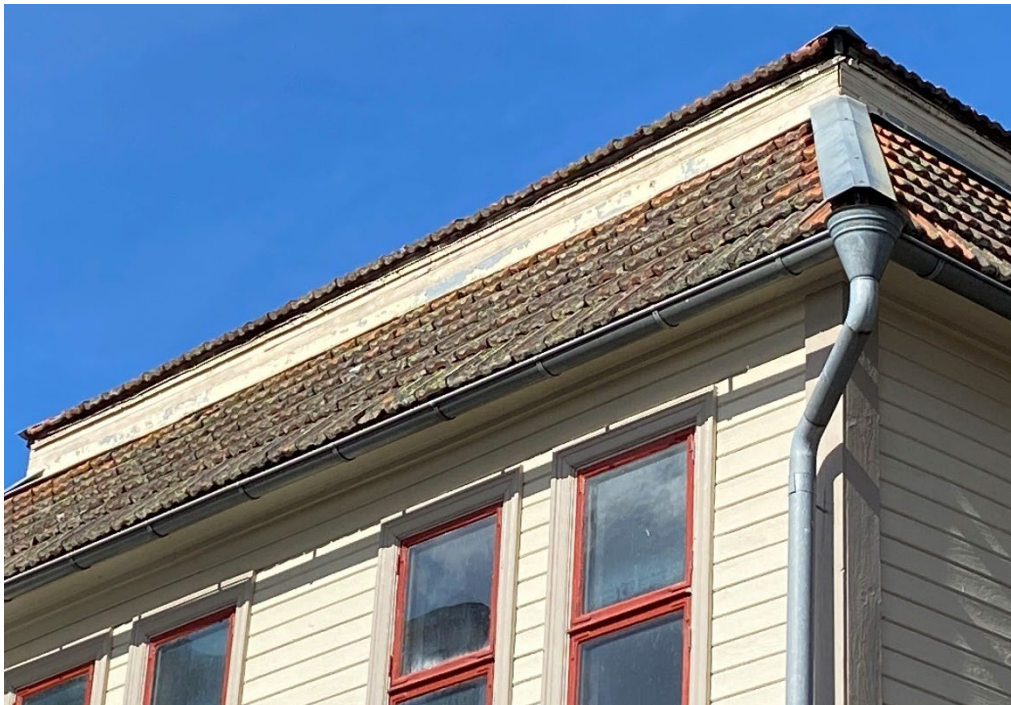
Figur 4. Den nordöstra flygelns tak är klätt med pressat tegel tillverkat på Nyrönningss tegelbruk i Storvik. Foto: Ulrika Olsson, 2022-10-18.
