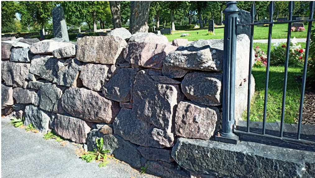
Figur 18. Bogårdsmuren kring Hedesunda kyrka är uppbyggd av röd granit, vilket är samma bergart som finns på Kittilberget. Foto från väster: Inga Blennå.
