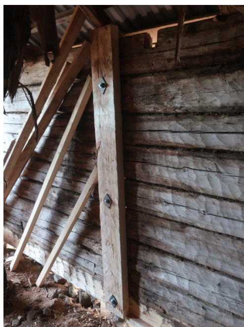
Figur 21. Den vertikala följaren på insidan av vagnsbodens nordvästra fasad. Foto: Daniel Olsson 2022-10-18.
