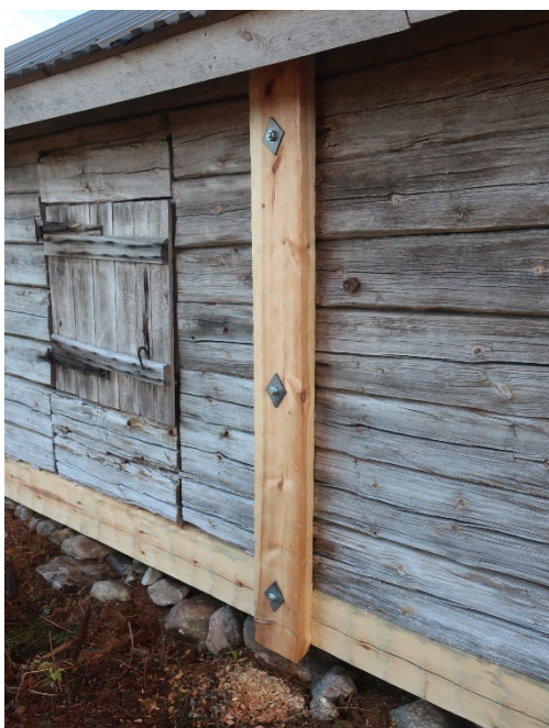
Figur 20. Den vertikala följaren på utsidan av vagnsbodens nordvästra fasad. Foto: Daniel Olsson 2022-10-18.
