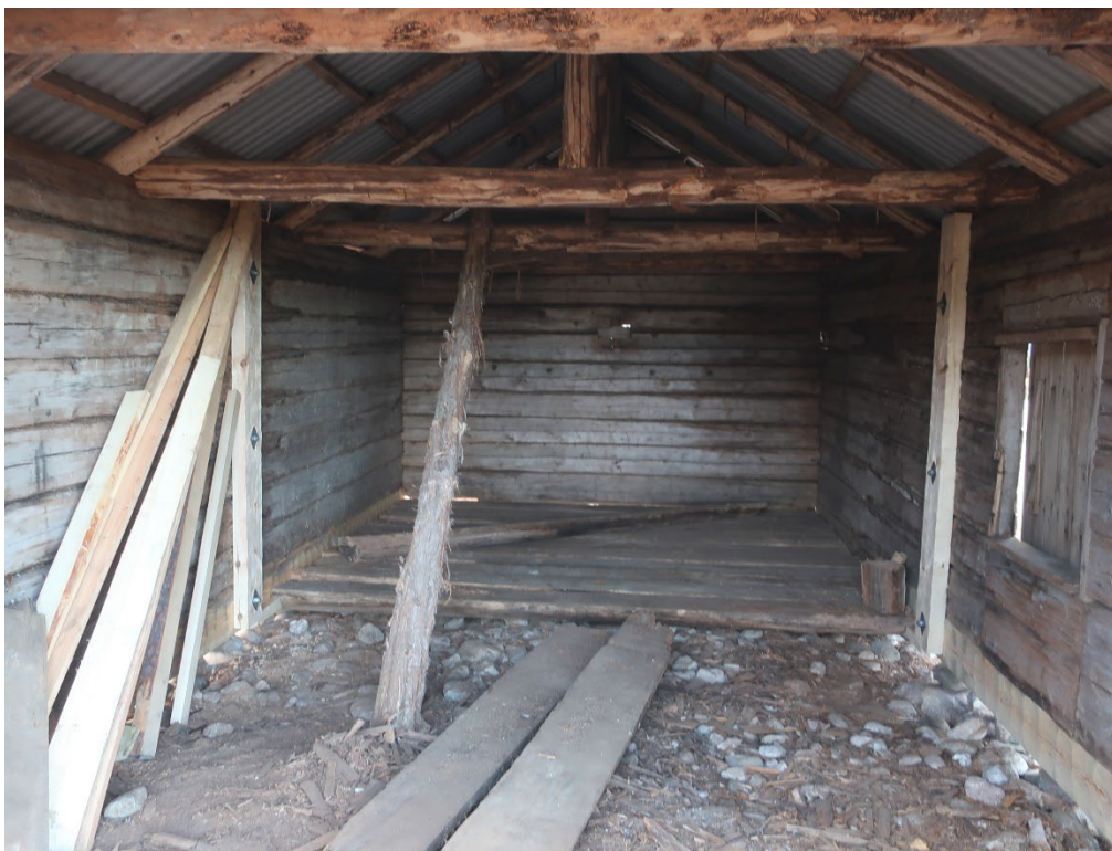
Figur 22. Vagnsbodens interiör från nordöst efter återläggning av trägolvet. Foto: Daniel Olsson 2022-10-18.
