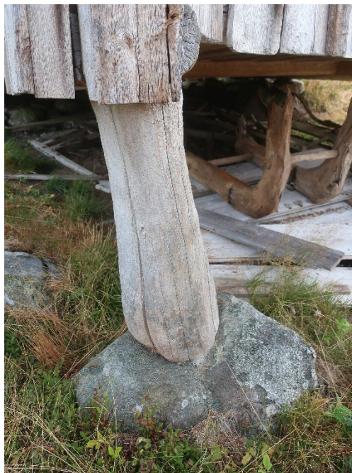
Figur 10. Detalj av lutande grundsten och lutande trästolpe under härbrets västra knut. Foto: Daniel Olsson 2022-08-31.
