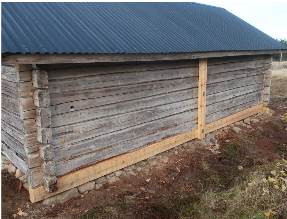
Figur 19. Vagnsbodens nordvästra fasad efter avslutad renovering. Foto: Daniel Olsson 2022-10-18.
