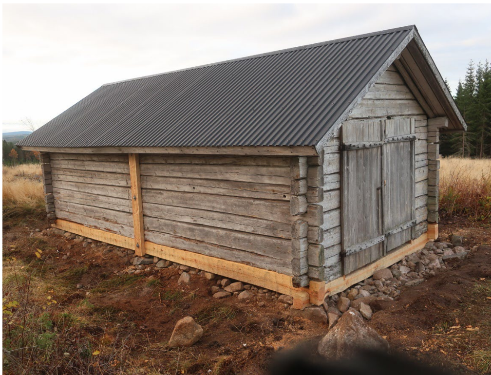
Figur 18. Vagnsboden från öster efter avslutad renovering. Foto: Daniel Olsson 2022-10-18.
