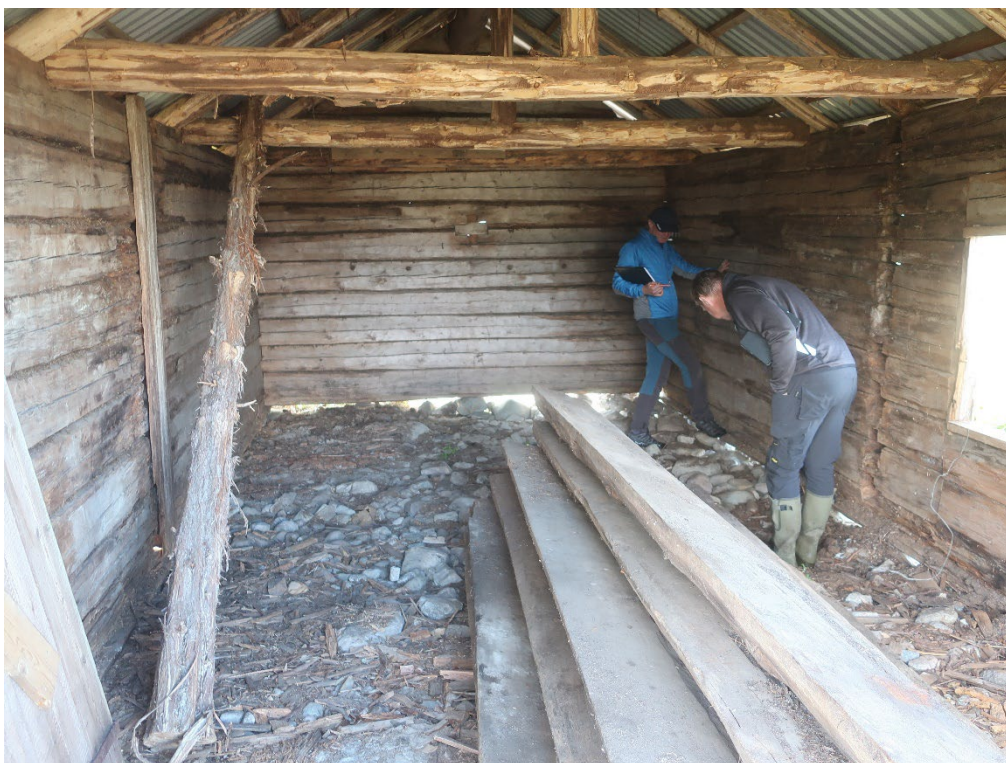
Figur 8. Vagnsbodens interiör från nordöst efter att de bevarade golvbrädorna lagts ihop i en trave. Lars Olofsson och Martin Karlsson undersöker ansamlingen av stenar på marken i den inre delen av byggnaden. Foto: Daniel Olsson 2022-08-31.
