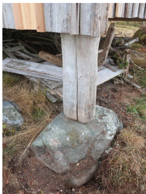
Figur 17. Stolpen och grundstenen under härbrets västra hörn efter avslutad renovering. Foto: Daniel Olsson 2022-10-18.
