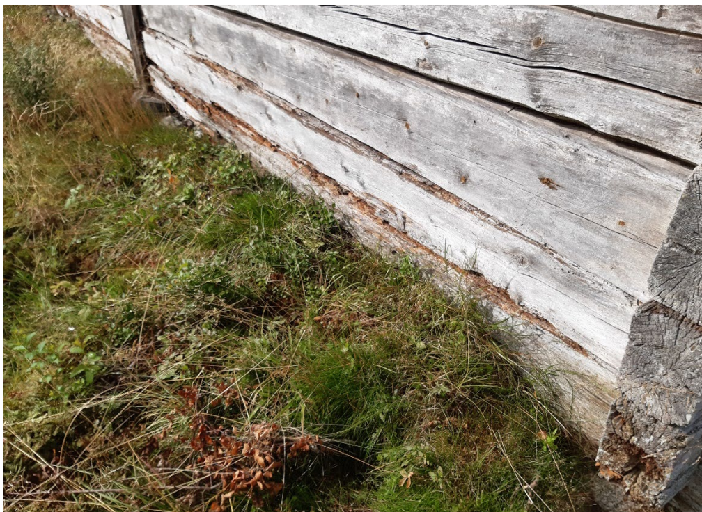
Figur 13. Detalj av vagnsbodens syllstock mot sydöst som legat emot jorden och blivit röt-skadad. Foto: Daniel Olsson 2022-08-31.
