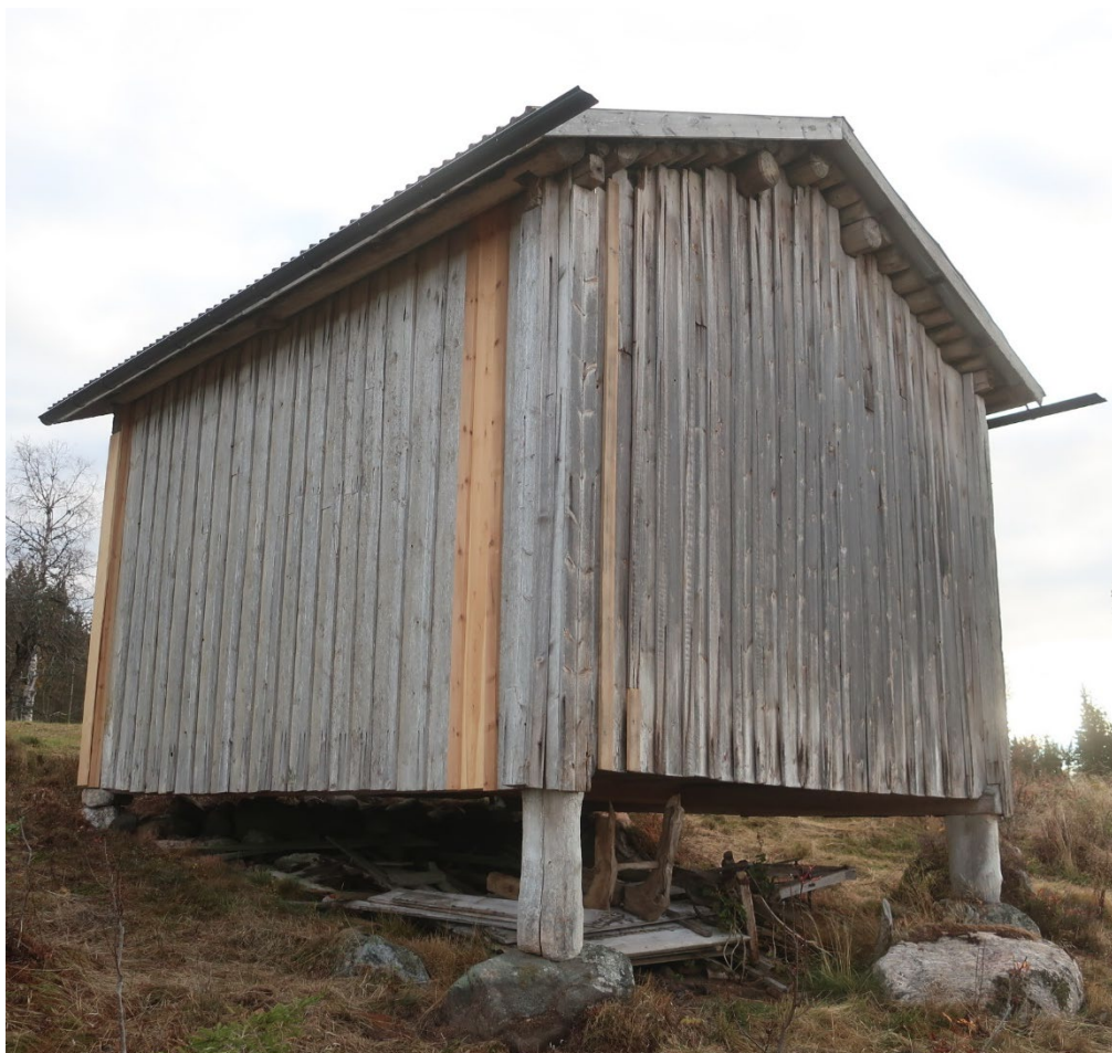
Figur 15. Härbret från väster efter avslutad renovering. Foto: Daniel Olsson 2022-10-18.
