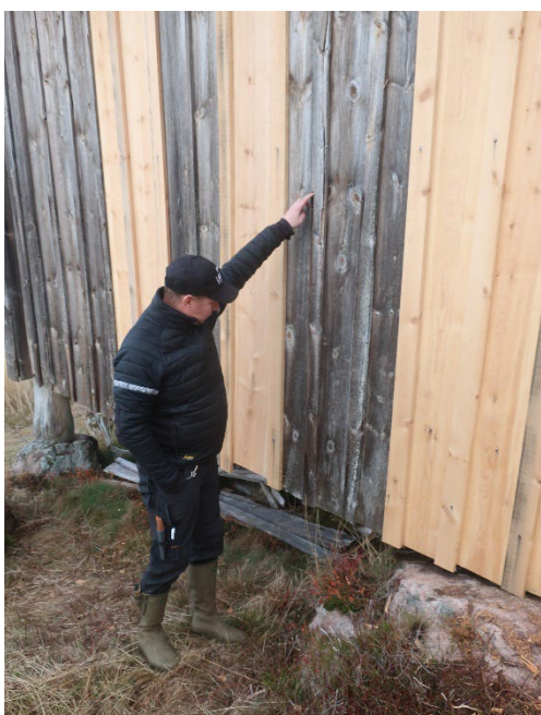
Figur 16. Martin Karlsson vid härbrets sydöstra fasad efter renovering av panelen. Foto: Daniel Olsson 2022-10-18.
