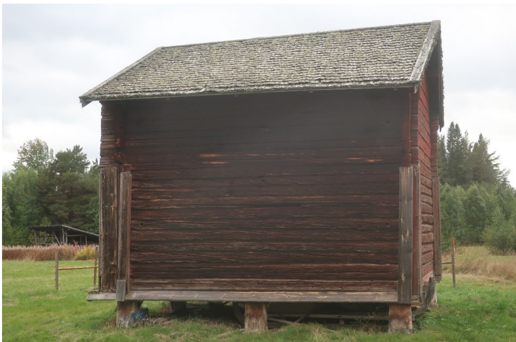
Figur 17. Härbret från sydöst innan renoveringen. Foto: Daniel Olsson 2020-09-16.
