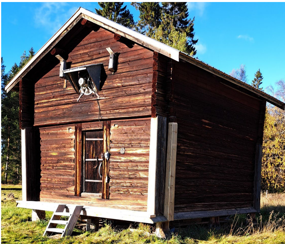
Figur 28. Härbret från sydöst efter färdigställning av knutlådor och trappa. Foto: Ann-Britt Karlsson 2022-10-08.
