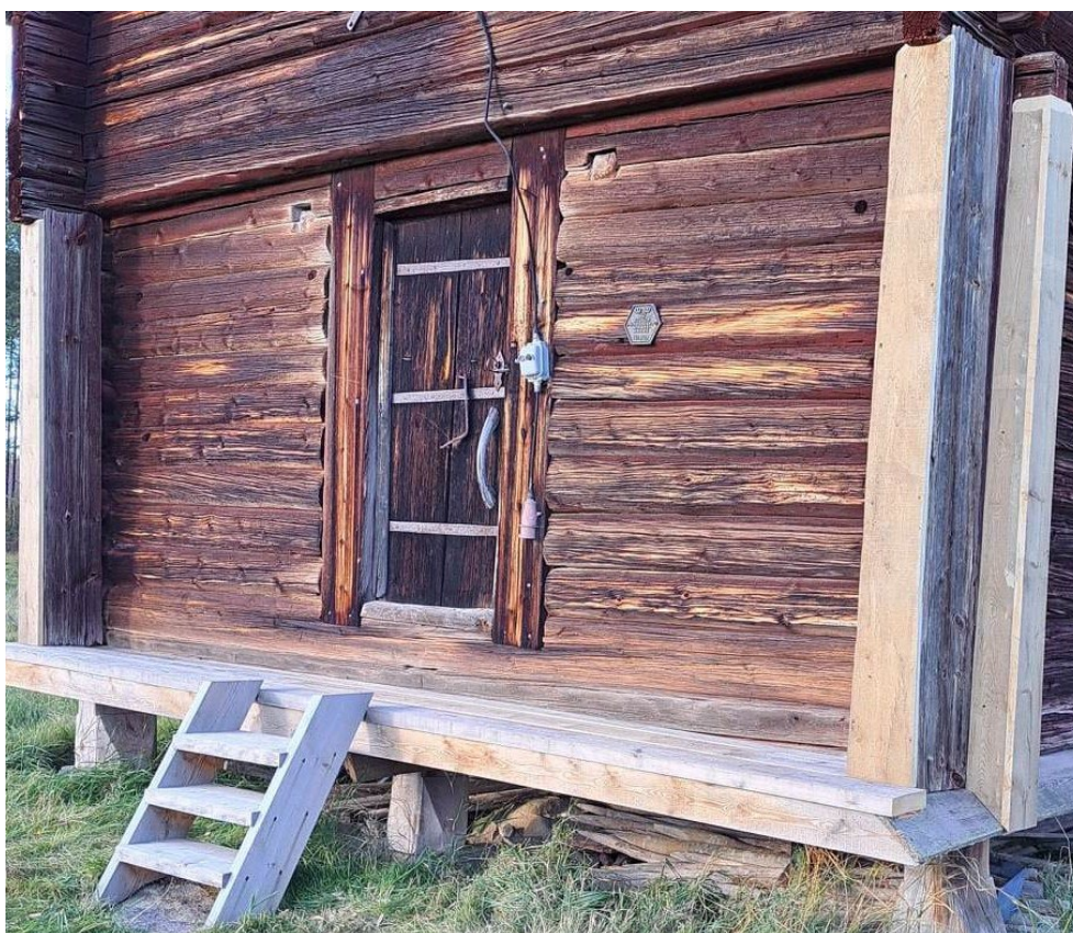
Figur 31. Detalj av härbrets svale med ny trappa och nya knutlådor efter avslutad renovering. Foto från sydöst. Foto: Ann-Britt Karlsson 2022-10-08.
