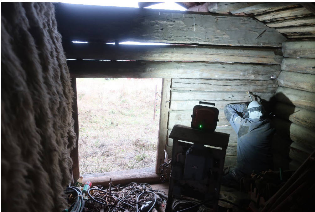
Figur 24. Daniel Åkerman borrar i ladans sydvästra vägg. Foto: Daniel Olsson 2021-10-19.
