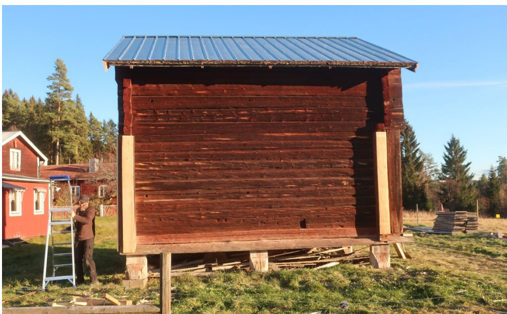
Figur 20. Härbret med nya knutlådor och nytt plåttak. Foto: Daniel Olsson 2021-10-26.
