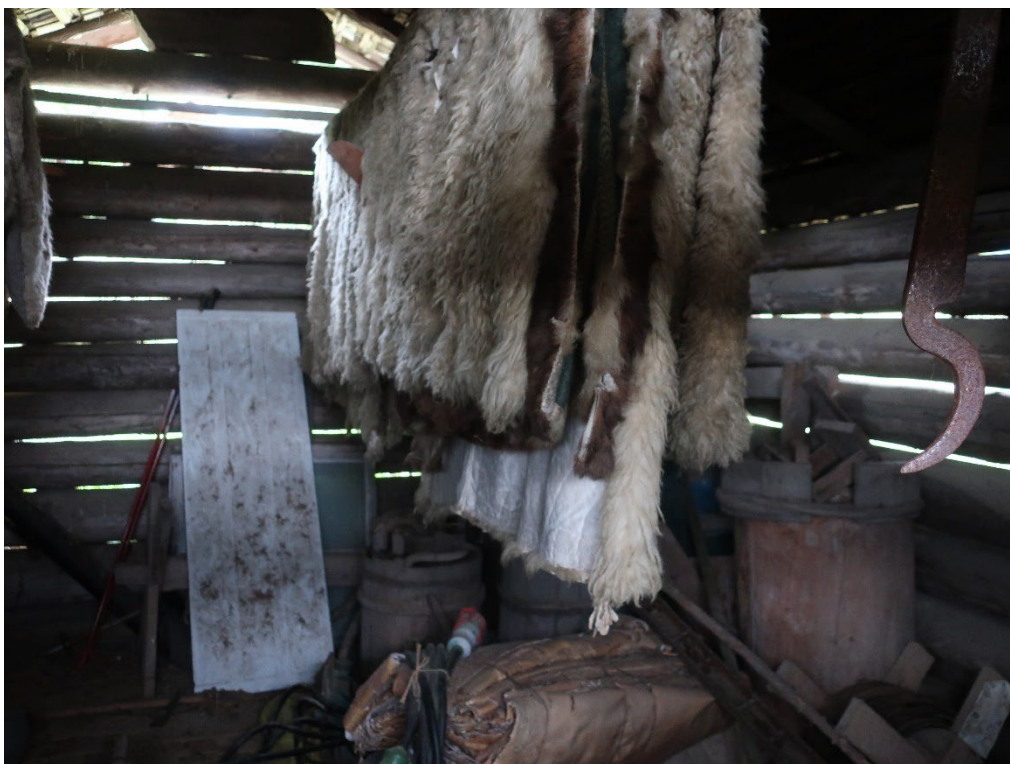
Figur 14. Ladans interiör från sydväst. Notera de stora gliporna mellan stockarna. Foto: Daniel Olsson 2021-10-19.
