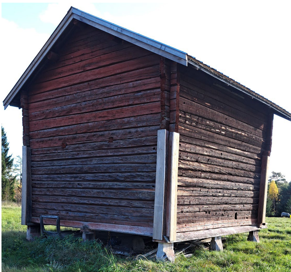
Figur 29. Härbret från nordväst efter färdigställning av knutlådor. Foto: Ann-Britt Karlsson 2022-10-08.
