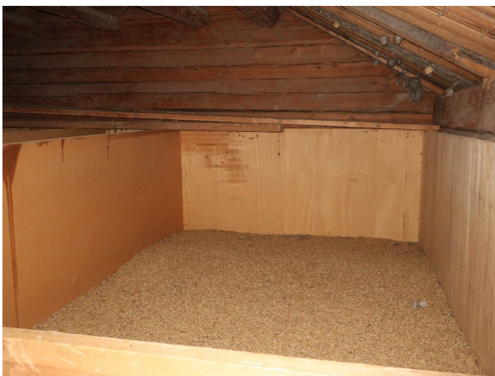
Figur 9. En av de moderna sädesbingarna av träfiberskivor på övervåningen. Foto: Daniel Olsson 2020-09-16.
