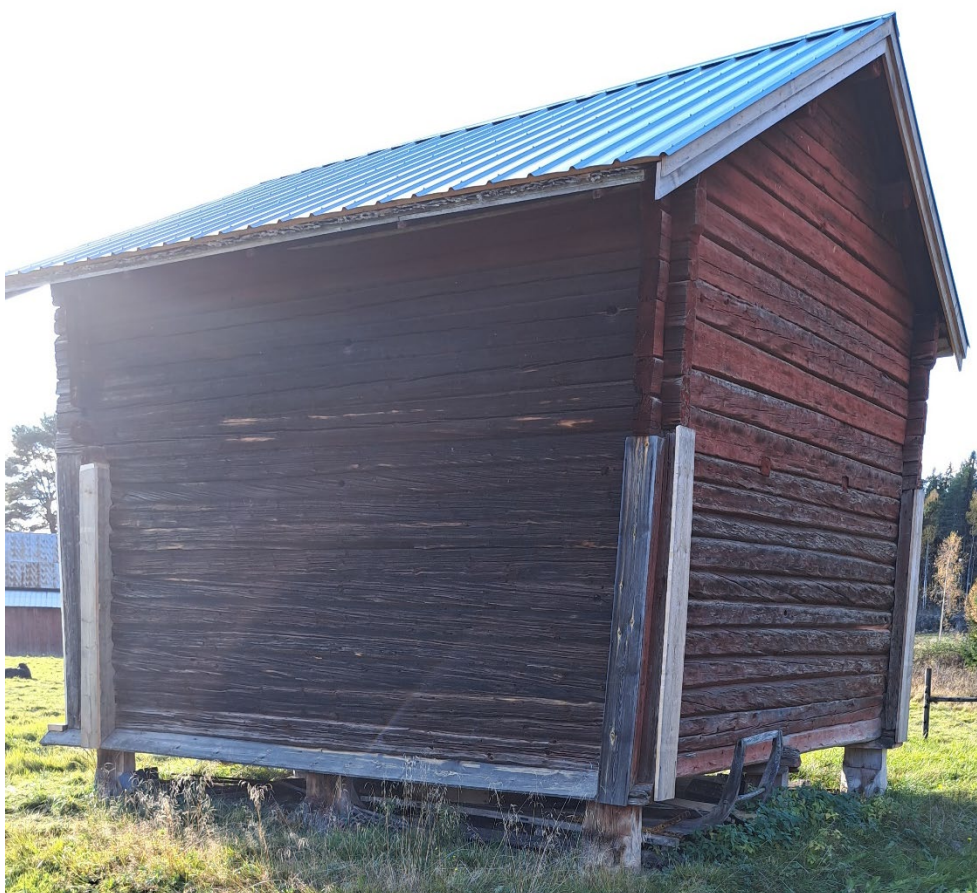
Figur 30. Härbret från nordöst efter färdigställning av knutlådor. Foto: Ann-Britt Karlsson 2022-10-08.
