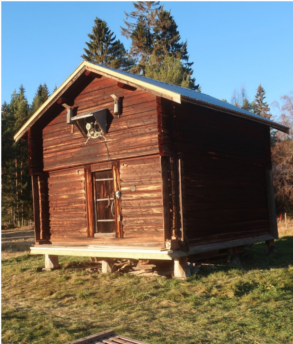
Figur 27. Härbret med nytt tak av pannplåt. Alla knutlådor och trappan var ännu inte på plats när bilden togs. Foto: Daniel Olsson 2021-10-26.
