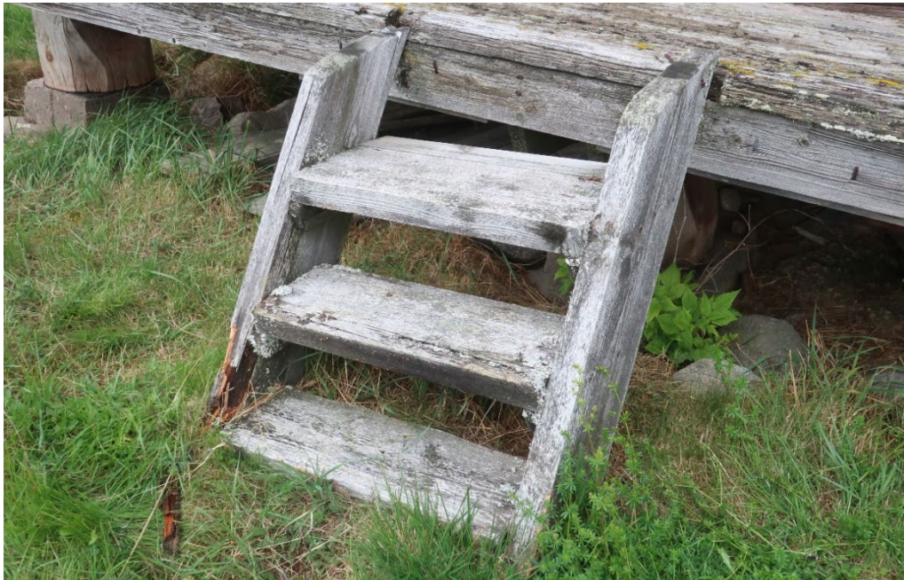
Figur 16. Trappan innan renoveringen. Foto: Daniel Olsson 2020-09-16.
