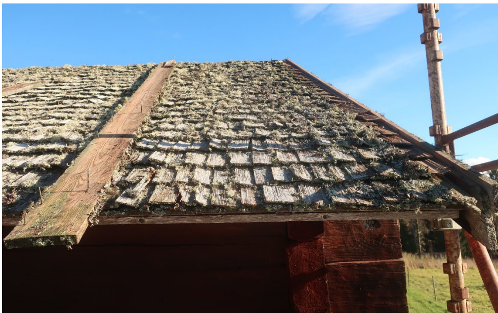
Figur 19. Del av härbrets takfall mot nordväst med takspån och borttagen vattbräda. Foto: Daniel Olsson 2021-10-07.
