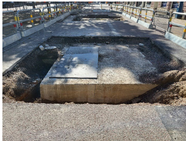
Figur 4. Schakt OS209 (förgrund) och schakt OS213 (bakgrund). Foto: Andreas Widerberg, Länsmuseet Gävleborg.
