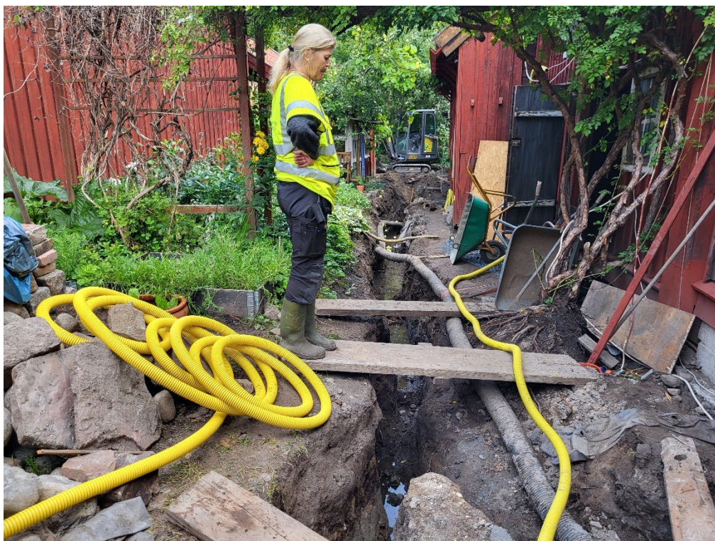
Figur 12. Anna Helligren står vid det smala ledningsschaktet OS1, foto mot norr. Foto: Andreas Widerberg, Länsmuseet Gävleborg.
