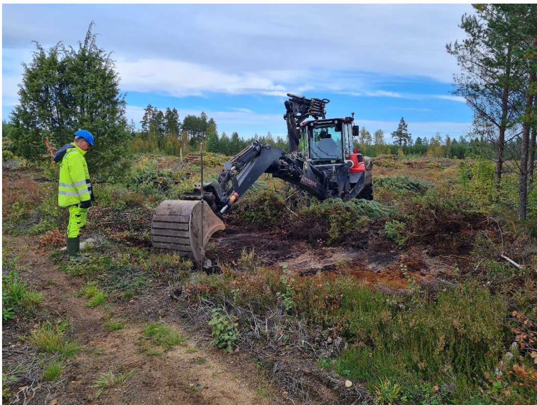
Figur 11. Schakt 306 upptas vid brottytan L1948:6371. Foto: Maria Björck.
