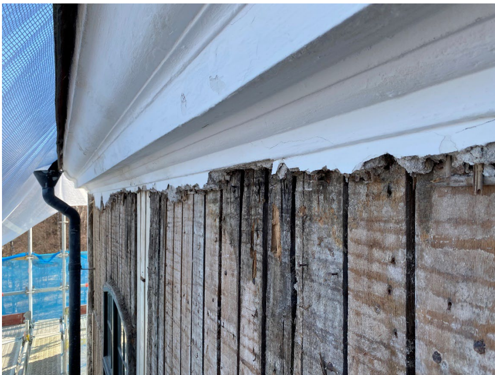
Figur 6. Takfotens puts bedömdes vara i sådant skick att den var möjlig att renovera. Foto: Ulrika Olsson, 2023-04-18.
