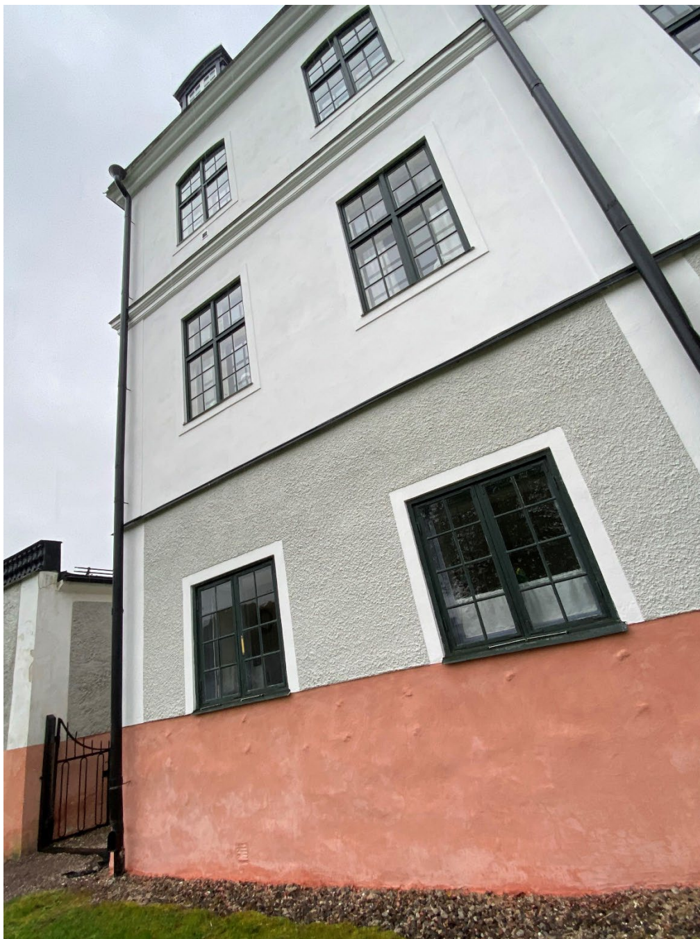
Figur 14. Sockeln är färdigrenoverad. Foto: Ulrika Olsson, 2023-10-06.
