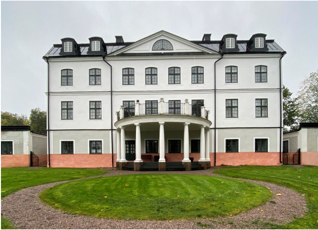
Figur 18. Forsbacka herrgård sedd från norr efter avslutade arbeten. Foto: Ulrika Olsson, 2023-10-06.
