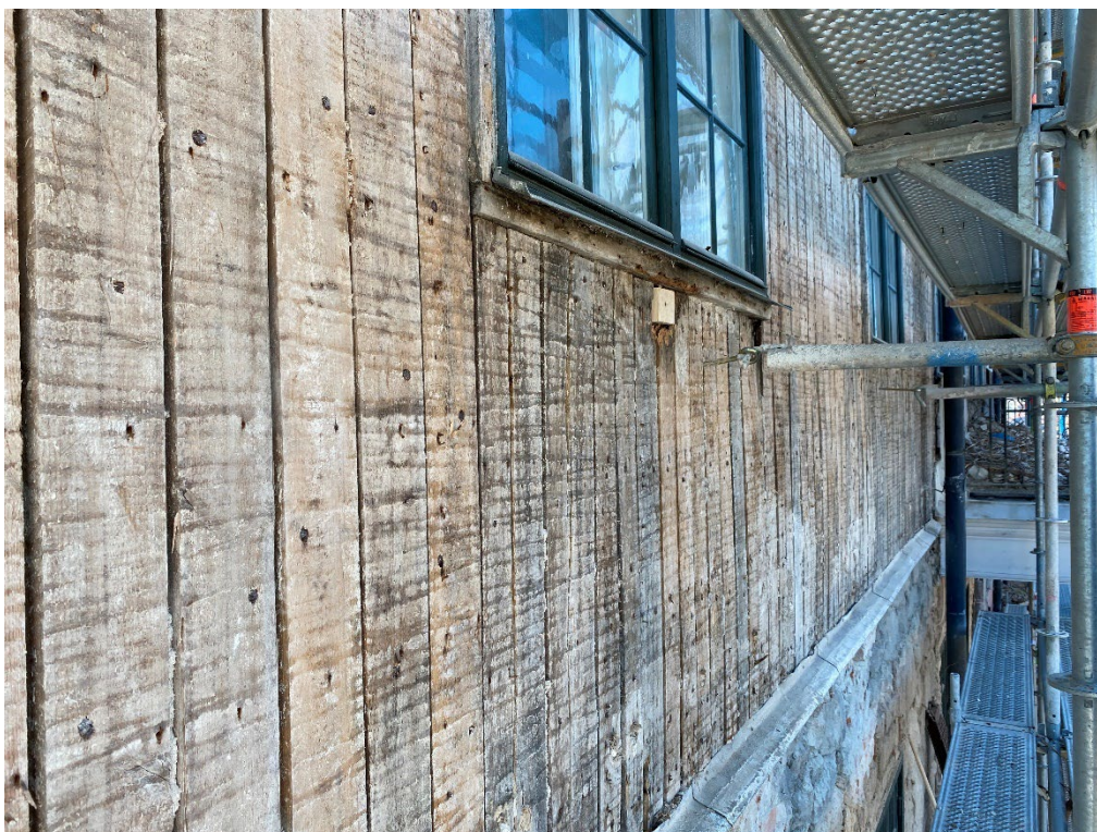
Figur 5. Putsen är nerknackad, en mindre trälagning syns under fönstret. Plåtlisten är ännu inte bytt. Foto: Ulrika Olsson, 2023-04-18.
