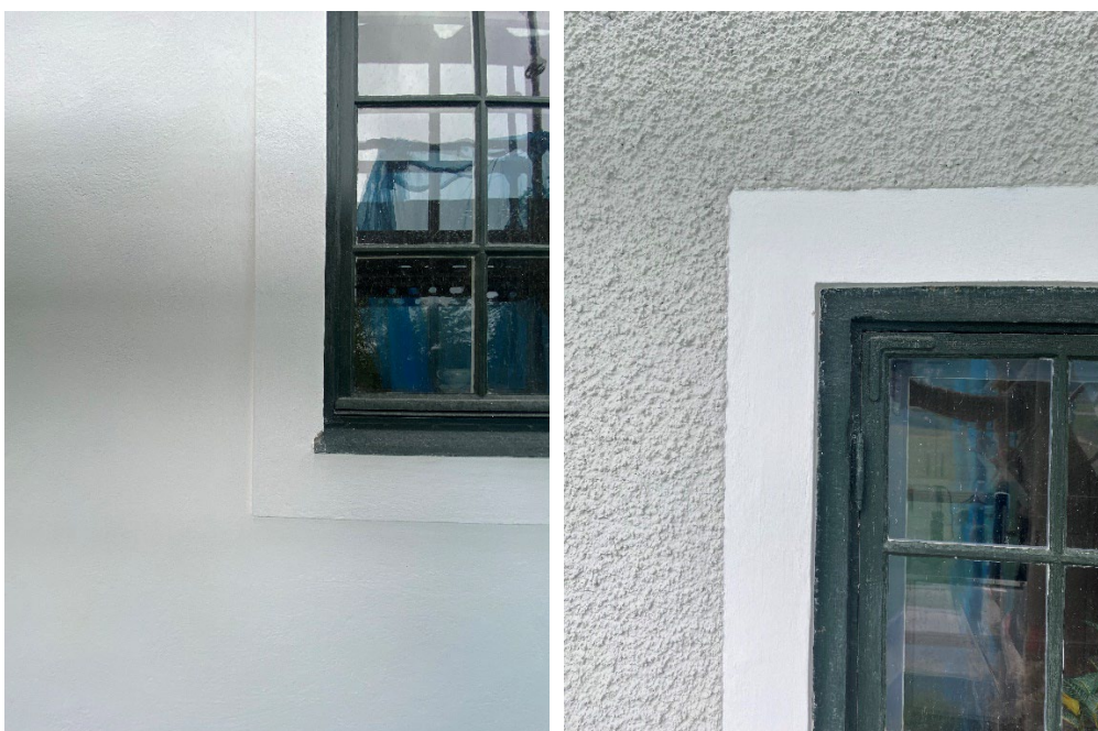
Figur 11 och 12. De nyputsade ytorna vid slutbesiktningen. Alla slätputsade partier är vita medan den spritputsade bottenväningen har en ljus grå kulör. Foto: Ulrika Olsson, 2023-07-04.
