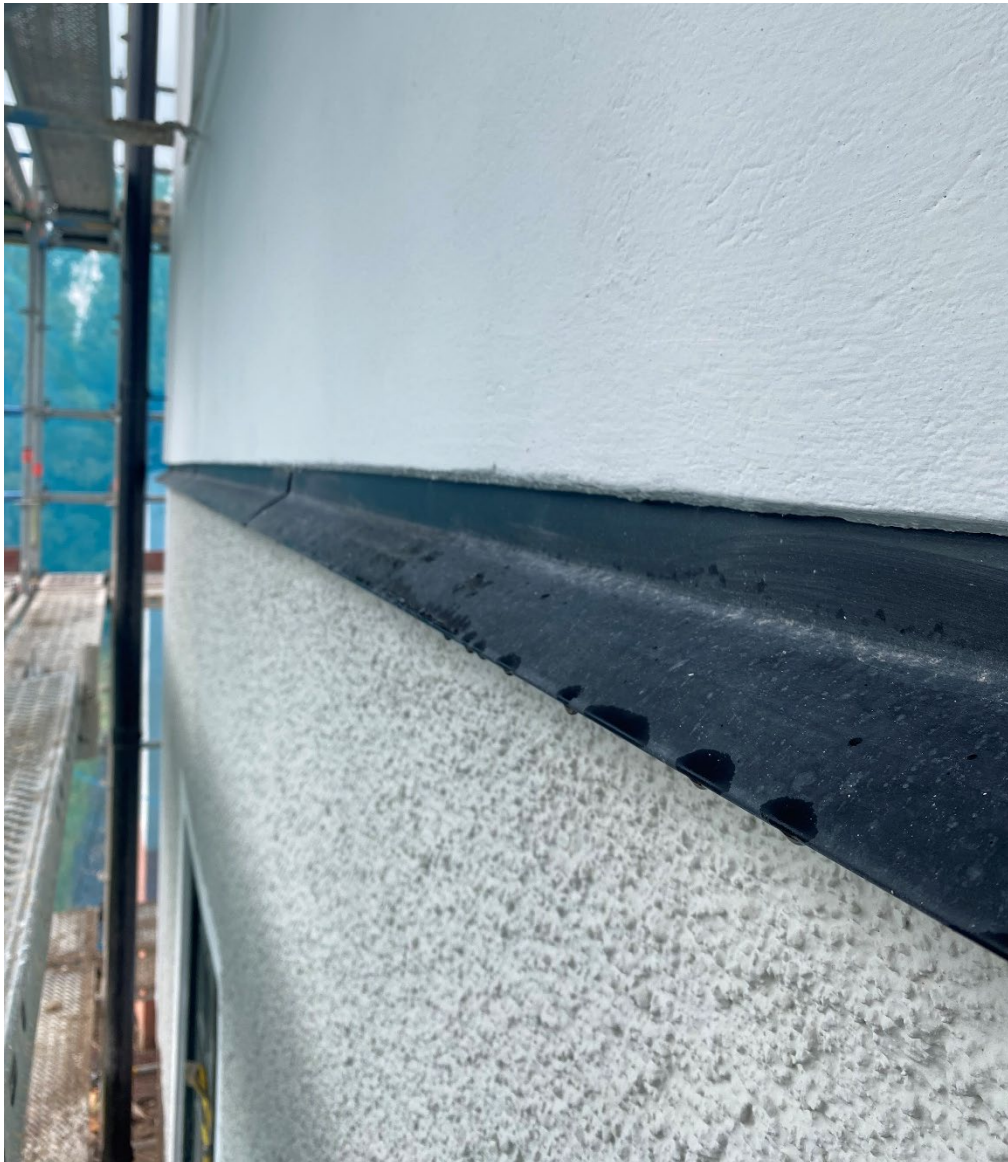
Figur 13. Ny utformning på plåtlisten som löper mellan bottenvåningens spritputs och ovanliggande slätputs. Den nya listen har ett högre uppdrag mot putsen. Foto: Ulrika Olsson, 2023-07-04.
