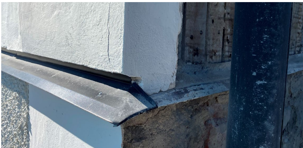
Figur 3. Under pågående arbeten. Här syns det nordöstra hörnet och två olika utföranden på plåtlist över bottenplan. Listen till höger var den som satt på den norra fasaden innan den nu aktuella renoveringen. Foto: Ulrika Olsson, 2023-04-18.
