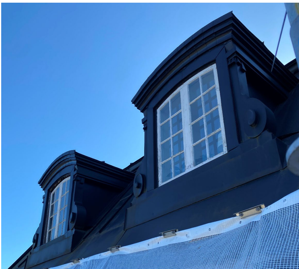
Figur 4. Fönsterbågarna i två av takkuporna innan påbörjad fönsterrenovering. Foto: Ulrika Olsson, 2023-04-18.
