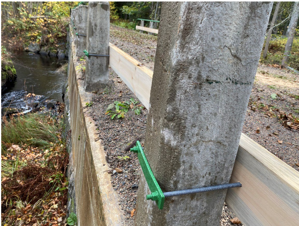
Figur 6. Vid slutbesiktningen av betongbrons räcken. Nya navföljare är monterade på betongardisterna likt tidigare utförande. Foto: 2021-10-19.
