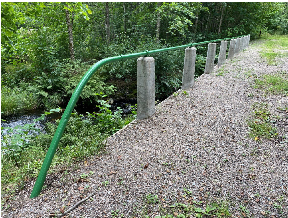
Figur 3. Under pågående arbeten. Den södra sidans rörföljare är färdigställda. Foto: 2021-08-19.
