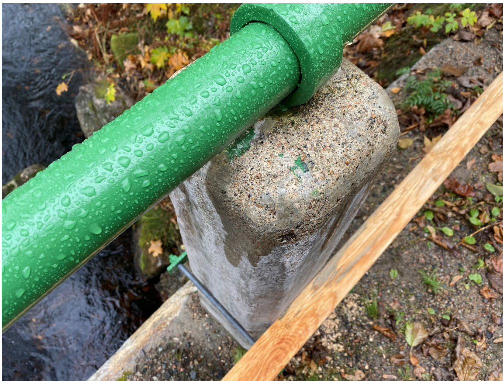
Figur 7. Vid slutbesiktningen av betongbrons räcken. Körföljarna vilar på och är monterade i, betonggardisterna. Foto: 2021-10-19.
