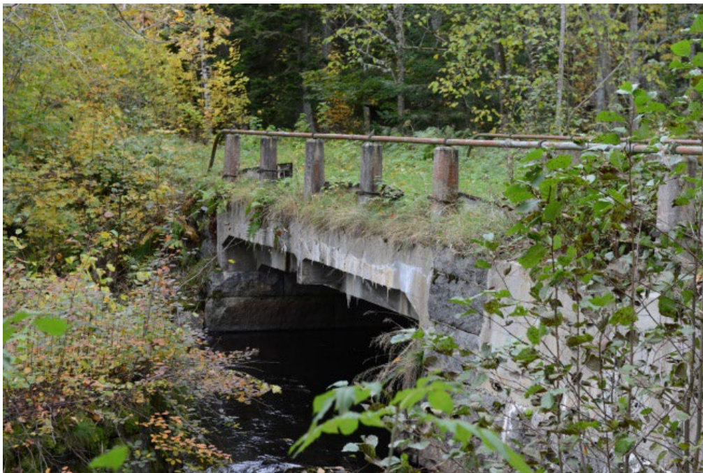
Figur 2. Betongbron innan påbörjade arbeten. Foto ur Sven Olof Ahlbergs arbetsberedning, 2020-06-07.
