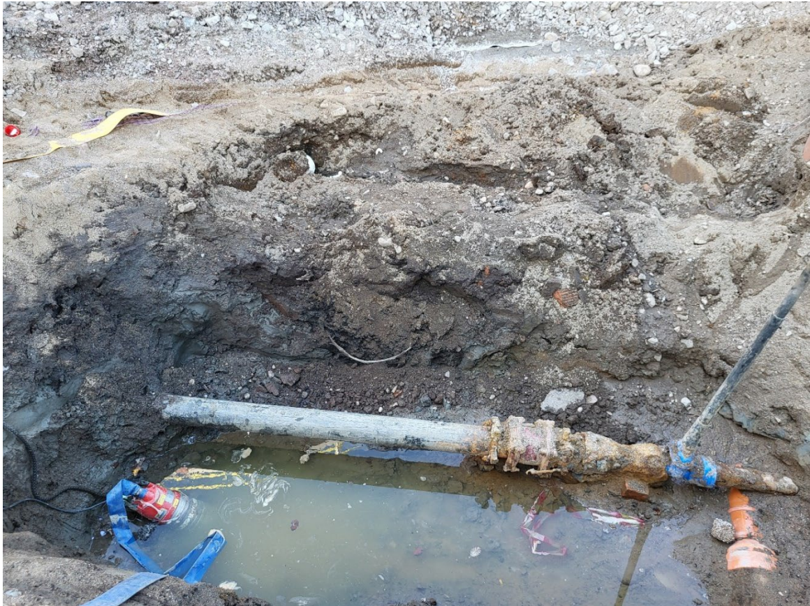
Figur 9. Kulturlagret i schakt OS257 mot norr. Foto: Andreas Widerberg, Länsmuseet Gävleborg.
