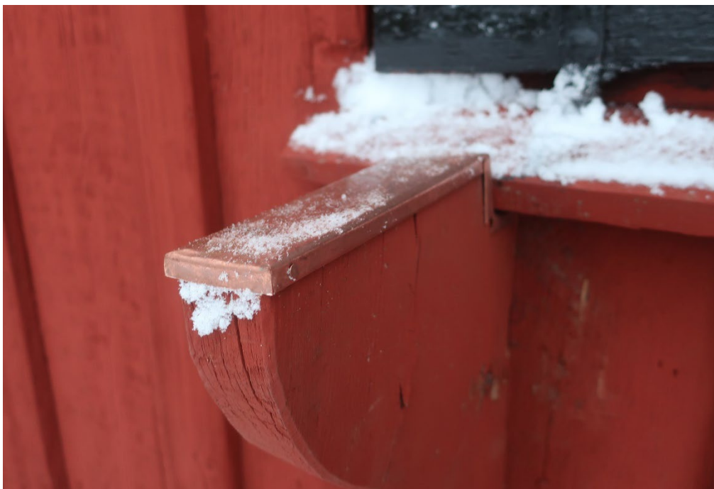
Figur 13. Detalj av ny kopparplåt på konsoll vid en av vädringsluckorna. Foto: Daniel Olsson 2022-11-24.
