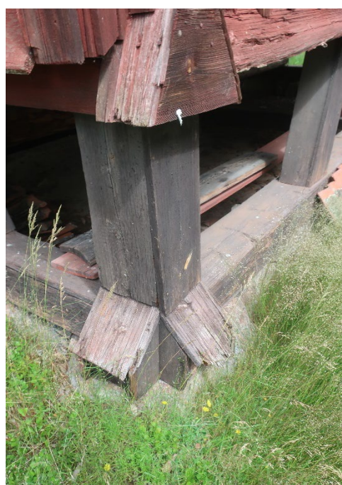
Figur 5. Detalj av syllramen med bärande stolpar. Foto: Daniel Olsson 2022-07-05.
