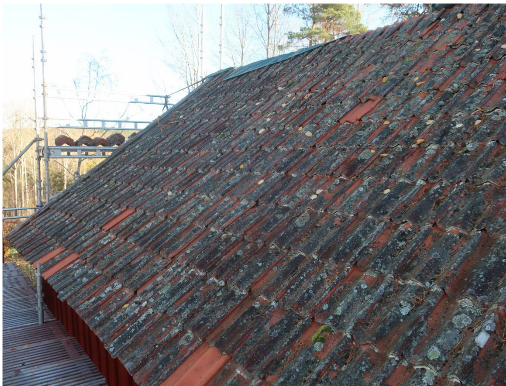
Figur 17. Takfallet mot nordväst innan nedplockning av pannorna. Foto: Daniel Olsson 2022-10-21.
