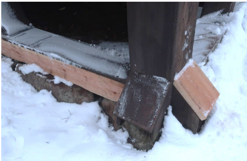
Figur 11. Detalj av nya täckbrädor vid knut mot norr. Foto: Daniel Olsson 2022-11-24.
