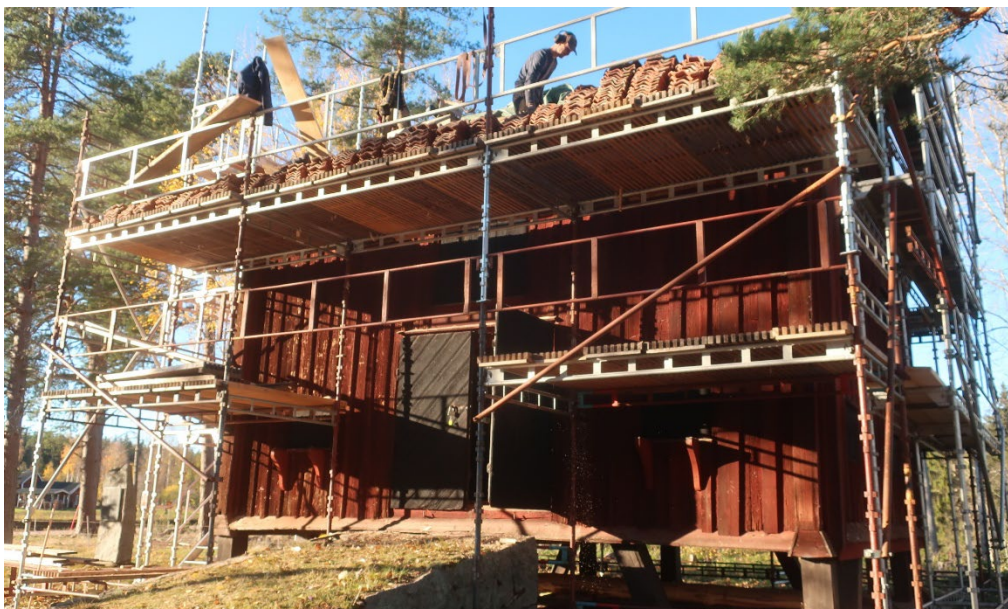
Figur 18. Trossboden från öster under takrenoveringen. Foto: Daniel Olsson 2022-10-21.
