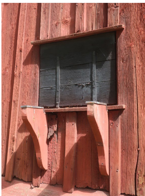
Figur 4. Detalj av vådringslucka med konsoller. Foto: Daniel Olsson 2022-07-05.
