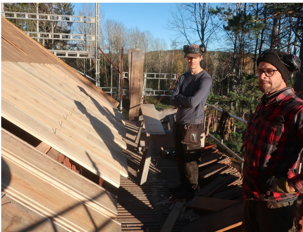
Figur 16. Samma takyta som på bilden ovan vid fastspikning av undertaksbrädor. Foto: Daniel Olsson 2022-10-21.
