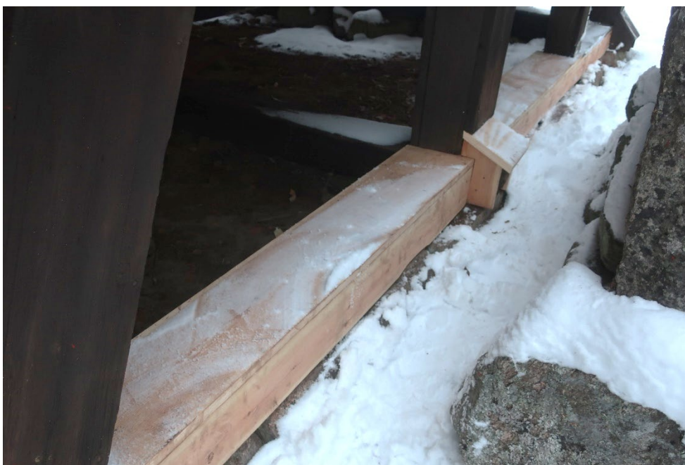
Figur 10. Detalj av syllstocken mot sydöst med nya täckbrädor. Foto: Daniel Olsson 2022-11-24.
