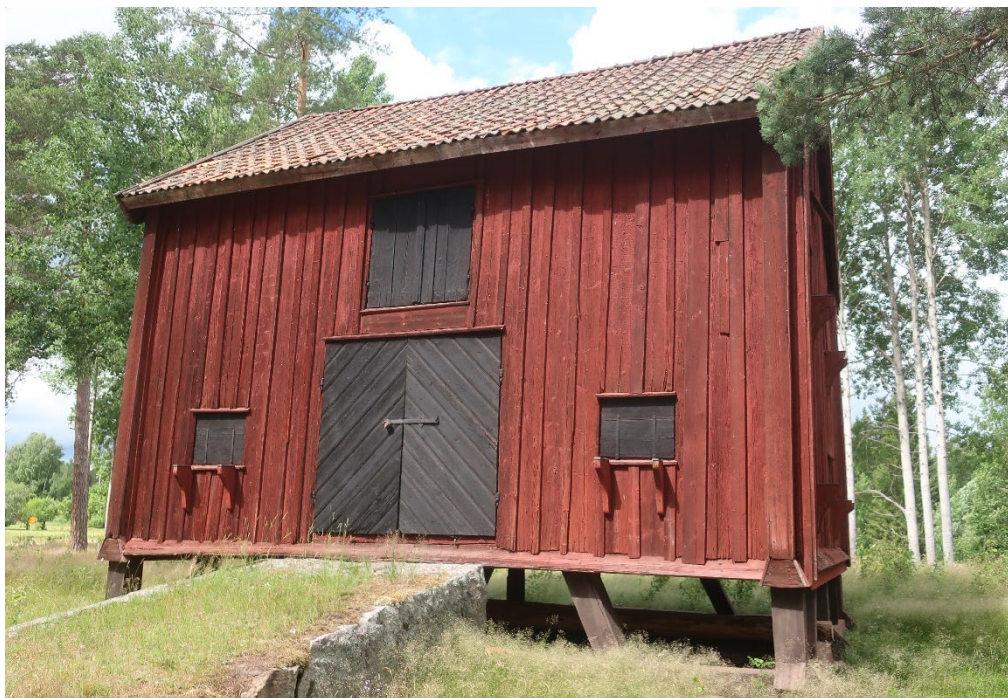
Figur 8. Trossboden från öster innan renoveringen. Foto: Daniel Olsson 2022-07-05.
