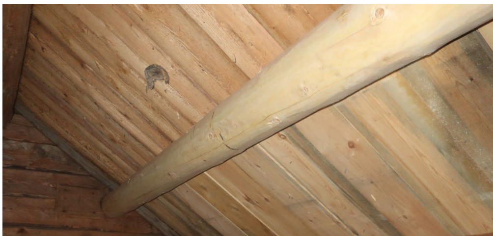
Figur 14. Detalj av den utbytta takåsen längst mot sydöst. Foto: Daniel Olsson 2022-11-24.
