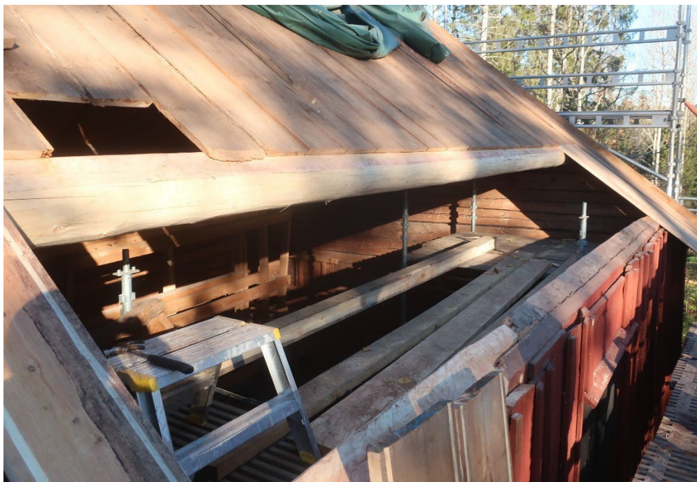
Figur 15. Takfallet mot sydöst under pågående byte av undertaksbrädor. Foto: Daniel Olsson 2022-10-21.
