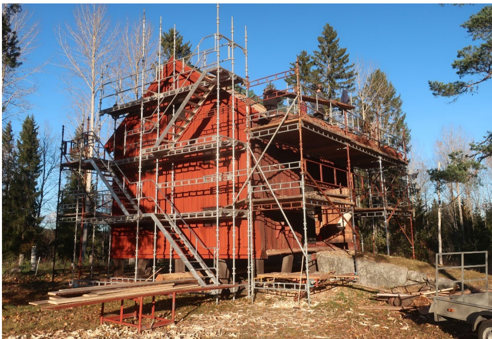
Figur 9. Trossboden från söder under renoveringen. Foto: Daniel Olsson 2022-10-21.
