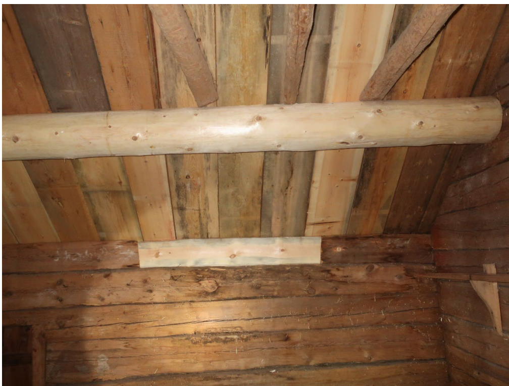
Figur 12. Detalj av den ilagade delen av hammarbandet i väggen mot sydöst samt utbytta undertaksbrädor och en del av den utbytta takåsen längst mot sydöst. Foto: Daniel Olsson 2022-11-24.
