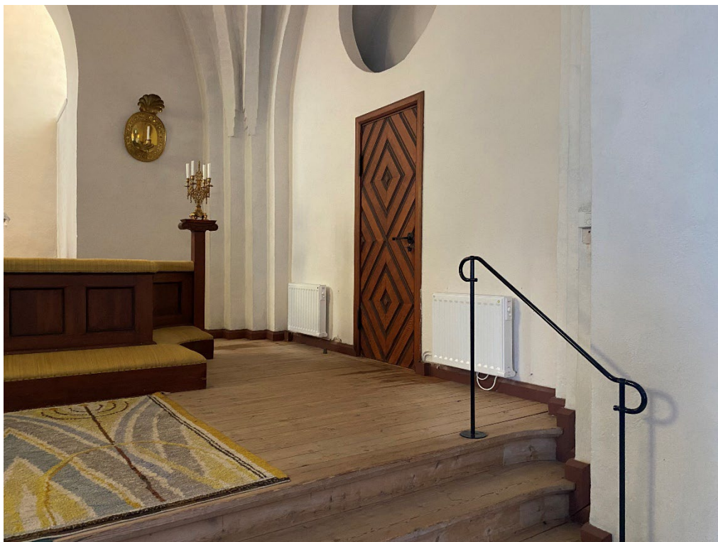
Figur 17. Korets södra sida innan påbörjade arbeten. På vardera sidan om dörren som leder in till sakristian satt små element. Foto: Ulrika Olsson, 2023-04-26.
