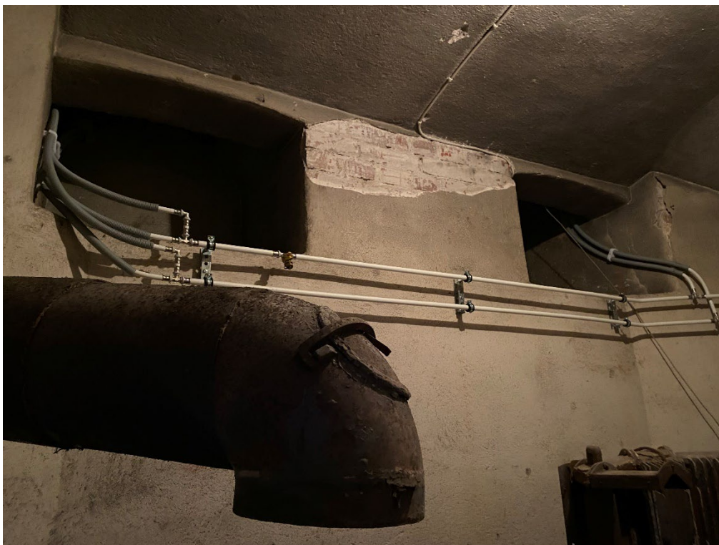
Figur 5. Rördragningarna har delvis gjorts via äldre värmekanaler under golvet. Foto: Ulrika Olsson, 2024-02-05.
