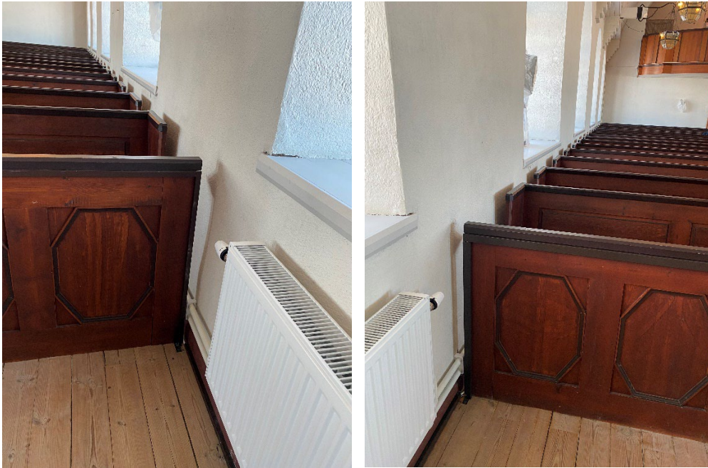
Figur 8 och figur 9. Den norra, respektive södra sidans bänkkvarter. Fotografierna visar hur bänkarna har flyttats ut från väggarna en aning för att rördagningarna ska få plats. Foto: Ulrika Olsson, 2024-02-05.
