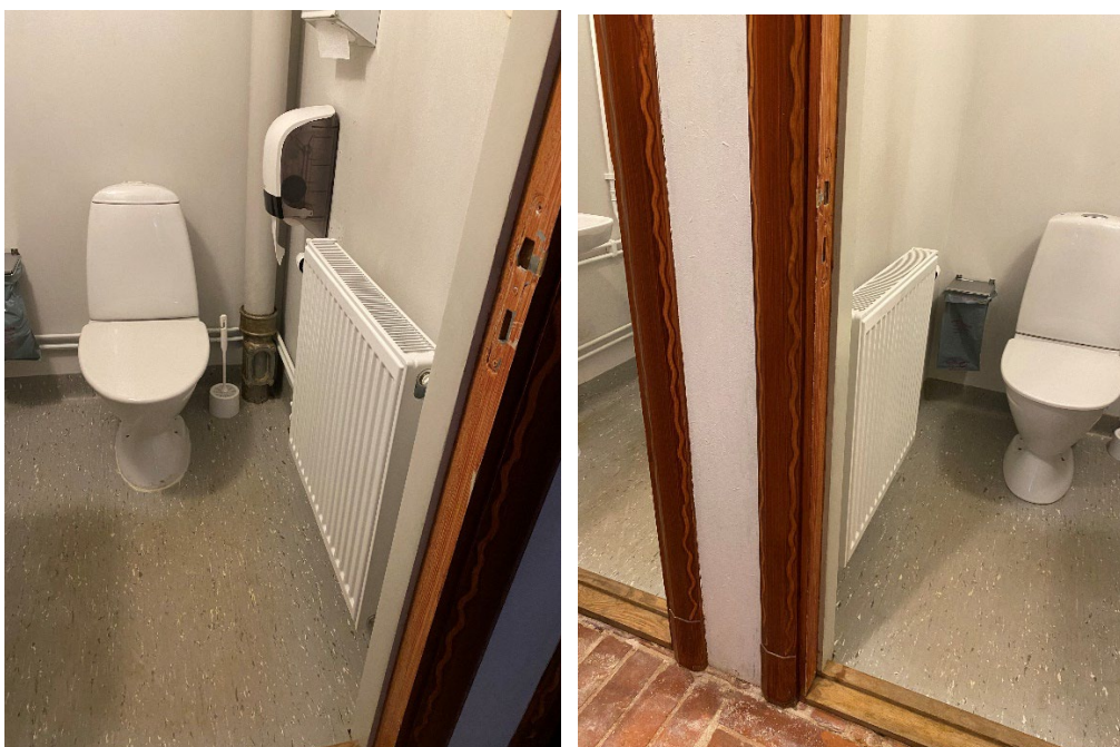
Figur 25 och figur 26. WC-utrymmena har försetts med nya radiatorer. Foto: Ulrika Olsson, 2024-02-05.
