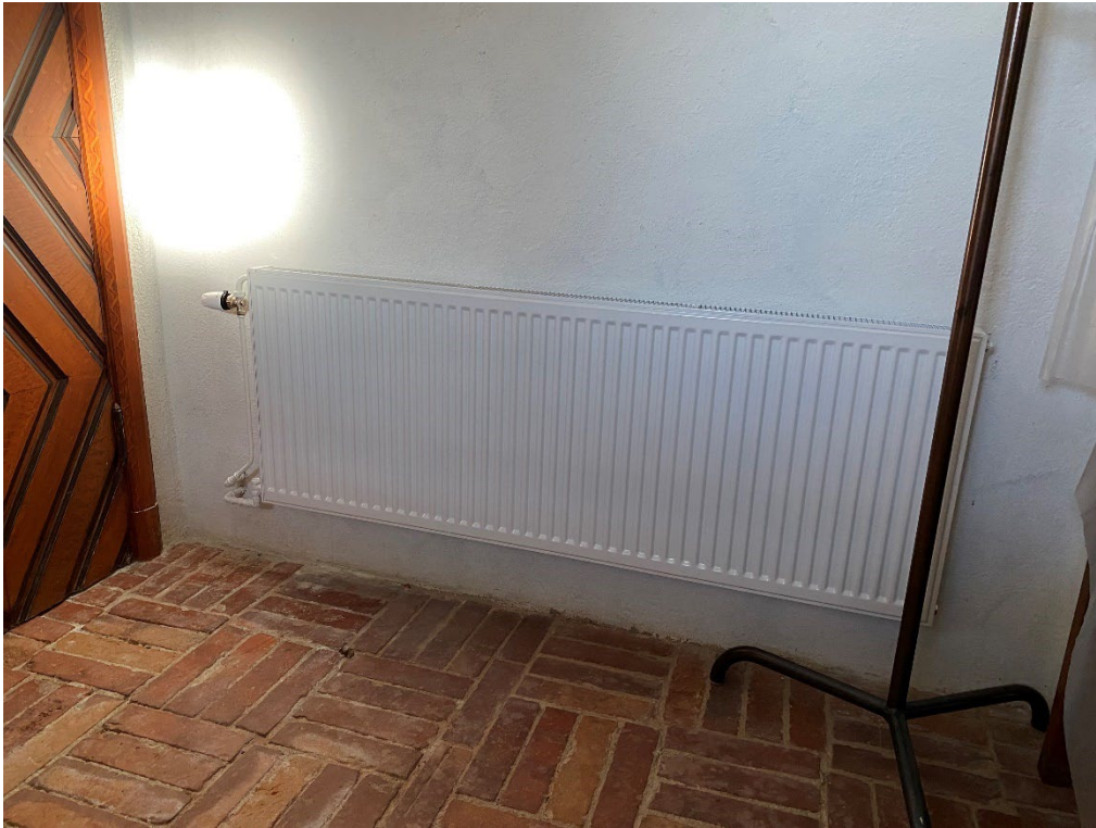
Figur 22. Vapenhusets norra del vid slutbesiktningen. En ny radiator har monterats på innerväggen mot kyrkorummet. Foto: Ulrika Olsson, 2024-02-05.
