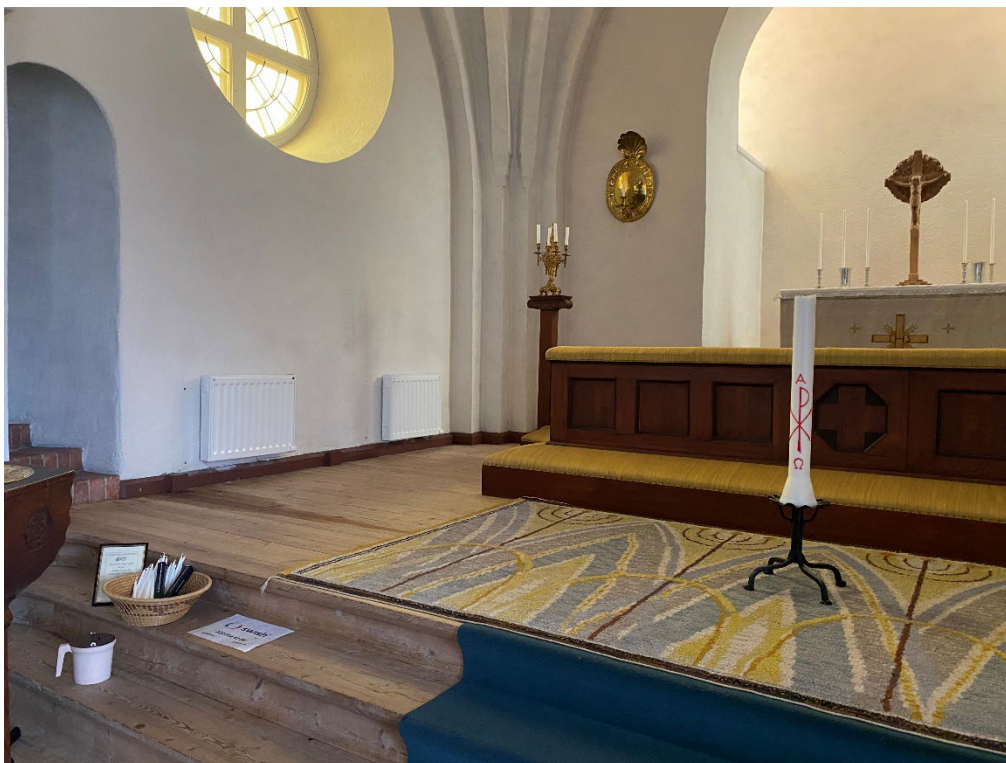
Figur 15. Korets norra sida innan påbörjade arbeten. Här satt två små radiatorer. Foto: Ulrika Olsson, 2023-04-26.
