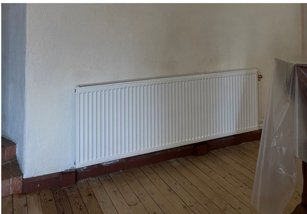
Figur 16. Korets norra sida vid slutbesiktningen. De två radiatorerna har bytts till en stor radiator som har centrerats under det runda fönstret. Foto: Ulrika Olsson, 2024-02-05.
