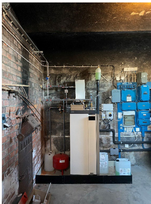
Figur 3 och figur 4. Inkommande ledningar från kulverten samt bergvärmepumpen. Foto: Ulrika Olsson, 2024-02-05.
