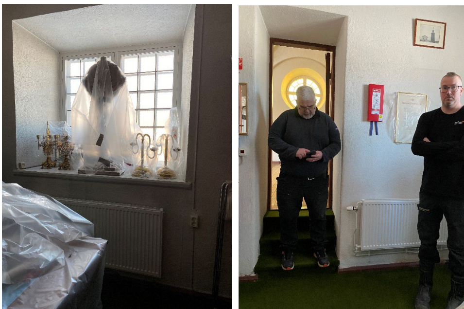
Figur 19 och figur 20. De två nya radiatorerna i sakristian vid slutbesiktningen. Till höger syns Ola Larsson från VVS-Montörerna AB och till höger syns Tobias Ström, Ockelbo församling. Foto: Ulrika Olsson, 2024-02-05.
