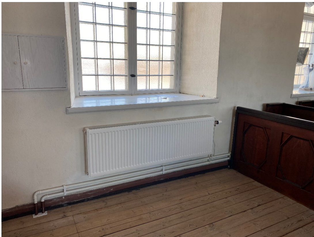
Figur 7. Den nya radiatoren på den södra sidan. Lite till vänster om radiatoren går rören upp genom gamla håltagningar i golvet. Foto: Ulrika Olsson, 2024-02-05.
