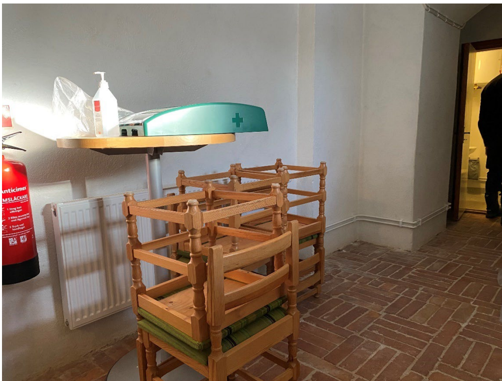
Figur 24. Vapenbusets södra del vid slutbesiktningen. En ny radiator har monterats på innerväggen mot kyrkorummet. Fotot visar även dragningen in till de båda toaletterna. Foto: Ulrika Olsson, 2024-02-05.
