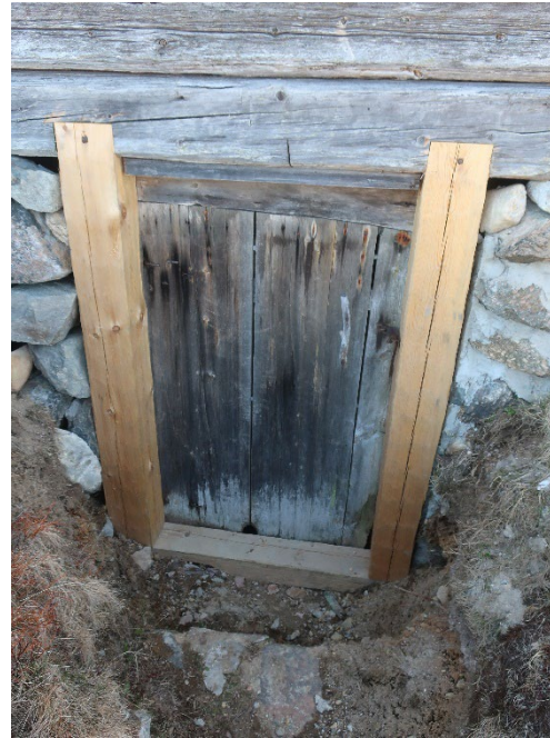
Figur 22. Detalj av källardörren med ny karm och uppresta stenkanter. Foto från nordväst: Daniel Olsson 2022-05-17.
