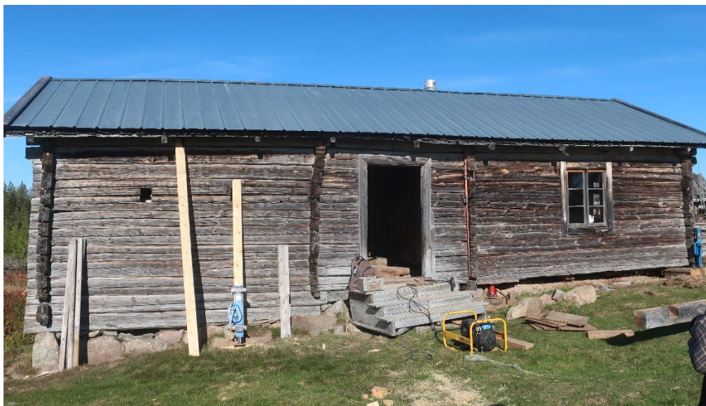
Figur 14. Vallstugan från sydväst under pågående renovering. Foto: Daniel Olsson 2021-09-15.
