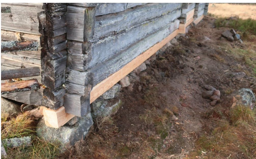
Figur 17. Syllstocken mot nordöst inlagd på rätt plats. Jämför med figur 16 ovan. Foto: Daniel Olsson 2021-10-27.
