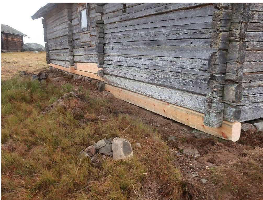
Figur 19. Vallstugans nordöstra fasad efter timmerbyten med den utbytta fyllnadsstocken till höger i bild. Foto från norr: Daniel Olsson 2021-10-27.
