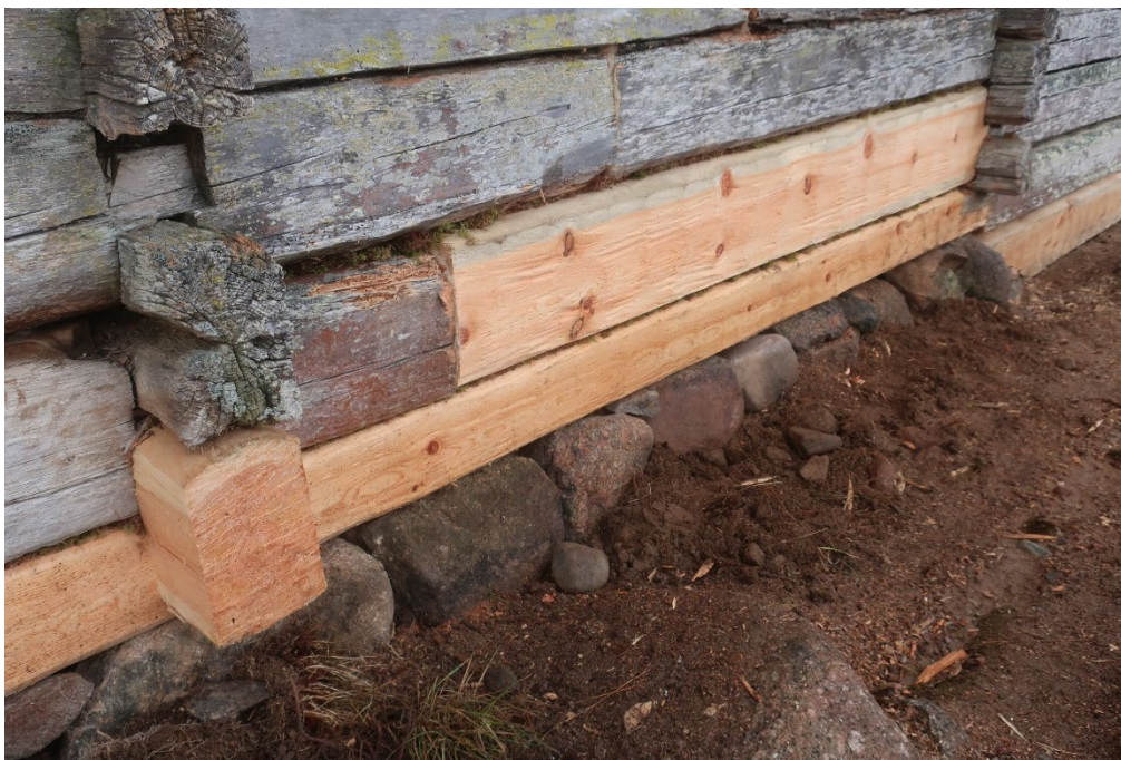
Figur 18. Detalj av mittpartiet på vallstugans nordöstra vägg (vägg C) efter byte av syllstocken och del av stocken ovanför denna. Foto från öster: Daniel Olsson 2021-10-27.
