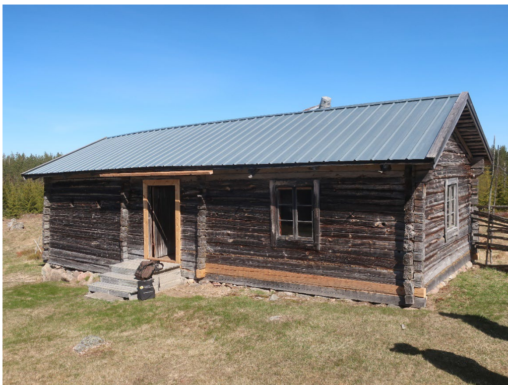
Figur 5. Lassgårds vallstuga från söder. Foto: Daniel Olsson, 2021-09-15.
