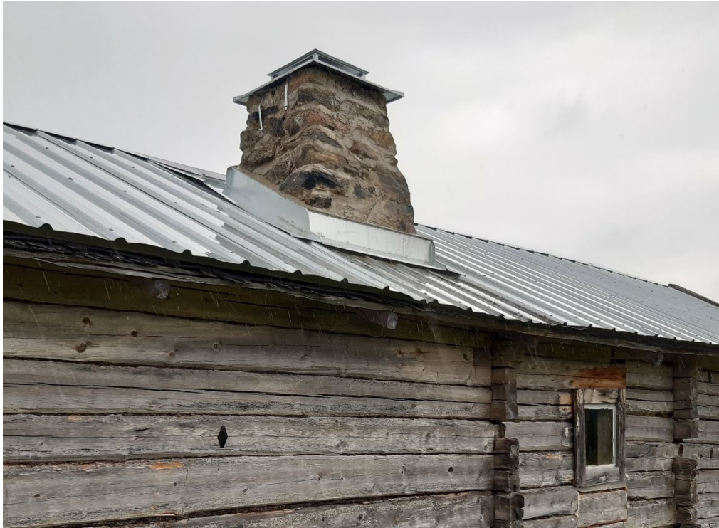
Figur 20. Den återuppförda skorstenen med nytt övre och nedre beslag. Foto: Daniel Olsson, 2022-07-04.
