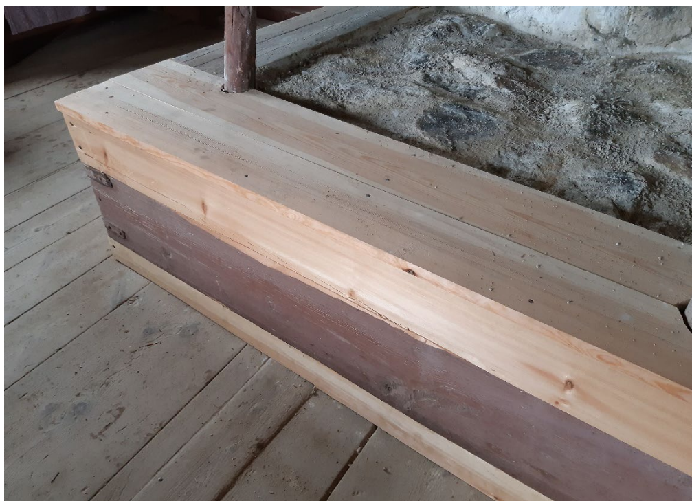
Figur 16. Detalj av gravsyllen efter renoveringen. Foto från öster: Daniel Olsson, 2022-07-04.
