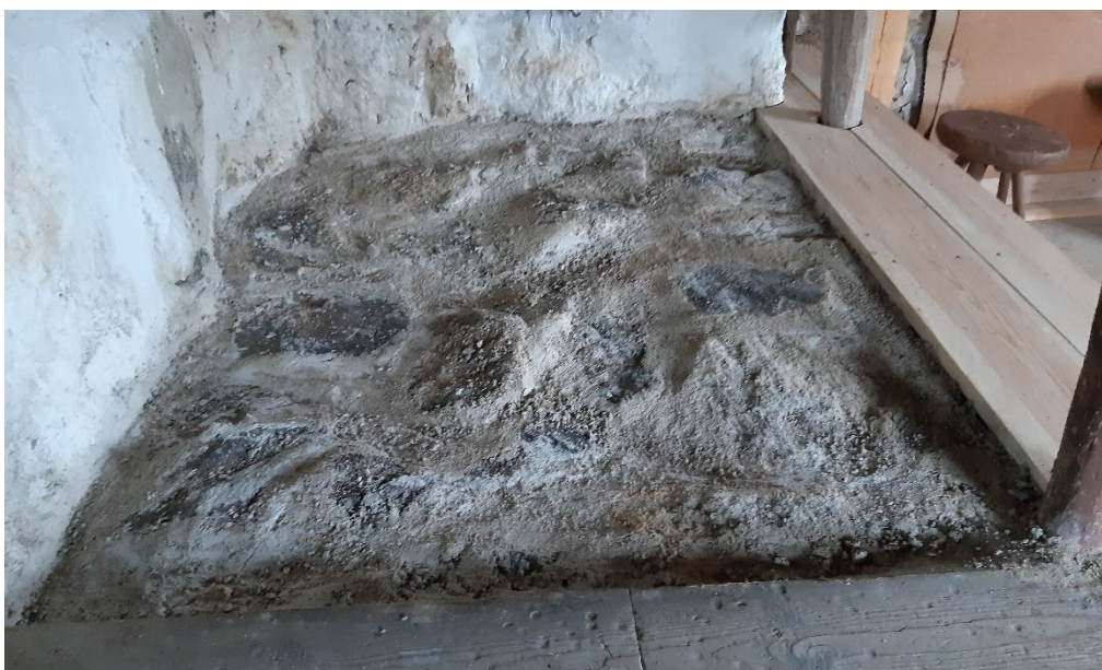
Figur 22. Detalj av eldbärden efter avslutad renovering. Foto från sydväst: Daniel Olsson, 2022-07-04.
