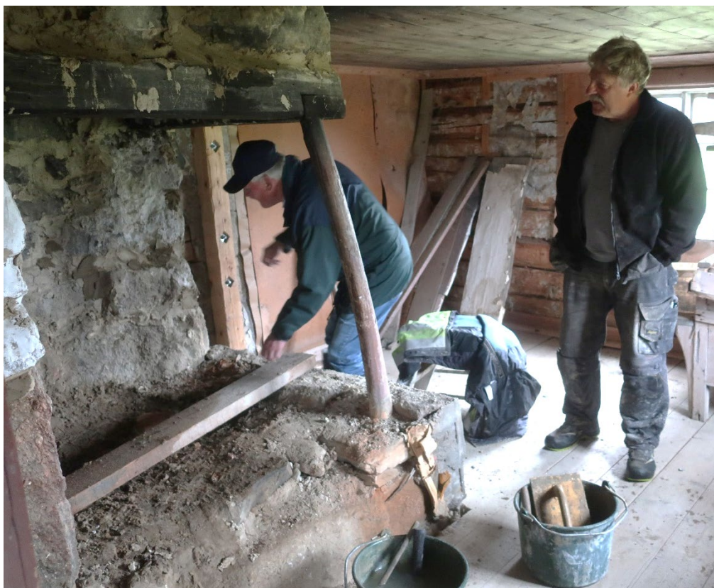
Figur 10. Fastighetsägaren Leif Karlsson och muraren Erik Andersson i samband med en besiktning under renoveringen. Skorstenen har här plockats ned och återuppförts. Gravsyllen och härden har ännu inte satts tillbaka. Foto från väster: Daniel Olsson, 2022-06-02.
