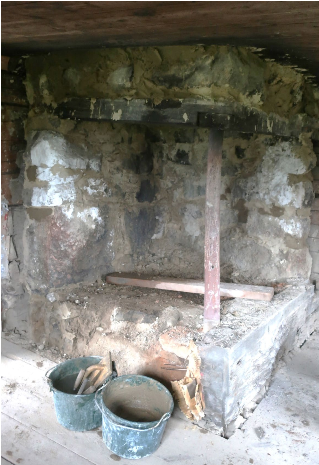
Figur 11. Eldstaden från söder under renoveringen. Foto: Daniel Olsson, 2022-06-02.
