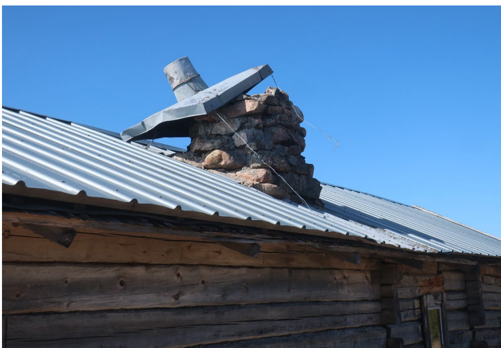
Figur 8. Skorstenen från öster med det övre plåtbeslaget delvis dementerat inför skorstensarbetet. Foto: Daniel Olsson, 2022-05-17.
