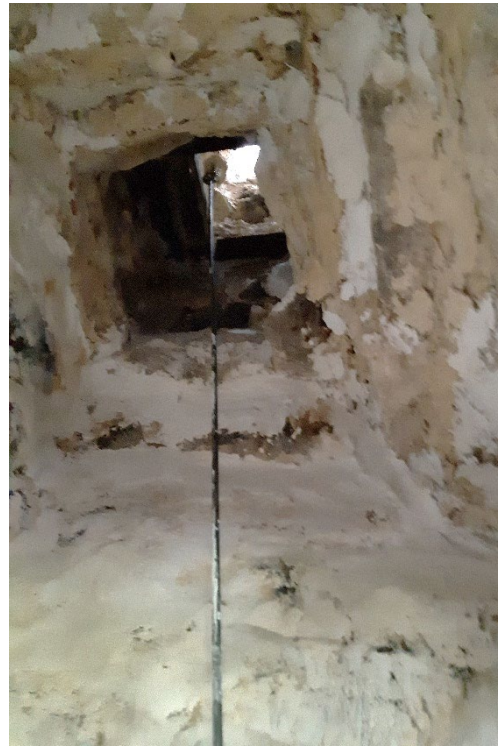
Figur 14. Murstocken sedd nedifrån efter återuppförandet samt försedd med ett fyrkantigt metallspjäll. Foto: Daniel Olsson, 2022-07-04.
