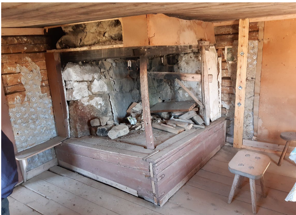
Figur 7. Den öppna spisen från söder innan renoveringen inleddes. Foto: Daniel Olsson, 2022-05-17.
