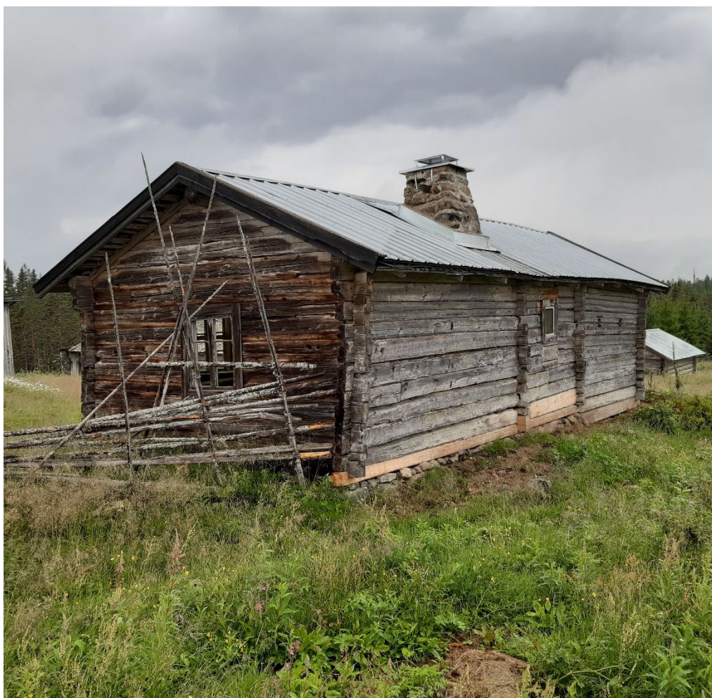
Figur 23. Vallstugan från öster efter avslutad renovering. Foto: Daniel Olsson, 2022-07-04.
