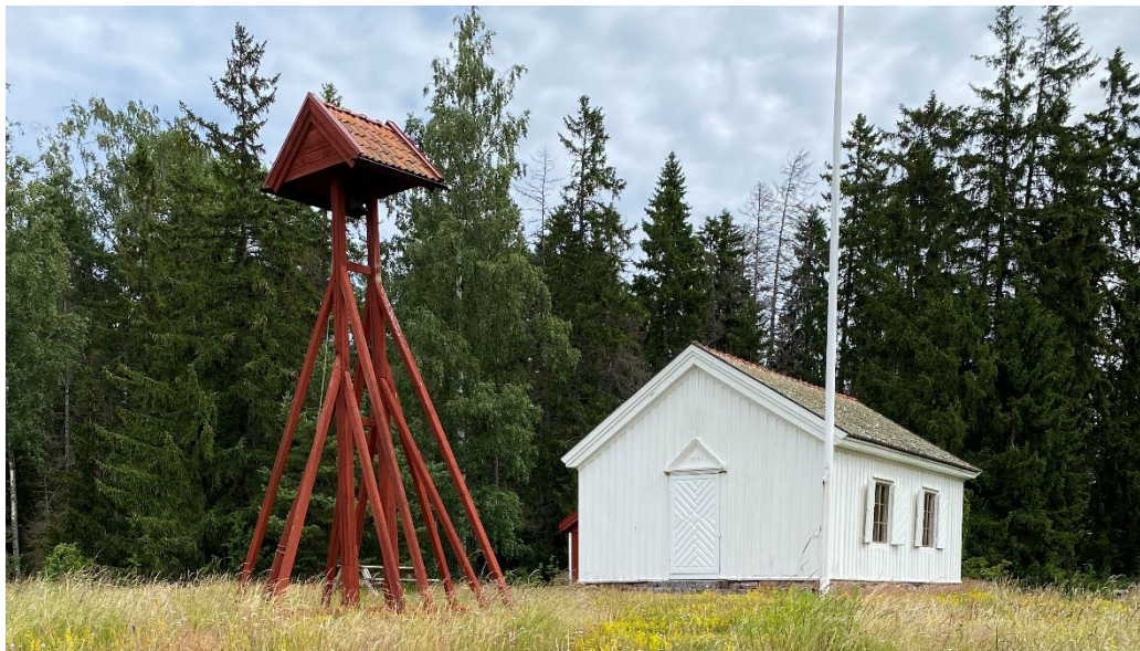
Figur 2. Lövgrunds kapell och klockstapel sedd från väster efter avslutade arbeten. Foto: Ulrika Olsson, Läns museet Gävleborg, 2024-07-03.
