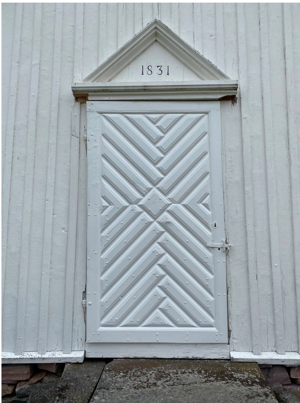
Figur 8. Dörren efter avslutade arbeten. Foto: Ulrika Olsson, Länsmuseet Gävleborg, 2024-07-03.
