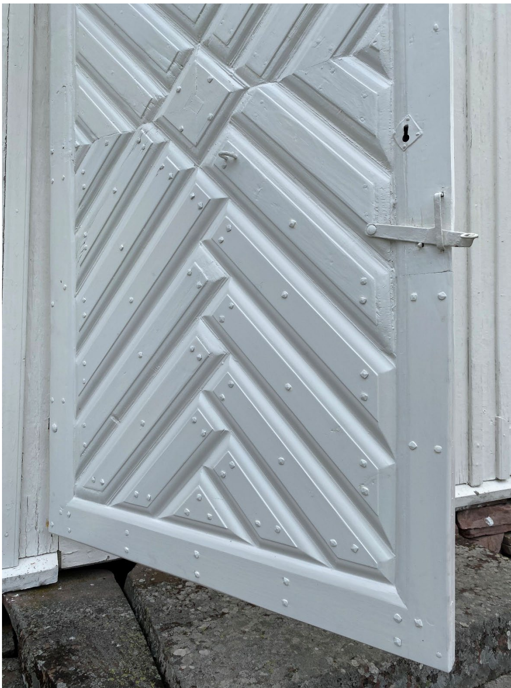
Figur 9. Dörren efter avslutade arbeten. Foto: Ulrika Olsson, Länsmuseet Gävleborg, 2024-07-03.
