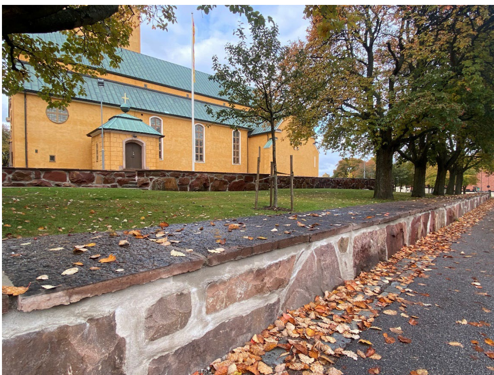
Figur 11. Efter avslutade arbeten. Murarna i tomtgränsen söder om kyrkan. Foto: Ulrika Olsson, 2024-10-08.
