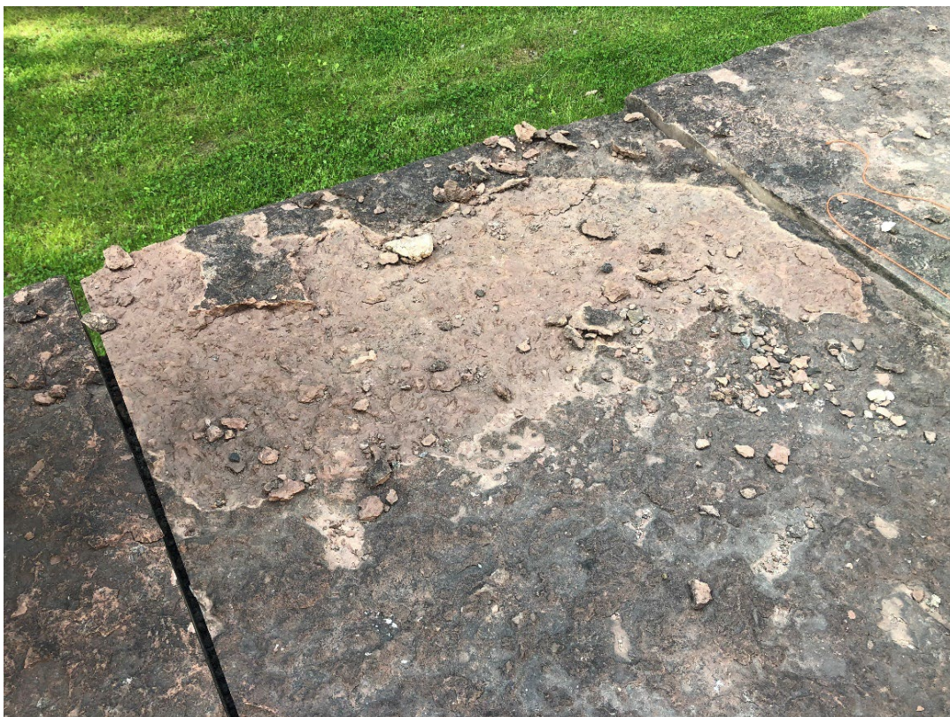
Figur 7. Innan påbörjade arbeten. Exempel på en häll som under årets etapp har bytts ut till en ny häll. Foto: Ulrika Olsson, 2024-06-05.
