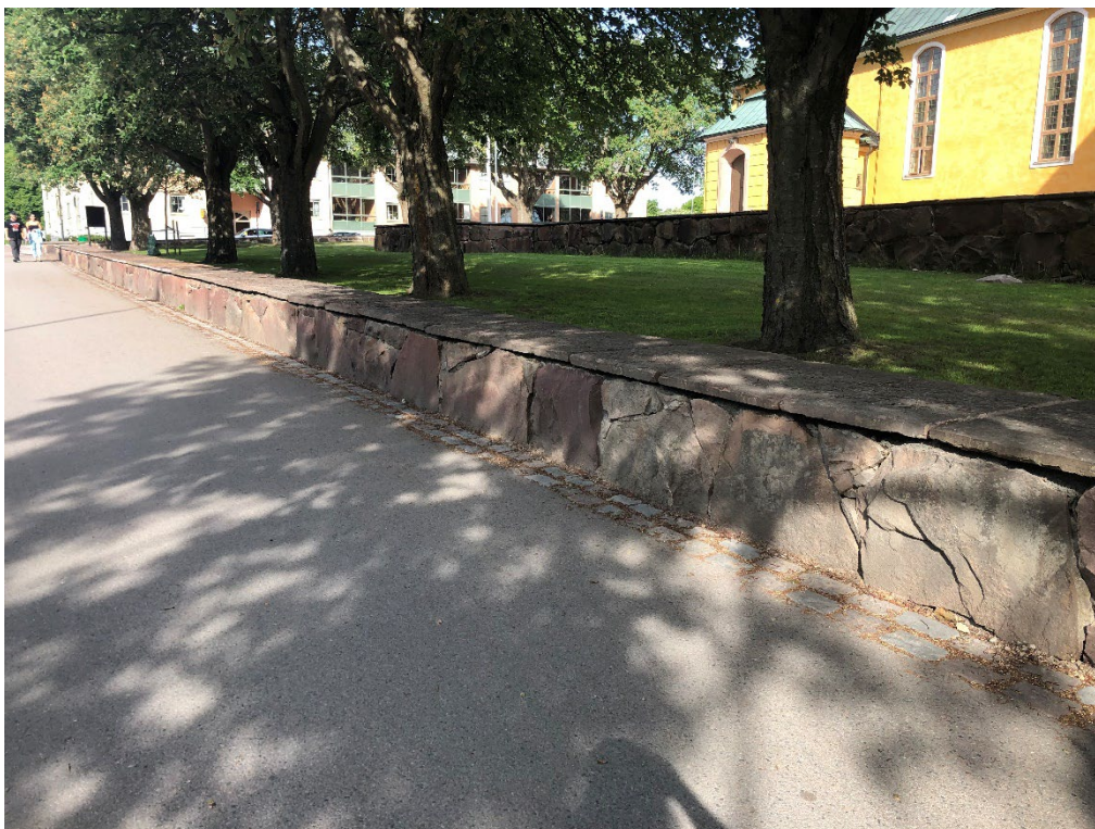
Figur 5. Den södra muren invid cykelbanan innan påbörjade arbeten. Foto: Ulrika Olsson, 2024-06-05.
