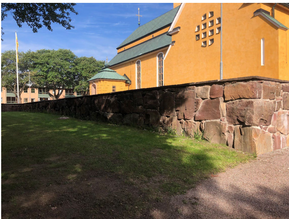
Figur 6. Den södra muren närmast kyrkan innan påbörjade arbeten. Foto: Ulrika Olsson, 2024-06-05.
