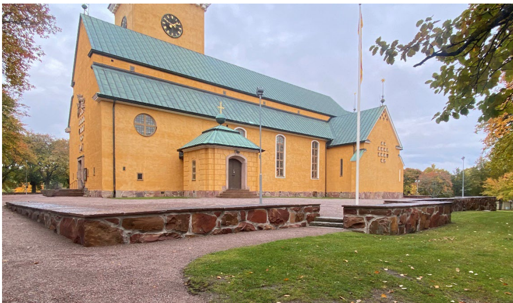
Figur 8. Efter avslutade arbeten. Murarna närmast söder om kyrkan. Foto: Ulrika Olsson, 2024-10-08.
