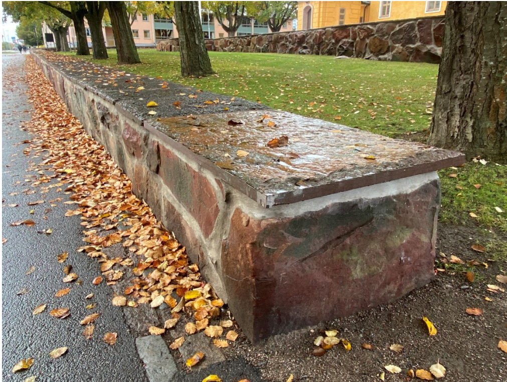
Figur 12. Efter avslutade arbeten. Murarna i tomtgränsen söder om kyrkan. Foto: Ulrika Olsson, 2024-10-08.
