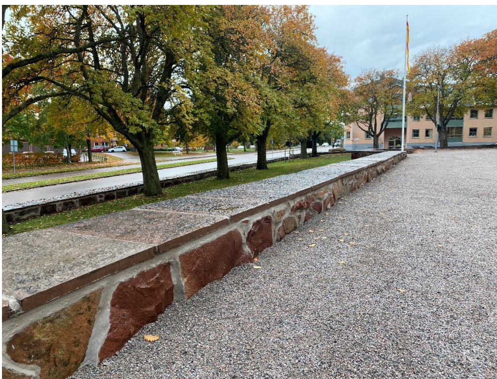
Figur 9. Efter avslutade arbeten. Murarna närmast söder om kyrkan. Dessa murar är till stor del markfjällda på den norra sidan. Foto: Ulrika Olsson, 2024-10-08.
