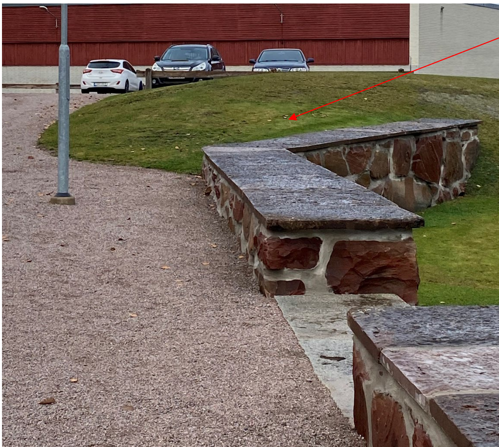
Figur 14. Efter avslutade arbeten. Murarna närmast öster om kyrkan. Pilen visar var det tidigare växte ett träd, vilket nu har tagits ner. Foto: Ulrika Olsson, 2024-10-08.
