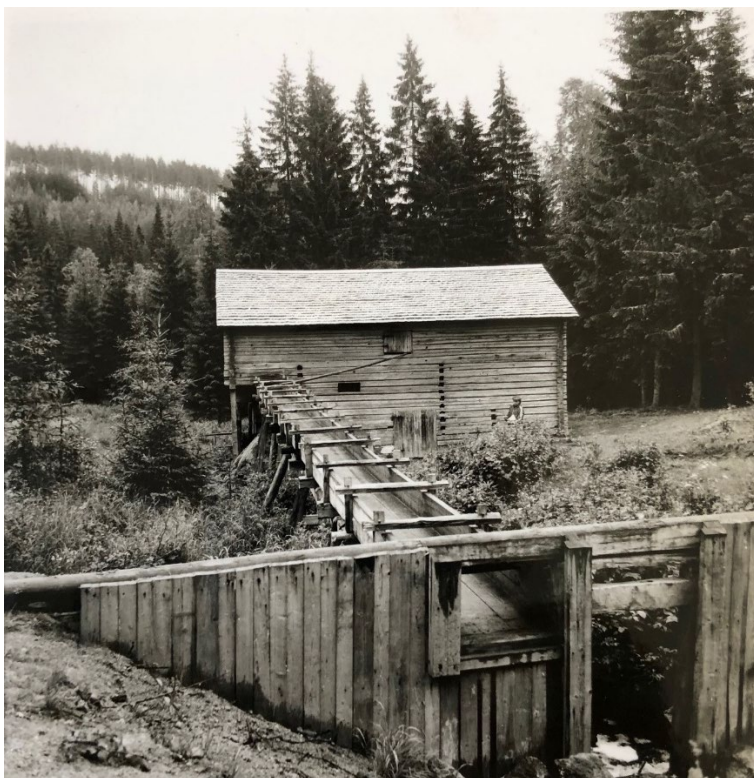
Figur 2. Ålkarsskäkten efter renoveringen 1983. Foto från nordväst med dammluckor och ränna. Foto: Carl-Magnus Gagge. Fotobeteckning: XLM K 83-1554.
