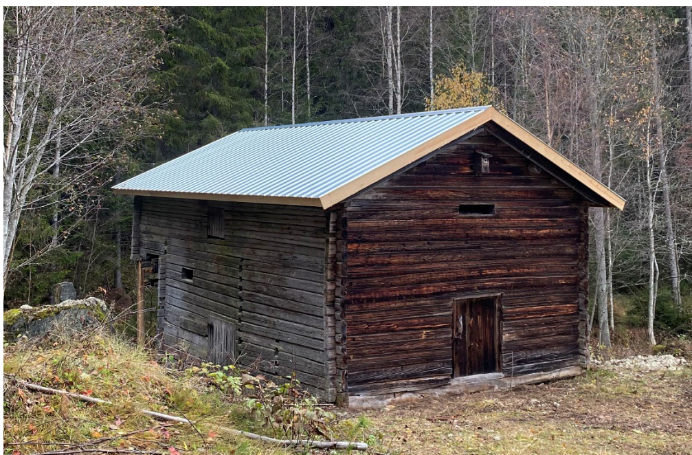
Figur 9. Ålkarsskäkten sedd från sydväst efter avslutade arbeten. Den nya taktäckningen av galvaniserad pannplåt är lagd ovanpå det tidigare spåntaket. Vindskivor och takfotsbrädor består av ramsågad kärnfuru. Foto: Ulrika Olsson, 2024-10-18.
