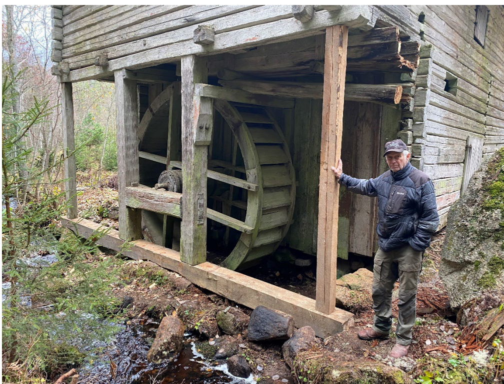
Figur 11. Lennart Östergrens vid den nordöstra gaveln där den yttre timmerstocken samt den närmaste stolpen har bytts ut till nya delar. Foto: Ulrika Olsson, 2024-10-18.
