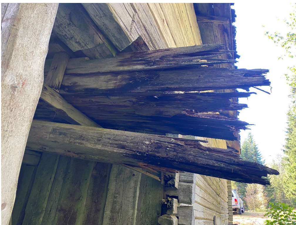
Figur 8. Rester från den tidigare rännan i trä som från nordväst ledde in vattnet från dammen. Foto: Ulrika Olsson, 2024-09-13.
