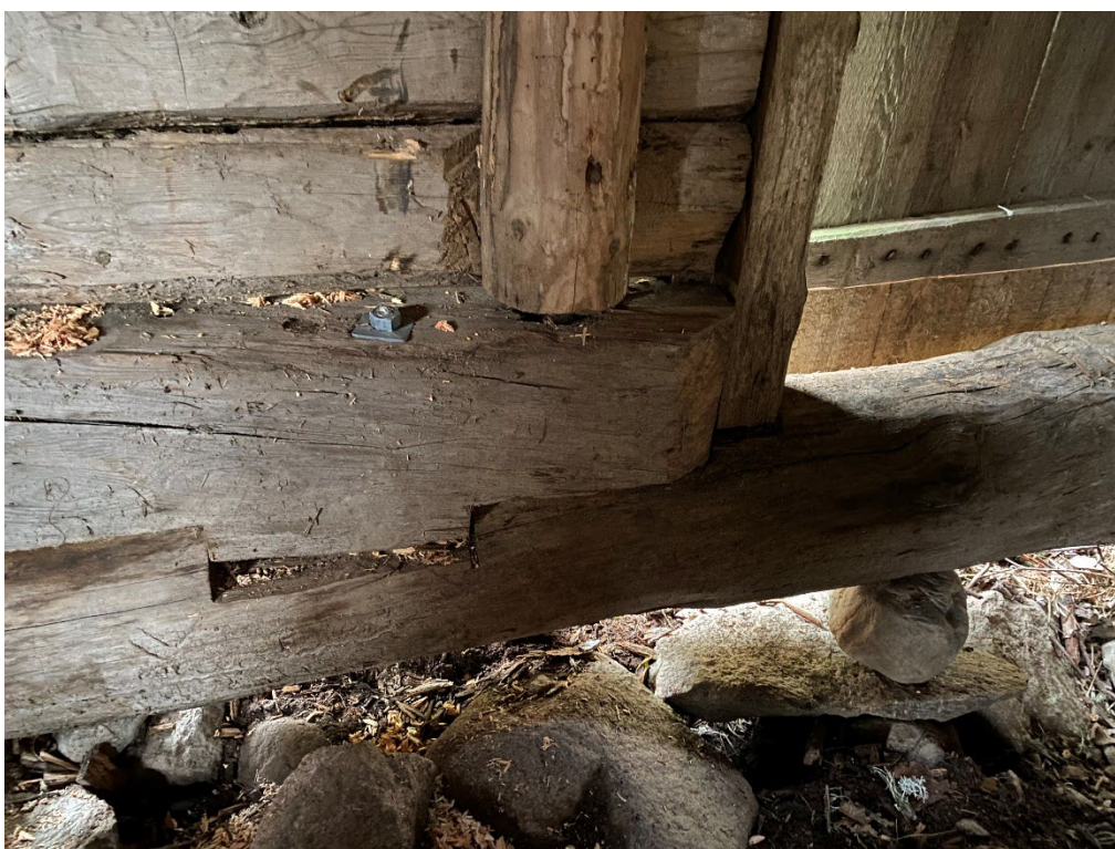
Figur 14. De två överskjutande sylldelarna efter den norra långsidan har säkrats med en gängstång. Foto: Ulrika Olsson, 2024-10-18.
