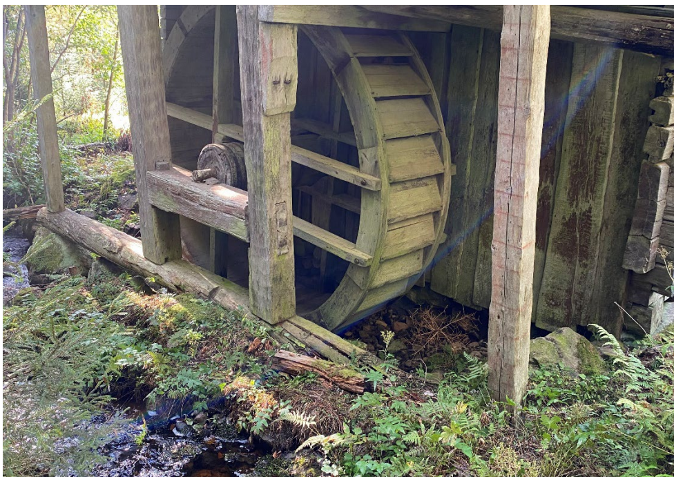
Figur 5. Ålkarsskäktens nordöstra gavel med vattenhjulet innan påbörjade arbeten. Den yttre timmerstocken har sjunkit ner i marken, liksom den närmaste stolpen. Båda dessa delar var rötskadade. Foto: Ulrika Olsson, 2024-09-13.
