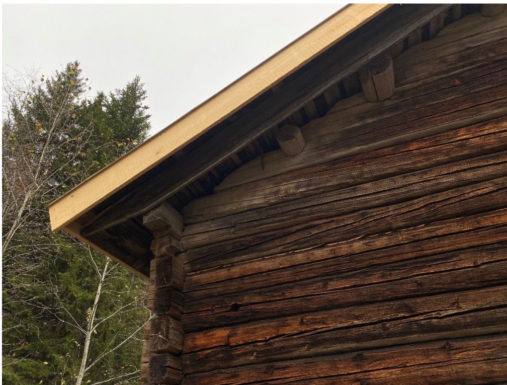
Figur 10. Gavelsprånget är utdraget något i jämförelse med det äldre gavelsprånget. De äldre vindskivorna är bevarade innanför de nya. Foto: Ulrika Olsson, 2024-10-18.
