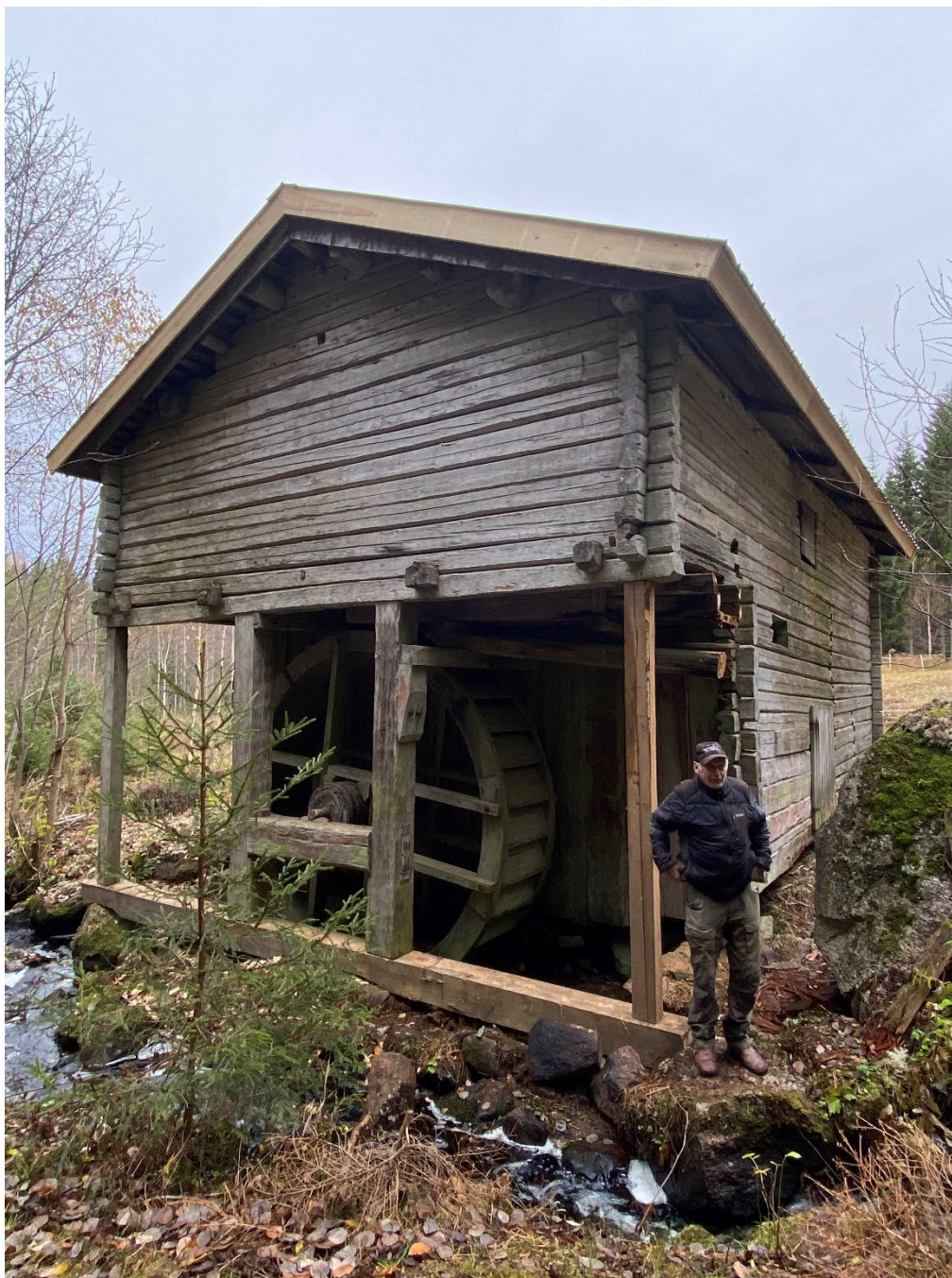
Figur 12. Lennart Östergrens vid den nordöstra gaveln efter avslutade arbeten. Notera de nya vindskivorna och takfotsbrüdan samt att de murkna delarna i den före detta vattenrännan har kapats, vilket ger ett mer helt intryck. Foto: Ulrika Olsson, 2024-10-18.
