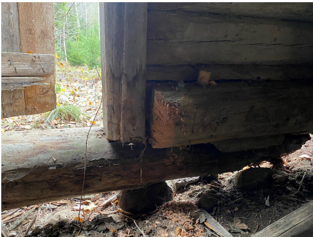
Figur 13. De två överskjutande sylldelarna efter den södra långsidan har skjutits ihop och säkrats med en gängstång. Foto: Ulrika Olsson, 2024-10-18.
