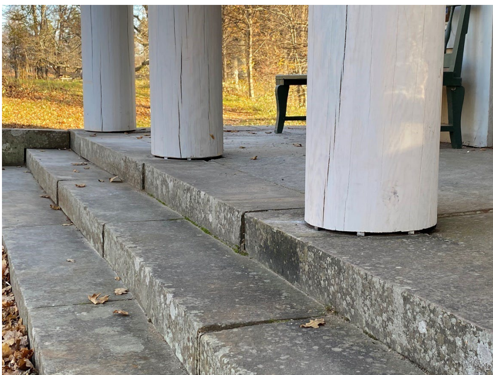
Figur 11. De tre bytta pelarna står nu på distanser av järn. Foto: Ulrika Olsson, 2024-10-24.
