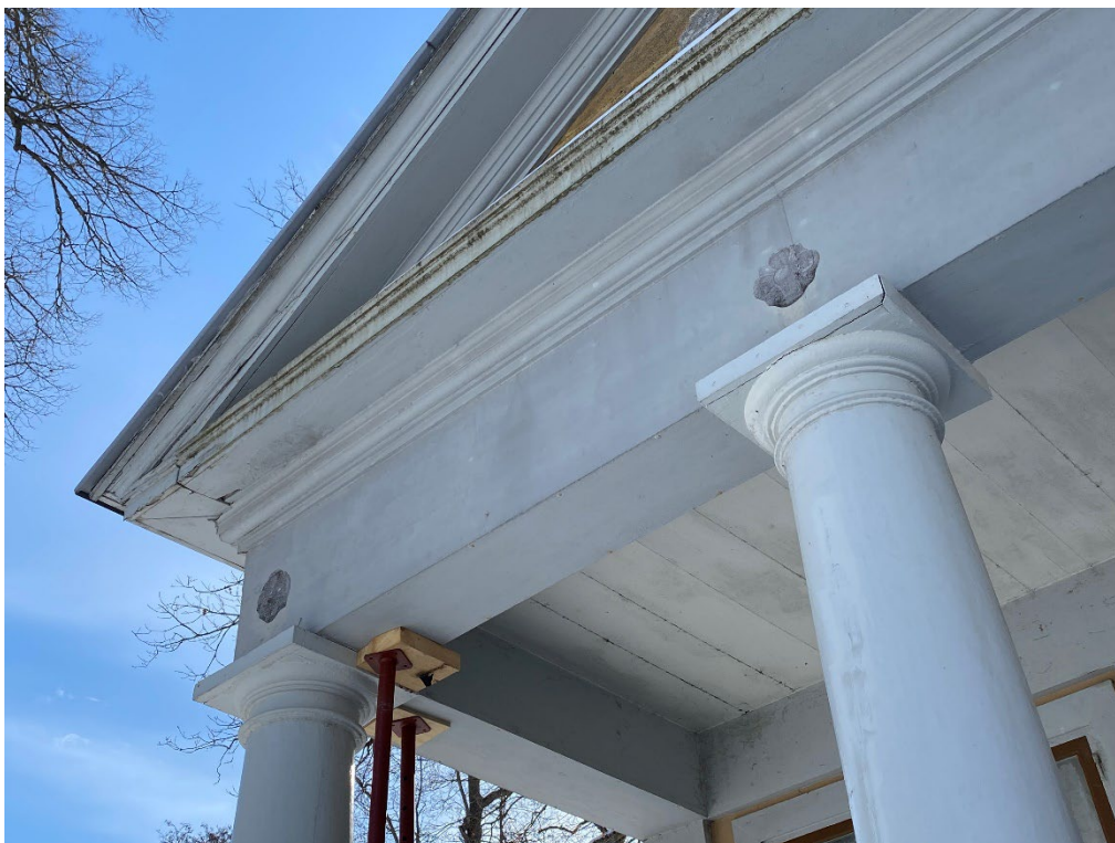
Figur 5. Syftet med att demontera den yttersta pelaren, nummer 1, var för att få svar på hur de olika delarna upptill var sammanfogade samt hur förbindelsen mot gavelns nedre kant såg ut. Foto: Ulrika Olsson, 2024-03-19.
