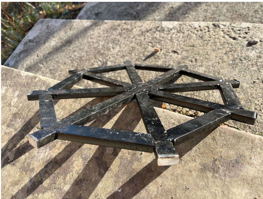
Figur 10. De tre nya pelarna vilar på solformade järnkonstruktioner. På så vis kommer inte pelarna att suga fukt från stenhällarna. Foto: Richard Klingberg sommaren 2024.
