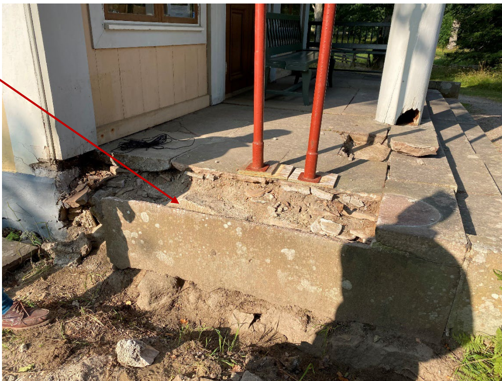
Figur 7. På bilden syns den stora stenen som av okänd anledning skjutit upp ovanliggande hällar. Det stora sidostycket är fastspikat i den stora stenen. Foto: Ulrika Olsson, 2024-08-20.
