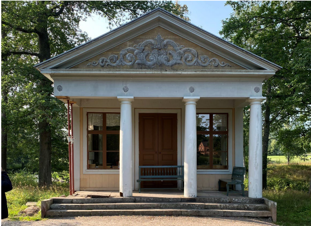
Figur 6. Vid besöket i slutet av augusti hade arbetet med stenläggningen påbörjats. Den nordöstra pelaren, nummer 1, var demonterad. Foto: Ulrika Olsson, 2024-08-20.
