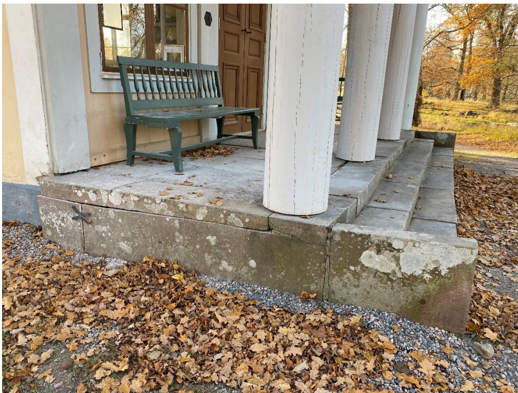
Figur 9. Efter avslutade arbeten. Sidostyckena är justerade, liksom de ovanliggande stenhällarna. Foto: Ulrika Olsson, 2024-10-24.
