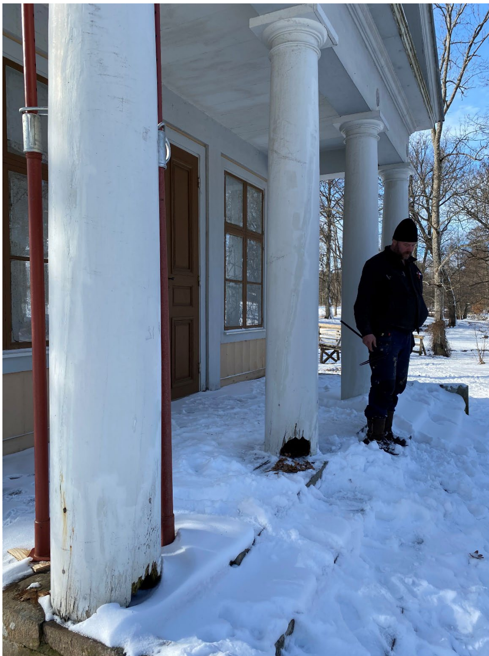
Figur 4. Vid det första besöket bestämdes den fortsatta gången på projektet. Pelare 1 syns närmast i bild. Med på bild är Dan Gavell, Gysinge Kulturbygg som här har dämt upp tempelgaveln för att anlasta pelare 1. Foto: Ulrika Olsson, 2024-03-19.
