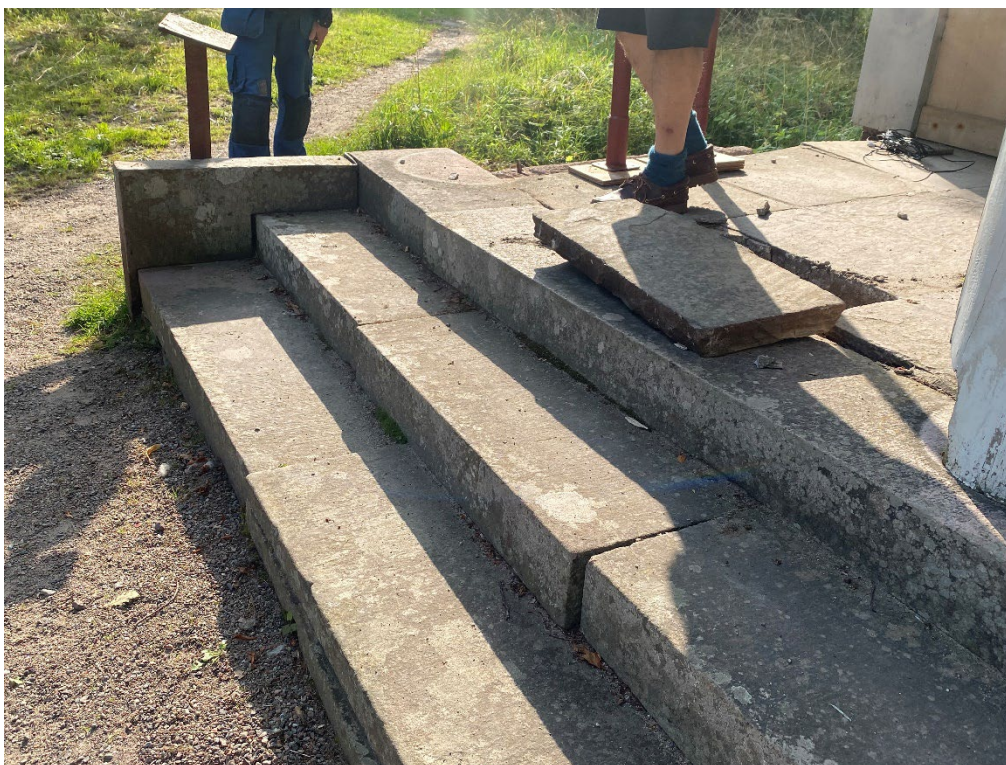
Figur 8. Hällar som sjunkit åtgärdades genom att stensmjöl 0-4 fylldes upp under dem tills dess att hällarna hamnade i en acceptabel nivå. Foto: Ulrika Olsson, 2024-08-20.
