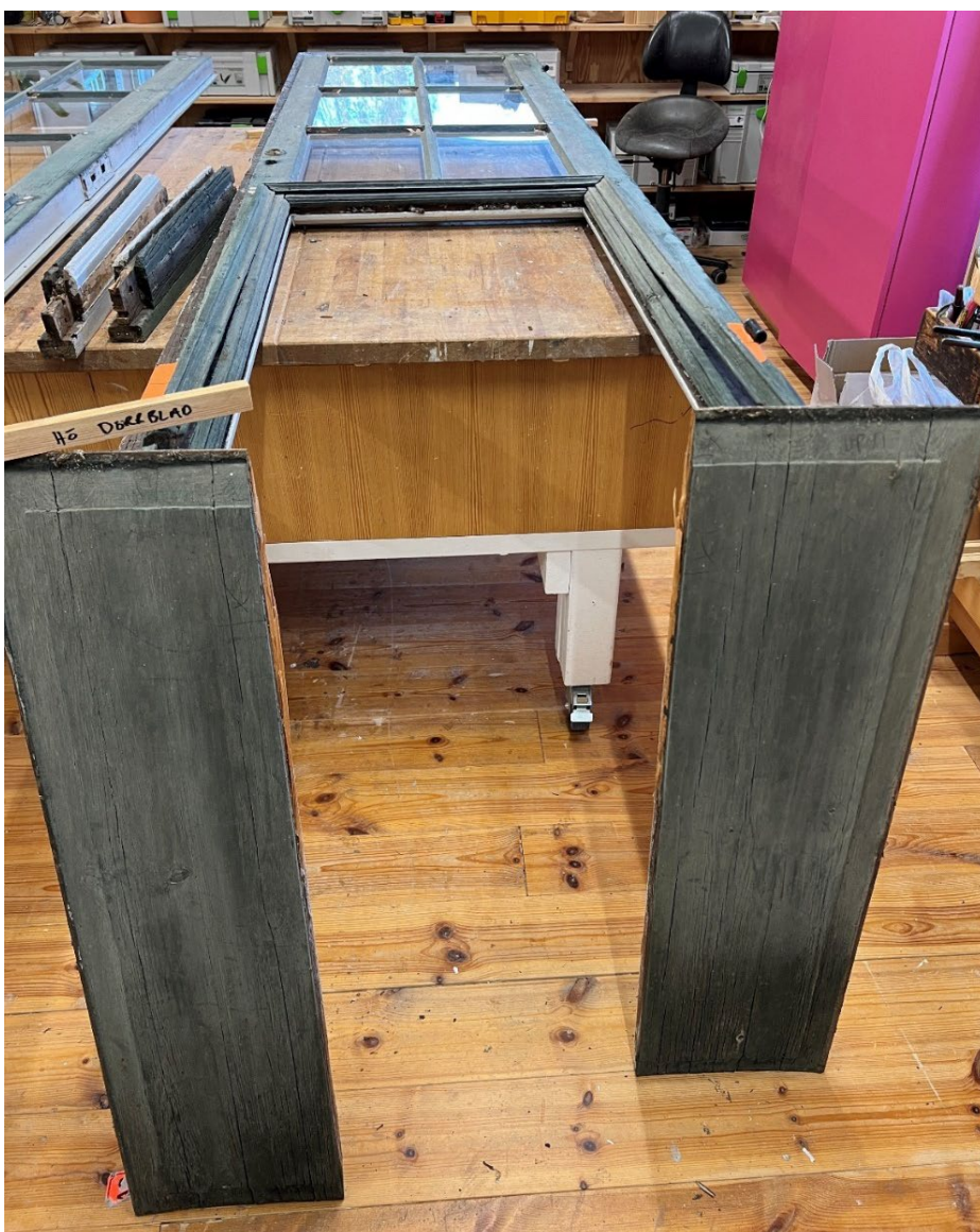
Figur 21. Spegelarna demonterades för att delarna skulle kunna slås ihop och sprickor åtgärdas. Foto: Heinemanns snickeri hösten 2024.
