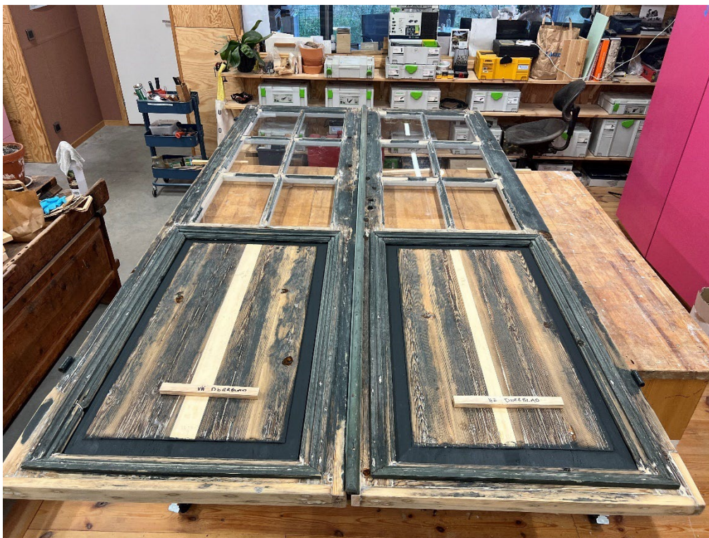
Figur 22. Under pågående arbete med dörrarna. Glipor i speglarna har slagits ihop och speglarna har breddats med nytt virke. Delarna har limmats ihop. Foto: Heinemanns snickeri hösten 2024.
