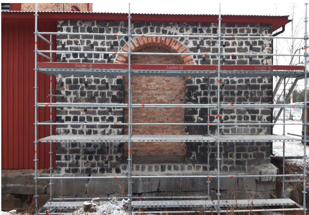
Figur 41. Slaggstensdelen på hyttans södra sida har fogats om. Foto: Daniel Olsson, 2024-11-29.
