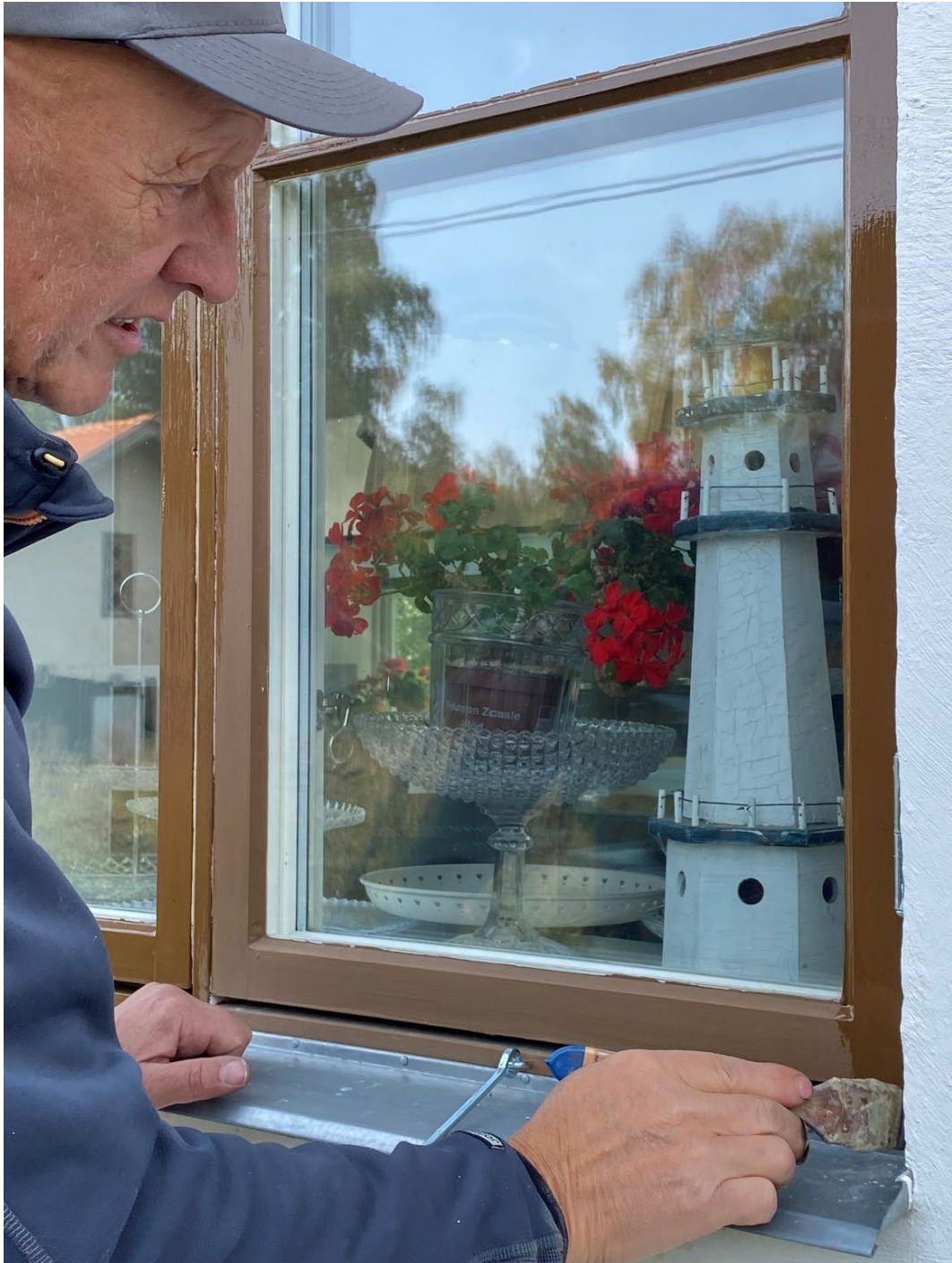
Figur 28. Målare Anders Löfman under pågående arbete med halvvoljning av fönsterbågar och karmar på orangeriet. Foto: Ulrika Olsson, 2024-09-18.
