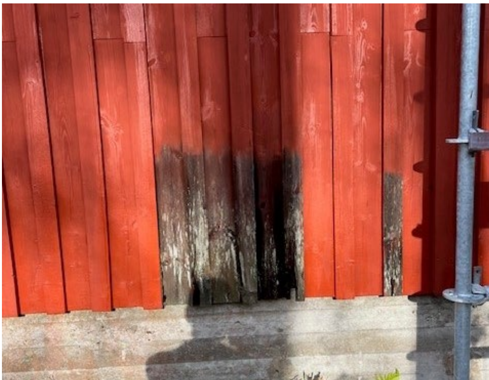
Figur 38. Under arbetets gång med panelen mot söder. På fotot syns hur enstaka panelbrädor har bytts ut till nytt virke. Foto: Anders Löfman hösten 2024.
