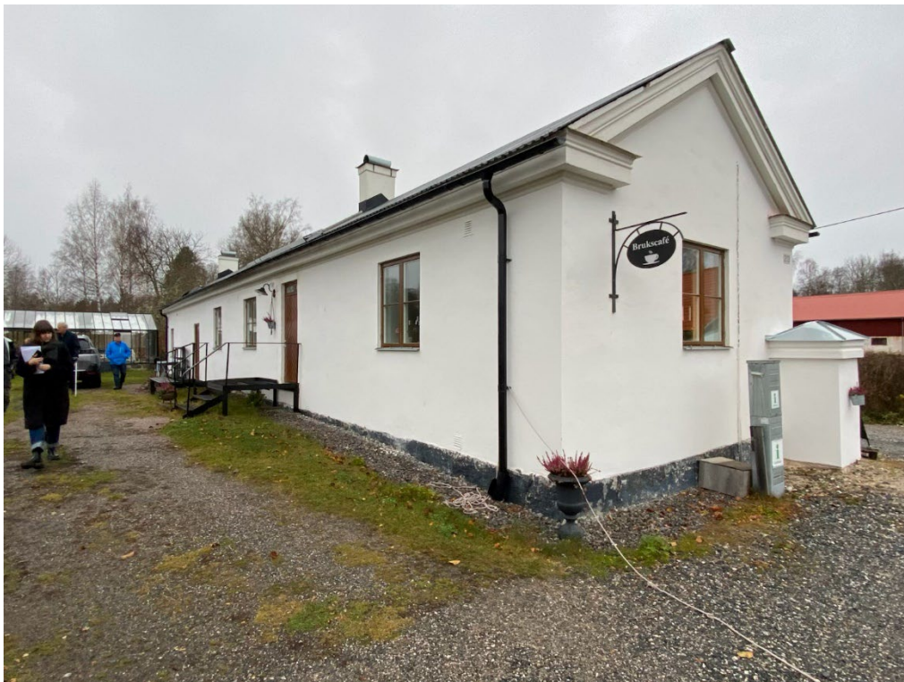
Figur 30. Orangeriet sett från sydöst efter avslutade arbeten där fönsterbågar och dörrar har halvöljats. Foto: Ulrika Olsson, 2024-10-31.
