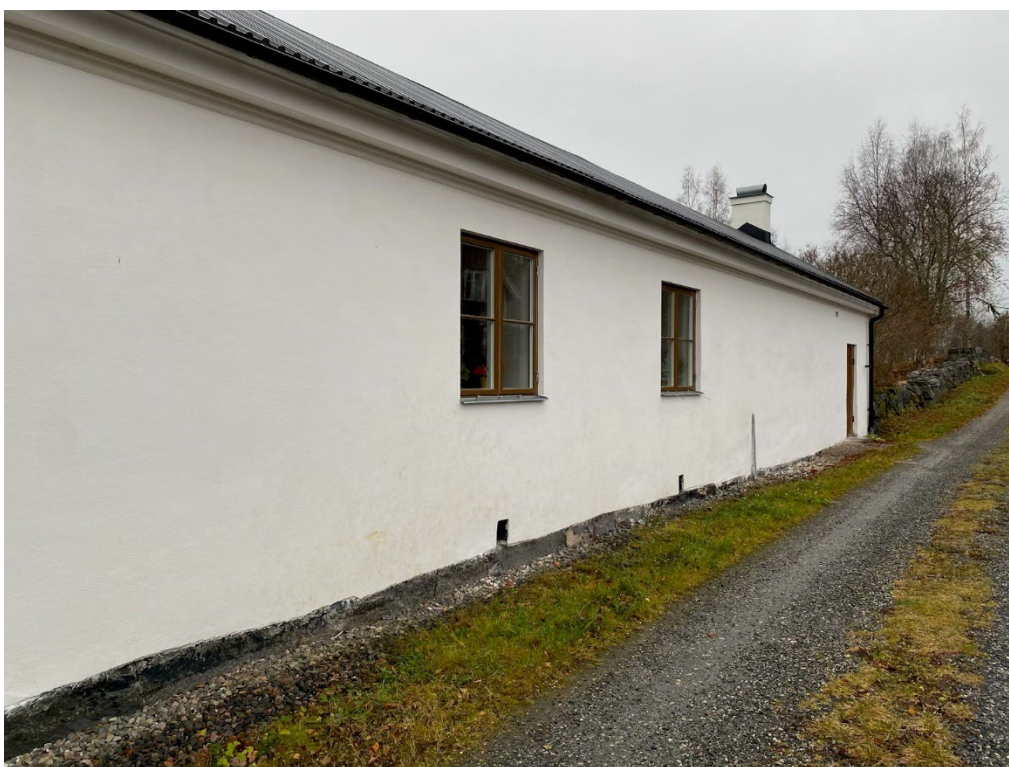
Figur 31. Den norra fasaden efter avslutade putsarbeten. Foto: Ulrika Olsson, 2024-10-31.
