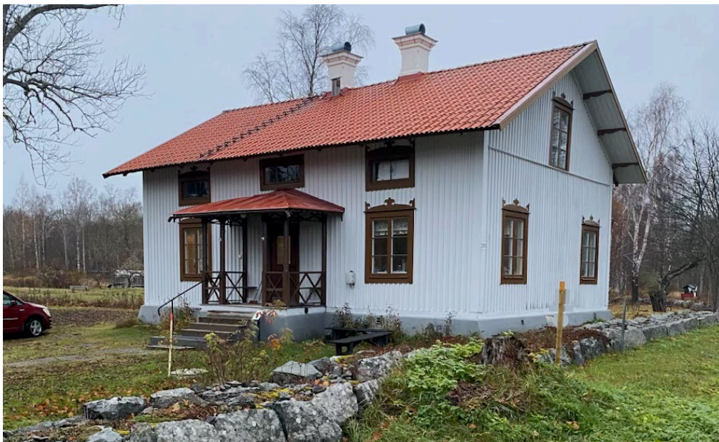
Figur 36. Kontoret sett från sydöst efter avslutade arbeten där de flesta snickeridetaljer har halvvoljats. Foto: Ulrika Olsson, 2024-10-31.
