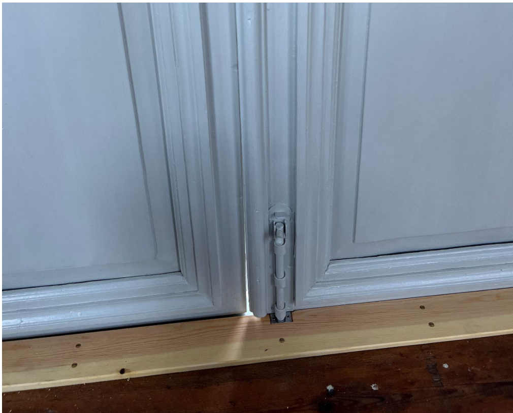
Figur 50. Glipa mellan dörrbladen som uppmärksammades då de nyrenoverade dörrarna återmonterades i lusthuset. Foto: Heinemanns snickeri, hösten 2024.
