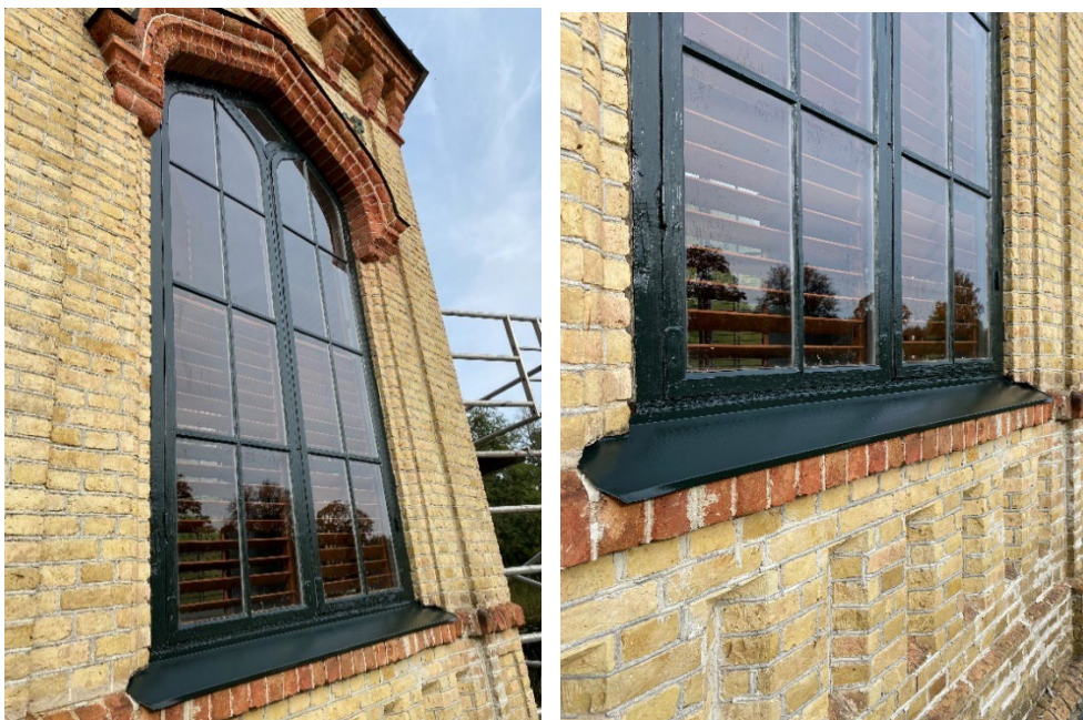
Figur 18 och 19. Renoverade fönsterbågar och nya fönsterbleck i lusthuset. Foto: Ulrika Olsson, 2024-09-18.
