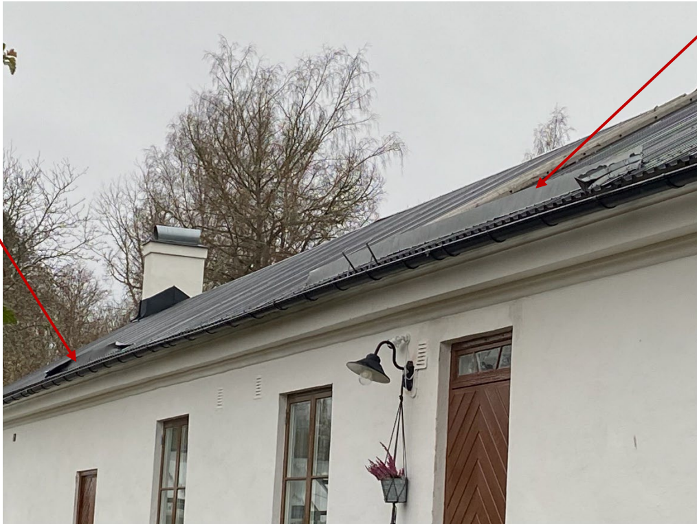
Figur 53. Snörasskydden sitter lösa och/ eller har demolerad form. Foto: Ulrika Olsson, 2024-10-31.
