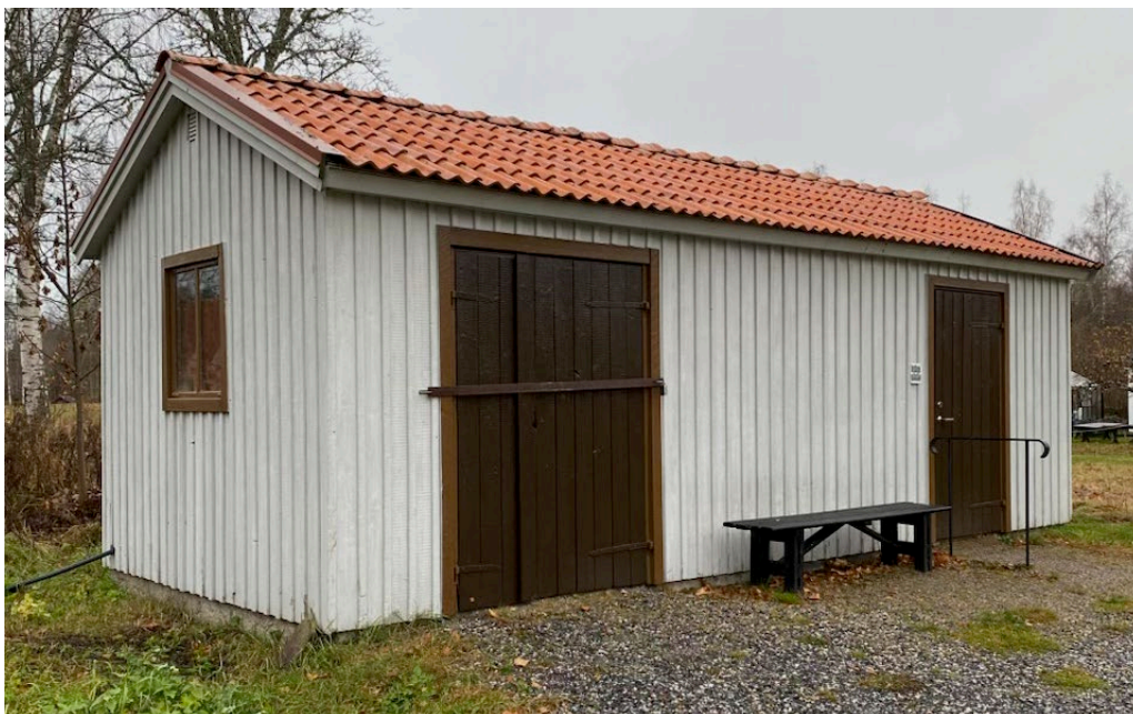
Figur 34. Förrådet efter avslutade arbeten. Fönsterbågar, fönsterkarmar, dörrar och foder har målats om. Foto: Ulrika Olsson, 2024-10-31.
