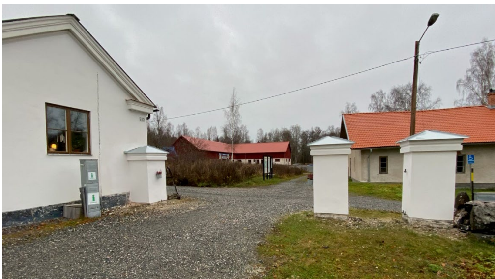
Figur 33. De tre grindstolparna vid orangeriet efter avslutade arbeten. Notera de nya nätta huvorna som är utformade med huvorna på det historiska fotot som förlaga. Foto: Ulrika Olsson, 2024-10-31.
