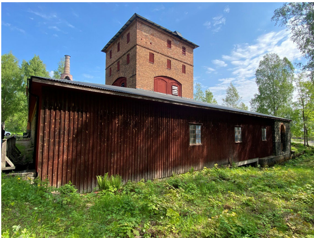
Figur 14. Hyttans södra panelklädda fasad och fönsterbågar var i behov av renovering. Foto: Ulrika Olsson, 2024-05-28.
