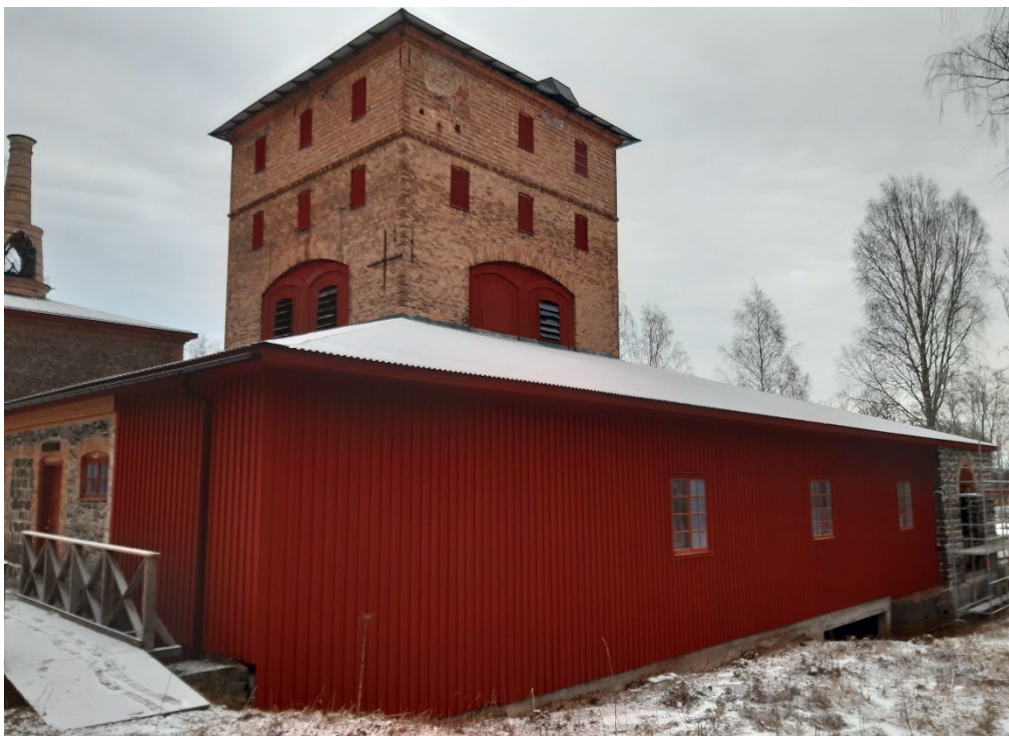
Figur 40. Den södra sidan av hyttan efter avslutade arbeten. Panel, takfot och fönster har målats och den borte slaggstensdelen har fogats om. Foto: Daniel Olsson, 2024-11-29.
