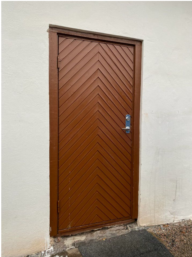
Figur 29. Entrédörren på orangeriets norra sida efter halvöljning. Foto: Ulrika Olsson, 2024-10-31.
