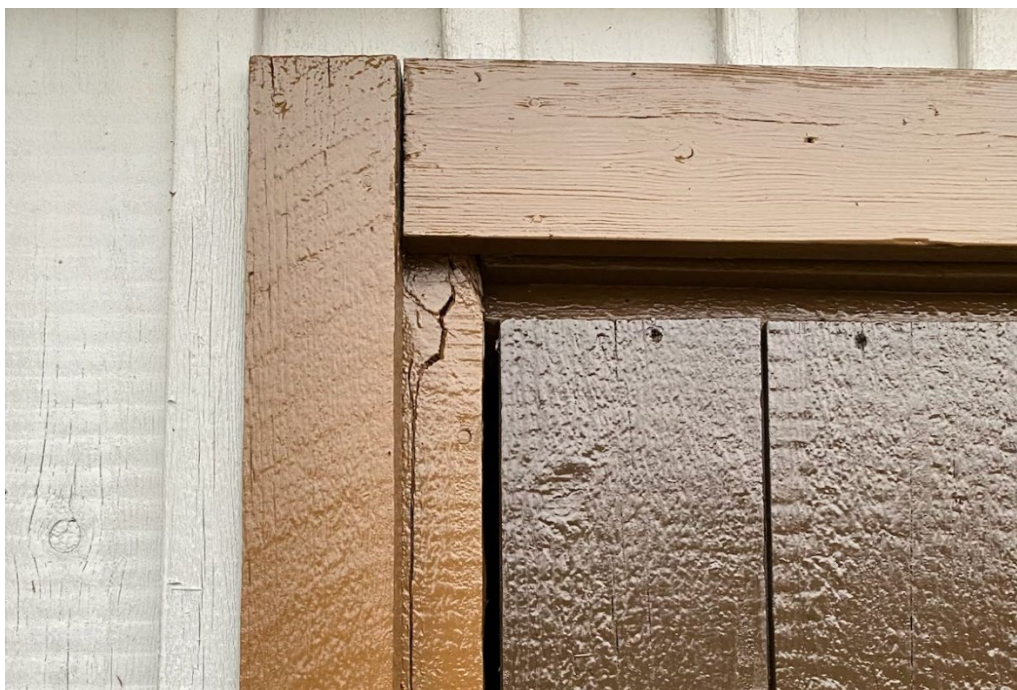
Figur 35. Närbild på de två olika kulörerna som foder och dörrar har målats i. Foto: Ulrika Olsson, 2024-10-31.
