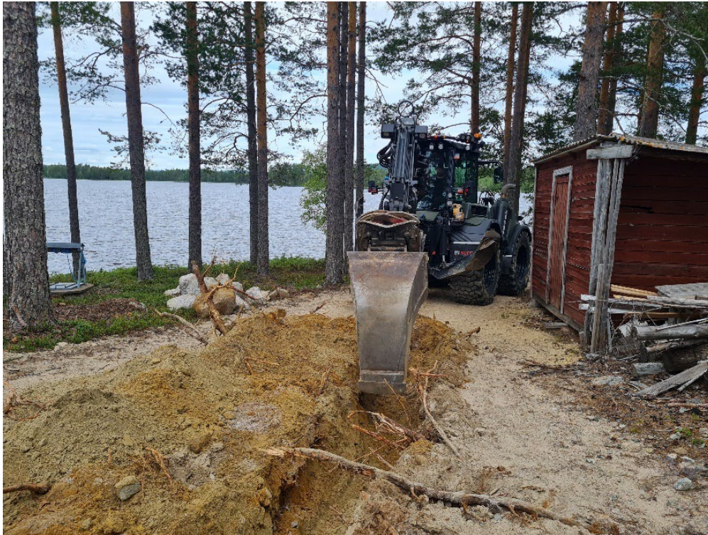
Figur 14. Kabelschaktet väster om stenåldersboplatsen och slaggförekomsten. Foto från söder: Maria Björck.
