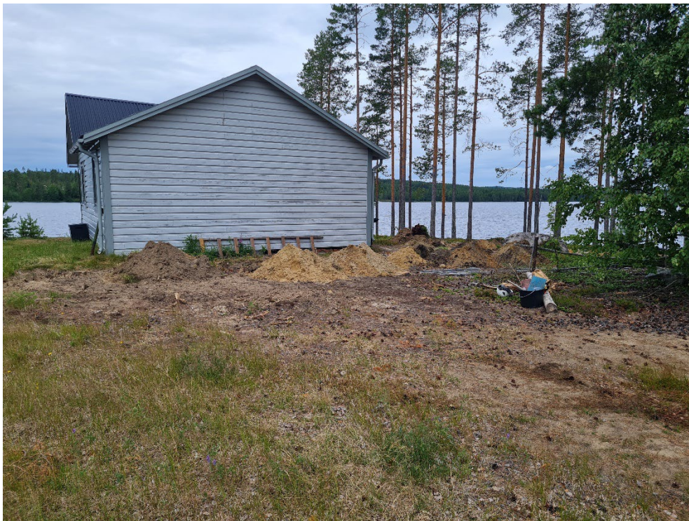
Figur 15. Kabelschaktet. Foto från väster: Maria Björck.
