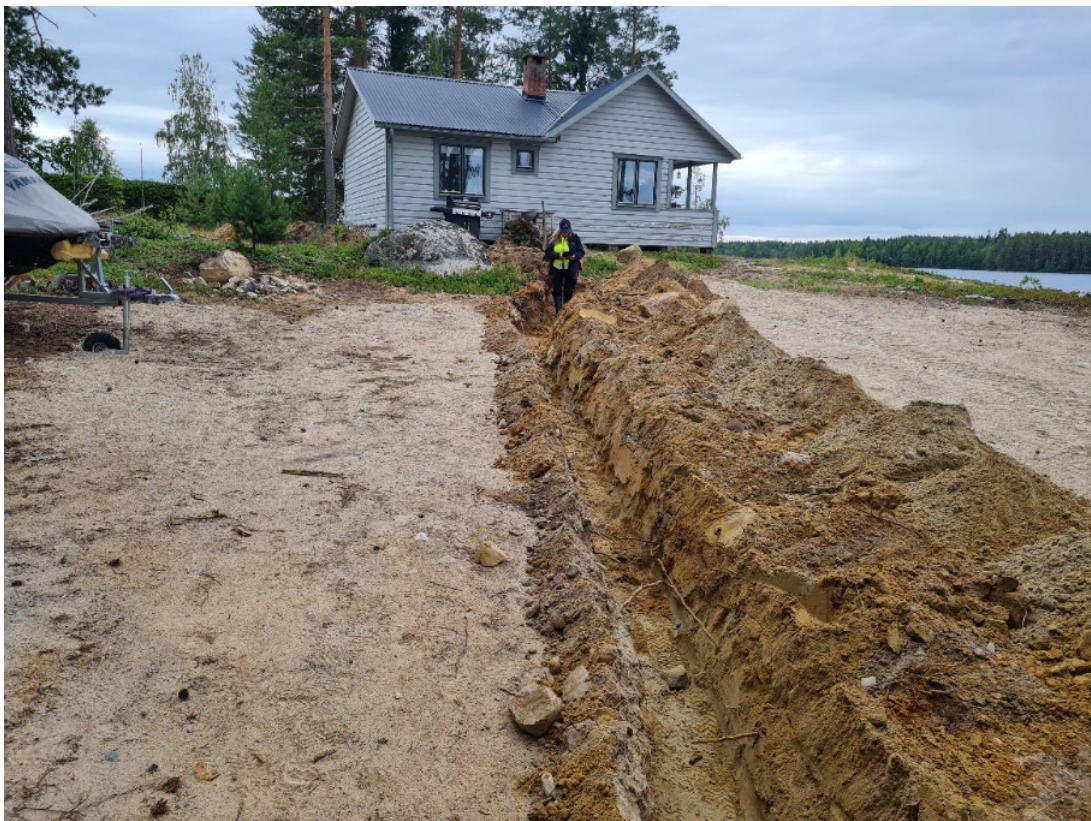
Figur 13. Kabelschaktet väster om stenåldersboplatsen och slaggförekomsten. Foto från norr: Maria Björck
