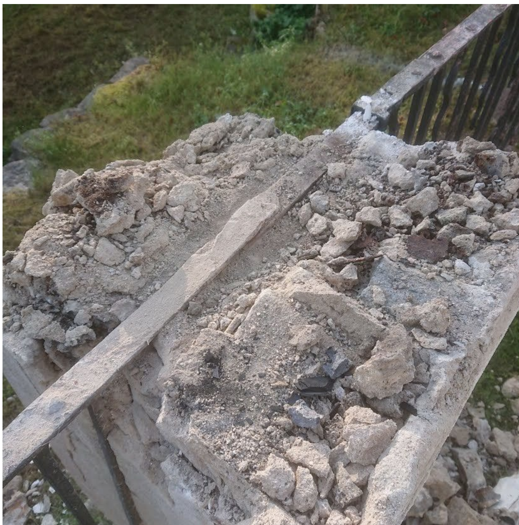
Figur 37. Under rivningen av en staketstolpe. Staketsektionerna är inmurade i stolparna. Foto: Valbo Fasad, oktober 2024.
