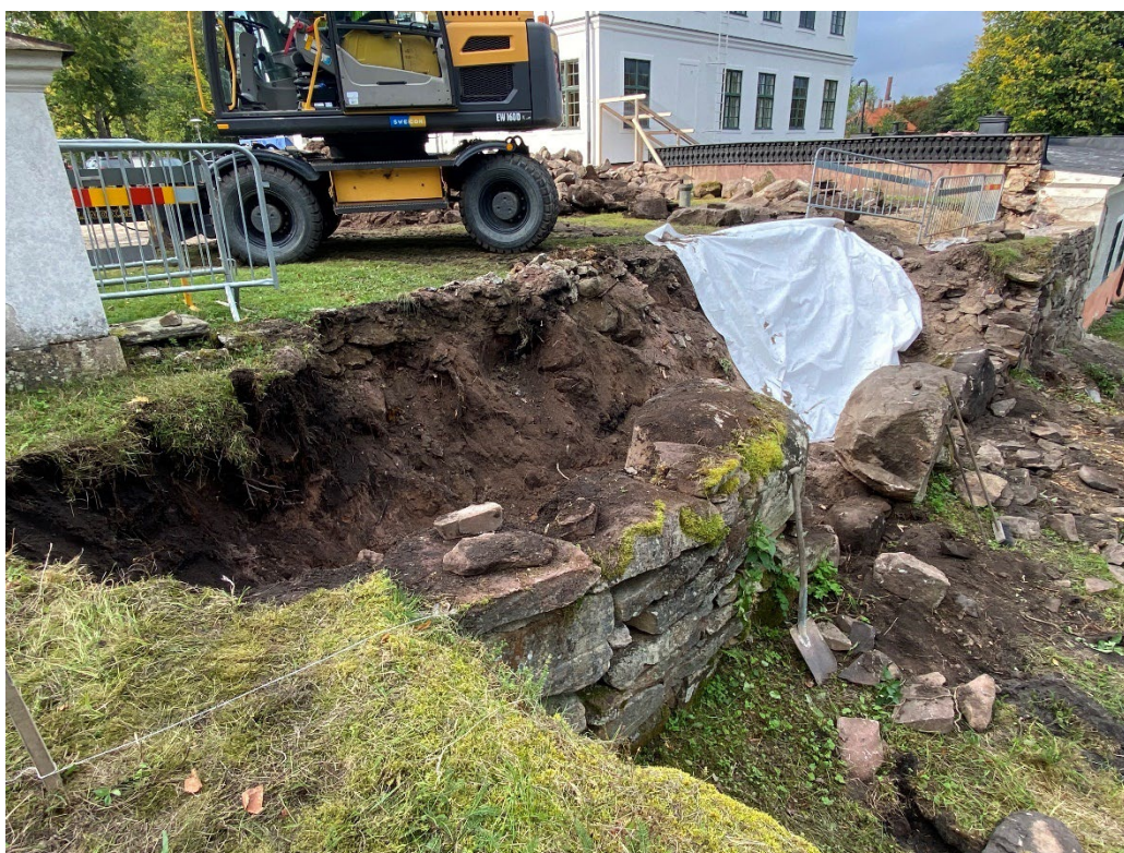
Figur 29. Kärnan är helt urgrävd och de flesta stenarna i den södra terrassmuren är demonterade. Kärnan bottas med markduk innan påfyllning påbörjas. Foto: Ulrika Olsson, 2024-09-23.
