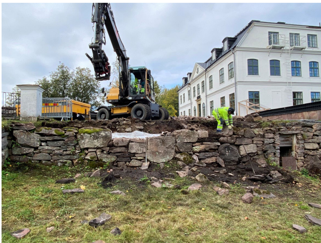
Figur 32. Under pågående arbeten med den södra sidan. Allt eftersom stenarna i muren lades på plats, fylldes kärnan upp. Foto: 2024-09-26.
