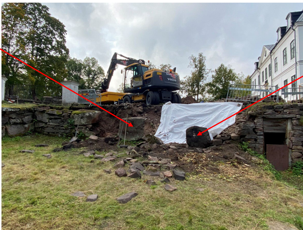
Figur 28. Kärnan är helt urgrävd och stenarna i den södra terrassmuren är demonterade. Två stora stenar lämnades i sina lägen. Foto: Ulrika Olsson, 2024-09-23.
