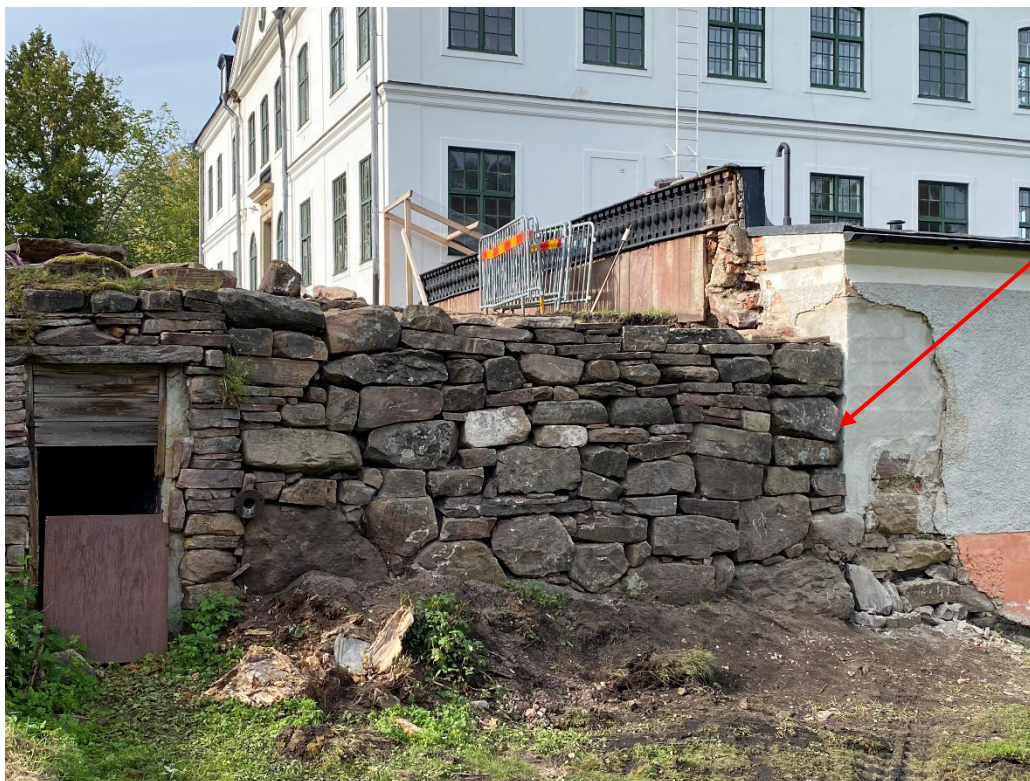
Figur 22. Den norra delen är till största del färdigmurad. Notera generalskarven mot flygelns mur. Foto: Ulrika Olsson, 2024-09-18.
