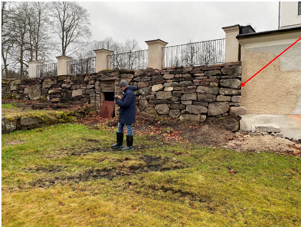
Figur 46. Terrassmuren och de fyra nymurade staketstolparna med mellanliggande renoverade smidessektioner. Notera generalskarven mellan terrassmuren och den östra flygeln samt lagningen i flygelns mur. Foto: Ulrika Olsson, 2024-12-02.
