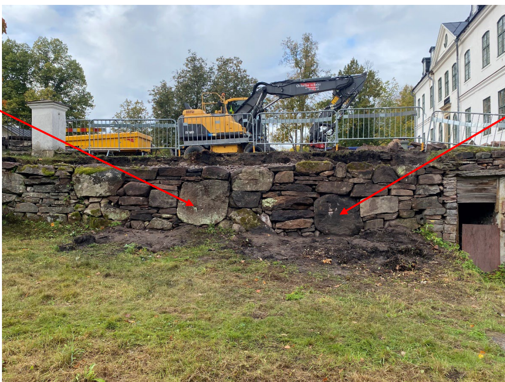
Figur 34. Den södra sidan av muren är till största del färdigmurad. Notera de två stora stenarna som lämnades kvar i sina ursprungliga lägen när resterande mur hade demonterats. Foto: Ulrika Olsson, 2024-10-01.
