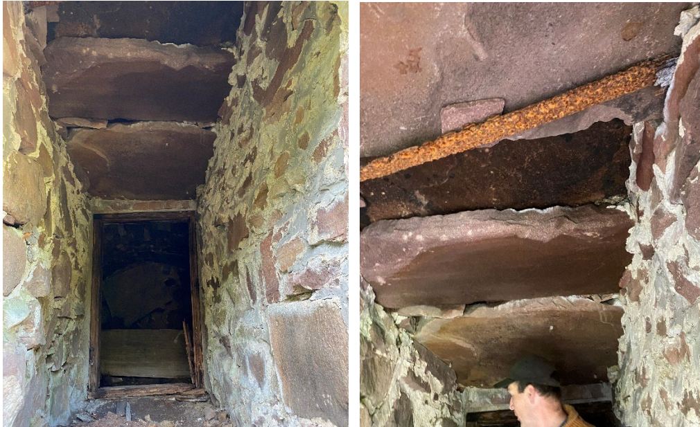
Figur 13 och 14. Taket i källarsvalen består av sandstenshällar. Foto: Ulrika Olsson, 2024-09-12.
