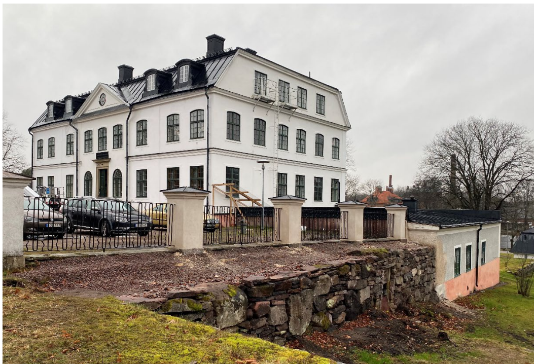
Figur 1. Staketet och terrassmuren vid slutbesiktningen 2024-12-02. Foto: Ulrika Olsson.
