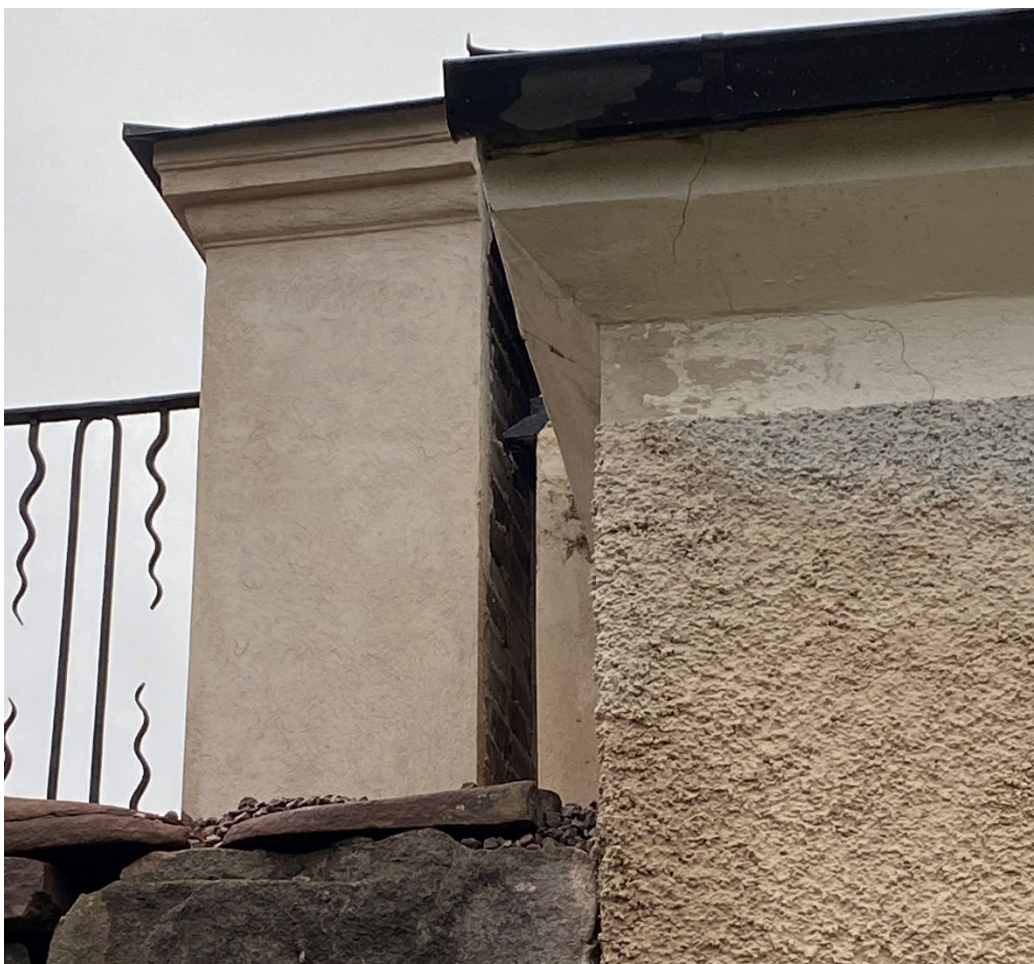
Figur 49. Insidan av staketstolpen närmast den östra flygeln är inte putsad. Sidan ska putsas innan hela stolpen anfärgas under säsongen 2025. Foto: Ulrika Olsson, 2024-12-02.
