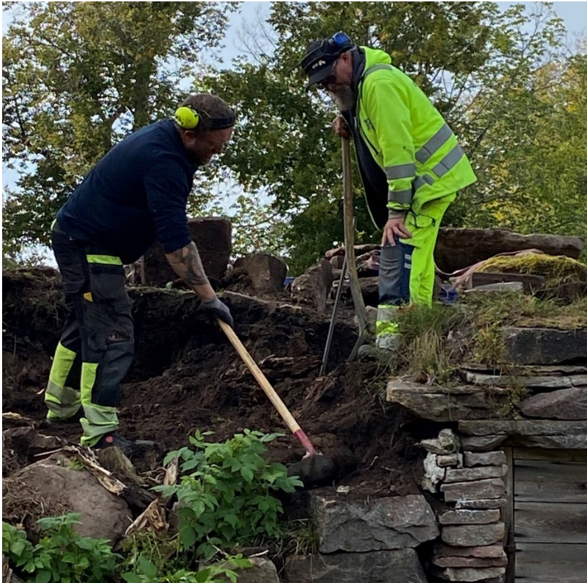
Figur 26. Två av stenväggarna jobbade parallellt med grävmaskinistens skopa. Rötter hanterades varsamt och när de var frigjorda lades de åt sidan. Foto: Ulrika Olsson, 2024-09-18.
