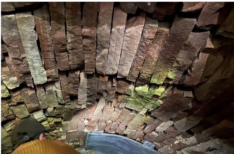
Figur 15. Källarvalvet består av stående sandstenshällar, en konstruktion som Lilja kallar ”Ring på ring”. Foto: Ulrika Olsson, 2024-09-12.
