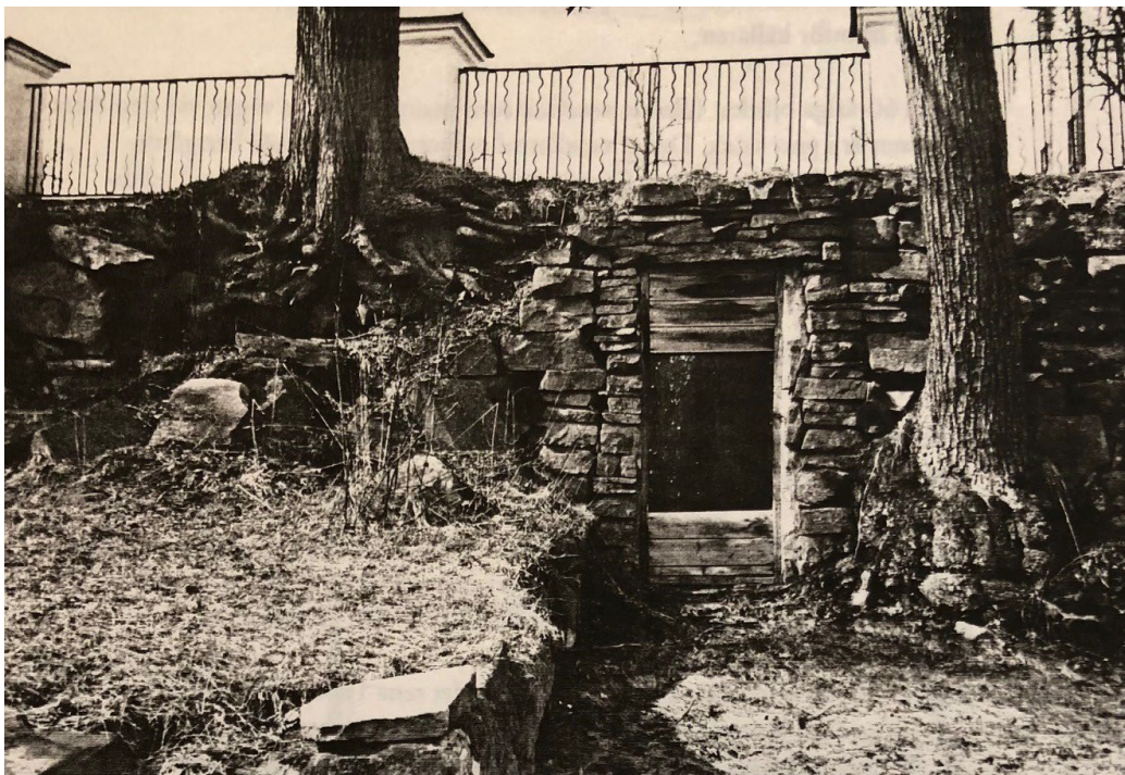
Figur 9. Foto hämtat ur rapporten Trädgårdsanläggningarna kring Forsbacka herrgård -Skötsel- och åtgärdsplan, Läns museet Gävleborg rapport 1995:12, som visar terrassmuren, källaringången och två av de träd som växte tätt på muren och som har orsakat skador i den.
