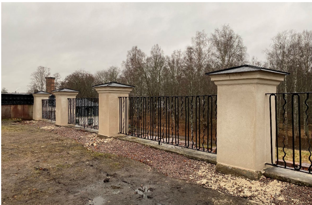
Figur 42. Arbetet med staketet och de murade stolparna är nästan färdigt. Avfärgning av staketstolparna återstår. Foto: Ulrika Olsson, 2024-12-02.
