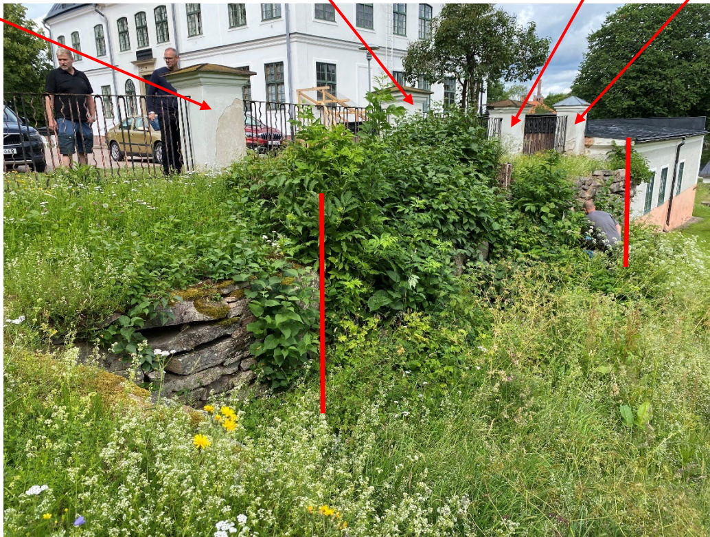
Figur 16. De stolpar som ingår i projektet är markerade med röda pilar. Den ungefärliga sträckan för terrassmuren som ska åtgärdas är markerad. Foto: Ulrika Olsson, 2024-07-04.
