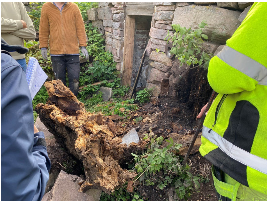
Figur 21. Resterna efter trädet som tidigare hade växt till höger om källaringången gick enkelt att avlägsna eftersom allt trä var murket. Foto: Ulrika Olsson, 2024-09-12.
