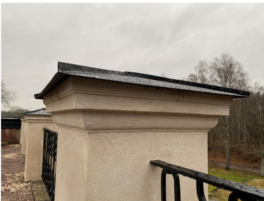
Figur 43. Närbild på den murade och putsade profilen och den nya plåtluven. Foto: Ulrika Olsson, 2024-12-02.
