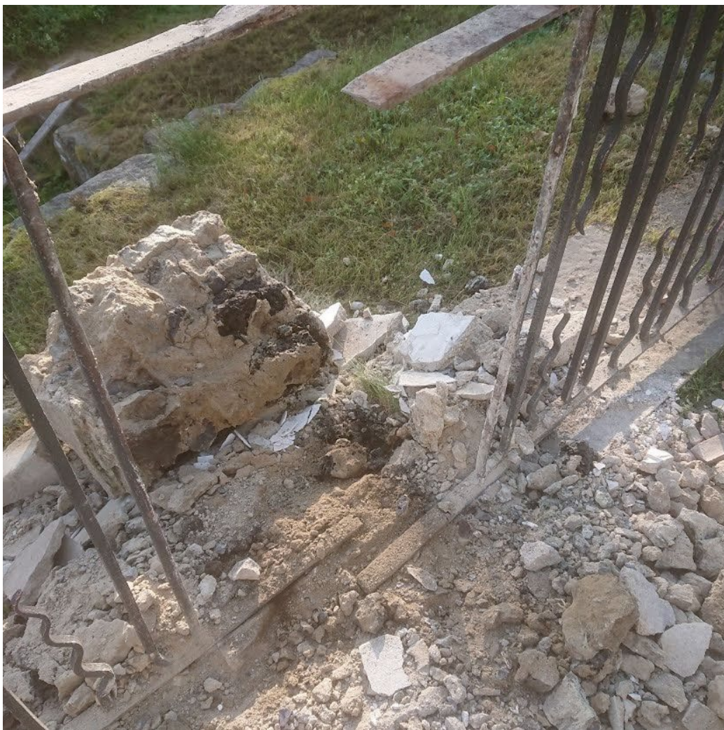
Figur 38. Under rivning av en staketstolpe. Smidesektionerna är inmurade i stolparna. Foto: Valbo Fasad, oktober 2024.
