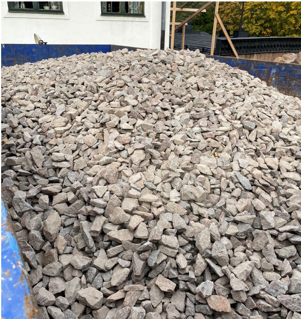
Figur 30. Större fraktioner på småstenen har använts i kärnan på den södra sidan. Dessa stenar håller 32–64 millimeter. Foto: Ulrika Olsson, 2024-09-23.
