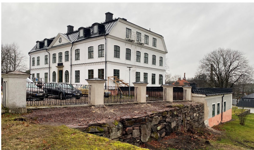
Figur 47. Avfärgning av staketstolpar och de lagade putsytorna i östra flygeln ska utföras under säsongen 2025, liksom markåterställningen kring staketet och ovanför terrassmuren. Foto: Ulrika Olsson, 2025-12-02.
