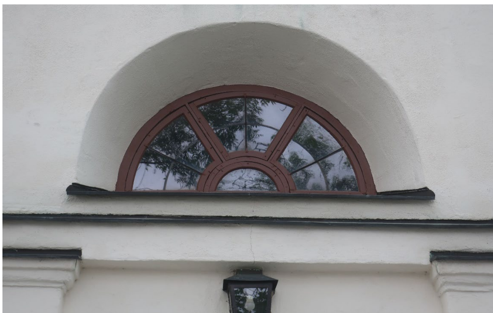
Figur 16. Lunettfönstret ovanför kyrkans huvudingång efter ommålning. Foto från väster: Daniel Olsson, 2021-10-12.
