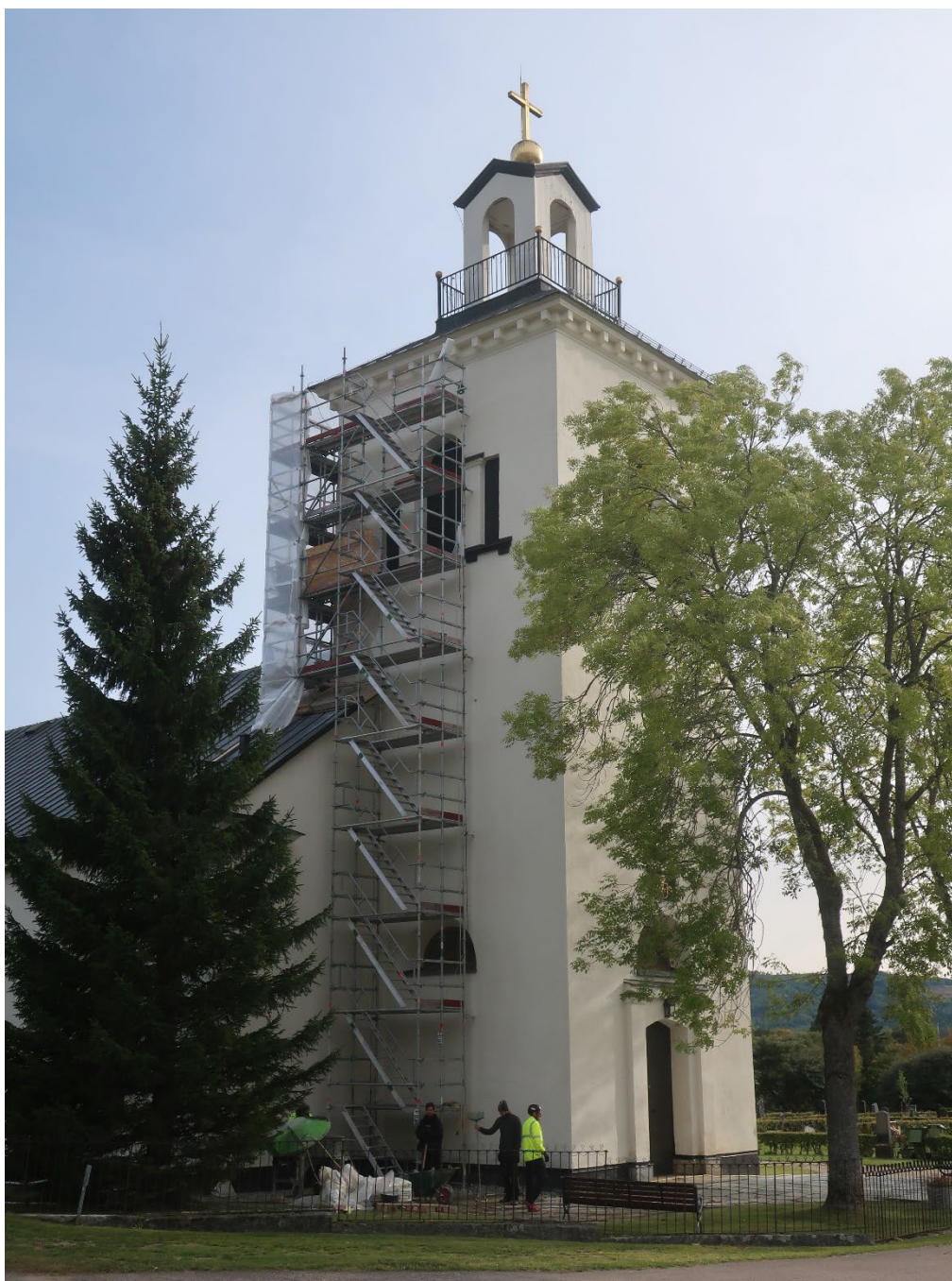
Figur 7. Kyrktornet från nordväst under renoveringen. Foto: Daniel Olsson, 2020-09-17.
