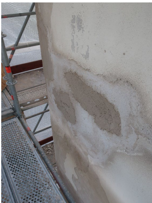
Figur 8. Detalj av putslagad yta på tornets östra fasad. Foto från nordöst: Daniel Olsson, 2020-09-17.
