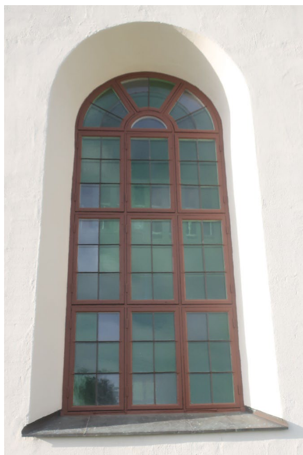
Figur 14. Detalj av fönster mot söder efter ommålning och avslutad fönsterrenovering. Foto: Daniel Olsson, 2021-06-23.
