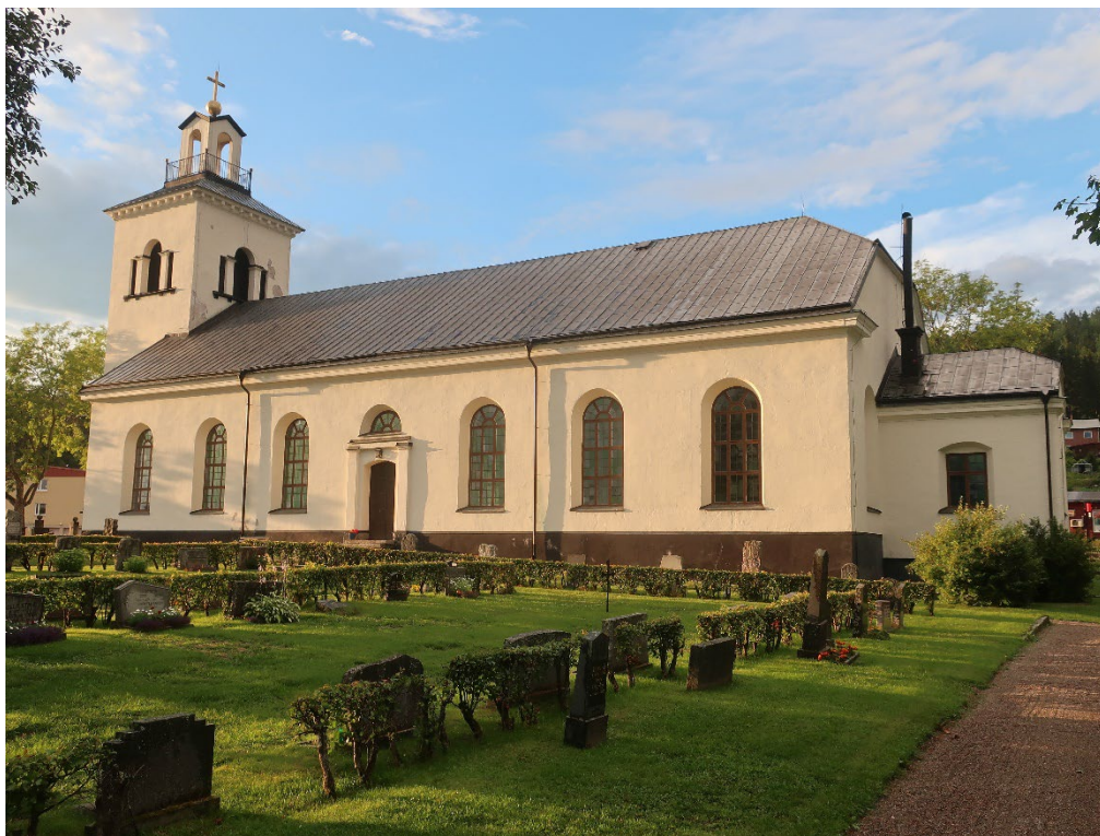
Figur 2. Hassela kyrka från sydöst innan fasadrenoveringen inleddes. Foto: Daniel Olsson, 2020-08-26.
