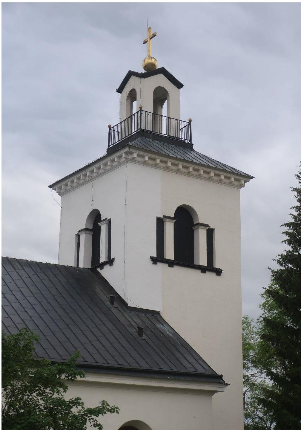
Figur 12. Kyrktornet från nordöst efter putsrenoveringen, men avfärgat i för ljus kulör på de åtgärdade fasadytorna. Foto: Daniel Olsson, 2021-06-23
