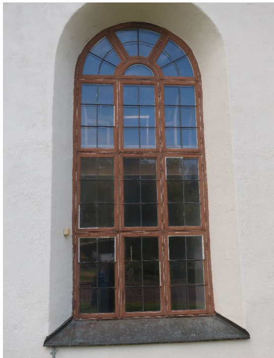
Figur 3. Ett av långhusets fönster mot norr innan renoveringen inleddes. Foto: Daniel Olsson, 2020-08-26.
