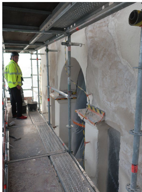
Figur 9. Putsarbetet på kyrktornets östra fasad i höjd med ljudluckorna. Foto från nordöst: Daniel Olsson, 2020-09-17.
