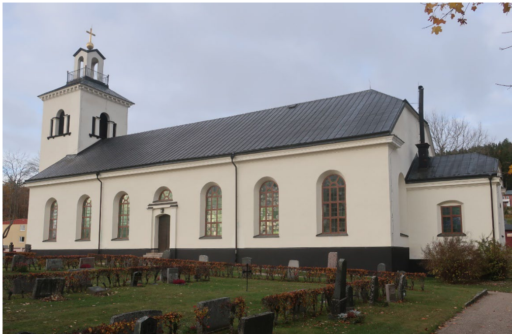
Figur 15. Kyrkan från sydöst efter avslutad fasadrenovering. Foto: Daniel Olsson, 2021-10-12.
