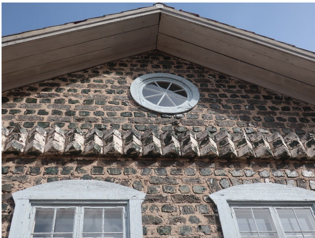
Figur 11. Detalj av kvarnens västra slaggstensfasad. Foto: Ulrika Olsson 2022-05-04.
