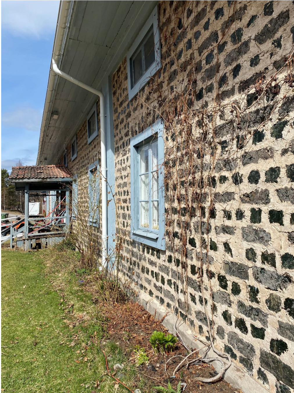
Figur 12. Ett av slaggstenshusen i den norra axeln norr om Bruksgatan. Foto: Ulrika Olsson 2022-05-05.
