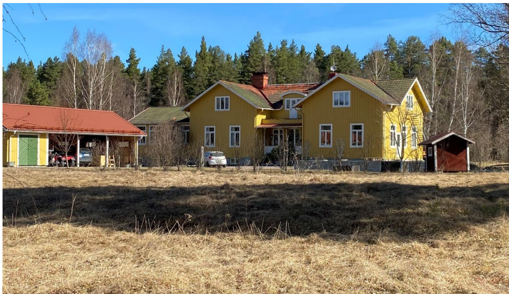
Figur 31. Skolhuset från sydväst. Foto: Ulrika Olsson 2022-05-05.
