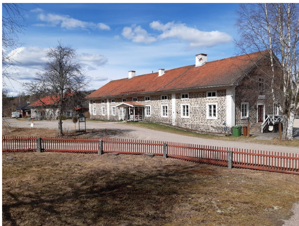
Figur 30. Slaggstensbyggnaderna vid den norra axeln vid Bruksgatan. Foto: Daniel Olsson 2022-05-05.
