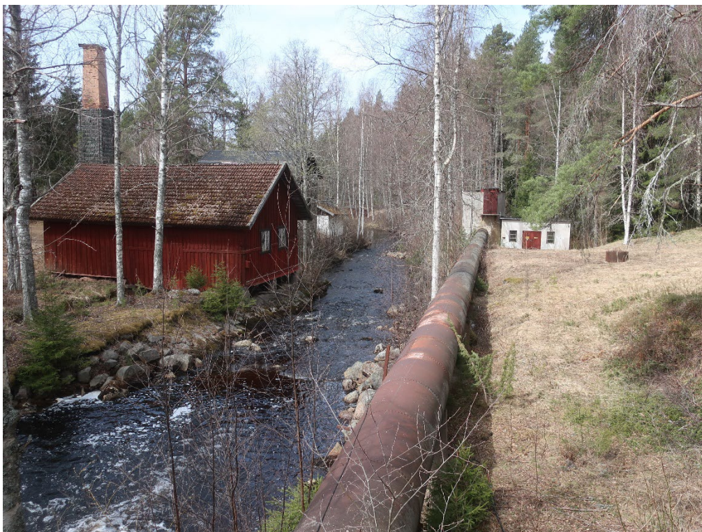
Figur 36. Kraftstationen från 1940-talet till höger om Bruksån. Till vänster i bild ses kalkkladan, rostugnens skorsten, den före detta klensmedjan och klensmedjan. Foto från nordöst. Foto: Daniel Olsson 2022-05-05.
