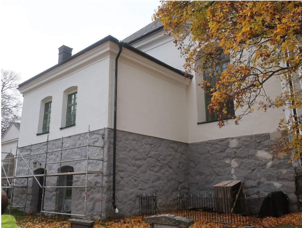
Figur 15. Sakristian och långhusets östra fasader efter avslutad fasadrenovering. Målning av sockeln återstod ännu vid fototillfället. Foto från nordöst: Daniel Olsson, 2021-10-12.
