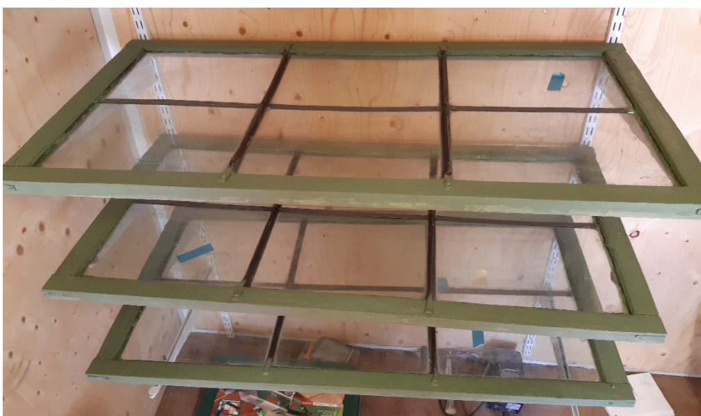
Figur 19. Nymålade fönsterbågar upplagda på torkning i den tillfälliga verkstaden vid församlingens kyrkogårdsexpedition. Foto: Daniel Olsson 2024-05-22.
