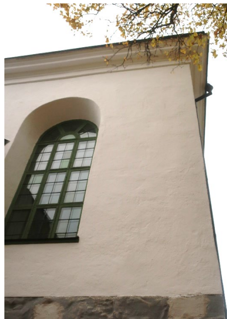
Figur 16. Den norra delen av långhusets östra fasad efter fasadrenovering. Jämför med figur 6. Foto från öster: Daniel Olsson, 2021-10-12.
