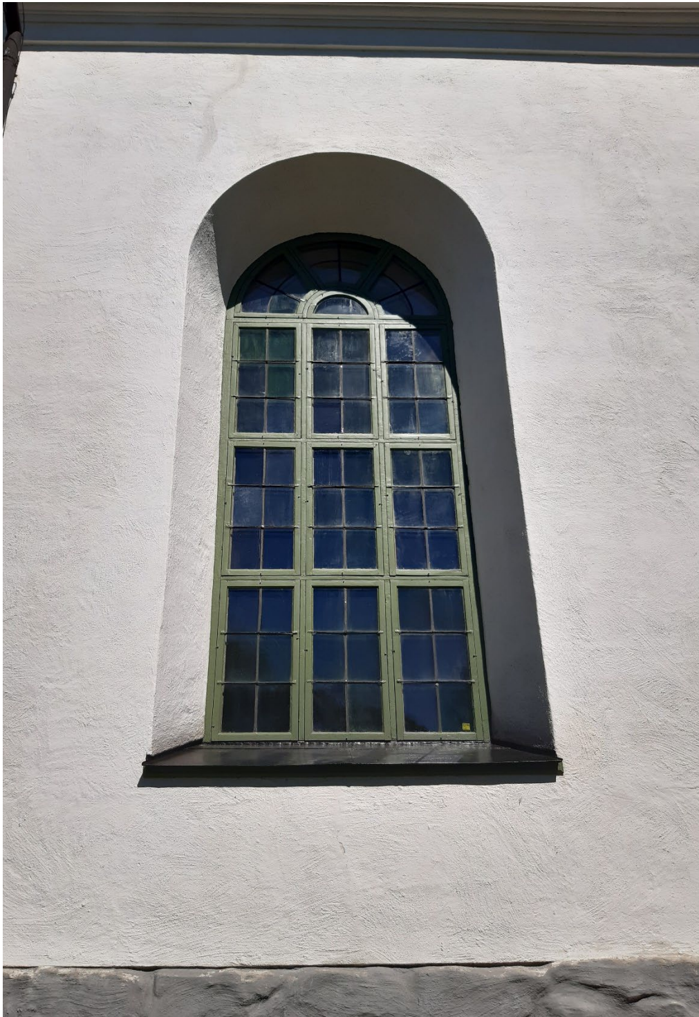
Figur 20. Nymålade fönsterbågar i långhusets södra fasad. Foto från söder: Daniel Olsson 2024-06-25.
