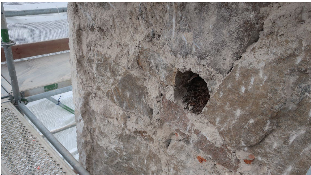
Figur 22. Detalj av det runda hålet, med förkolnat virke, väster om ljudluckorna på den östra tornfasaden. Foto från sydöst: Daniel Olsson, 2021-04-30.
