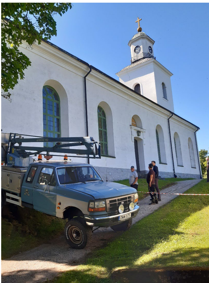
Figur 21. Kyrkans fasad mot norr med fönsterentreprenörens fordon med skylift. Foto från nordöst, Daniel Olsson 2025-06-25.
