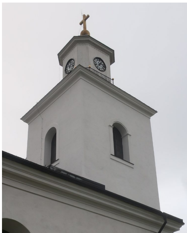
Figur 14. Tornets östra fasad (till vänster i bild) efter avslutad renovering. Foto: Daniel Olsson, 2021-10-12.
