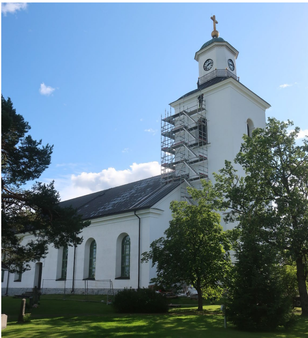
Figur 12. Kyrkan från nordväst med byggställningar resta vid kyrktornet. Foto: Daniel Olsson, 2021-09-01.
