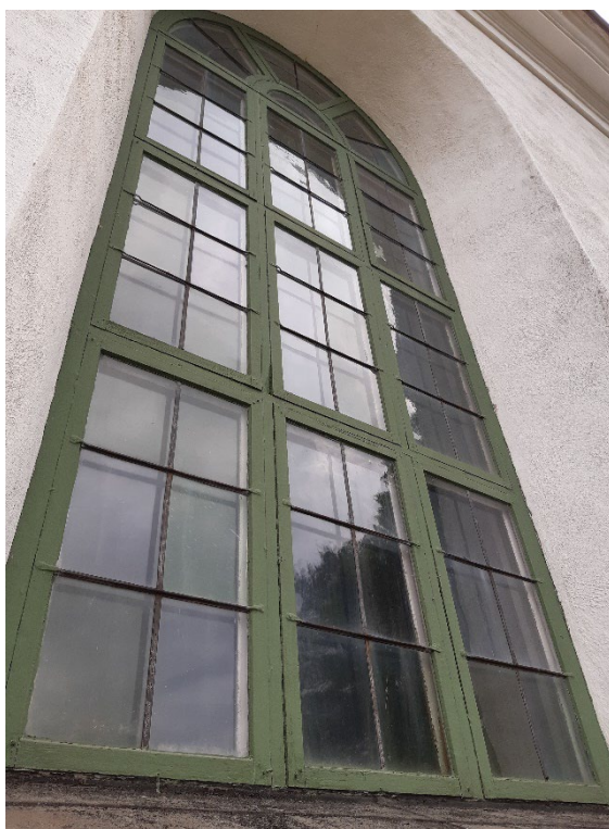
Figur 11. Fönster mot söder innan renoveringen inleddes. Foto: Daniel Olsson, 2023-06-28.
