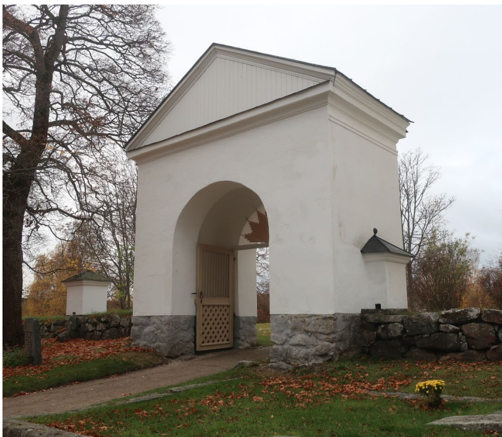
Figur 17. Stigporten från nordöst efter avslutad fasadrenovering och avfärgning. Foto: Daniel Olsson, 2021-10-12.
