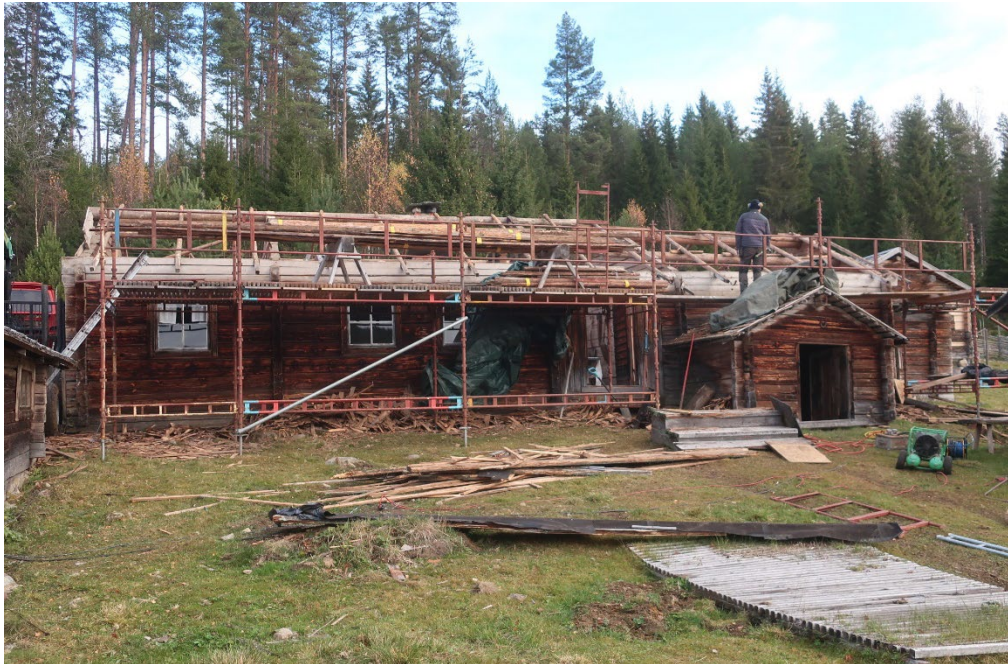
Figur 18. Vallstugan från sydväst under renoveringen. Foto: Daniel Olsson, 2022-10-24.
