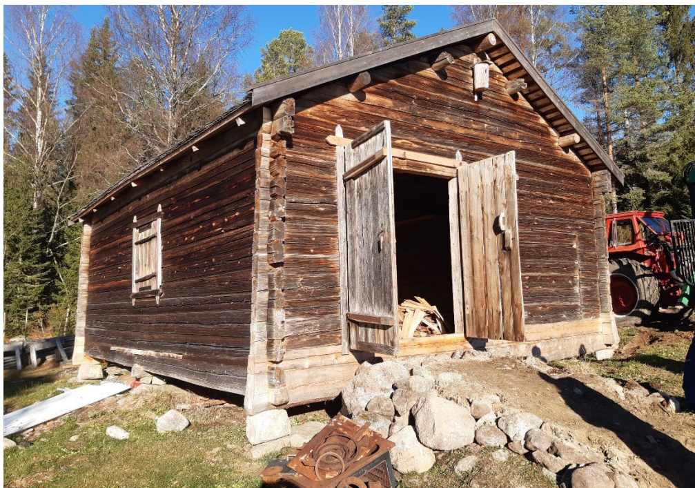
Figur 38. Tröskklogen och den nybyggda rampen vars stenkonstruktion låg emot trävirket. Foto från söder: Daniel Olsson, 2024-10-25.
