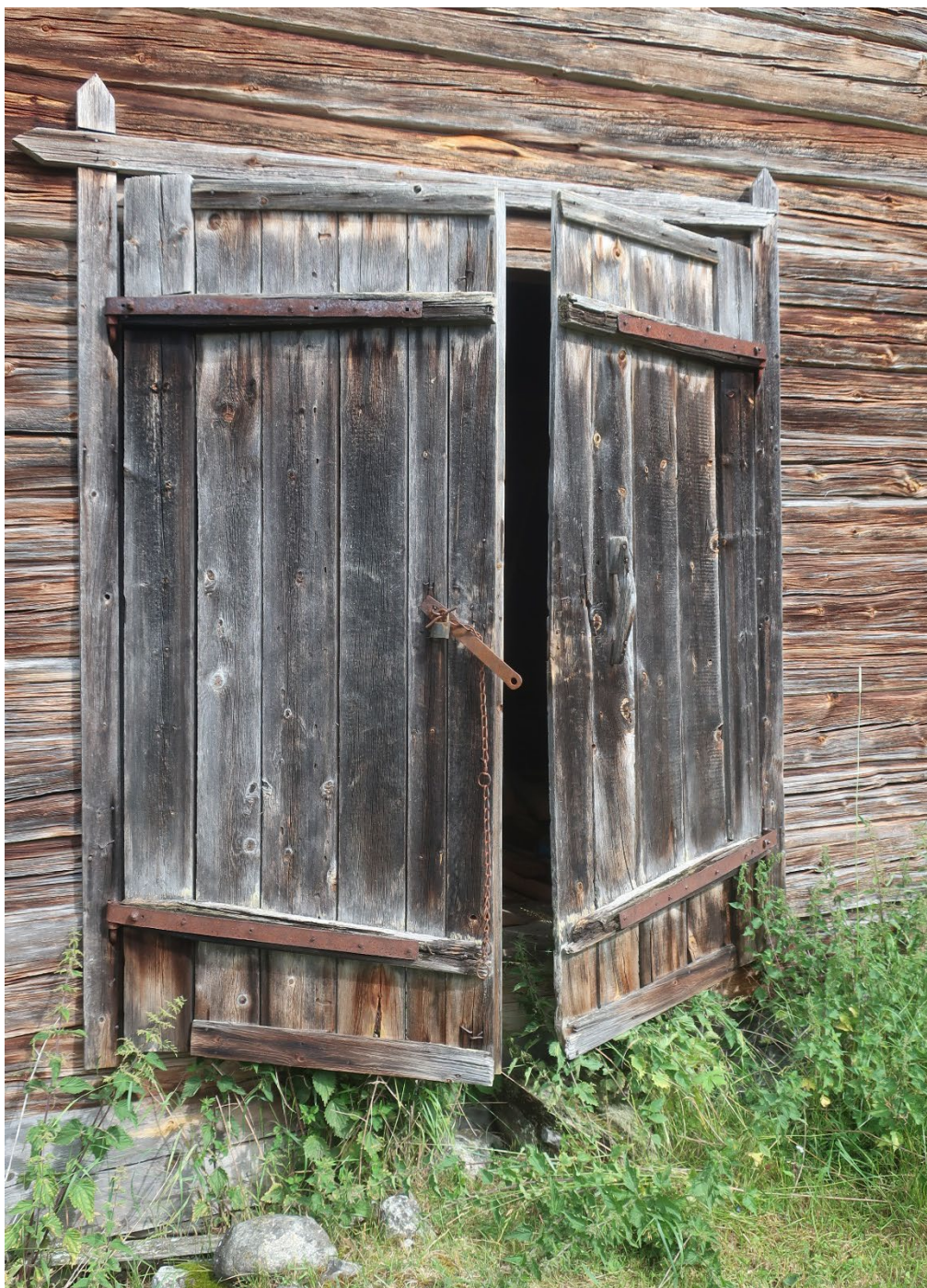
Figur 17. Trösklogens port från sydöst innan renoveringen inleddes. Foto: Daniel Olsson, 2022-07-05.
