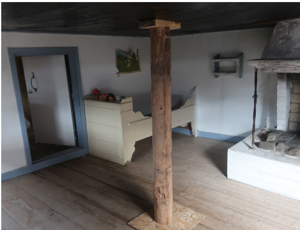
Figur 24. Taket i stugan efter stämpning. Foto från söder: Daniel Olsson, 2022-10-24.
