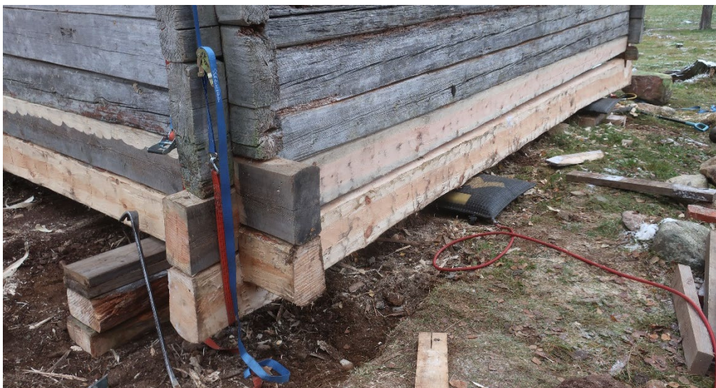
Figur 31. Del av trösklogens utbytta stockar. Foto från norr: Daniel Olsson, 2023-10-27.
