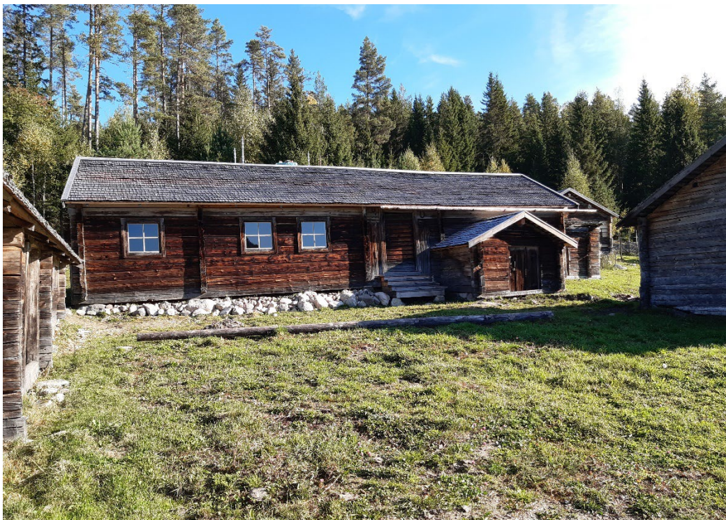
Figur 21. Marken sydväst om byggnaden efter fastighetsägarens sänkning av marknivån. Foto: Daniel Olsson, 2024-10-25.
