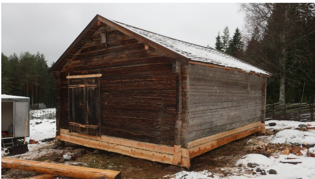
Figur 32. Trösklogen från öster med utbytta stockar. Foto: Daniel Olsson, 2023-11-10.
