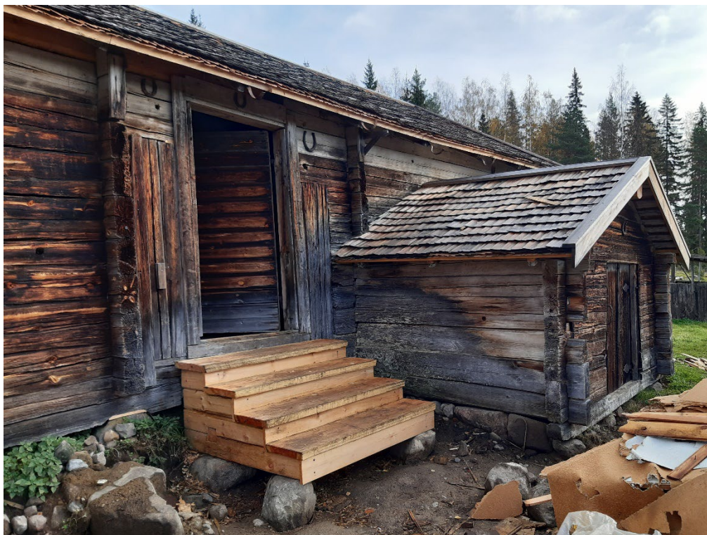
Figur 26. Den nya trappan vid vallstugans huvudingång från väster. Foto: Daniel Olsson, 2023-10-12.
