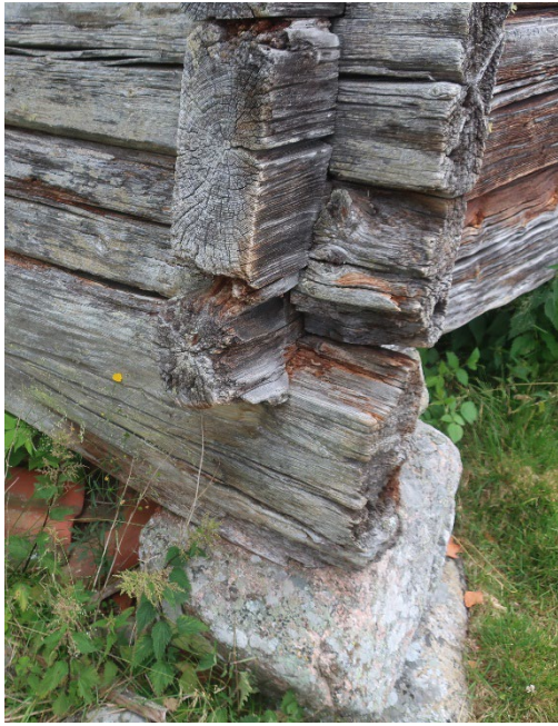
Figur 11. Detalj av ursprunglig trapetsformad sylstock i vägg C i trösklogen. Foto från väster: Daniel Olsson, 2022-07-05.
