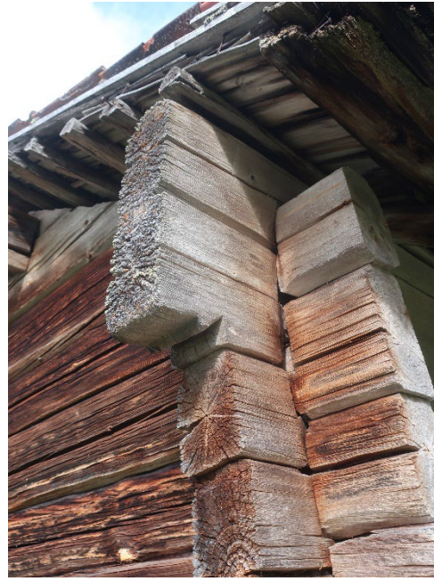
Figur 12. Detalj av huggen avslutning uppåt vid trösklogens knut A/D. Foto från öster: Daniel Olsson, 2022-07-05.
