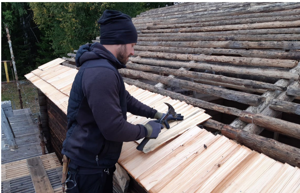
Figur 36. Spikning av takspån på trösklogens sydvästra takfall. Foto: Daniel Olsson, 2022-09-23.
