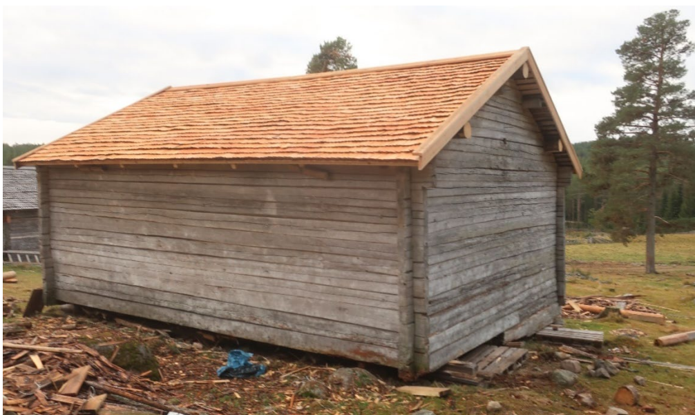
Figur 37. Trösklogen från norr med nylagt spåntak. Foto: Daniel Olsson, 2022-10-24.
