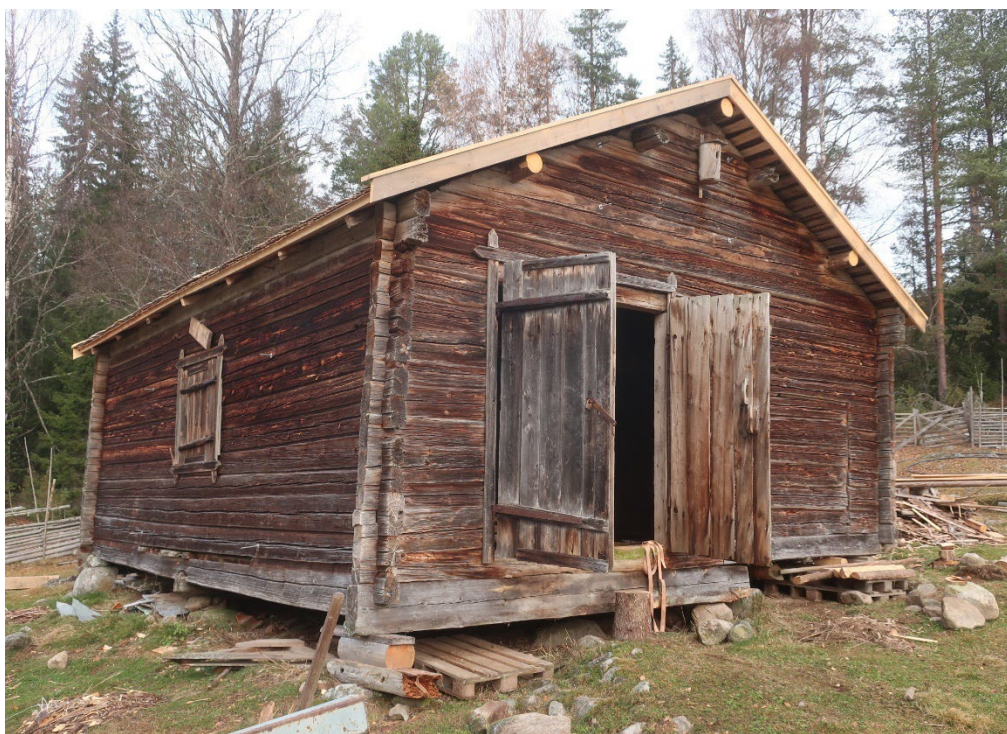
Figur 30. Trösklogen från öster under renoveringen. Foto: Daniel Olsson 2022-
