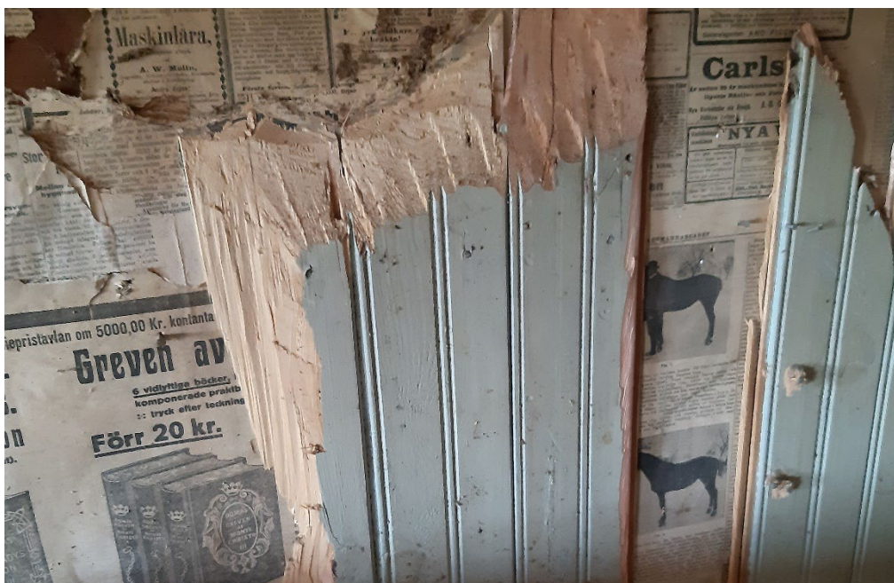
Figur 40. Detalj av den blågrå pärlspontspanelen i stugan som satt uppsatt ovanpå uppklistrade tidningar från 1910-talets början. Foto: Daniel Olsson, 2023-10-12.
