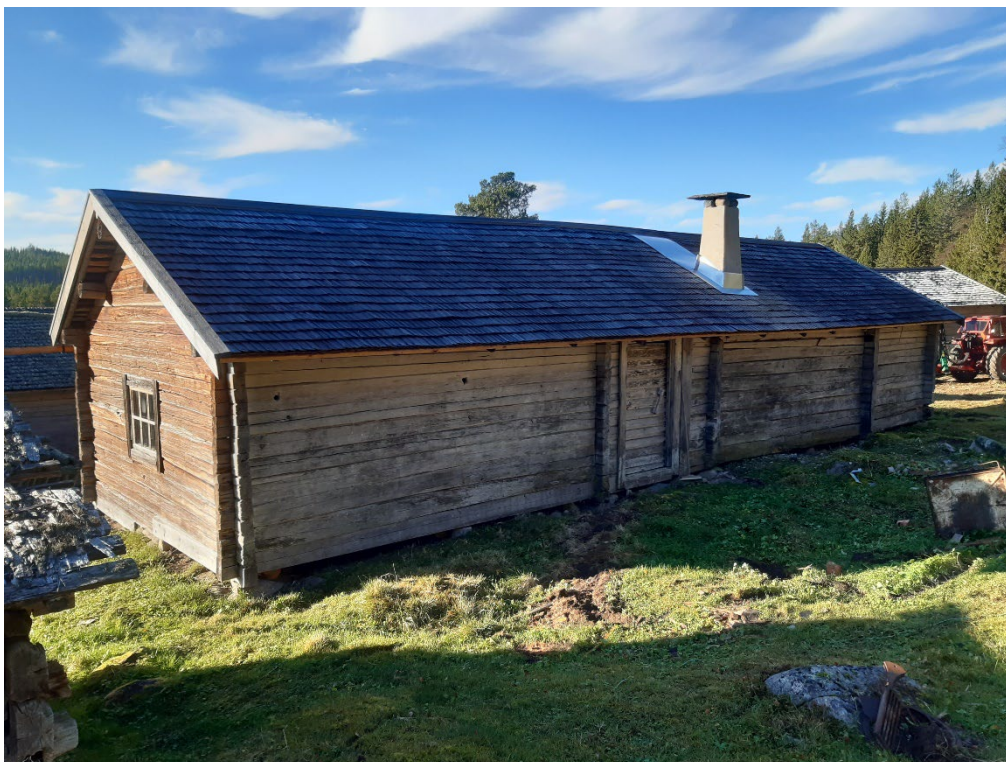
Figur 27. Vallstugan från öster efter spåntaksläggning. Foto: Daniel Olsson, 2024-10-25.
