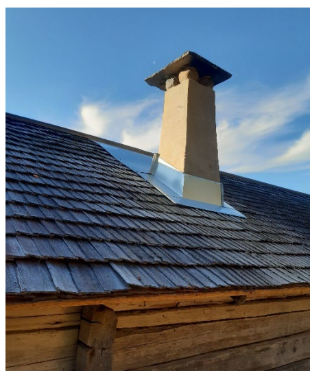
Figur 29. Skorstenen från öster efter avslutad renovering. Foto: Daniel Olsson, 2024-10-25.
