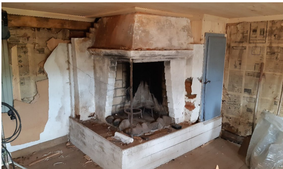
Figur 39. Stugans östra hörn med eldstaden. Väggarna under borttagning av Tretexskivorna. Foto från väster: Daniel Olsson, 2023-10-12.
