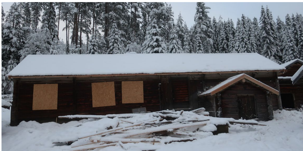
Figur 28. Vallstugan från sydväst under pågående renovering. Foto: Daniel Olsson, 2022-12-09.
