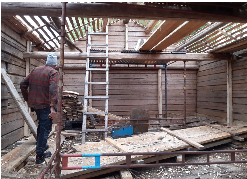
Figur 34. Daniel Åkerman står inne i trösklogen under renoveringen. De vertikala följarna har satts på plats. Foto från sydöst: Daniel Olsson, 2022-09-23.
