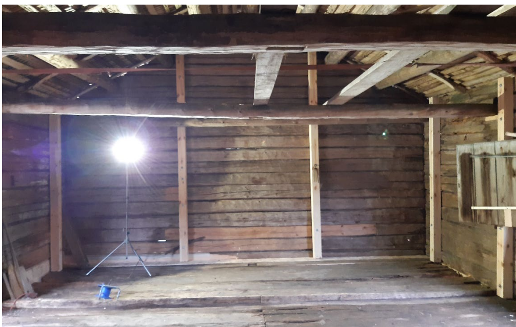
Figur 19. Byggnadens interiör från nordväst med nya horisontella följare. På bilden syns även de två mittersta bjälkarna mellan långsidesväggarna och de urtag för klivstockar som bjälkarna är försedda med. Foto: Daniel Olsson, 2024-11-15.
