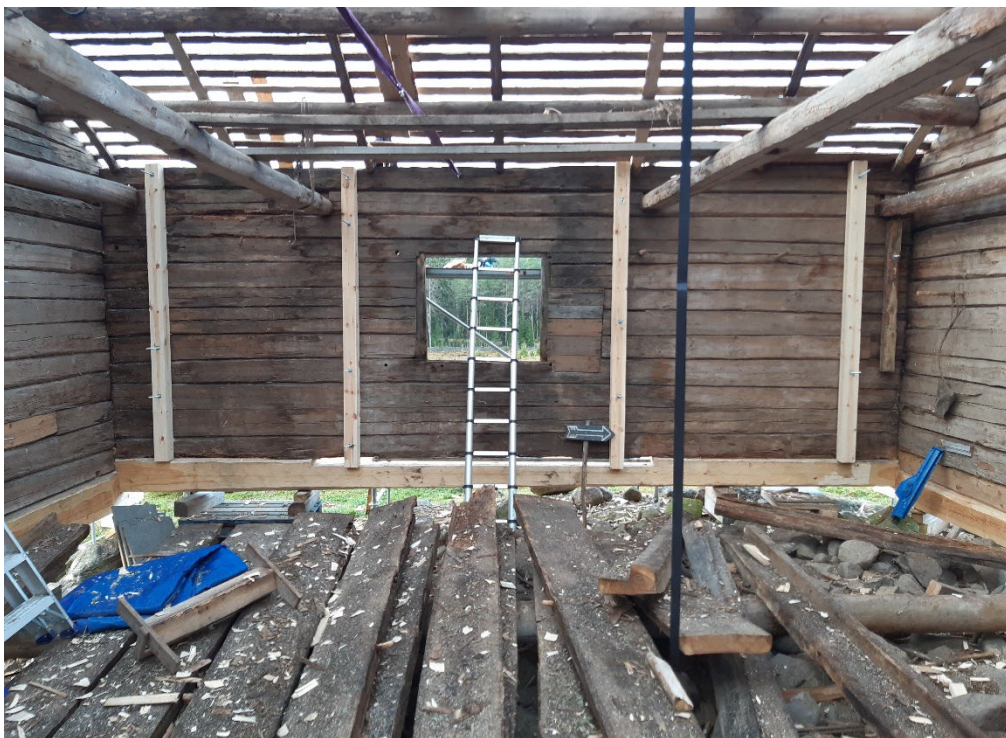
Figur 18. Logens interiör från nordöst under renoveringen med de fyra nya vertikala följarna uppsatta på insidan av vägg C. Foto: Daniel Olsson, 2024-10-25.
