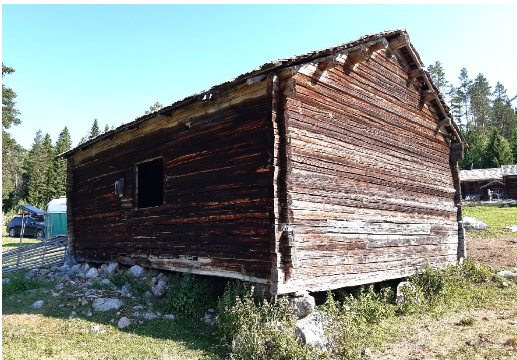
Figur 8. Trösklogen från söder innan renoveringen. Foto: Daniel Olsson, 2024-06-28.
