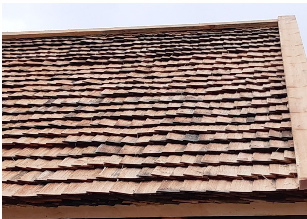
Figur 24. Detalj av spåntaket på takfallet mot nordöst efter omläggning samt montage av vattbrädor ochnockbrädor. Foto: Daniel Olsson, 2024-11-15.
