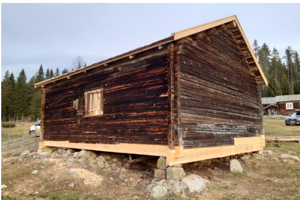
Figur 29. Trösklogen från söder vid slutbesiktningen. Foto: Daniel Olsson, 2024-11-15.
