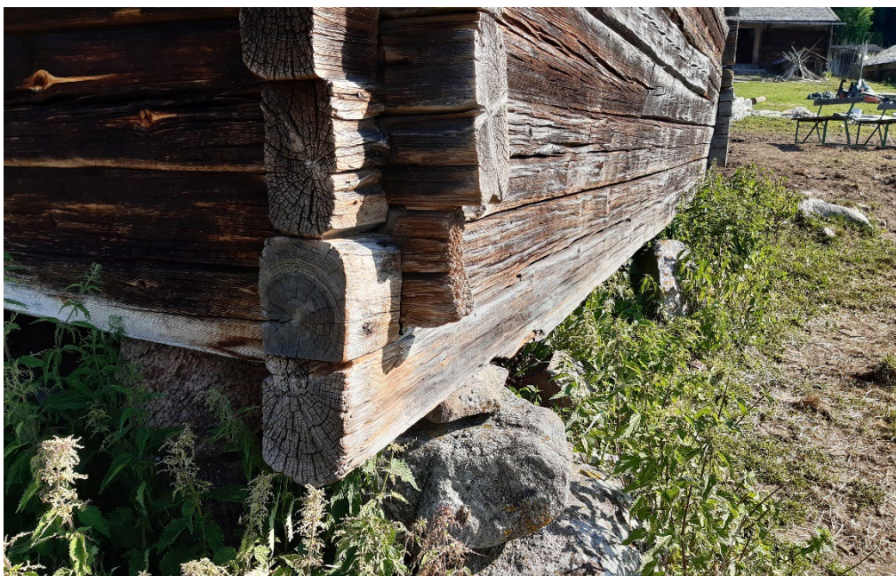
Figur 11. Detalj av syllstock B1 och stock B2 i väggen mot sydöst innan renoveringen inleddes. Foto från söder: Daniel Olsson, 2024-06-28.
