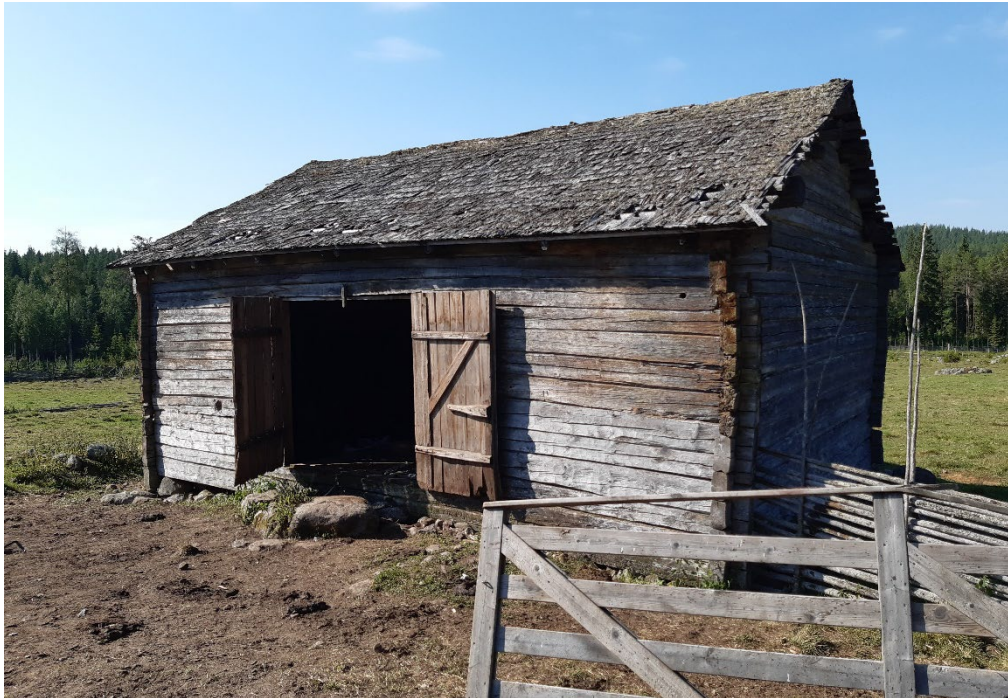
Figur 7. Trösklogen (hus 13) från väster innan renoveringen inleddes. Foto: Daniel Olsson, 2024-06-28.
