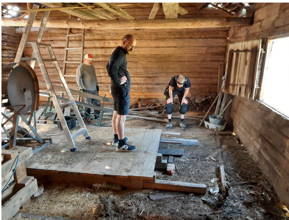
Figur 9. Trösklogens golv innan renoveringen inleddes med ett uppbbyggt golvparti i byggnadens mitt. Foto från nordväst: Daniel Olsson, 2024-06-28.
