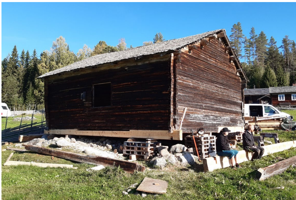
Figur 14. Trösklogen från söder under renoveringen. Foto: Daniel Olsson, 2024-06-28.
