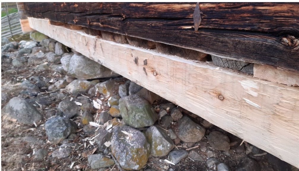
Figur 28. Detalj av öppningen i syllstocken i vägg C där loggolvet mittparti skjuter ut efter renoveringen. Jämför med figur 27. Foto från söder: Daniel Olsson, 2024-11-15.
