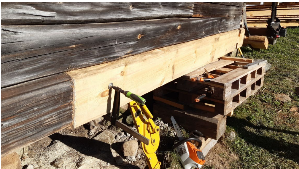
Figur 16. Detalj av stock B2 från söder efter byte av timmer och skarvning med bladskarv. Foto: Daniel Olsson, 2025-09-20.
