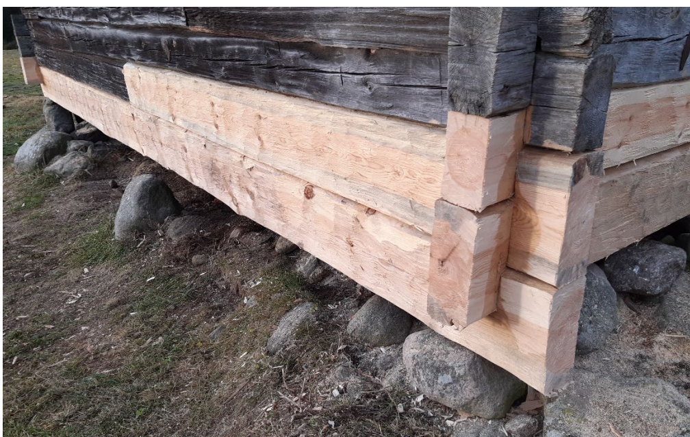
Figur 17. Vägg B samt den sydöstra delen av vägg A efter timmerbyte. Foto: Daniel Olsson, 2024-11-15.
