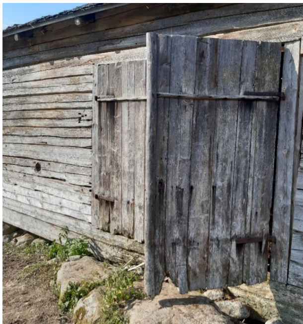
Figur 13. Porten innan renoveringen. Foto från norr: Daniel Olsson, 2024-06-28.
