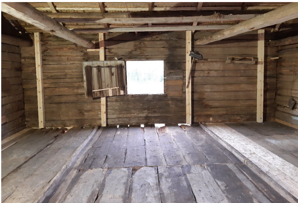
Figur 20. Trösklogens interiör från nordöst efter återläggning av golvet. Notera de båda uppskjutande kanterna i golvet som avgränsar tröskytan i mitten. Foto: Daniel Olsson, 2024-11-15.
