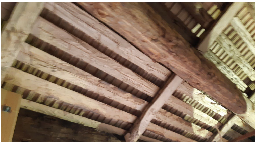
Figur 23. Detalj av takkonstruktionen efter omläggning. Foto: Daniel Olsson, 2024-11-15.
