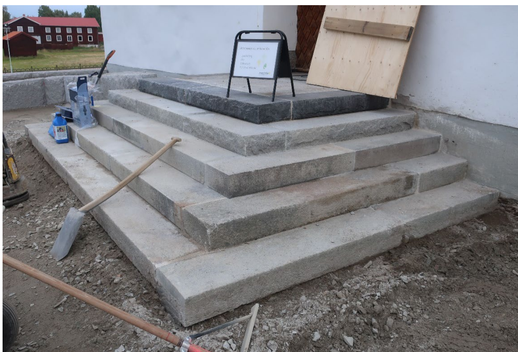
Figur 14. Trappan efter utflyttning och komplettering. Foto från sydväst: Daniel Olsson, 2021-09-07.
