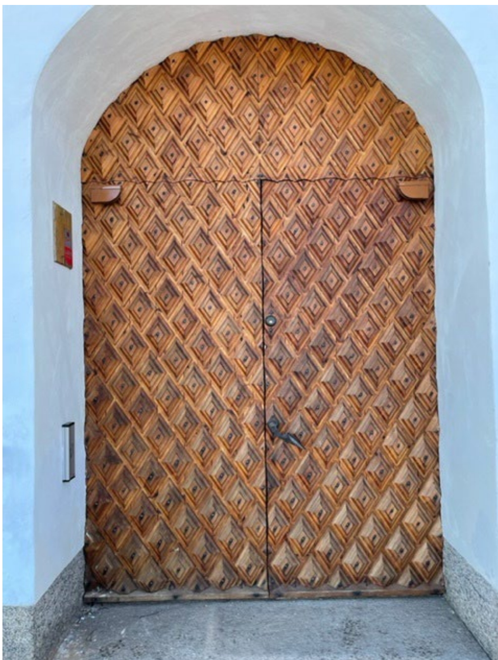
Figur 25. Porten från väster efter inmålning av dörrsensorer. Armbågskontakten sitter monterad på väggen till vänster om dörren. Foto: Roger Eriksson, Hedlunds Glas, januari 2022.
