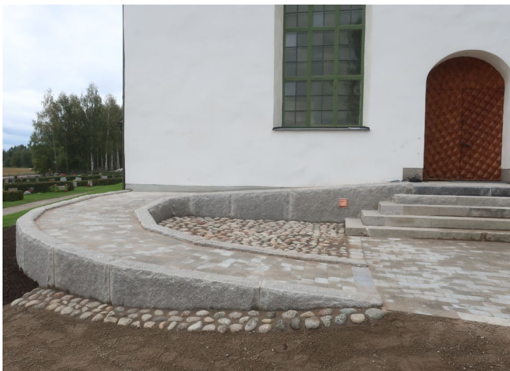
Figur 16. Rampen och del av trappan från väster med kullerstensläggning i den yta som rampen omgärdar samt väster om rampen för att ta upp höjdskillnaden. Foto: Daniel Olsson, 2021-09-16.
