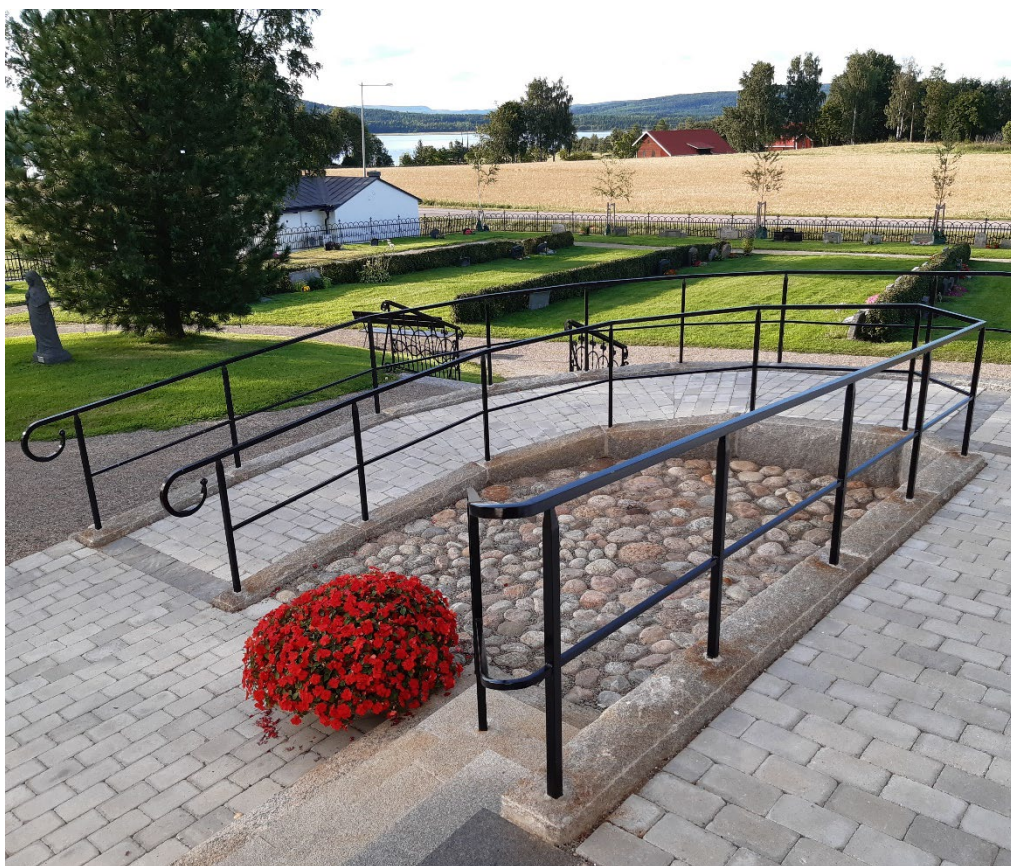
Figur 21. Rampen efter färdigställande. Foto från sydöst: Daniel Olsson, 2022-08-22.
