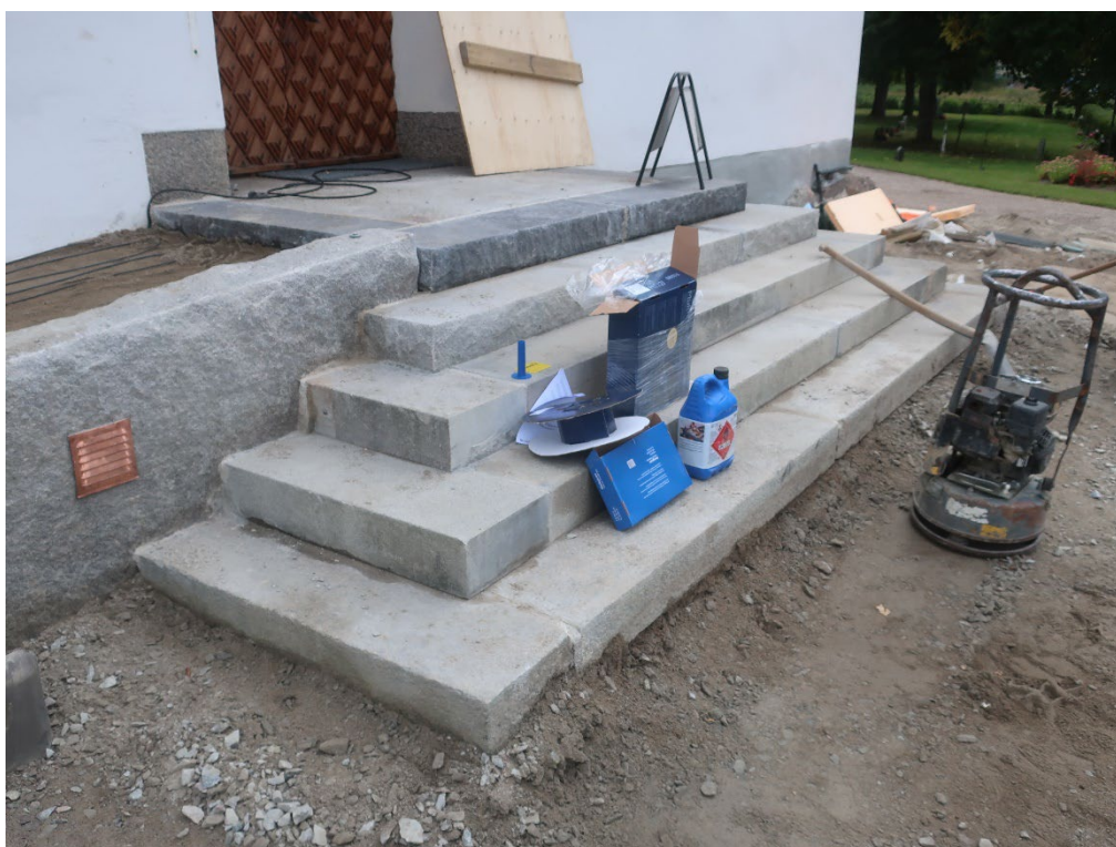
Figur 13. Den utflyttade trappan från nordväst. Foto: Daniel Olsson, 2021-09-07.
