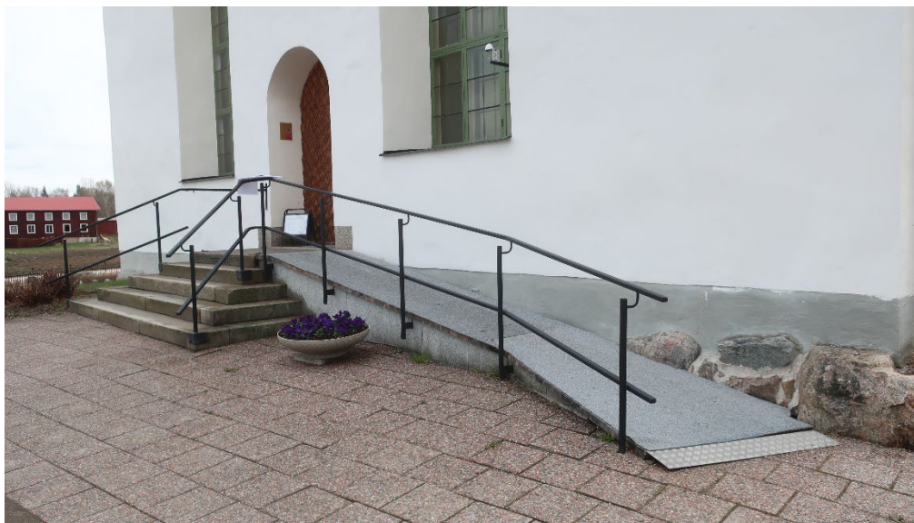
Figur 4. Trappan och rampen från sydväst innan ombyggnaden. Foto: Daniel Olsson, 2021-05-11.
