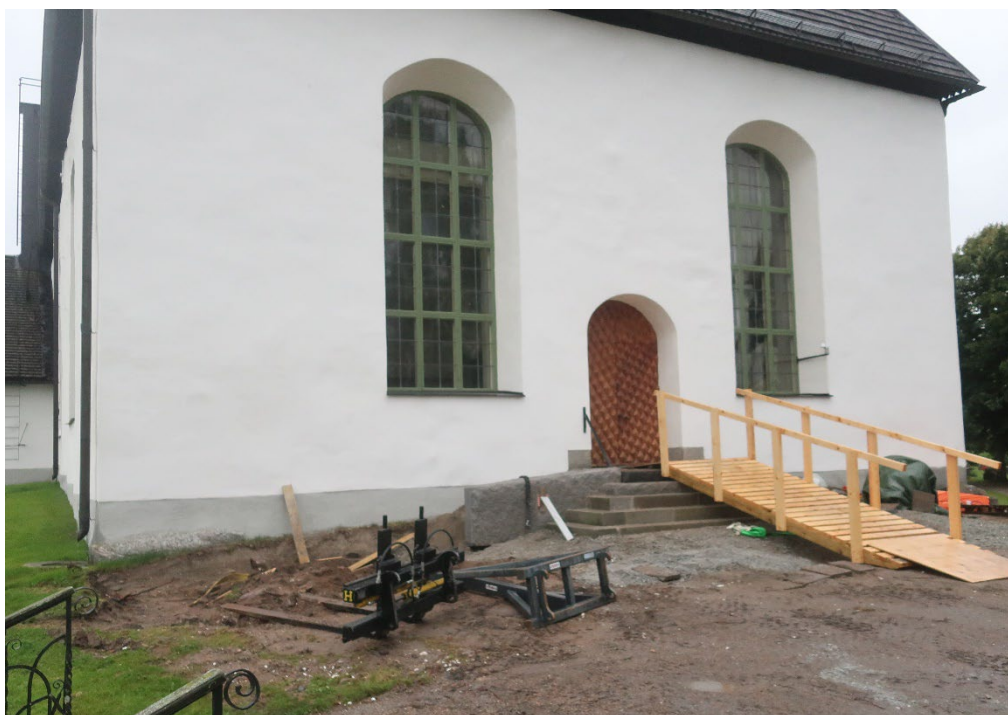
Figur 8. Den blivande rampens grundläggning från nordväst. Foto: Daniel Olsson, 2021-08-26.
