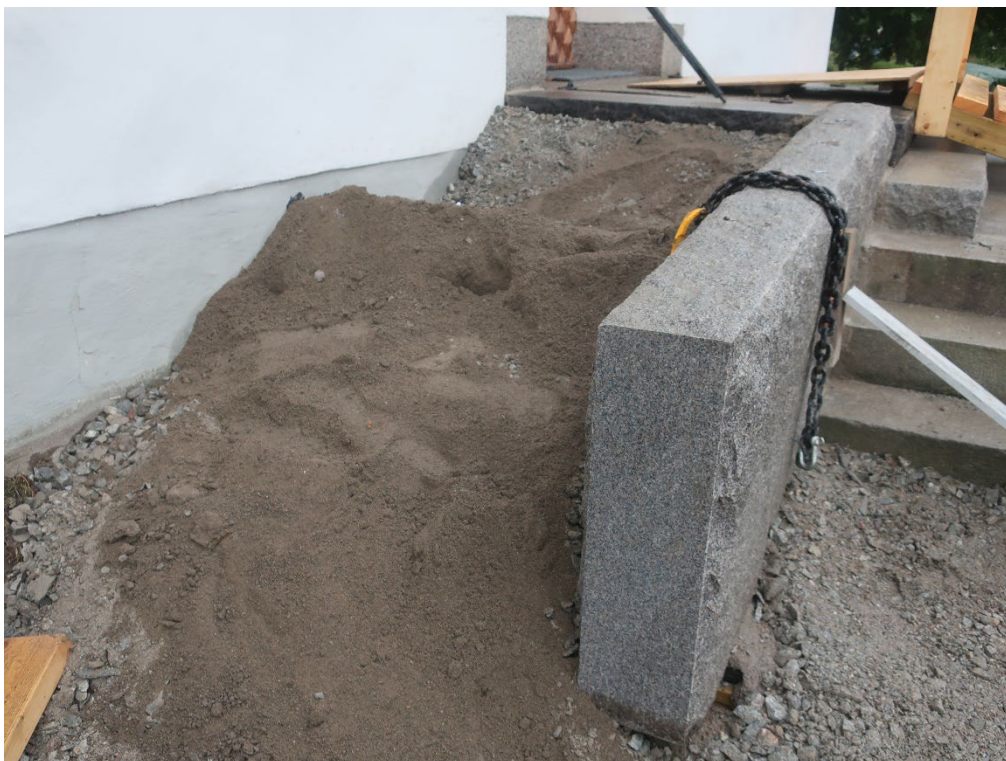
Figur 10. Rampens översta del under uppförande. Foto från nordväst: Daniel Olsson, 2021-08-26.
