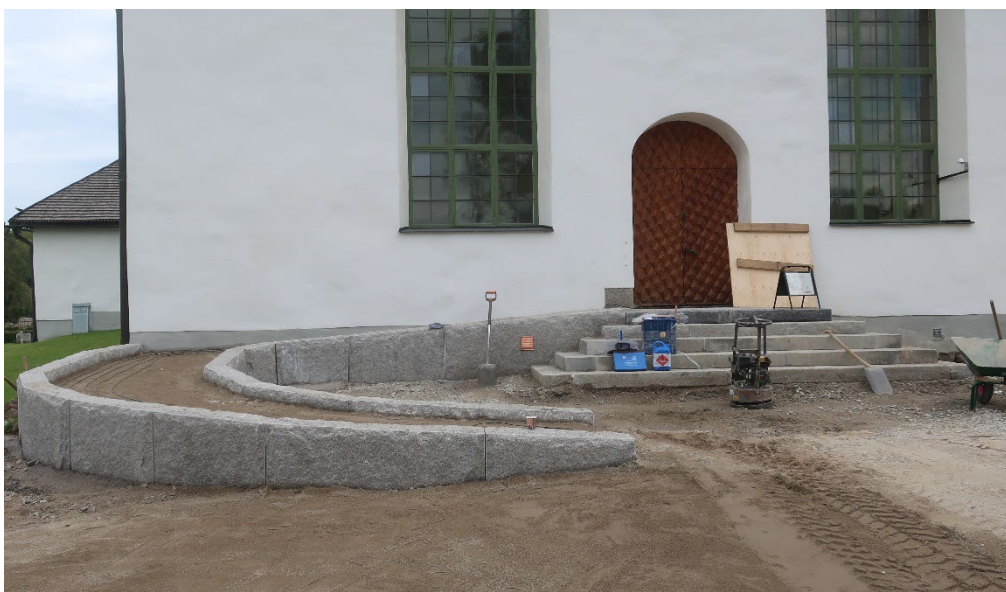
Figur 11. Rampen under uppförande. Foto från väster: Daniel Olsson, 2021-09-07.
