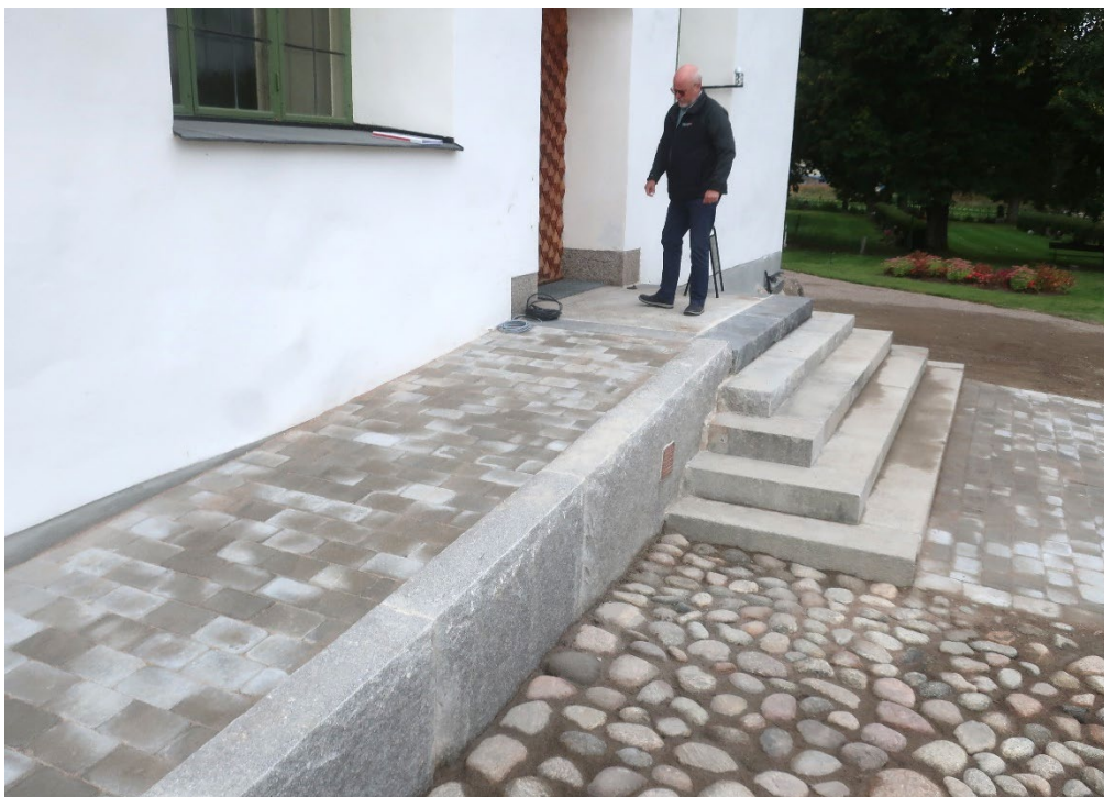
Figur 15. Kyrkogårds- och fastighetschef Lars Grunnesjö betraktar den nylagda rampen. Räckert är ännu inte på plats. Foto från nordväst: Daniel Olsson, 2021-09-16.
