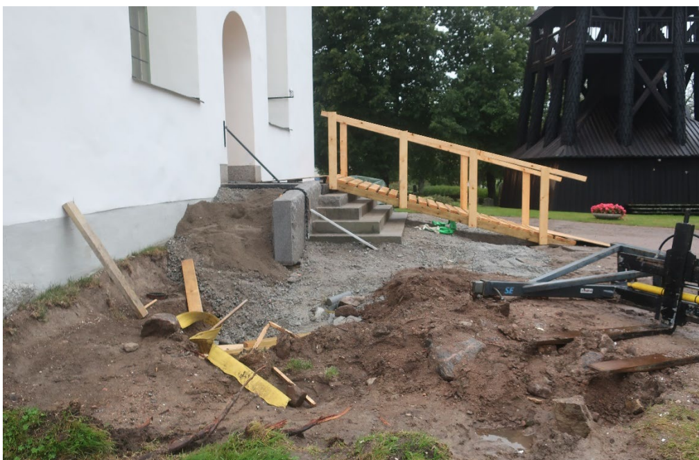
Figur 9. Platsen för den blivande rampen från norr. Foto: Daniel Olsson, 2021-08-26.
