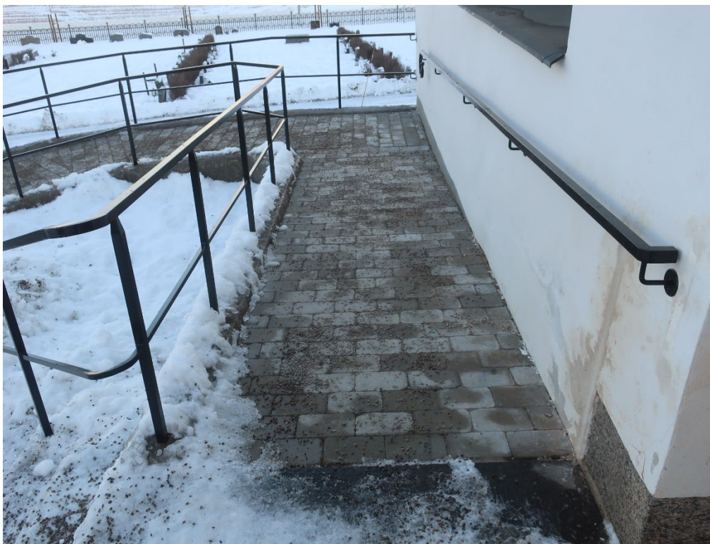
Figur 17. Den färdiga rampen sedd från trappans vilplan. Foto från söder: Daniel Olsson, 2021-12-16.
