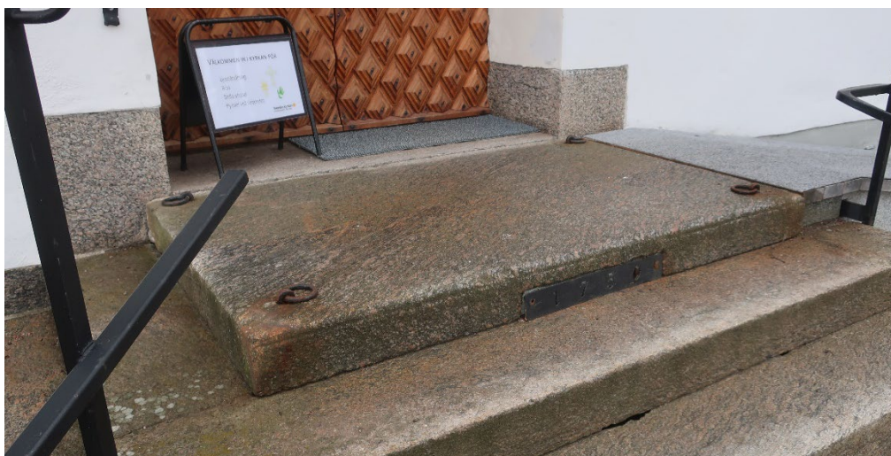
Figur 26. Vilplanet med järnringarna och årtalsplåten monterad vid översta steget innan ombyggnaden. Foto från nordväst: Daniel Olsson, 2021-05-11.
