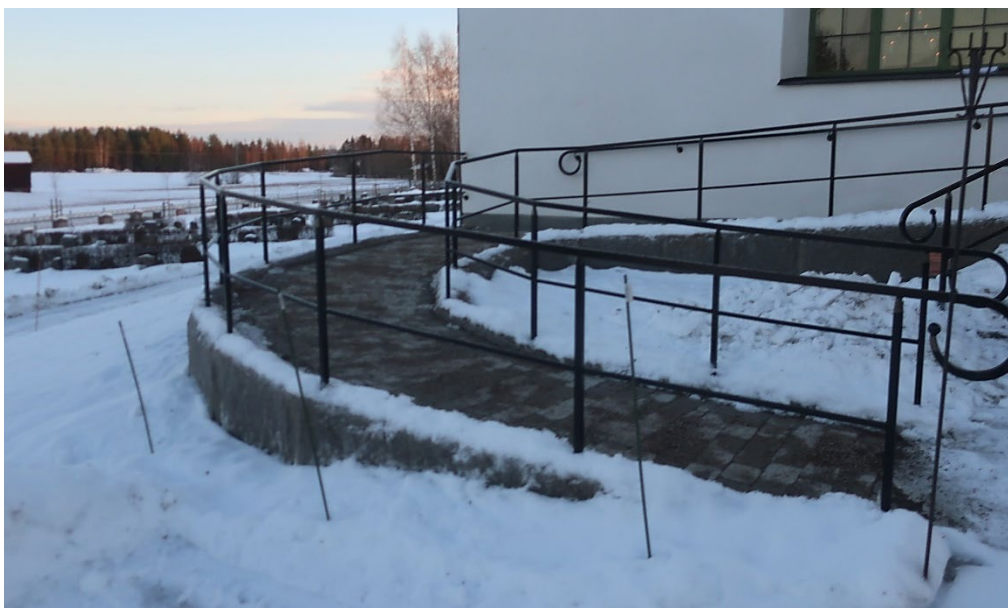
Figur 18. Rampens nedre del från sydväst efter montering av smidesräcke. Foto: Daniel Olsson, 2021-12-16.
