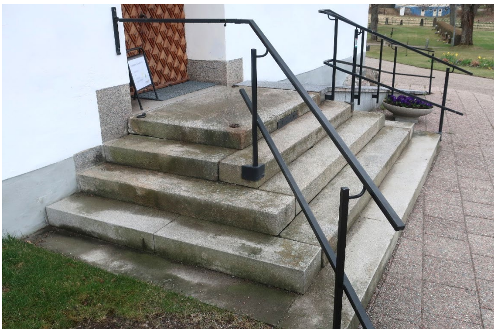
Figur 5. Stentrappan från nordväst innan ombyggnaden. Foto: Daniel Olsson, 2021-05-11.
