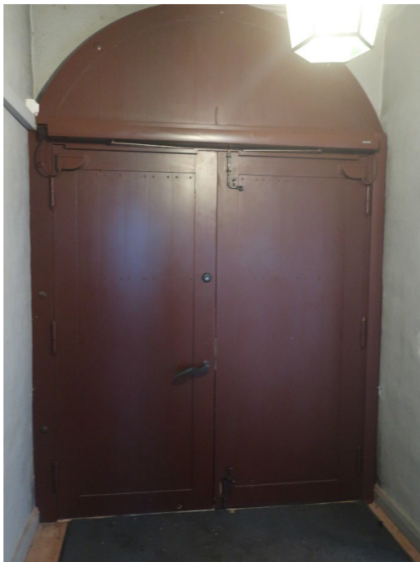
Figur 22. Pardörren från öster efter montering av dörrautomatik ovanför dörrbladen samt dörrsensorer och en vertikal list. Foto: Daniel Olsson, 2022-01-24.
