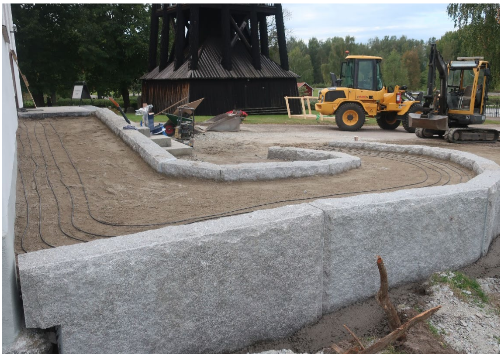
Figur 12. Rampen från nordöst under bygget. Några av elslingorna är utlagda. Foto: Daniel Olsson, 2021-09-07.
