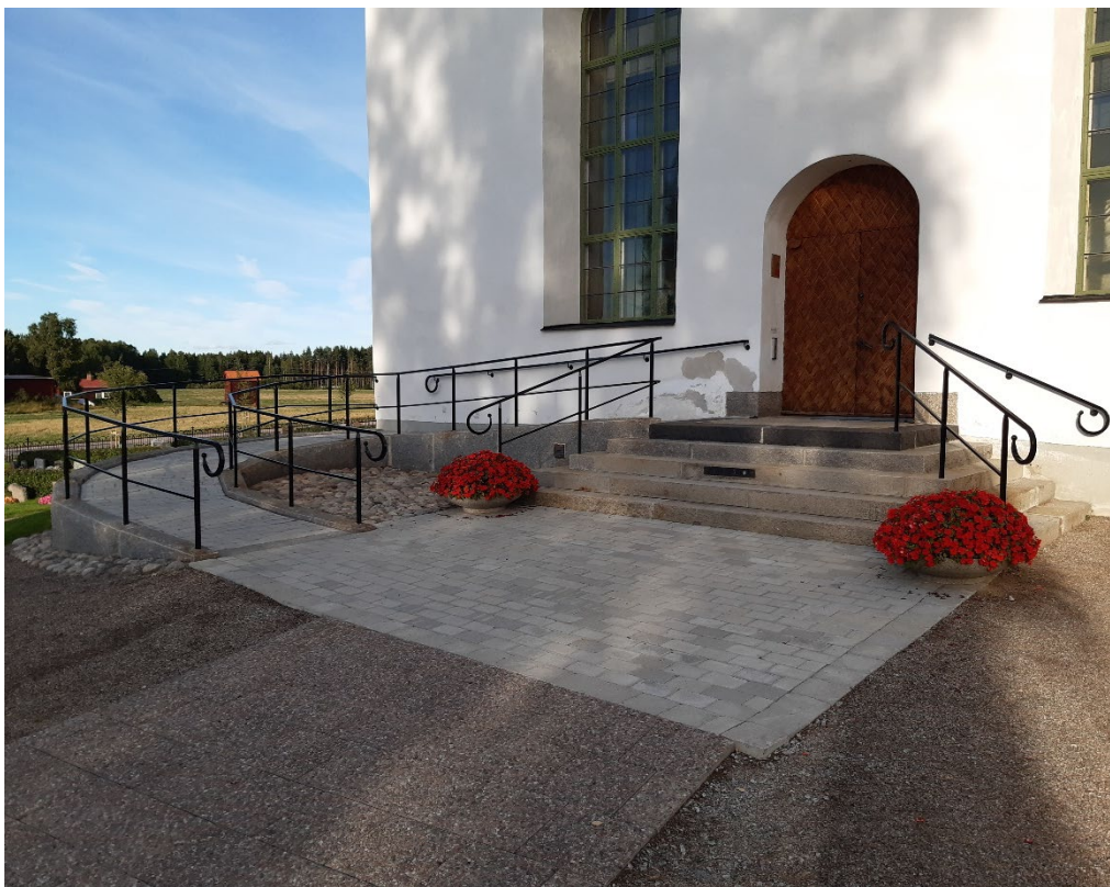
Figur 20. Trappan och rampen efter färdigställande. Foto från sydväst: Daniel Olsson, 2022-08-22.
