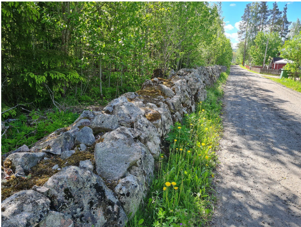
Figur 6. Stenmur L2025:4856. Foto från norr.
