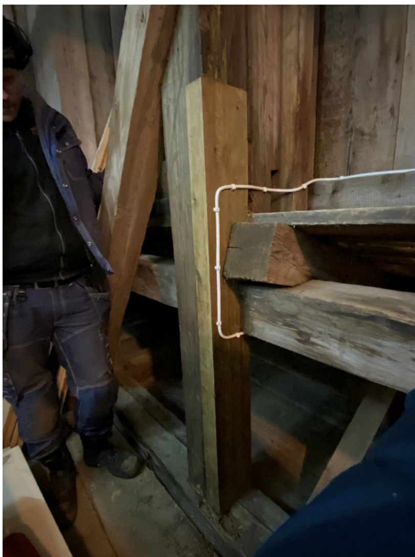
Figur 10. Innan påbörjade arbeten. De två stolparna och bjälken som de står på, se närmare i figur 9. Foto: Ulrika Olsson, 2025-02-07.
