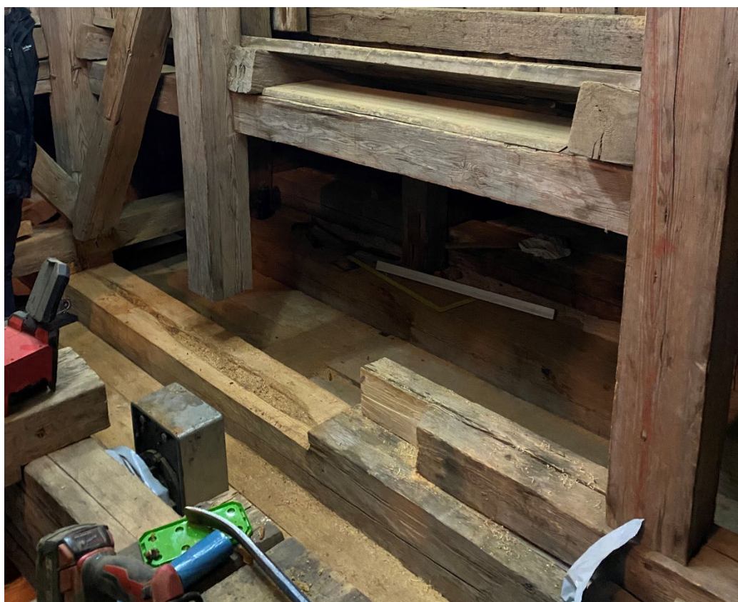
Figur 8. Vid det första besöket hade rötskadade delar sågats ur mot väster, markerad med "C" i figur 5. Foto: Ulrika Olsson, 2025-02-04.
