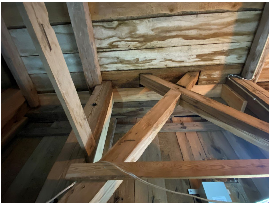
Figur 20. Den rötskadade brädan som låg närmast över stolparna har bytts ut till en ny bräda. Dock byttes inte hela längden då skadorna framför allt fanns i delarna precis över stolparna som är markerade i figur 9. Foto: Ulrika Olsson, 2025-03-12.
