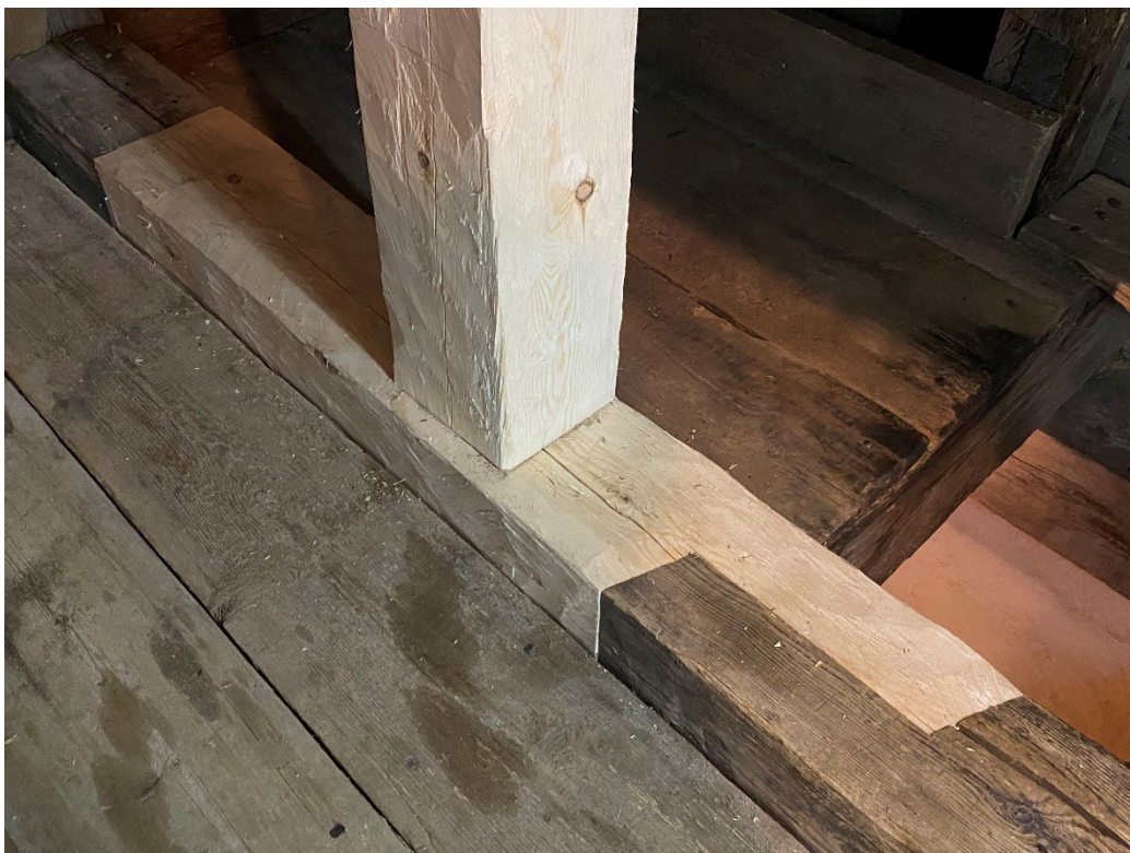
Figur 15. Lagningen av delen på den norra sidan, se figur 5. Det nya virket är iskarvat på timrets halva tjockleken. Det nya virket är förankrat med konstruktionsskruv från utsidan och därefter pluggat. Foto: Ulrika Olsson, 2025-03-12.
