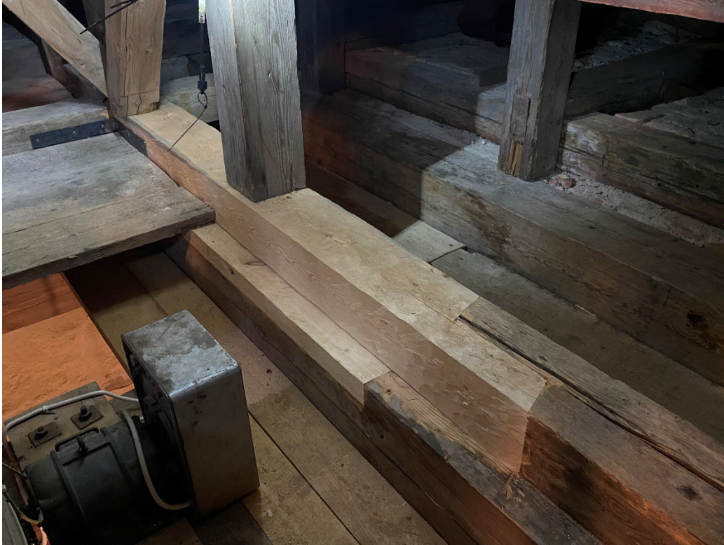
Figur 13. Lagningen av delarna mot väster, ytan markerad med "C" i figur 5. De nya delarna är skruvade och pluggade mot underlaget. I hörnet är de nya delarna förankrade i konstruktionen genom ett hörnjärn. Foto: Ulrika Olsson, 2025-03-12.
