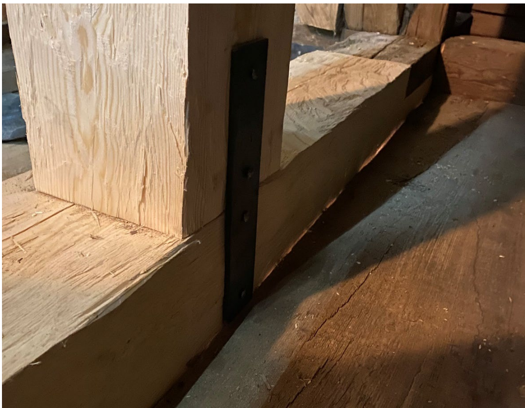
Figur 19. Stolpen har förankrats mot bjälken med hjälp av ett järn, som har spikats fast. Foto: Ulrika Olsson, 2025-03-12.
