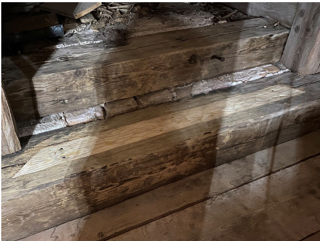
Figur 21. Ilagningen av en stock på den östra sidan, se markering "B" i figur 5. Det nya virket har spikats fast. Foto: Ulrika Olsson, 2025-03-12
