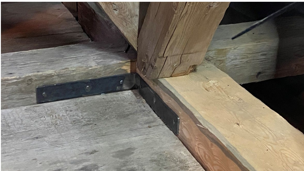
Figur 14. Här syns hörnjärnet som har tillkommit i det sydvästra hörnet, invid lagningarna i figur 13. Foto: Ulrika Olsson, 2025-03-12.
