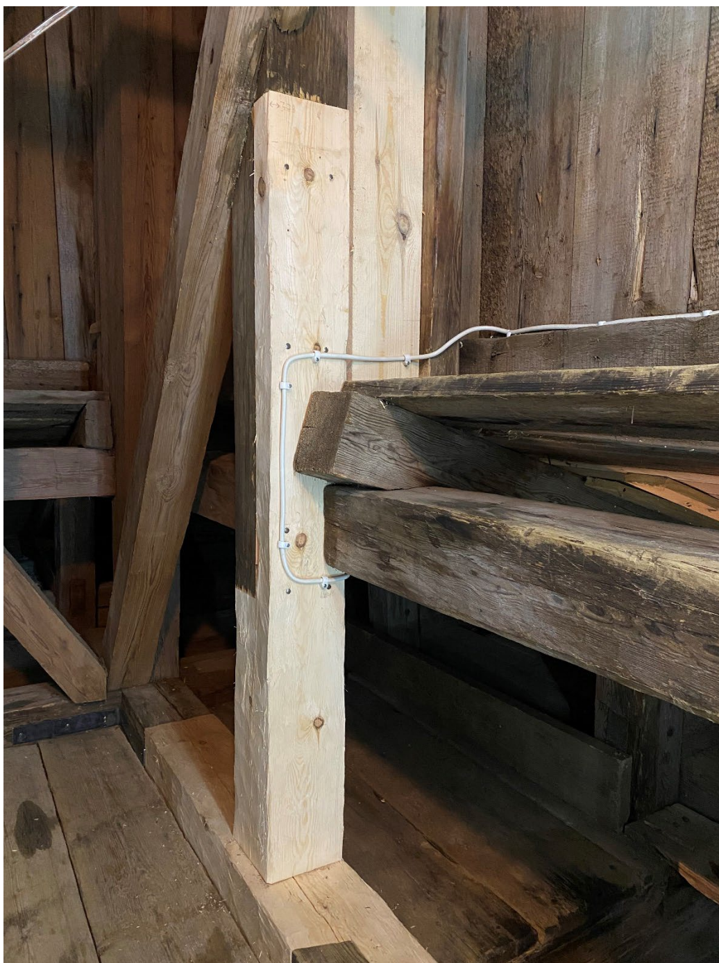
Figur 18. Den ilagade inre stolpen efter avslutade arbeten. Foto: Ulrika Olsson, 2025-03-12.
