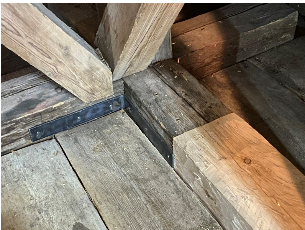
Figur 16. I anslutning till lagningen på den norra sida - se figur 11 - har ett hörnjärn satts i det nordvästra hörnet för att säkerställa konstruktionen. Foto: Ulrika Olsson, 2025-03-12.
