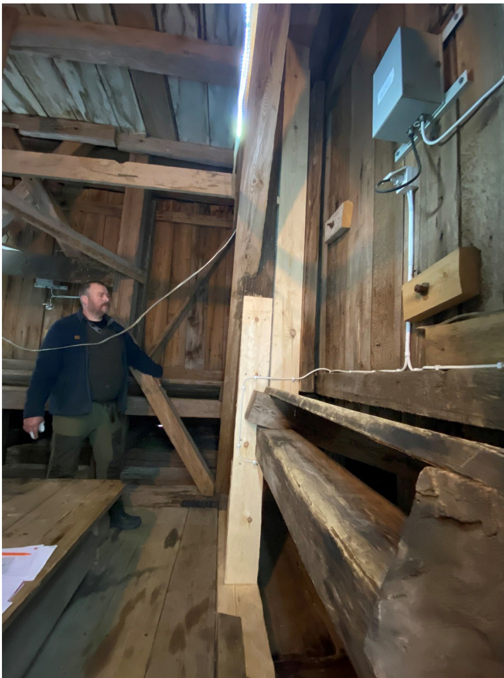
Figur 17. Den inre stolpen på den norra sidan - se figur 9 - som har lagats i. Den gamla lagningen som fanns på stolpen togs bort för att hantverkarna skulle kunna komma åt stocken bakom. De nya delarna är förankrade med genomgående bultar. På fotografiet syns timmerman Dan Gavell, Gysinge Kulturbygg. Foto: Ulrika Olsson, 2025-03-12.
