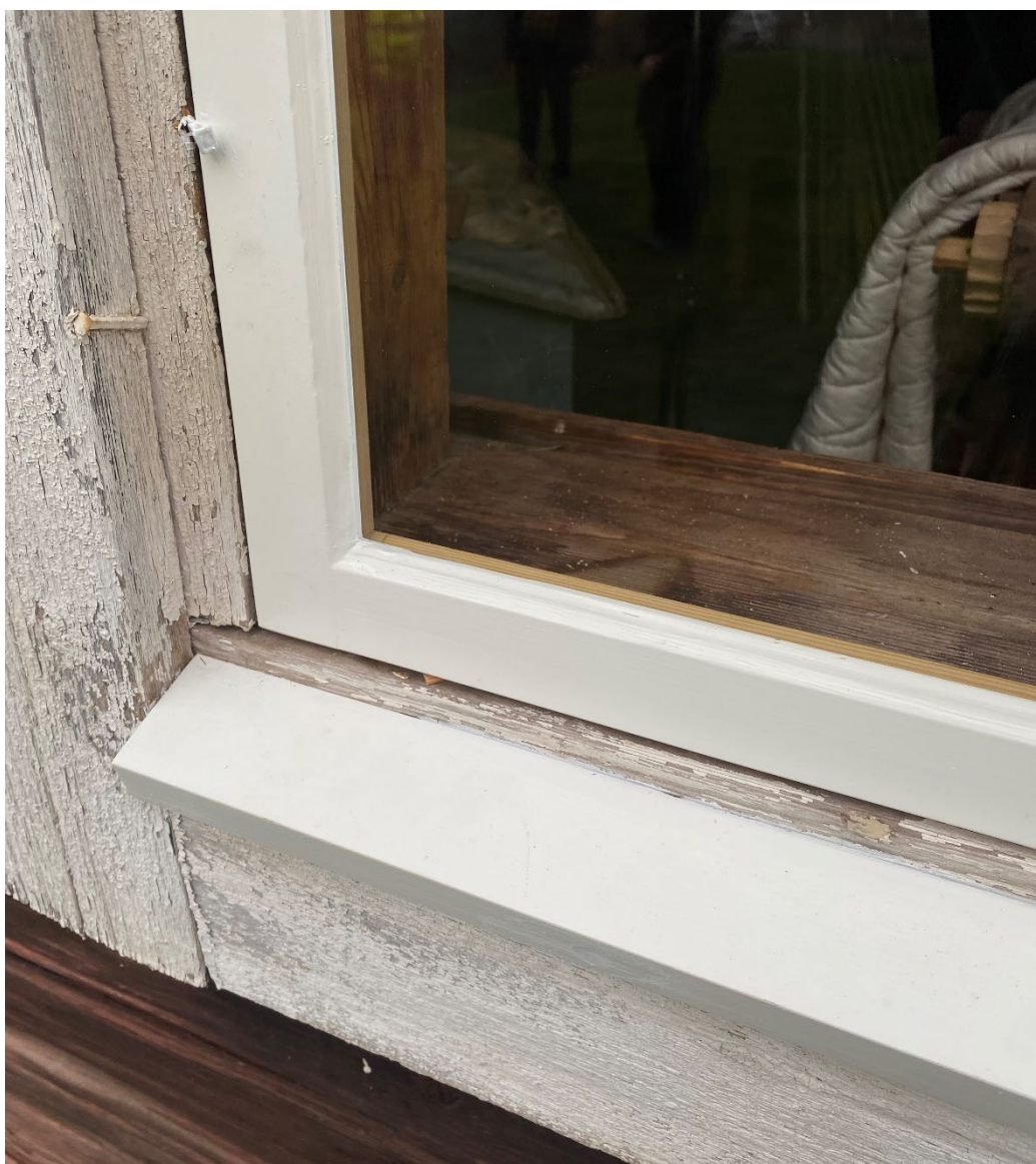
Figur 14. Nyttillverkad fönsterbåge och nyttillverkad vattbräda. Foto: Ulrika Olsson, Länsmuseet Gävleborg, 2025-11-07.
