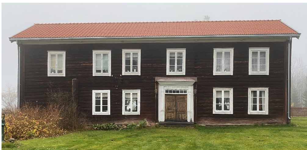
Figur 1. Gammelbyggningen på Sörböle Hälsingegård sedd från söder. Nya fönsterbågar har tillverkats till de fyra fönstren på bottenplan. Foto: Ulrika Olsson, 2025-11-07.
