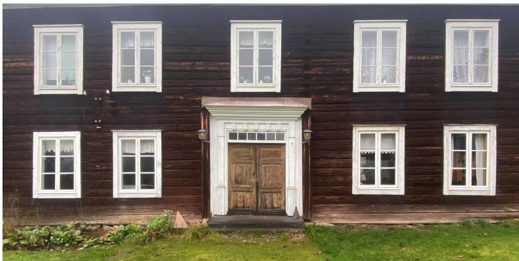
Figur 15. De åtta nytillverkade fönsterbågarna på bottenplan efter avslutade arbeten. Alla fyra fönstereenheter har även försetts med nya vattbrädor. Foto: Ulrika Olsson, Läns museet Gävleborg, 2025-11-07.
