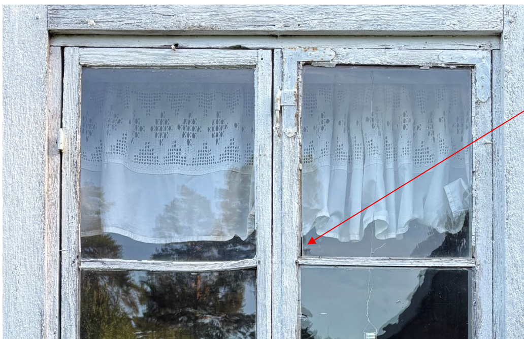
Figur 5. Uttjänta trädelar i fönsterbågarna ihop med glas som var för nätta för öppningarna gjorde att beslut fattades om att nya glas skulle användas i de nya fönsterbågarna. Foto: Ulrika Olsson, Länsmuseum Gävleborg, 2025-09-23.
