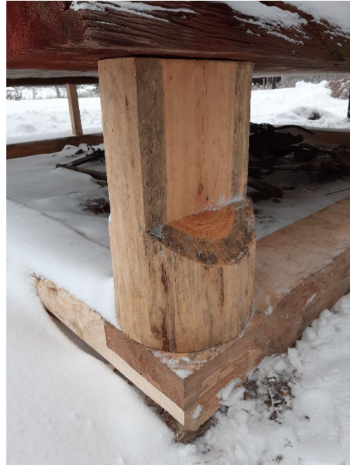
Figur 26. Detalj av nytillverkad stolpe vid slutbesiktningen. Foto från nordväst: Daniel Olsson, 2023-11-03.
