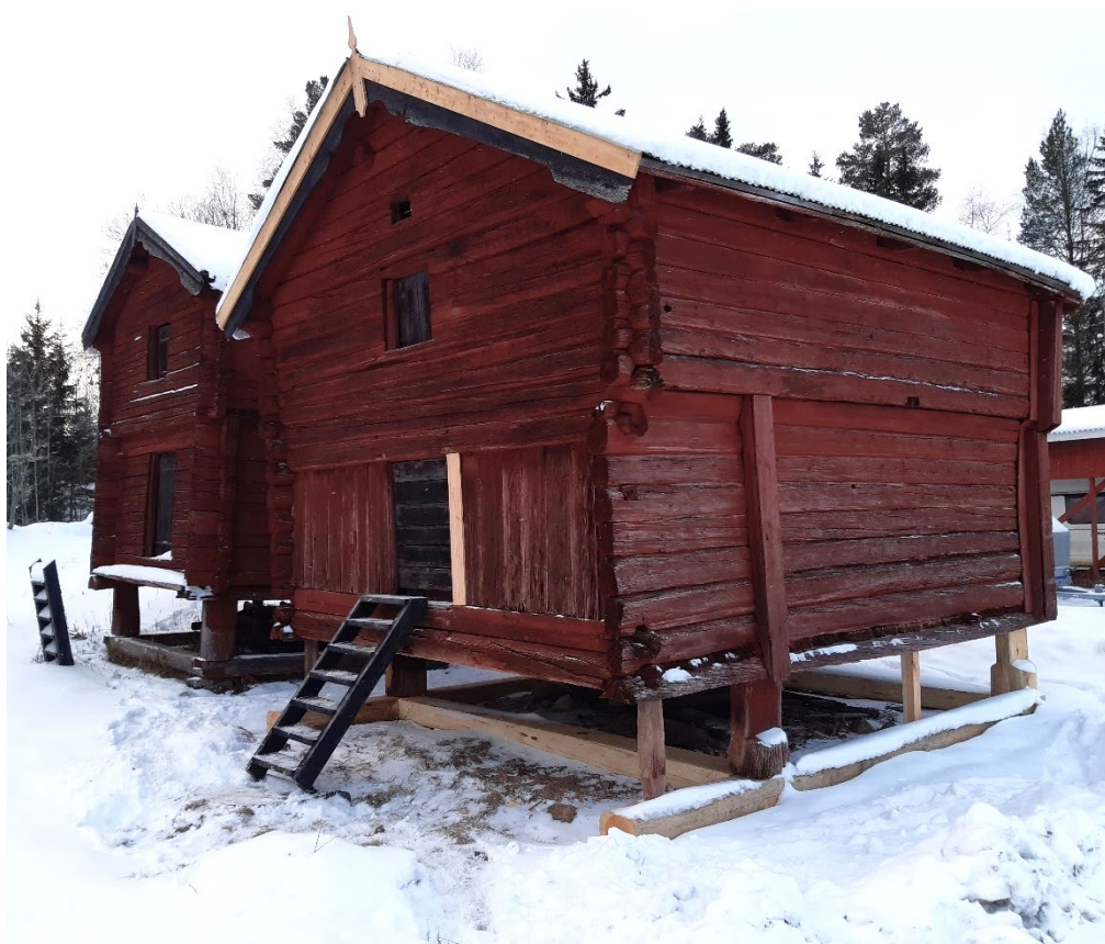
Figur 34. Gårdens äldsta härbre (närmast i bild) efter avslutad renovering. Foto från öster: Daniel Olsson, 2023-11-30.
