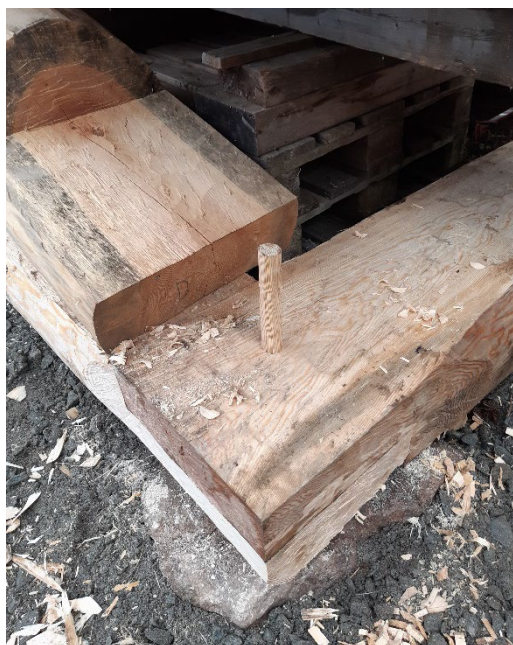
Figur 23. Detalj av syllramens sammanfogning i ett hörn. Foto: Daniel Olsson, 2023-10-25.
