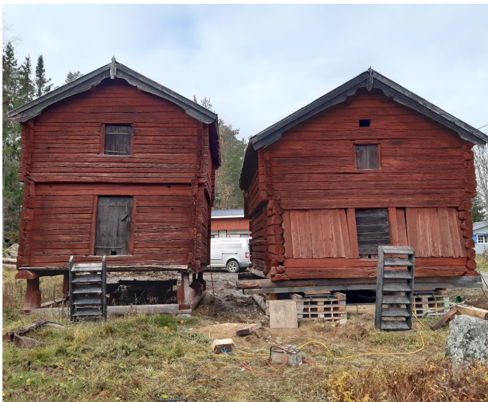
Figur 1. Det yngre härbret (till vänster) och det äldre härbret (till höger) vid Per-Måns i Veckebo, Färila socken, under pågående renovering av det äldre härbret. Foto från sydöst: Daniel Olsson, 2023-10-25.
