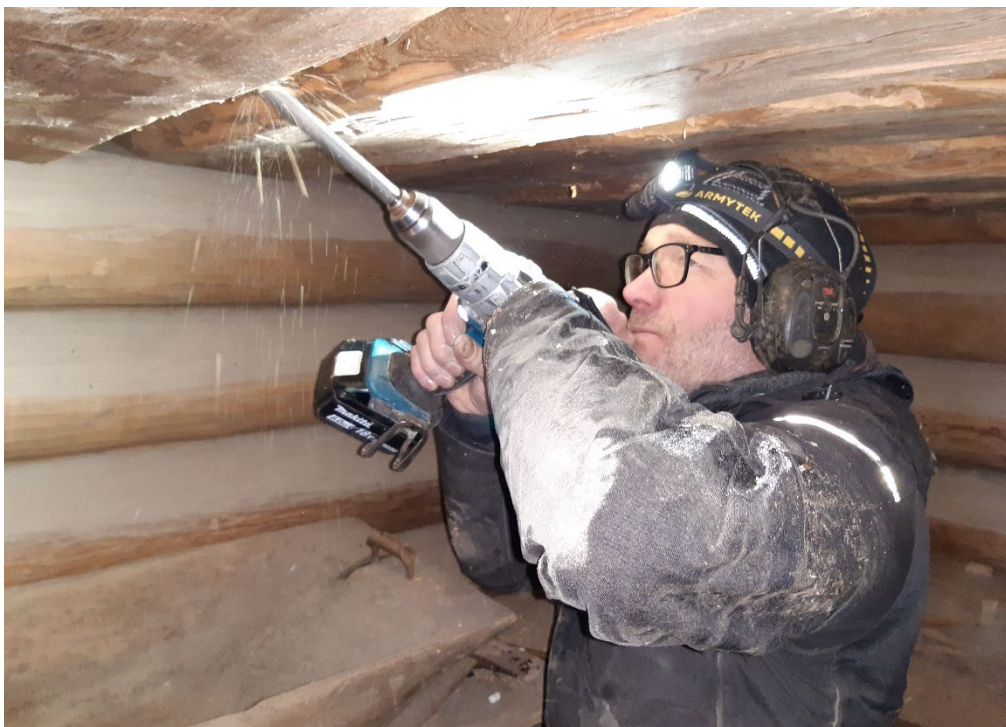
Figur 31. Daniel Åkerman tar ut borrhövar i övervåningens golv i härbret. Foto: Daniel Olsson, 2023-11-30.
