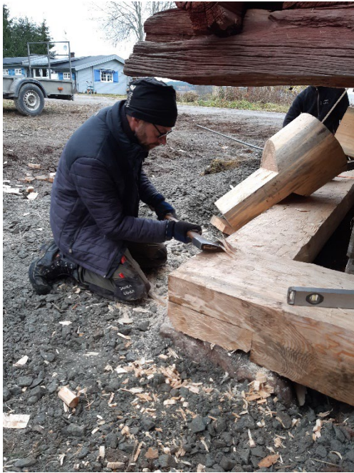
Figur 25. Anders Bekkos hugger till ytan där den nytillverkade stolpen ska placeras. Foto: Daniel Olsson, 2023-10-25.
