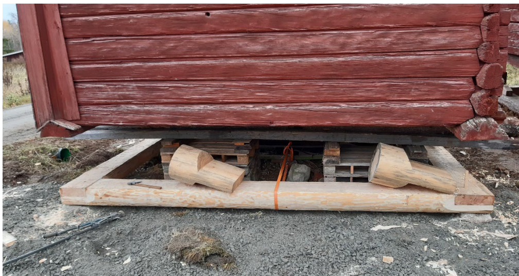
Figur 22. Syllramen från nordväst med de båda nytillverkade kraftigare stolparna. Foto: Daniel Olsson, 2023-10-25.
