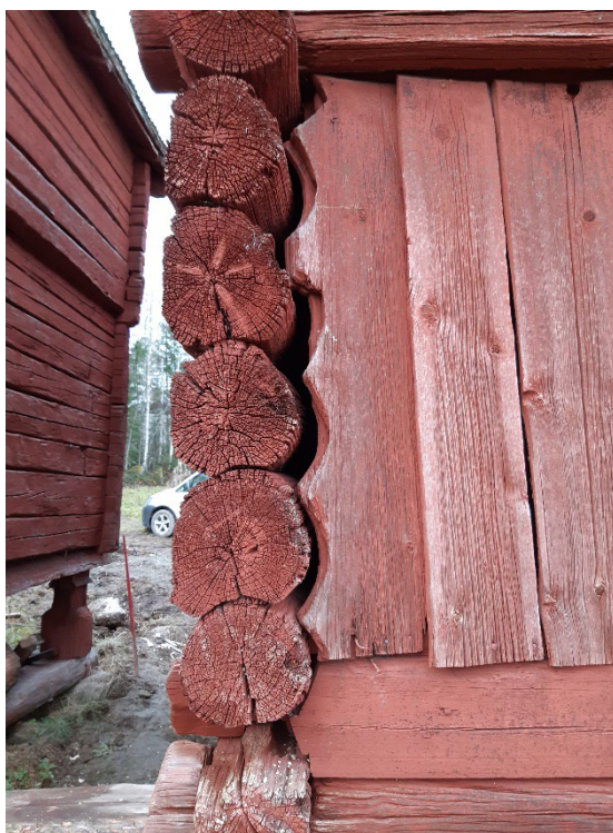
Figur 20. Detalj av knutkedja vid härbrets västra börn. Foto från sydöst, Daniel Olsson, 2023-10-25.
