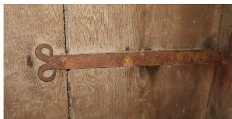
Figur 14. Detalj av en av den inre dörrens ålderdomliga järnbeslag. Foto: Daniel Olsson, 2021-09-03.
