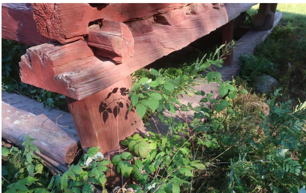
Figur 18. Syllramens nordvästra del där två stora stenar har tryckt och skadat syllramen, Foto från väster: Daniel Olsson, 2023-10-25.
