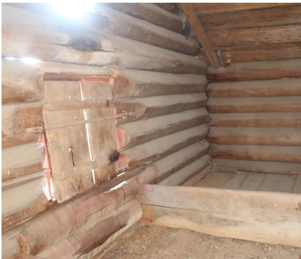
Figur 16. Övervåningens södra hörn med luckan i den sydvästra väggen. Foto: Daniel Olsson, 2021-09-03.
