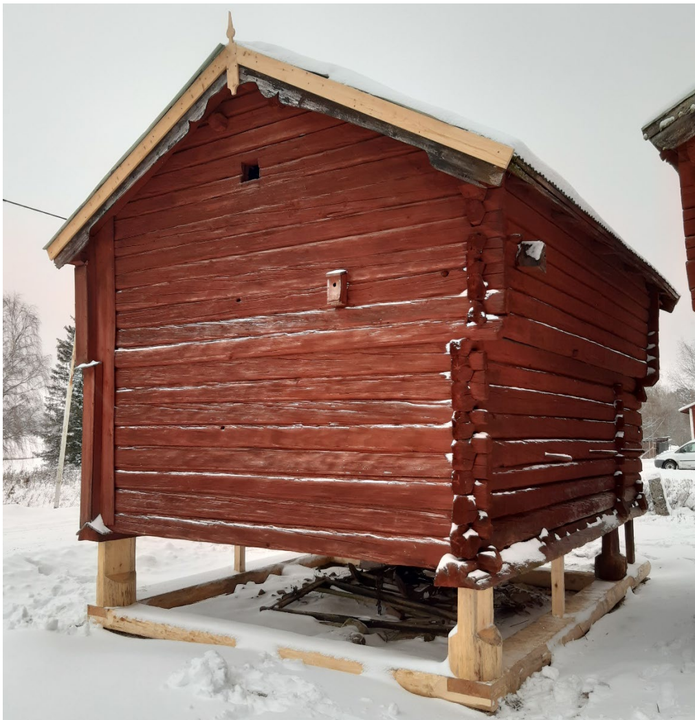
Figur 27. Detalj av härbret från väster vid slutbesiktningen. Foto: Daniel Olsson, 2023-11-03.
