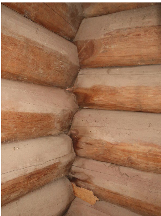
Figur 12. Detalj av en av härbrets knutar inifrån byggnaden med halsningar närmast knuten. Foto: Daniel Olsson, 2021-09-03.
