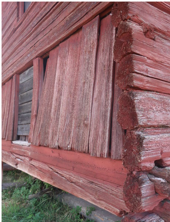
Figur 19. Detalj av panelen vid härbrets svalg innan renoveringen. Foto från öster: Daniel Olsson, 2023-10-25.
