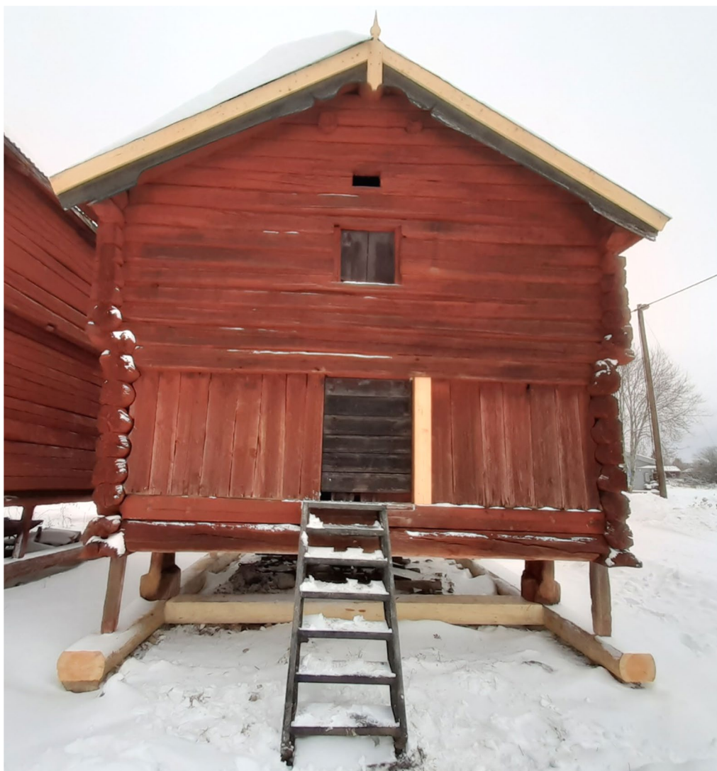
Figur 30. Härbret från sydöst vid slutbesiktningen. Foto: Daniel Olsson, 2023-11-03.
