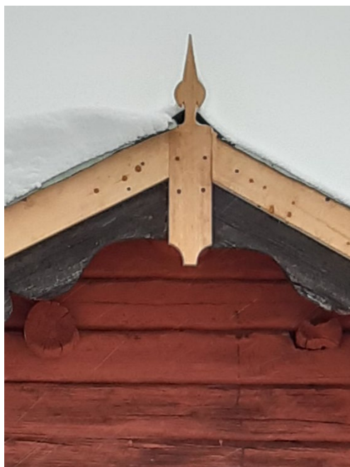
Figur 29. Detalj av den ny tillverkade utsmyckningen vid gavelspetsen. Foto från sydöst, Daniel Olsson, 2023-11-03.
