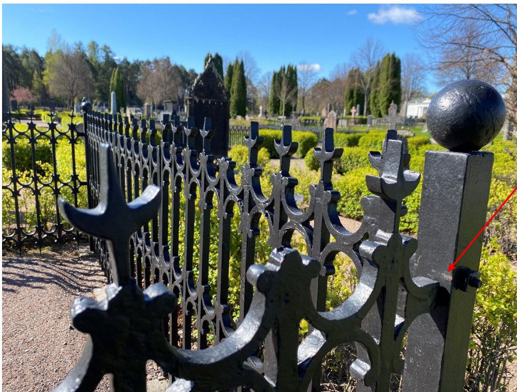
Figur 10. K03 0069 efter åtgärd. Närbild på gjutjärnsstaketet. På hörnstolpen, vid pilen, syns den typ av skada som lätt uppstår i frakten av staketet. Dessa skador bättras på plats efter att staketet är monterade. Foto: Ulrika Olsson, Länsmuseet Gävleborg, 2025-05-06.
