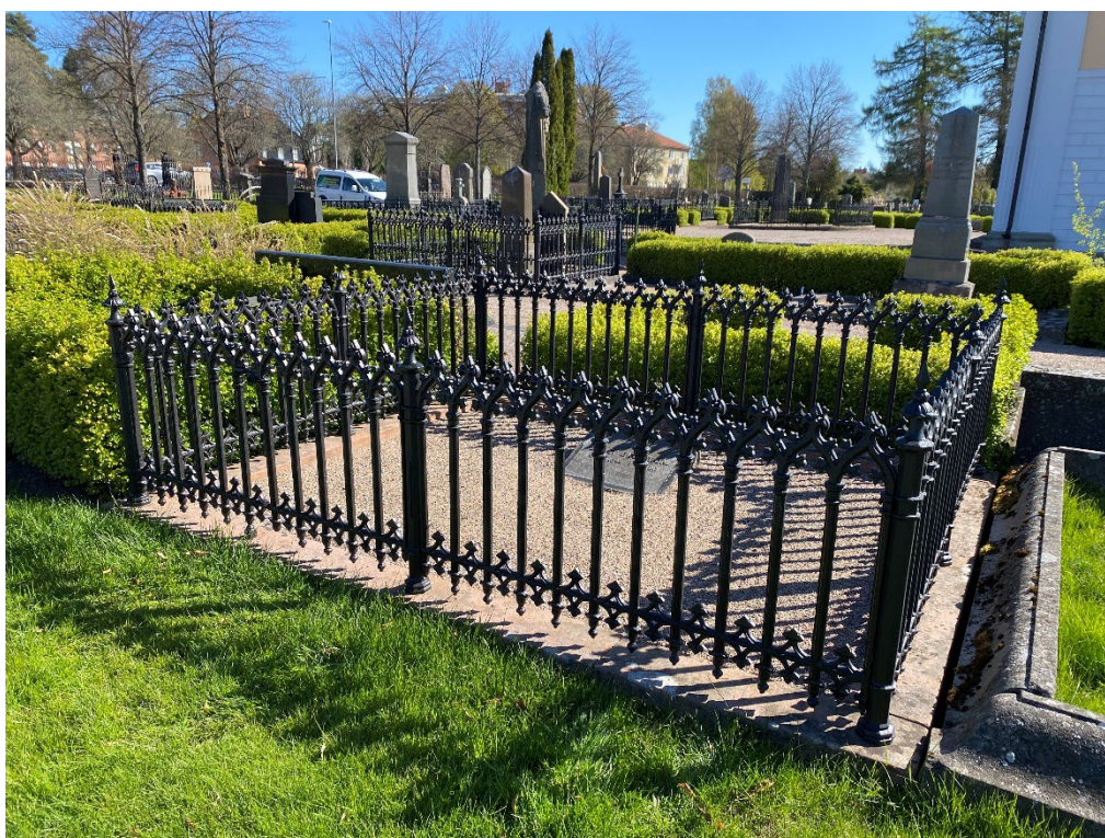
Figur 5. GK03 0054 efter åtgärd. Stensockeln har riktats och gjutjärnsstaketet har renoverats. Foto: Ulrika Olsson, Länsmuseet Gävleborg, 2025-05-06.
