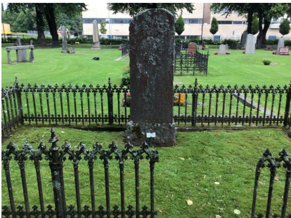
Figur 17. GK06 0255+, 280 innan åtgärd. Gjutjärnsstaket i behov av renovering. Grind och grindstolpe saknas. Stensockel i behov av riktning. Foto: Kyrkogårdsenheten, Gävle församling, sommar 2023.
