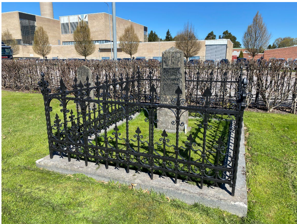
Figur 16. GK06 0020 efter åtgärd. Stensockeln har riktats och smidesstaketet har renoverats. Foto: Ulrika Olsson, Länsmuseet Gävleborg, 2025-05-06.
