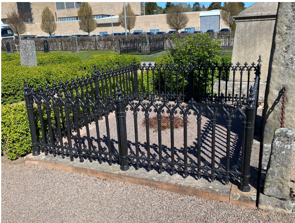
Figur 14. GK05 0150 efter åtgärd. Stensockeln har riktats och gjutjärnsstaketet Foto: Ulrika Olsson, Länsmuseet Gävleborg, 2025-05-06.
