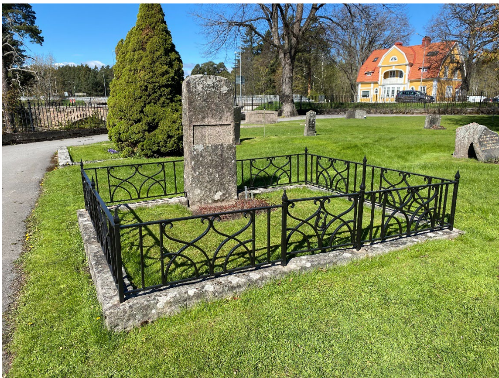
Figur 20. GK10 0175 efter åtgärd. Stensockeln har riktats och smidesstaketet har renoverats. Foto: Ulrika Olsson, Länsmuseet Gävleborg, 2025-05-06.
