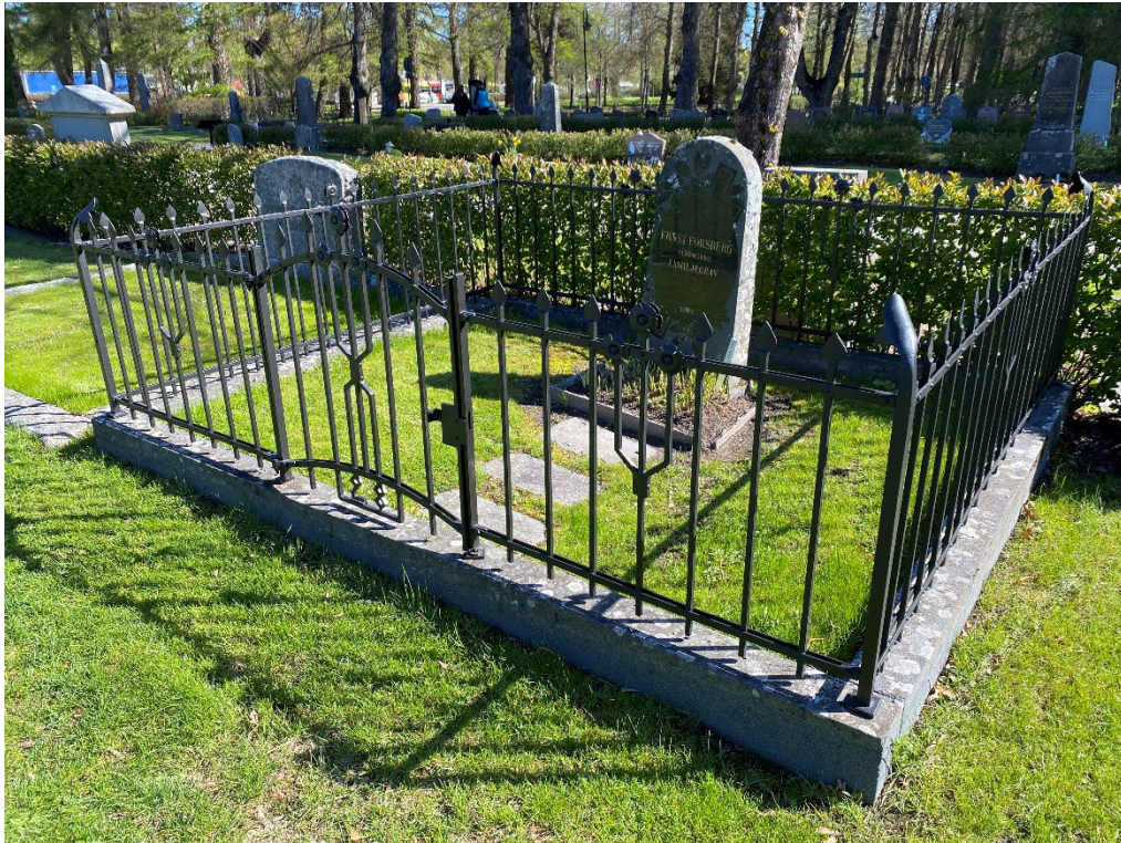
Figur 4. GK12 0028 efter åtgärd. Stensockeln har riktats och smidesstaketet har renoverats. Foto: Ulrika Olsson, Länsmuseet Gävleborg, 2025-05-06.
