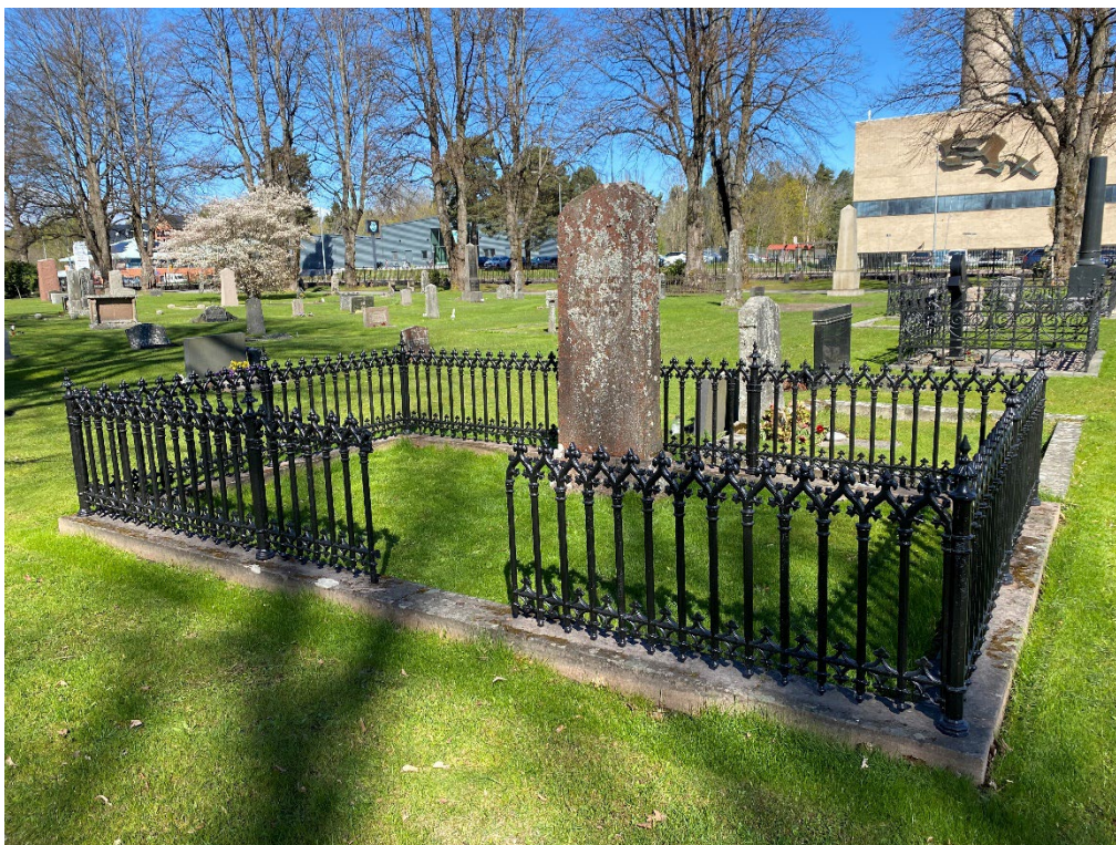
Figur 18. GK06 0255+, 280 efter åtgärd. Stensockeln har riktats och gjutjärnsstaketet har renoverats. Grindöppningen har lämnats som den var, det vill säga i avsaknad av grind och grindstolpe. Foto: Ulrika Olsson, Länsmuseet Gävleborg, 2025-05-06.
