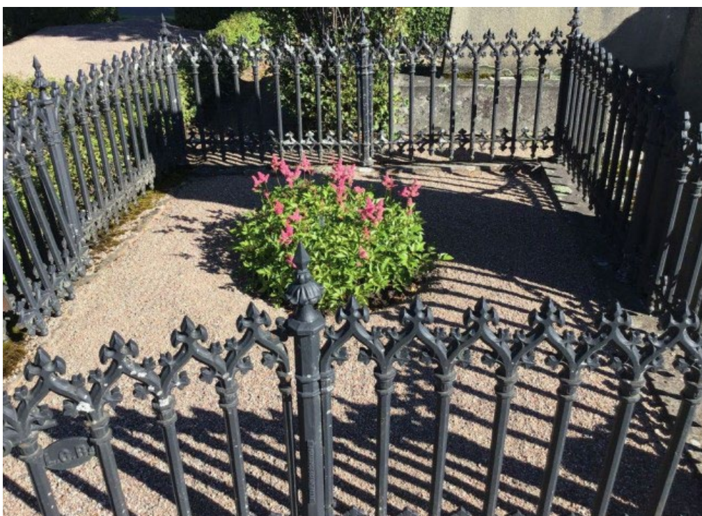
Figur 13 GK05 0150 innan åtgärd. Gjutjärnsstaket i behov av renovering. Stensockel i behov av riktning. Foto: Kyrkogårdsenheten, Gävle församling, sommar 2023.
