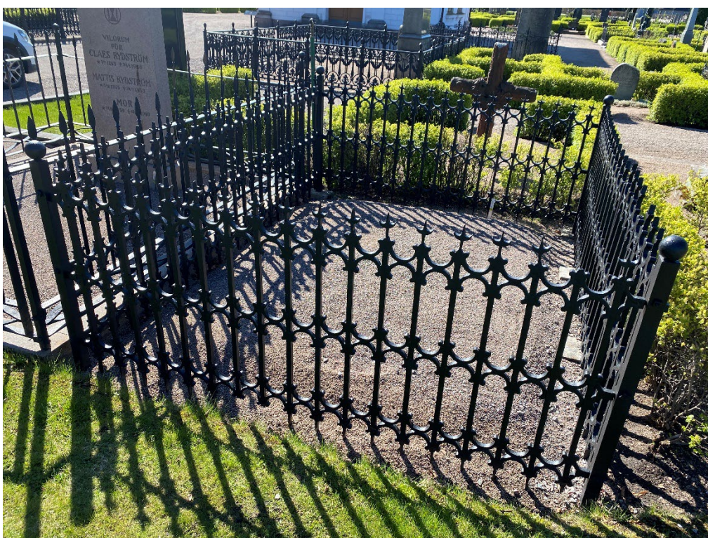
Figur 9. K03 0069 efter åtgärd. Stenkuberna har riktats och gjutjärnsstaketet har renoverats. Foto: Ulrika Olsson, Länsmuseet Gävleborg, 2025-05-06.
