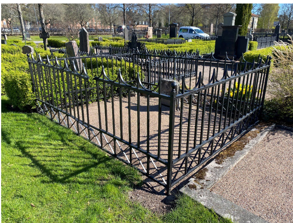
Figur 7. GK03 0057 efter åtgärd. Hörnstenarna har riktats och smidesstaketet har renoverats. Foto: Ulrika Olsson, Länsmuseet Gävleborg, 2025-05-06.
