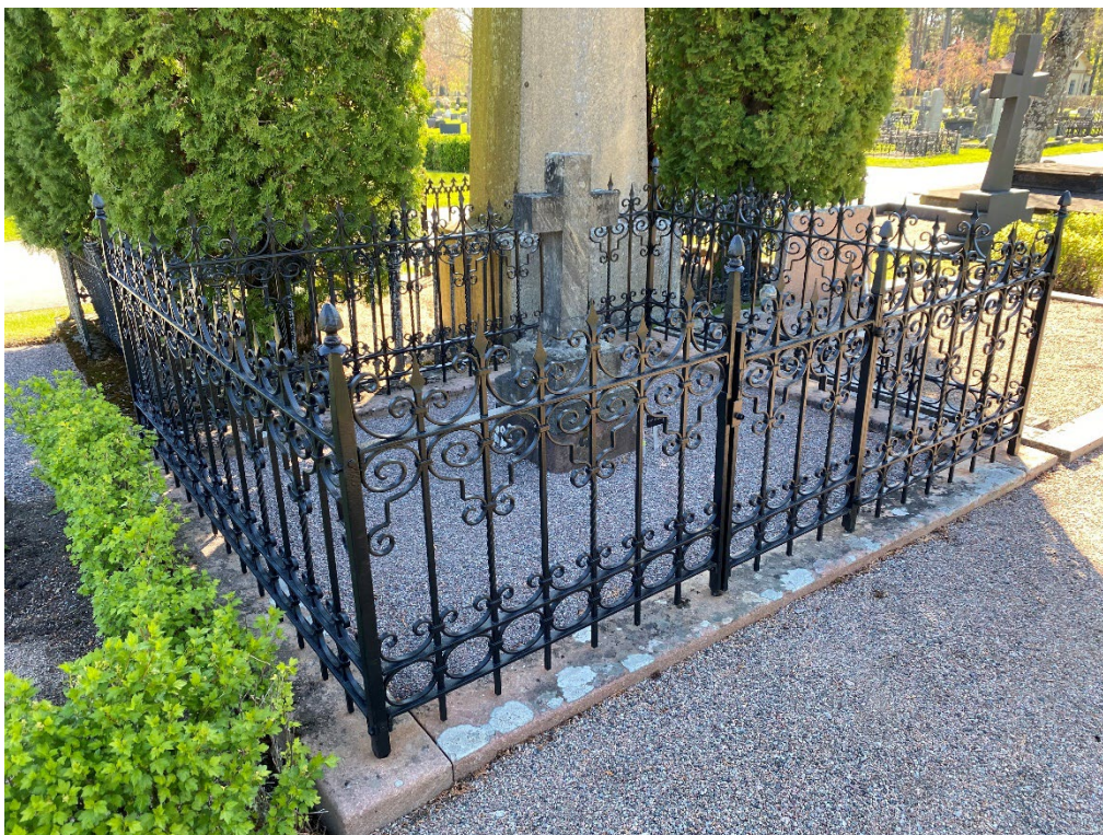
Figur 12. GK05 0054 efter åtgärd. Stensockeln har riktats och smidesstaketet har renoverats. Foto: Ulrika Olsson, Läns museet Gävleborg, 2025-05-06.
