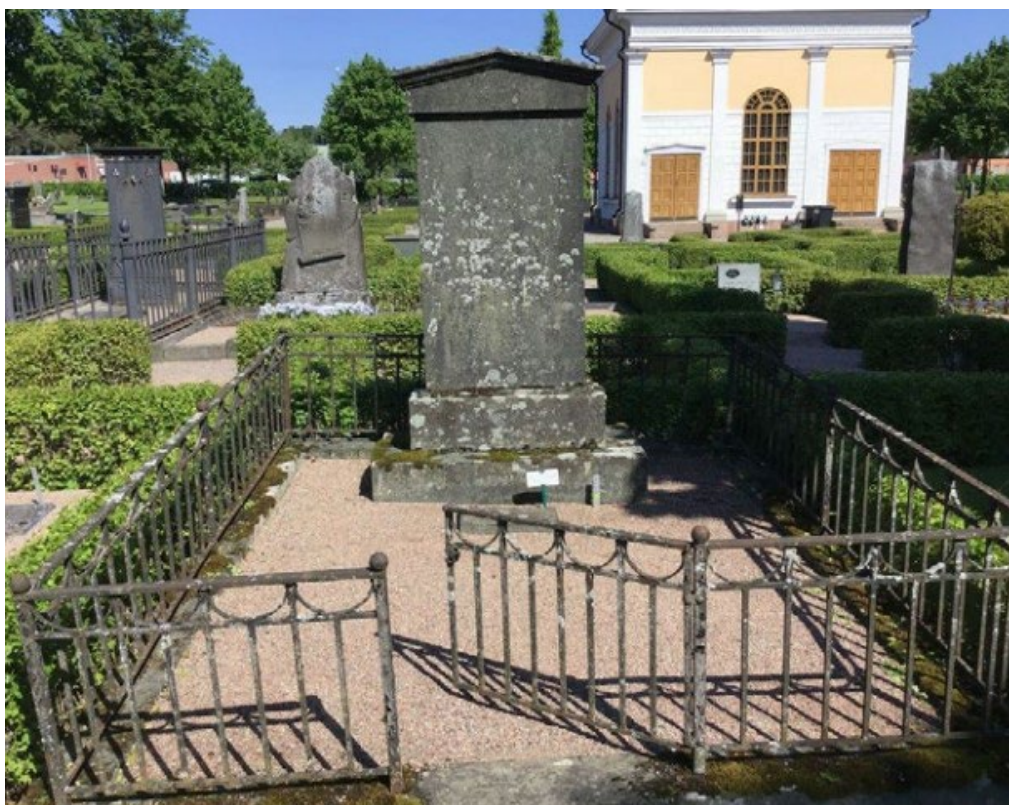
Figur 2. GK03 0036B innan åtgärd. Smidesstaket i behov av renovering. Stensockel i behov av riktning. Foto: Kyrkogårdsenheten, Gävle församling, sommar 2023.
