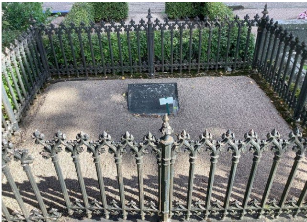
Figur 4. GK03 0054 innan åtgärd. Gjutjärnsstaket i behov av renovering. Stensockel i behov av riktnings. Foto: Kyrkogårdsenheten, Gävle församling, sommar 2023.
