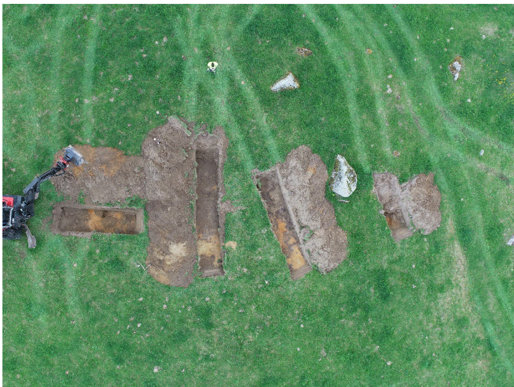
Figur 11. Drönarfotografi över schakt 159-162 under pågående schaktning. Foto: Linus Eriksson.
