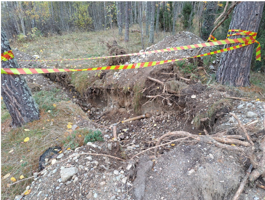
Figur 4. Yta schaktad utan övervakning före 14 oktober. Foto: Linus Eriksson.
