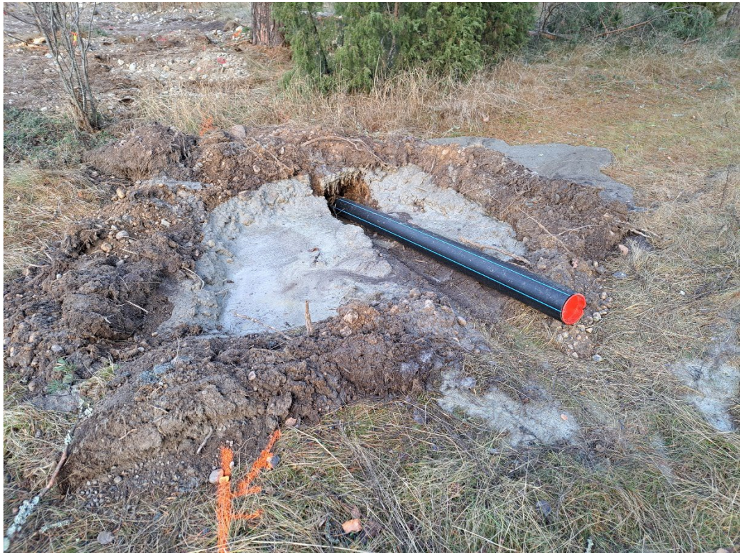
Ej övervakad del I schaktets norra spets. Foto: Linus Eriksson.
