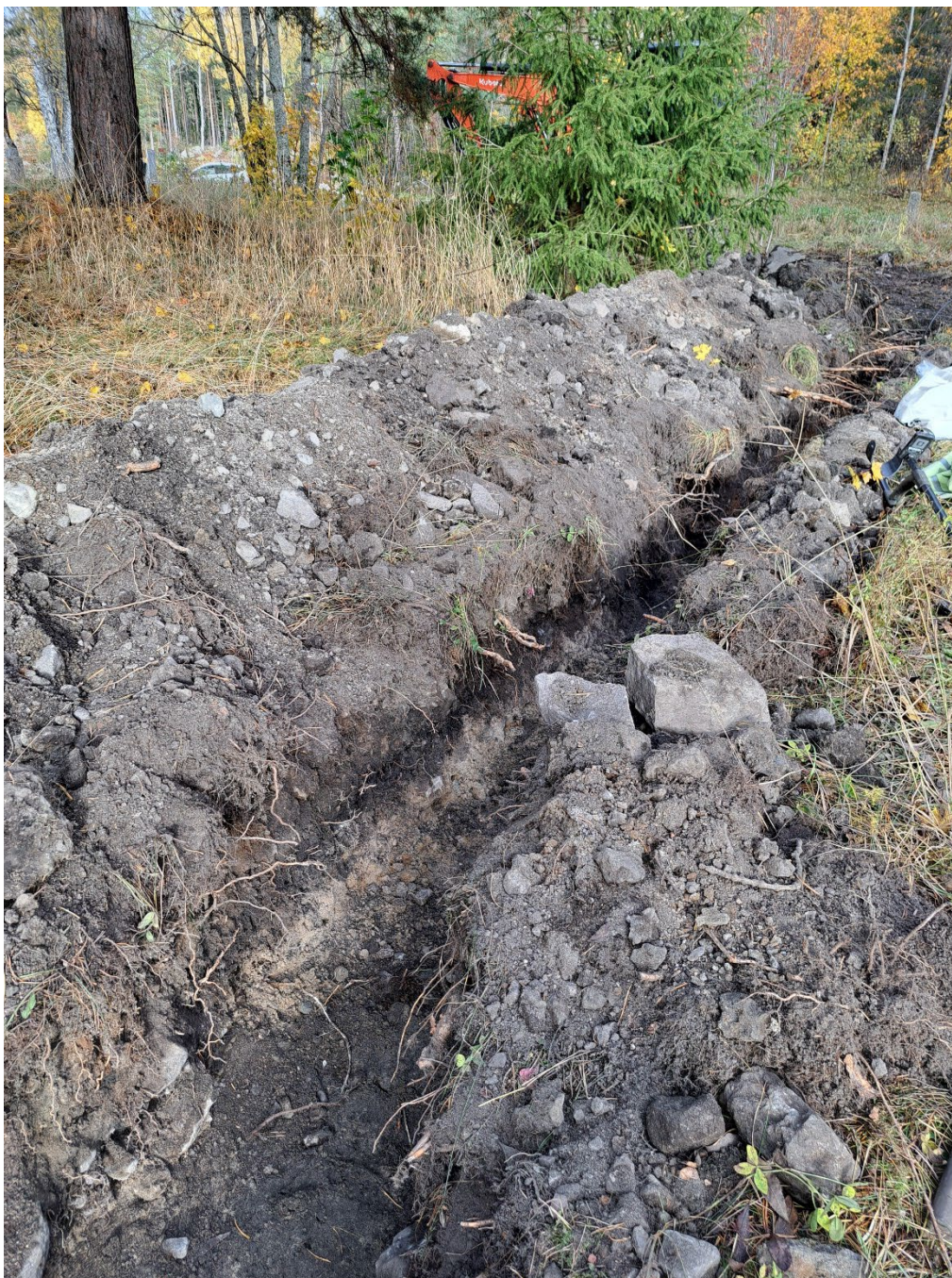
Centrala delen av schaktet och sotlager A123 under pågående schaktning. Foto: Linus Eriksson.
