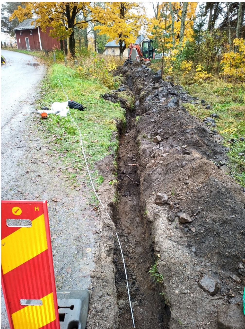
Norra delen av schaktet med kulturlager under pågående schaktning. Foto: Linus Eriksson.
