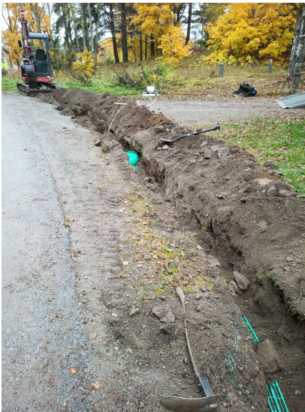
Norra delen av schaktet utan kulturlager under pågående schaktning. Foto: Linus Eriksson.
