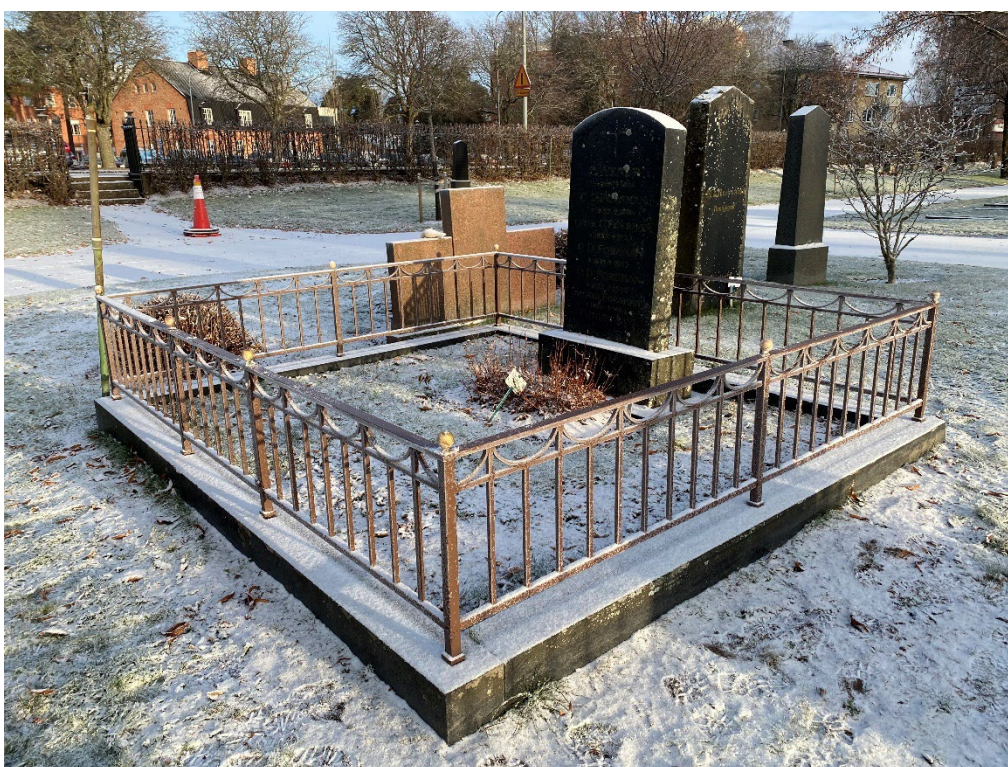
Figur 13. GK02 0006 efter åtgärd. Stensockeln har rengjorts och riktats och smidesstaketet har renoverats. Enligt färgdokumentationen utförd av Per Mattsson ska staketet målas i kulör NCS S 9000-N, svart. Staketet är nu målat i kulör NCS S 7010-Y70R, gråbrun. Knopparna är i massiv mässing och har lämnats utan åtgärd. Foto: Ulrika Olsson, Läns museet Gävleborg, 2025-11-19.
