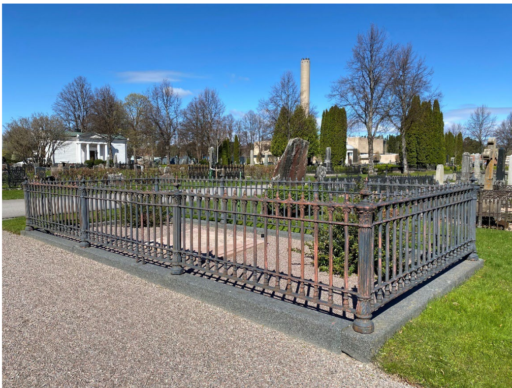
Figur 15. GK04 0007+, 0008+, 0030+ innan åtgärd. Gjutjärnsstaket i behov av renovering. Stensockeln var i visst behov av riktning. Foto: Ulrika Olsson, Länsmuseet Gävleborg, 2025-05-06.
