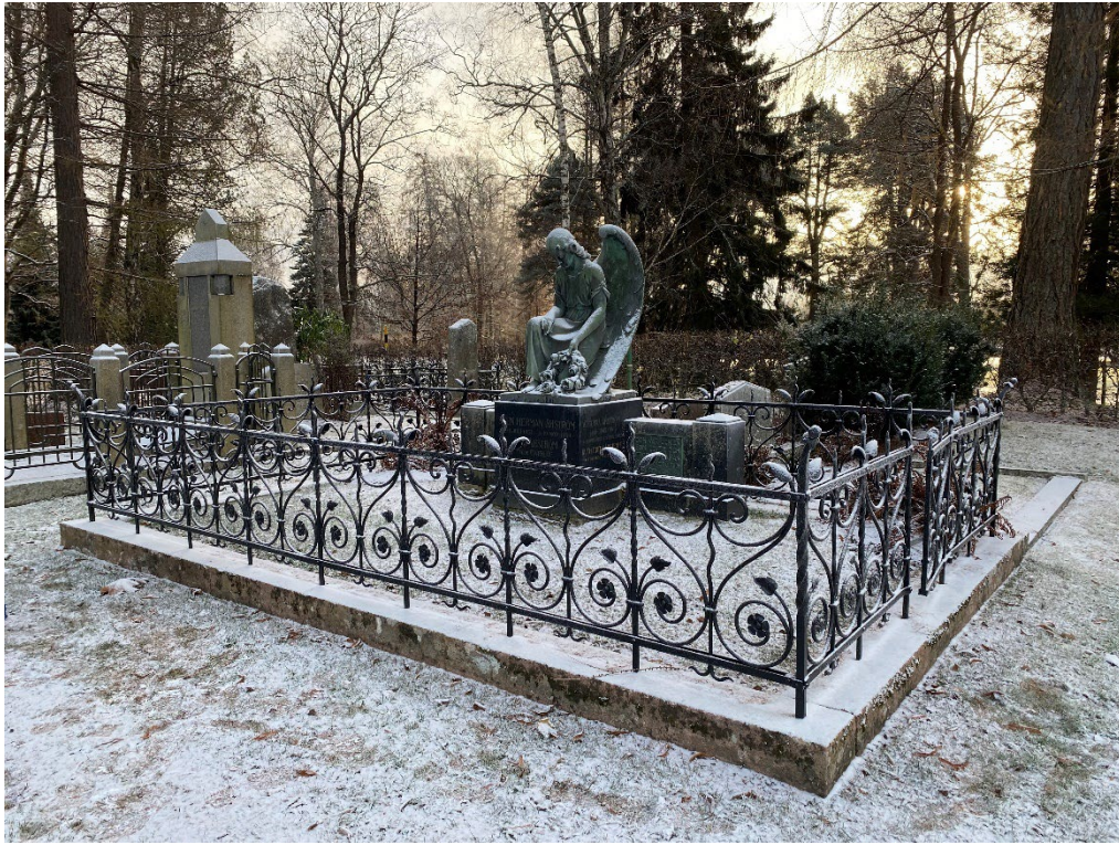
Figur 4. GK01 0073+ efter åtgärd. Stensockeln har rengjorts och riktats och smidesstaketet har renoverats. Foto: Ulrika Olsson, Länsmuseet Gävleborg, 2025-11-19.
