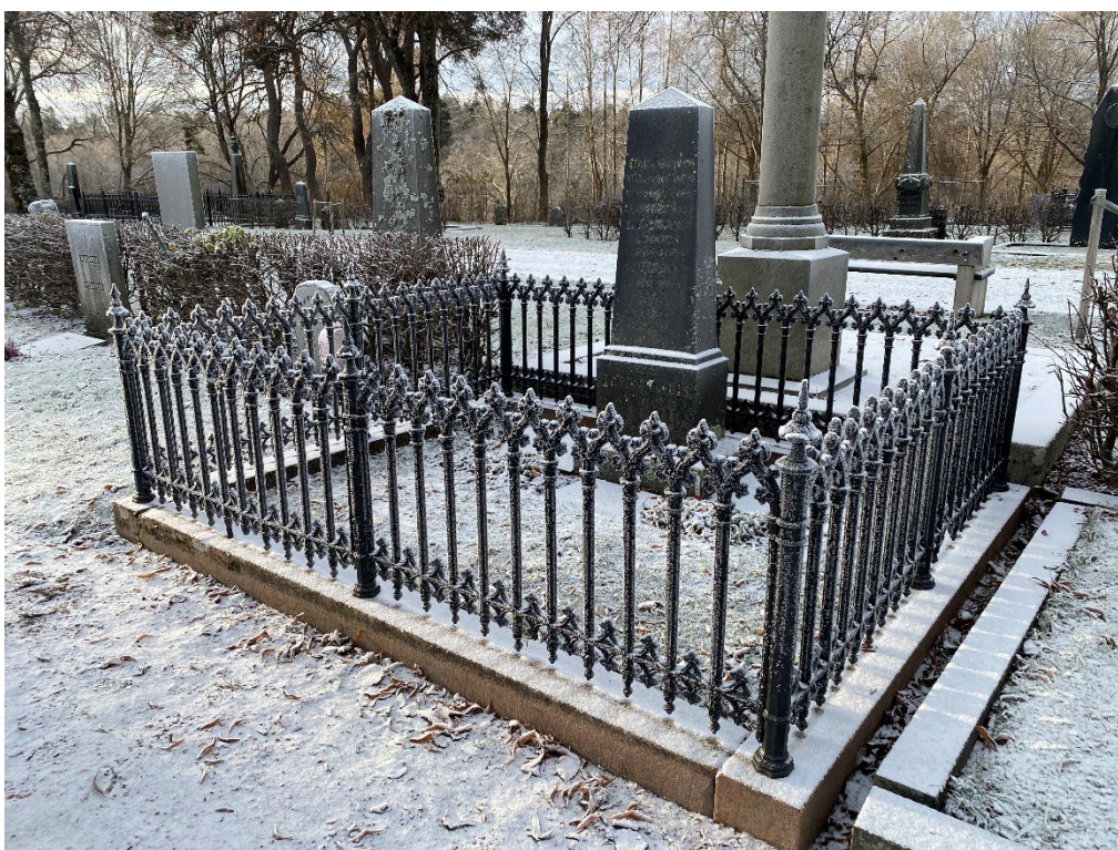
Figur 28. GK07 0116 efter åtgärd Stensockeln har rengjorts och riktats och gjutjärnsstaketet har renoverats. Foto: Ulrika Olsson, Läns museet Gävleborg, 2025-11-19.
