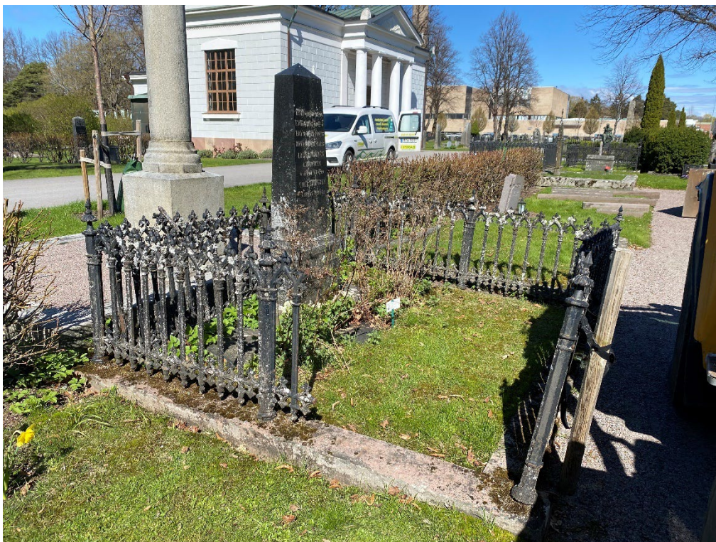
Figur 27. GK07 0116 innan åtgärd. Gjutjärnsstaket i behov av renovering. Stensockel i behov av rengöring och riktning. En staketsektion stod lutad mot staketet bakom gravstenen. Foto: Ulrika Olsson, 2025-05-06.
