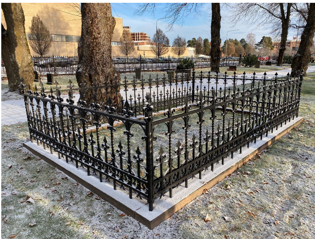
Figur 26. GK06 0333–0334 efter åtgärd. Stensockeln har rengjorts och hela ramen har flyttats ut någon centimeter från trädet. Gjutjärnsstaketet har renoverats. Foto: Ulrika Olsson, Länsmuseet Gävleborg, 2025-11-19.
