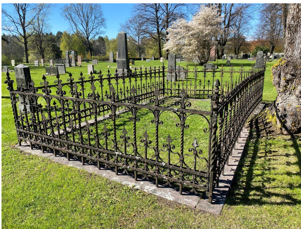
Figur 24. GK06 0333–0334 innan åtgärd. Smidesstaket i behov av renovering. Stensockel i behov av rengöring och riktning. Trädets rötter låg väldigt nära stensockeln. Foto: Ulrika Olsson, 2025-05-06.
