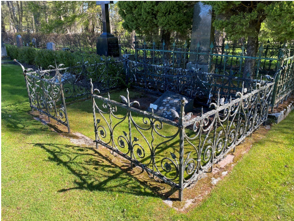
Figur 5. GK01 0162 innan åtgärd. Smidesstaket i behov av renovering. Stensockel i behov av rengöring och riktning. Foto: Ulrika Olsson, Länsmuseet Gävleborg, 2025-05-06.
