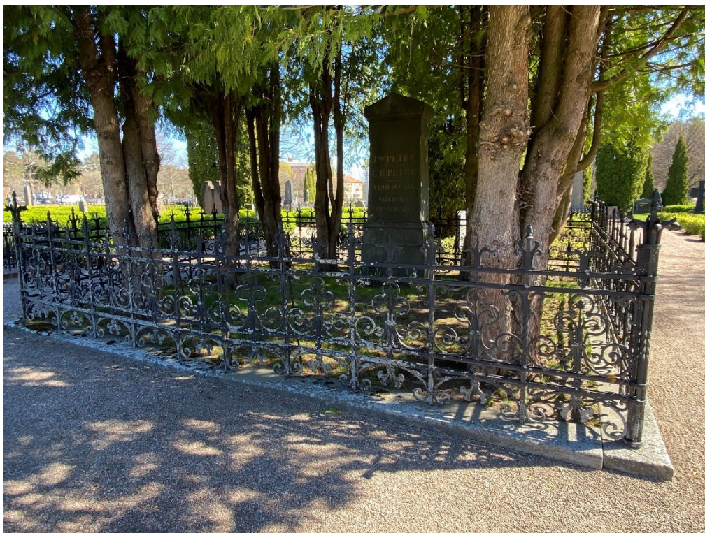
Figur 21. GK05 0201+ innan åtgärd. Smidesstaket i behov av renovering. Stensockel i behov av rengöring och riktning. Fyra mycket högresta tujor hade orsakat sättningar i gravanordningarna och skulle därför tas ner. Foto: Ulrika Olsson, Länsmuseet Gävleborg, 2025-05-06.
