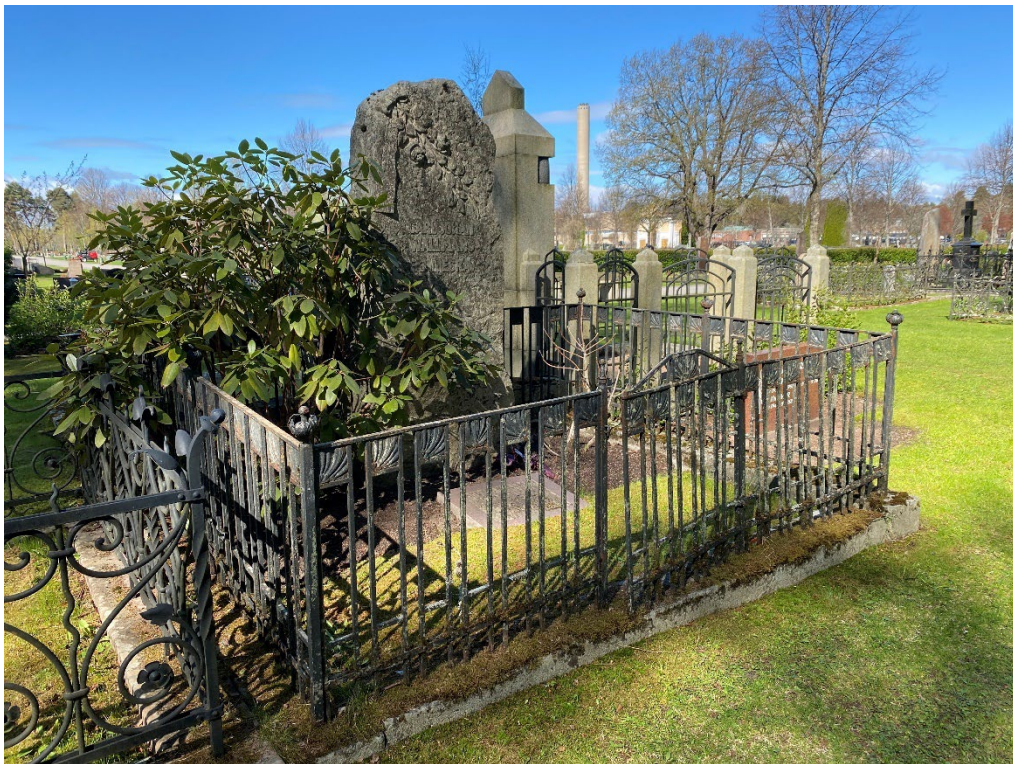
Figur 7. GK01 0167 innan åtgärd. Smidesstaketet i behov av renovering. Stensockel i behov av rengöring och riktning. Färgdokumentation efterfrågades. Foto: Ulrika Olsson, Länsmuseum Gävleborg, 2025-05-06.
