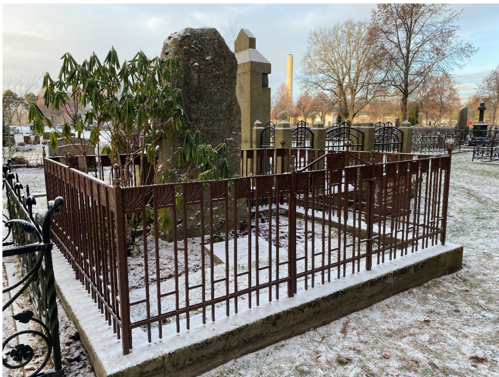
Figur 8. GK01 0167 efter åtgärd. Stensockeln har rengjorts och riktats och smidesstaketet har renoverats. Enligt färgdokumentationen utförd av Per Mattsson ska staketet målas i kulör NCS 8010-Y90R, mörkt brun. Staketet är nu felaktigt målat i kulör NCS S 7010-Y70R, gråbrun. Foto: Ulrika Olsson, Läns museet Gävleborg, 2025-11-19.
