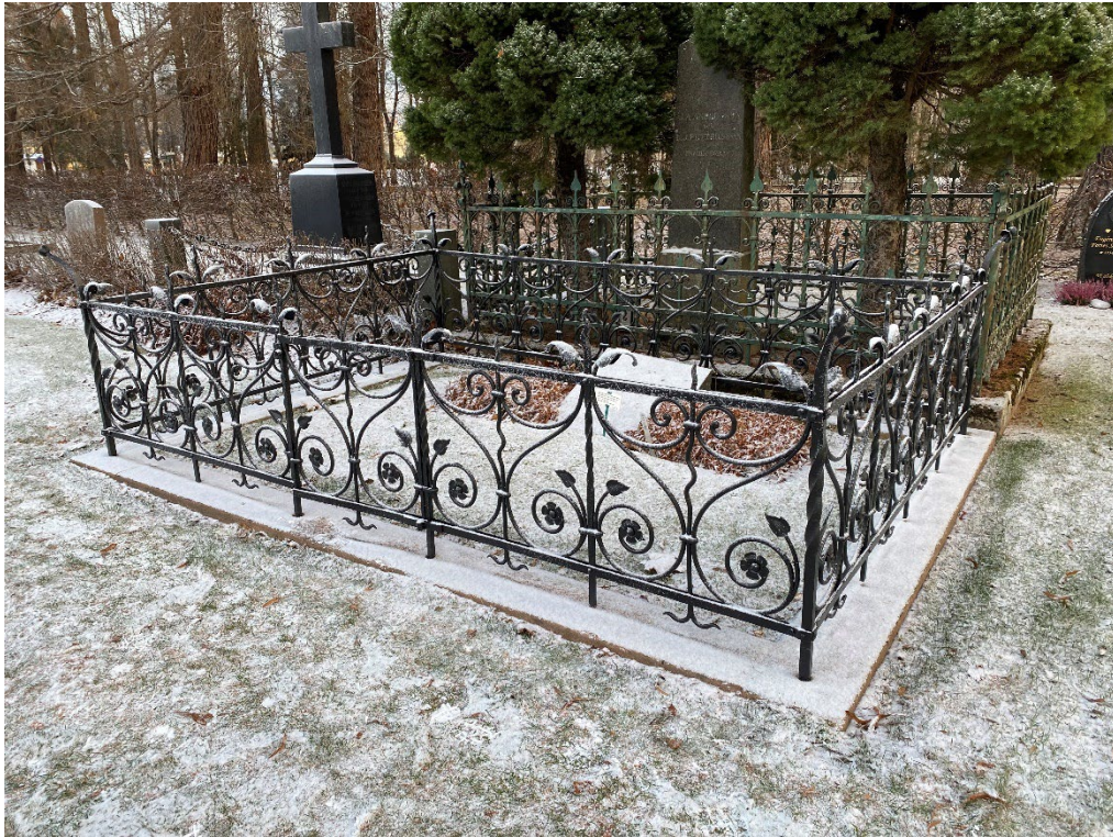
Figur 6. GK01 0162 efter åtgärd. Stensockeln har rengjorts och riktats och smidesstaketet har renoverats. Foto: Ulrika Olsson, Länsmuseum Gävleborg, 2025-11-19.
