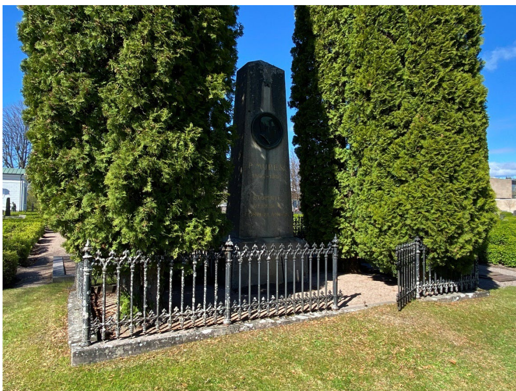
Figur 18. GK05 0053+55 innan åtgärd. Gjutjärnsstaket i behov av renovering. Stensockel i behov av rengöring och riktning. Fyra mycket högresta tujor hade orsakat sättningar i gravanordningarna och skulle därför tas ner. Foto: Ulrika Olsson, Länsmuseet Gävleborg, 2025-05-06.
