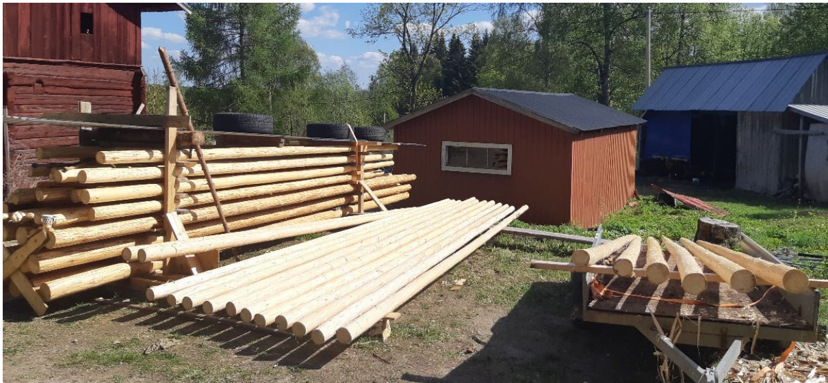
Figur 25. Virke till storhässjans snedsträvor och roer upplagt för torkning i Gräsåsen. Foto: Stefan Bromhed Sundin, 2023-05-20.
