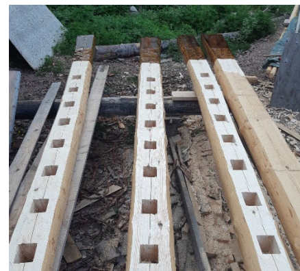
Figur 26. Storbässjans vertikala stolpar efter upptagning av rektangulära hål för roerna samt tjärning av de delar som skulle placeras under mark. Foto: Stefan Bromhed Sundin, 2023-06-14.
