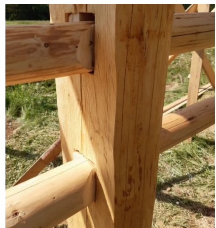
Figur 27. Detalj av roernas inpassning och skarvning i stolparnas rektangulära hål. Foto: Daniel Olsson, 2023-06-26.
