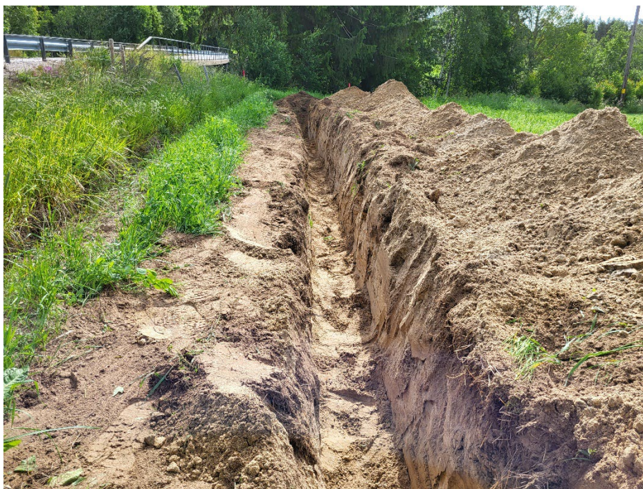
Figur 5. Schakt 2 mot öst. Foto: Andreas Widerberg.
