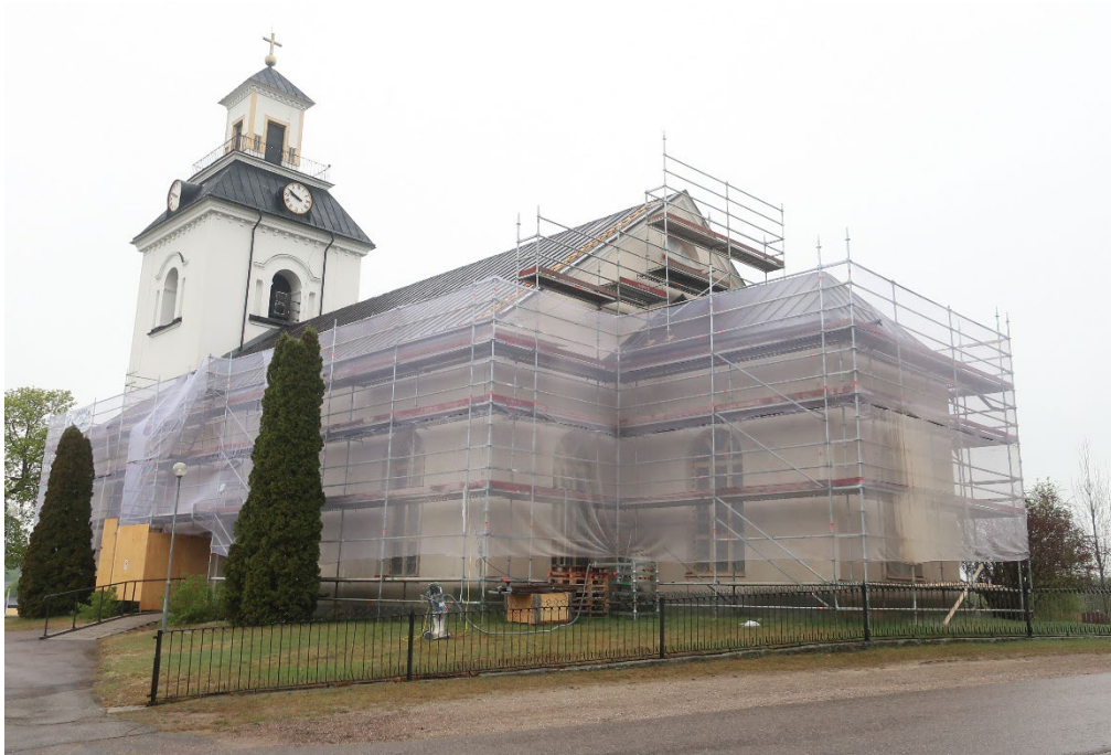
Figur 18. Ilsbo kyrka från sydöst efter att byggnadsställningarna hade satts upp under renoveringsetapp 1. Foto: Daniel Olsson, 2022-05-25.
