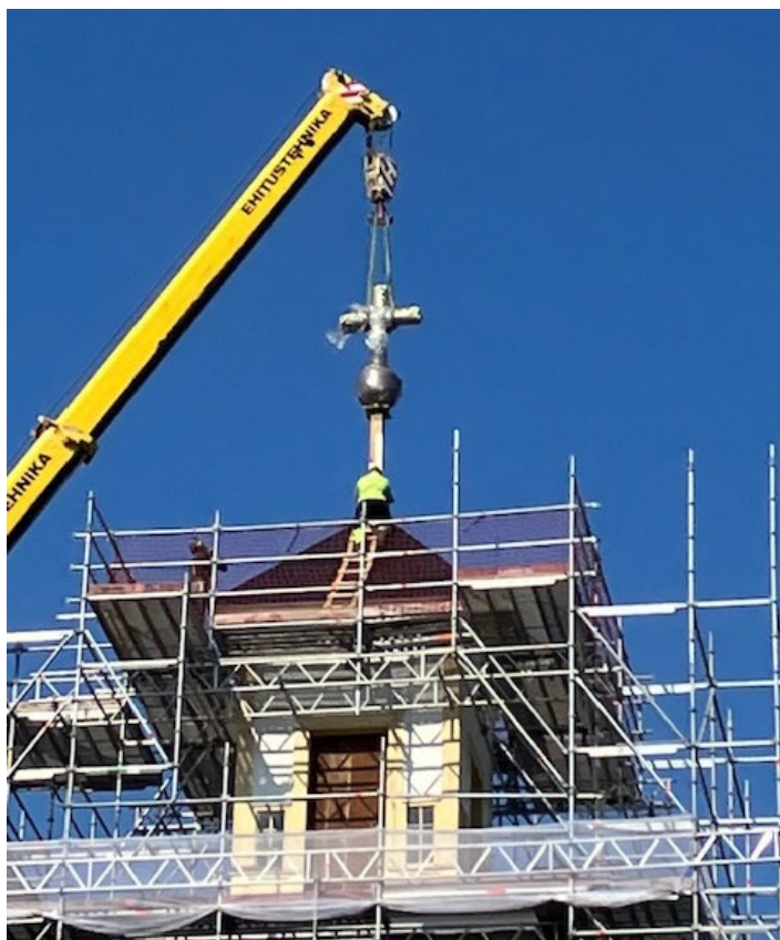
Figur 56. Klotet och korset lyfts på plats med hjälp av lyftkran. Foto: Lennart Carlsson, 2023-06-08.
