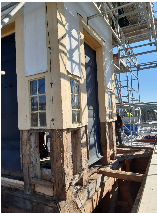
Figur 32. Lanterninens västra del från nordväst under pågående renovering. All panel under fönstren har tagits bort. Foto: Daniel Olsson, 2023-04-19.
