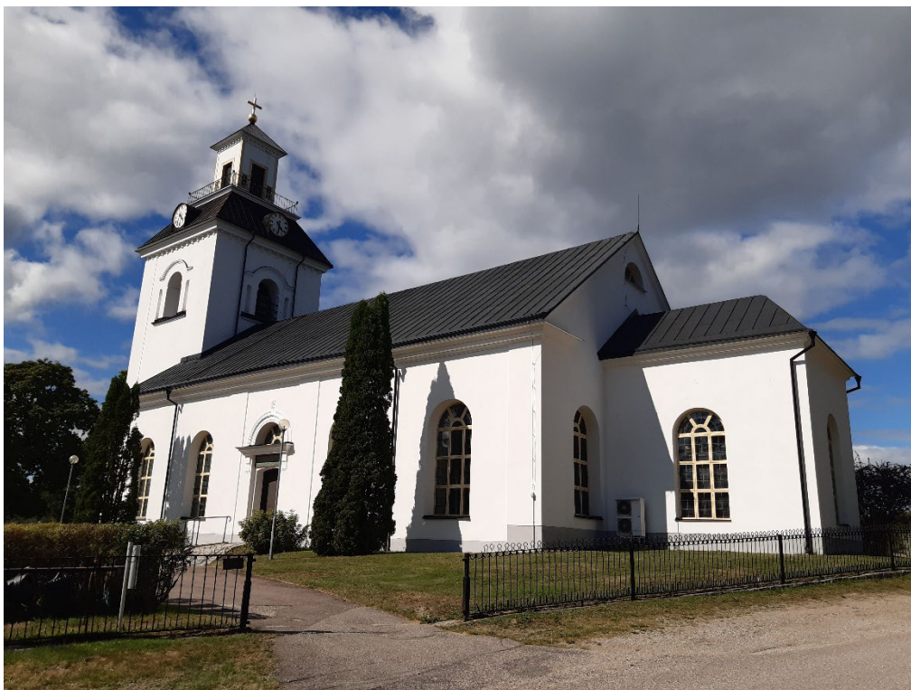
Figur 63. Ilsbo kyrka från sydväst efter avslutad renovering. Foto: Daniel Olsson, 2025-08-12.
