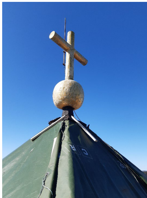
Figur 16. Klotet och korset med urlakad förgyllning. Fotot taget under renoverings-etapp 2. Foto: Daniel Olsson, 2023-04-19.
