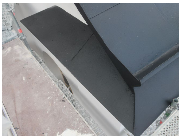
Figur 53. Detalj av utbytt och målad plåt vid långhusets nordöstra hörn. Foto: Daniel Olsson, 2022-08-17.
