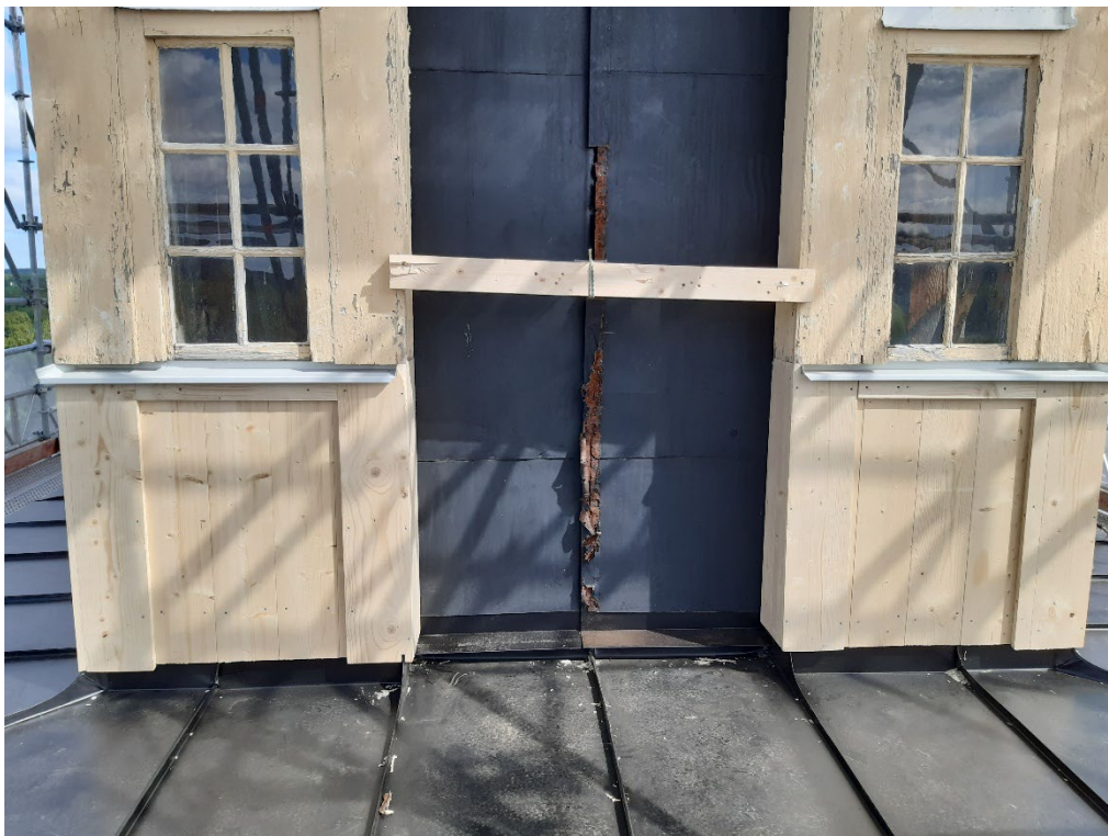
Figur 35. En av lanterninens fasader med ny panel under fönstren. Foto: Daniel Olsson, 2023-06-01.
