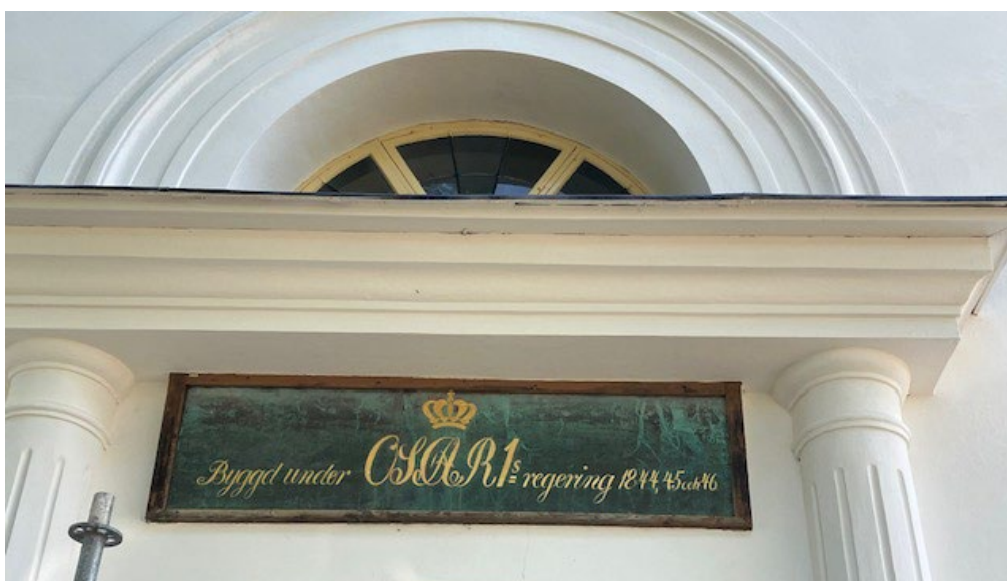
Figur 55. Inskriptionstavlan ovanför kyrkans huvudentré efter omförgyllning. Foto: Lennart Carlsson, 2023-06-14.
