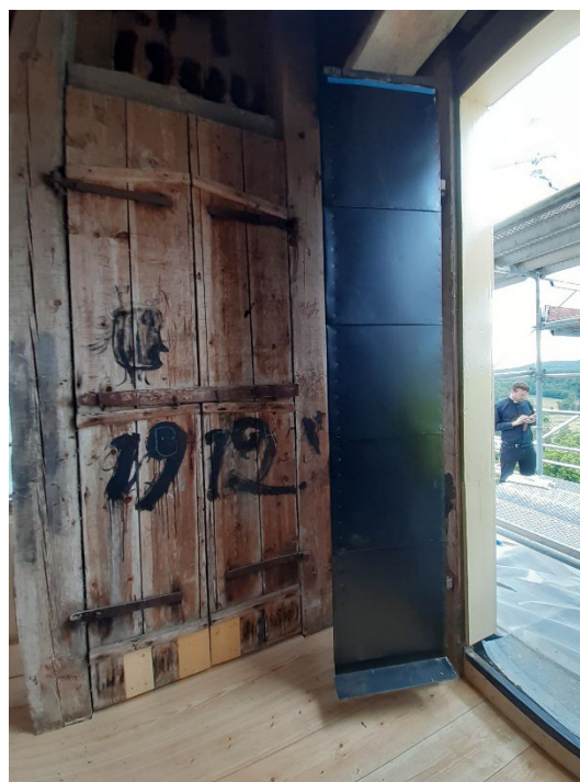
Figur 49. En av dörrbladen med ny plåtbeklädnad. Foto: Daniel Olsson, 2023-06-28.
