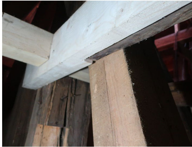
Figur 34. Detalj av utbytta delar av bjälkar under lanterninen. Foto: Daniel Olsson, 2023-05-10.
