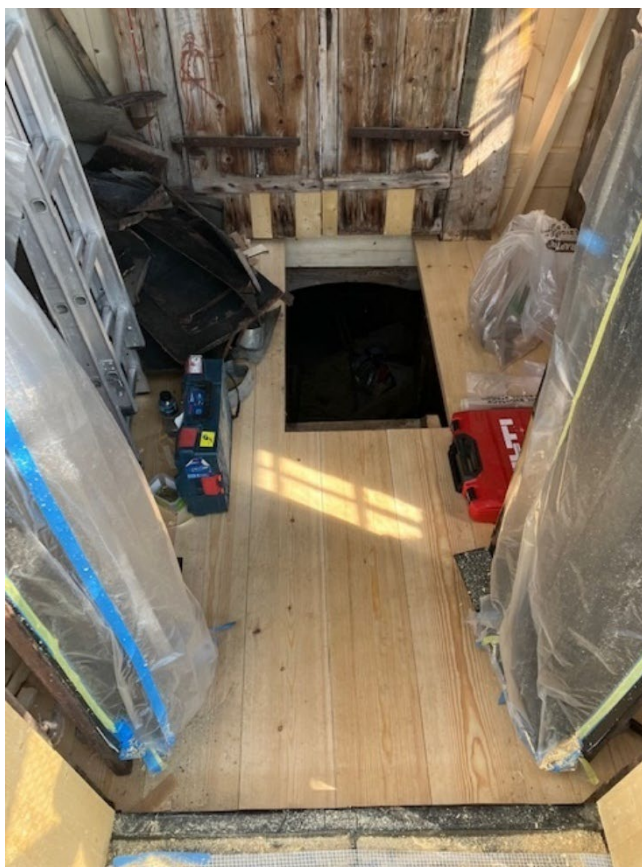
Figur 59. Detalj av lanterninens omlagda trägolv med bredare brädor. Foto: Lennart Carlsson, 2023-06-14.
