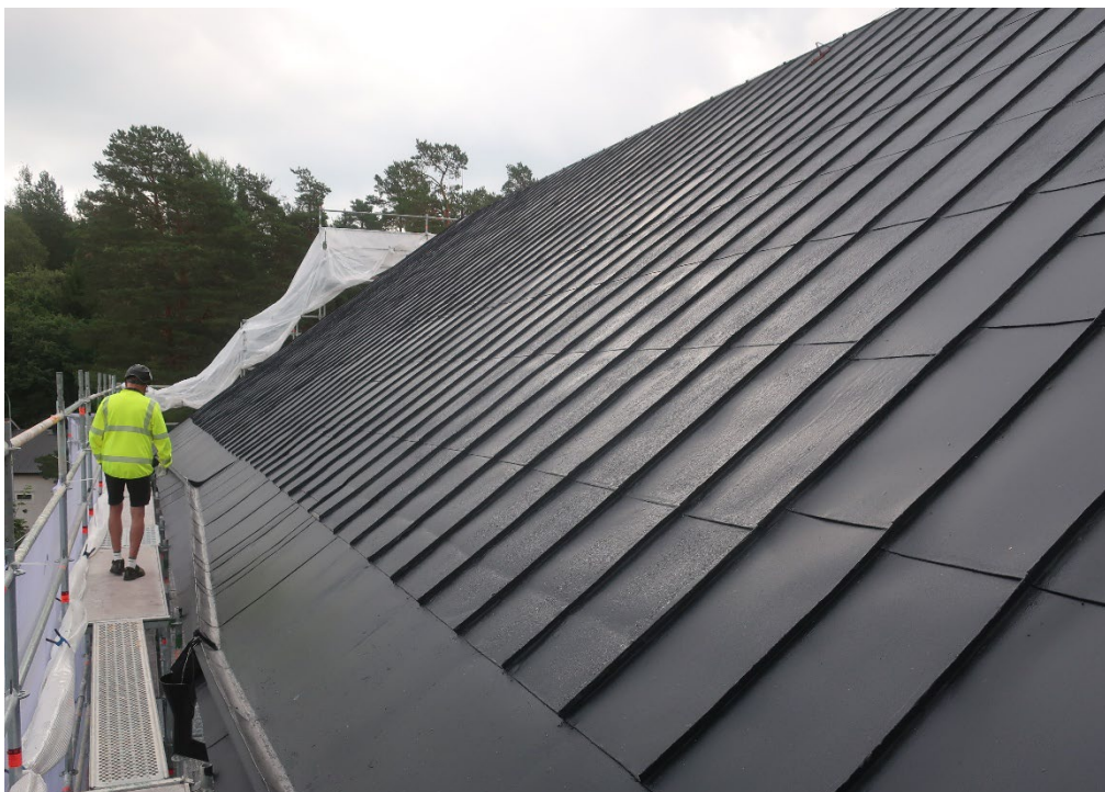
Figur 43. Kyrkans norra takfall från nordöst efter avslutad takrenovering. Foto: Daniel Olsson, 2022-08-17.
