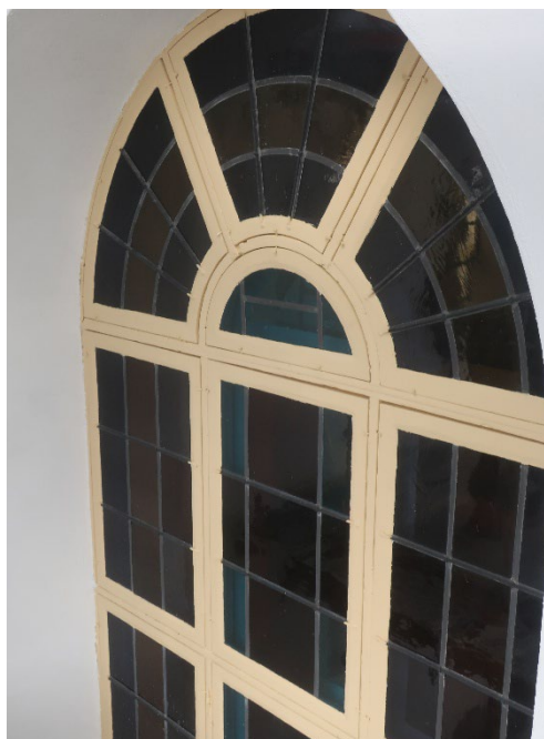
Figur 40. Detalj av nymålat fönster. Foto: Daniel Olsson, 2022-08-17.
