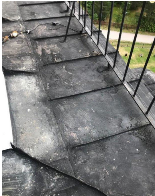
Figur 15. Detalj av balkonggolvet vid lanterninen. Foto från nordväst: Lennart Carlsson, 2021.
