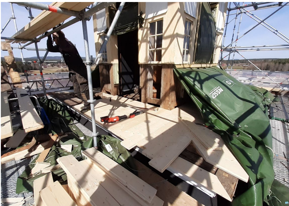
Figur 47. Lanterninen under pågående byte av brädor under balkongen. Foto: Daniel Olsson, 2023-05-10.
