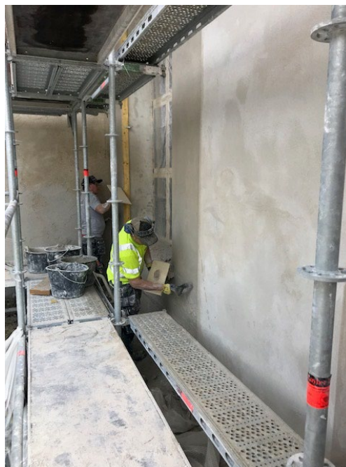
Figur 21. Putsning av sakristians södra fasad. Foto från sydöst: Lennart Carlsson, 2022-07-07.
