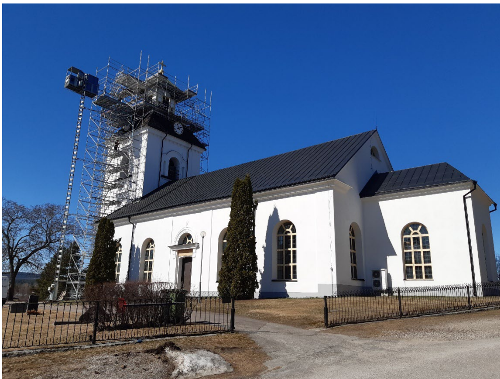
Figur 58. Ilsbo kyrka från sydöst under renoveringsetapp 2. Foto: Daniel Olsson, 2022-04-19.
