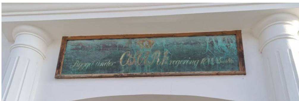
Figur 17. Inskriptionstavlan över kyrkans huvudentré med urlakad förgyllning. Texten lyder: Byggt under Oscar 1s regering 1844, 45 och 46. Foto: Lennart Carlsson, 2023-02-17.
