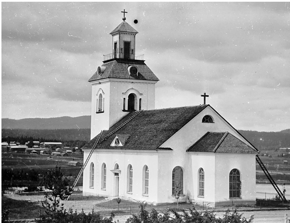
Figur 3. Ilsbo kyrka från sydöst innan takomläggningen 1902. På denna bild har kyrkan takspån på samtliga takytor. Foto: Okänd. Riksantikvarieämbetets bildarkiv. Public domain.
