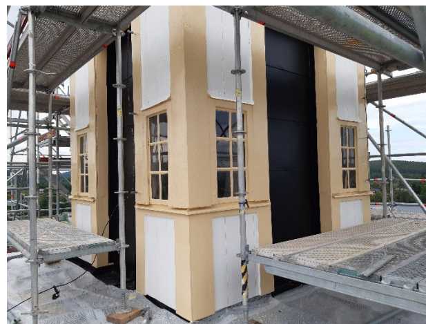
Figur 51. Lanterninens fasader efter målning. Foto: Daniel Olsson, 2023-06-28.
