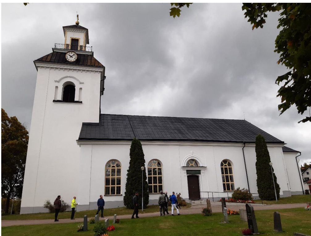
Figur 25. Kyrkan från söder efter avslutad fasadrenovering av långhuset och sakristian. Foto: Daniel Olsson, 2022-09-13.
