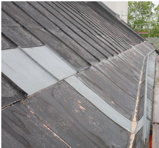
Figur 42. Detalj av ilagade plåtar på långhusets norra takfall innan målning av hela takytan. Foto från nordöst: Daniel Olsson, 2022-05-25.
