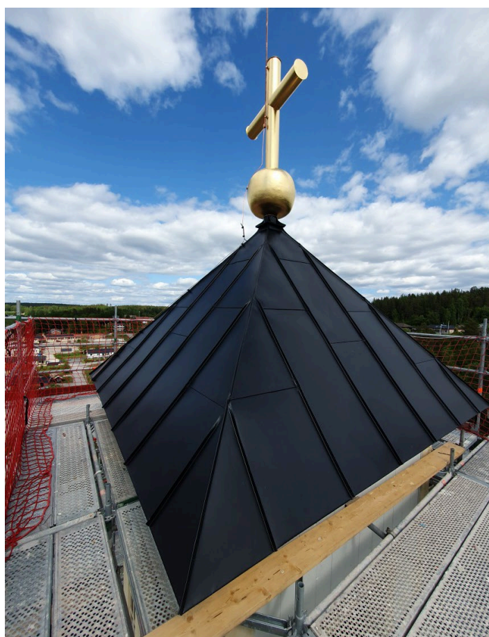
Figur 57. De förgyllda korset och klotet på plats på lanternintaket. Foto från sydväst: Lennart Carlsson, 2023-06-08.
