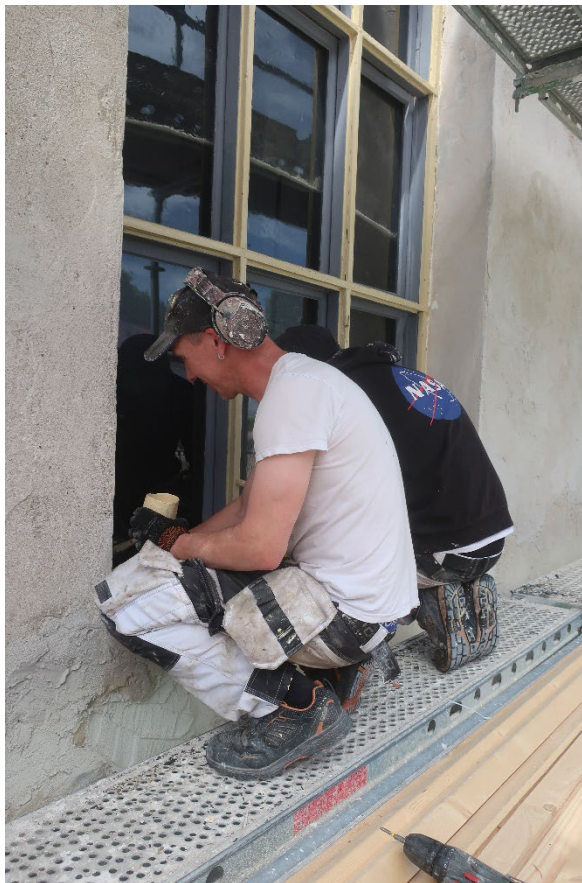
Figur 38. Målning av fönsterbåge. Foto: Daniel Olsson, 2022-06-23.
