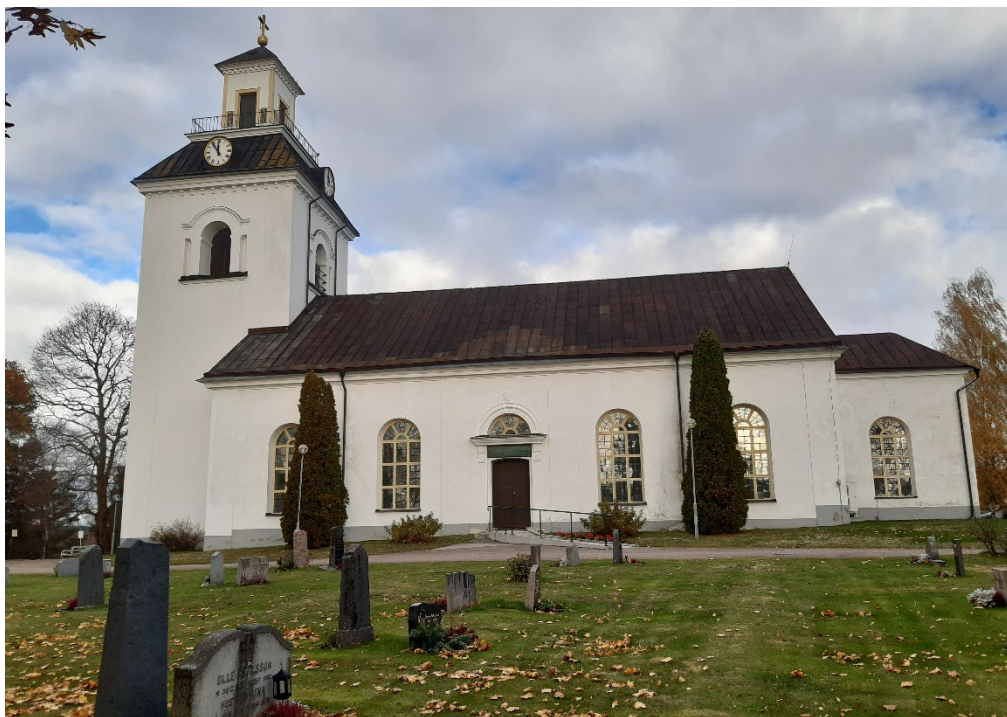
Figur 4. Ilsbo kyrka från söder innan renoeringen inleddes. Foto: Daniel Olsson, 2021-10-12.
