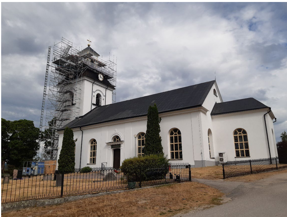
Figur 52. Kyrkan från sydöst efter avslutad takmålning av långhusets och sakristians tak. Foto: Daniel Olsson, 2023-06-28.
