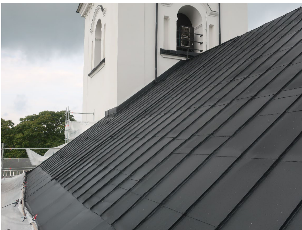
Figur 44. Kyrkans södra takfall från sydöst efter avslutad takrenovering. Foto: Daniel Olsson, 2022-08-17.
