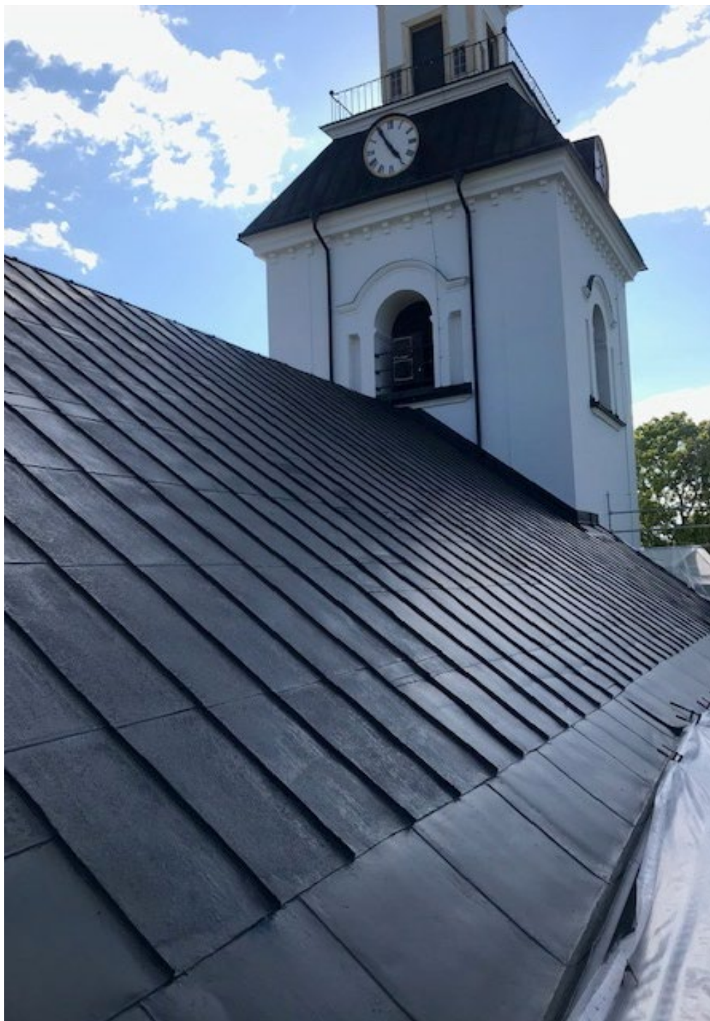
Figur 62. Kyrkans takfall mot norr efter renovering och målning. Foto: Lennart Carlsson, 2022-08-09.
