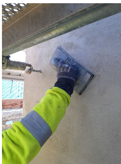
Figur 29. Ytputsens på kyrktornets norra fasad får rätt struktur. Foto från nordväst: Daniel Olsson, 2025-05-15.
