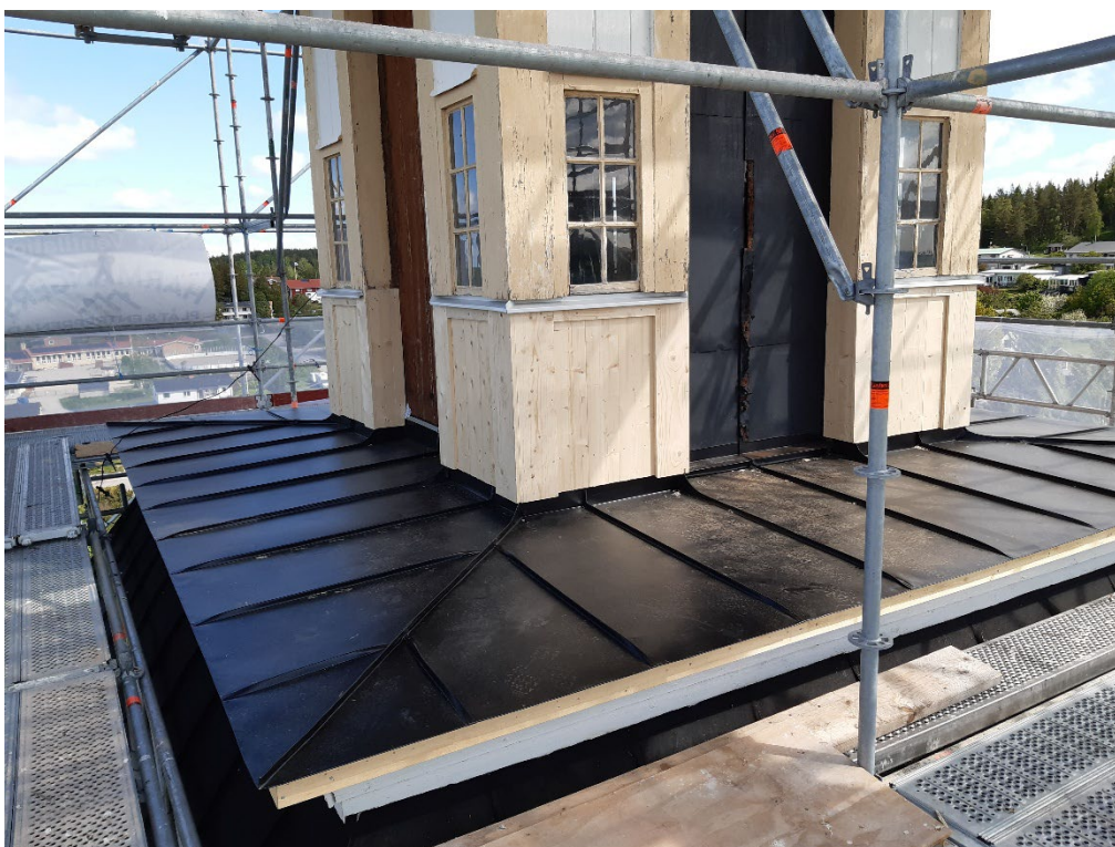
Figur 48. Lanterninen med nytt plåtklätt golv på balkongen. Foto: Daniel Olsson, 2023-06-01.
