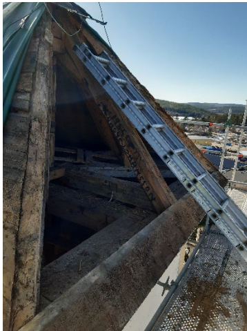
Figur 45. Detalj av lanternintaket mot norr efter borttagning av plåt och underlagstak. Foto: Daniel Olsson, 2023-04-19.
