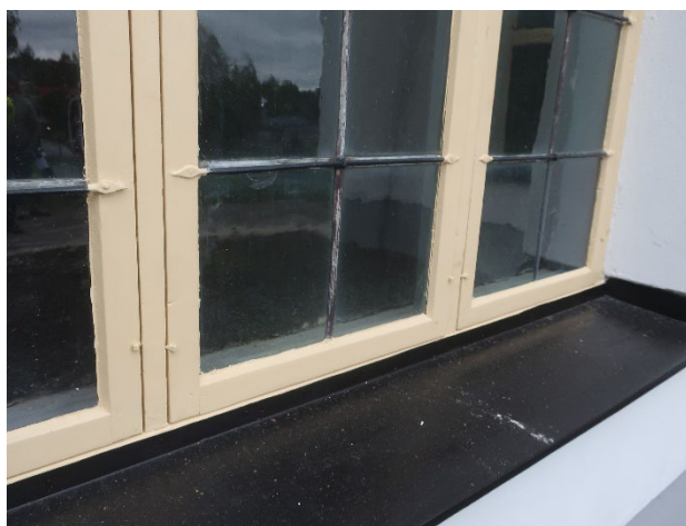
Figur 50. Detalj av nymålade fönsterbågar. Foto: Daniel Olsson, 2022-09-13.
