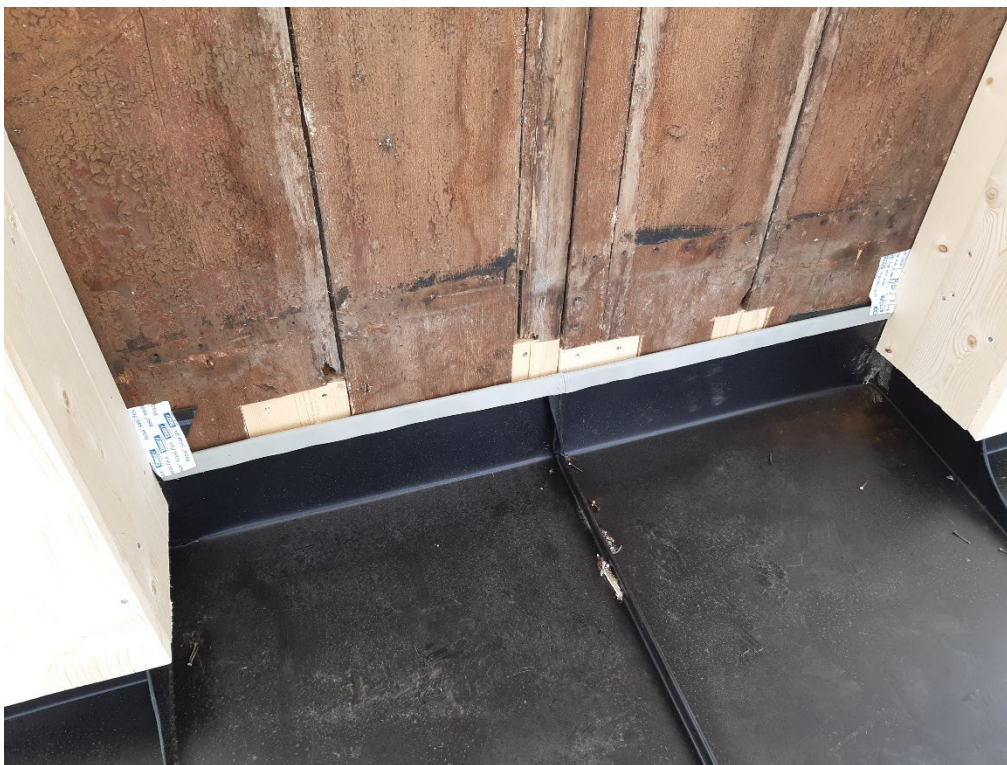
Figur 36. Detalj av lagning av två av lanterninens dörrblad nedtill. Foto: Daniel Olsson, 2023-06-01.
