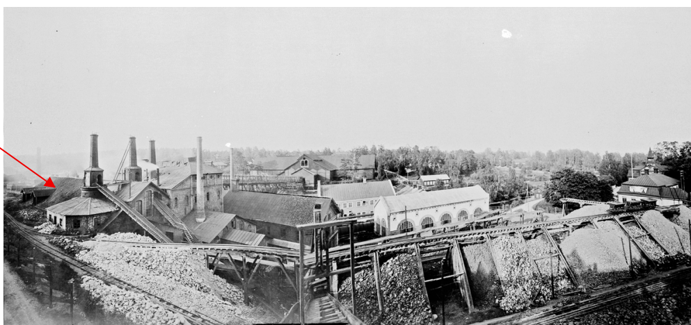
Figur 2. Iggesunds bruk i ett panoramamontage från 1935. Det gamla järnverkets södra takfall är markerat med en pil. Foto ur museets samlingar, identifikationsnummer: XLM.CL001077
