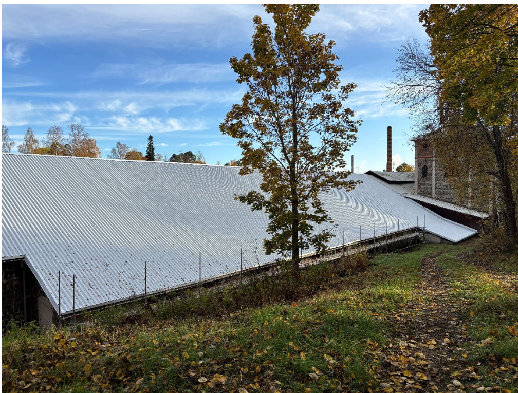
Figur 6. Efter avslutade arbeten. Det södra takfallet sett mot öster. Foto: Ulrika Olsson, 2025-10-10.
