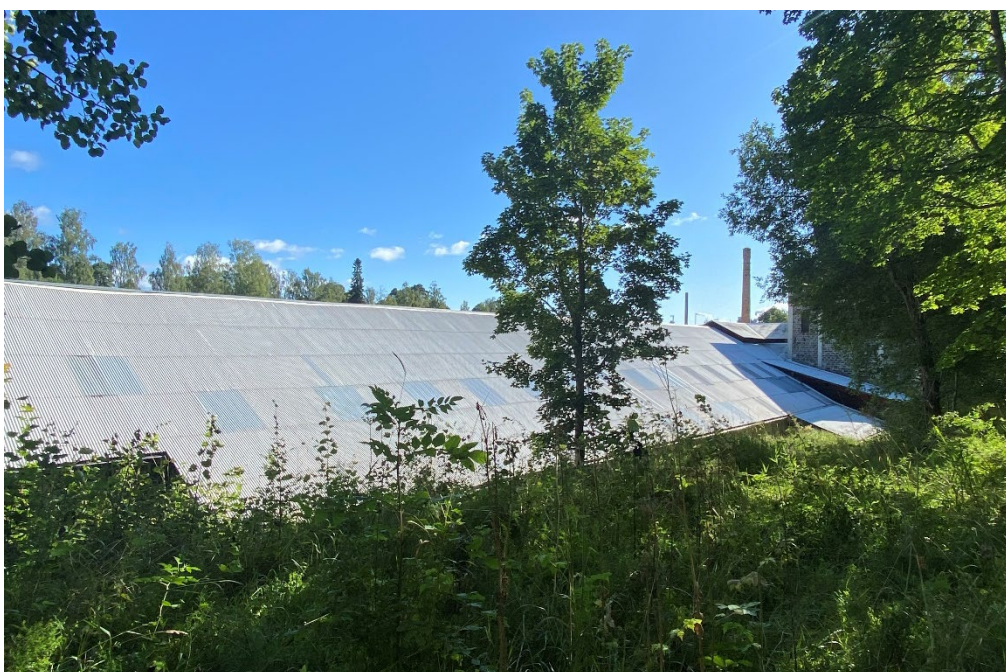
Figur 4. Det södra takfallet innan påbörjade arbeten. Plåten som hade lappats vid flera tillfällen bedömdes som uttjänt. Foto: Ulrika Olsson, 2025-08-12.
