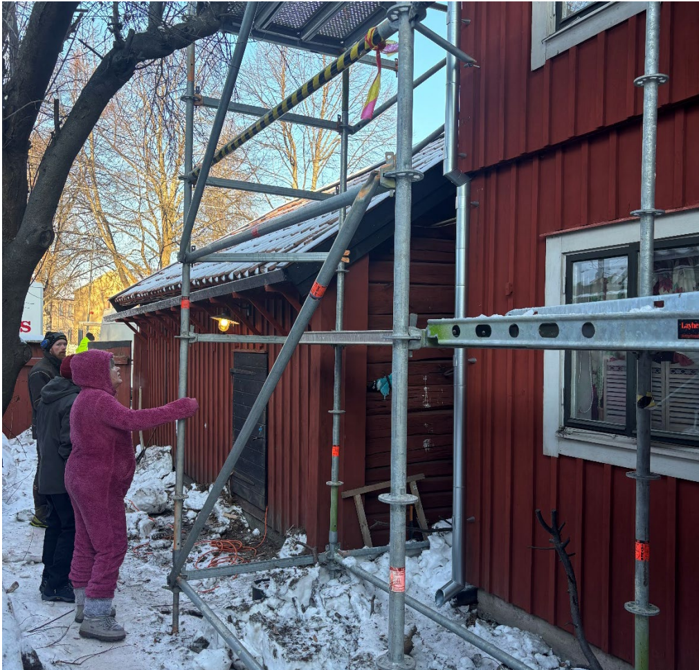
Figur 18. Efter avslutade arbeten. Till fiskeboden har tillverkats en hängränna i trä samt nya konsoler till rännan. Rännan är tjärstruken på verkstad och konsolerna är rödfärgade på verkstad. Foto: Ulrika Olsson, 2026-02-02.
