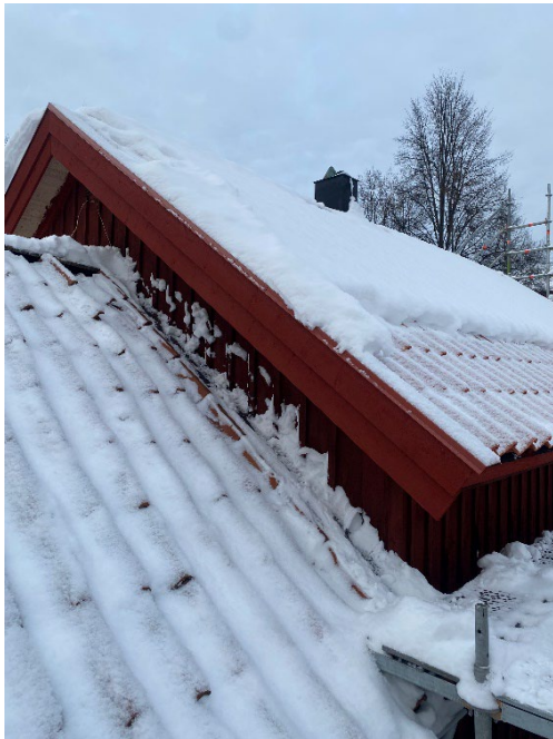
Figur 10 och figur 11. Till vänster visas gaveln på högdelen efter avslutade arbeten. På högdelen är vindskivorna rödfärgade och vindskivebeslagen är av röd plåt. Till höger syns bostadsdelens lågdelen efter avslutade arbeten. På lågdelen har takstegen återmonterats i samma läge som innan. Nockarna är täckta mednocktegel. Foto: Ulrika Olsson, 2026-01-13 och 2026-02-02.
