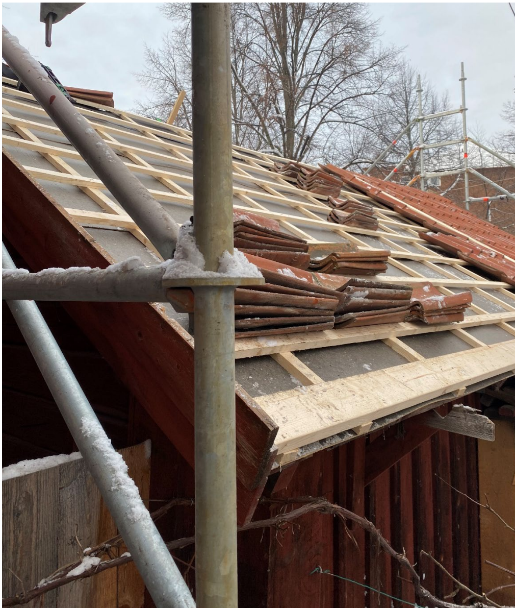
Figur 16. Fiskebodens östra takfall under pågående arbeten. Foto: Ulrika Olsson, 2026-01-13.
