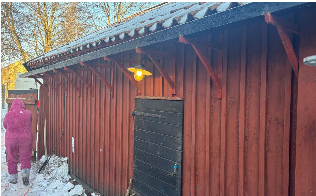
Figur 19. Efter avslutade arbeten. Till fiskeboden har tillverkats en hängränna i trä samt nya konsoler till rännan. Rännan är tjärstruken på verkstad och konsolerna är rödfärgade på verkstad. Foto: Ulrika Olsson, 2026-02-02.
