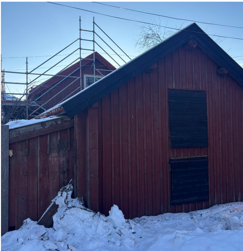
Figur 17. Fiskebordens norra gavel efter avslutade arbeten. Nya vindskivor och vattbrädor är tillverkade i trä som har tjärstrukits på verkstad innan montering. Foto: Ulrika Olsson, 2026-02-02.
