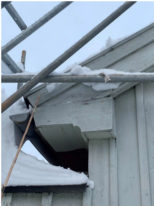
Figur 12 och figur 13. Till vänster visas vindskivan mot gatan innan påbörjade arbeten. Till höger visas det färdiga utförandet. Vid slutbesiktningen saknades fortfarande vindskivebeslag i galvaniserad plåt. Foto: Ulrika Olsson, 2026-01-13 och 2026-02-02.
