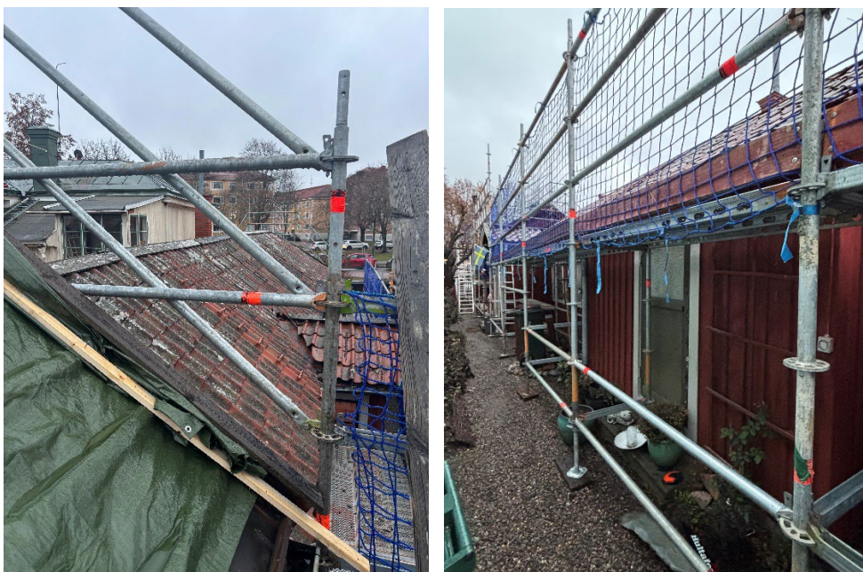
Figur 4 och figur 5. Bostadsdelens lågdel innan påbörjade arbeten. Foto: Ulrika Olsson,
