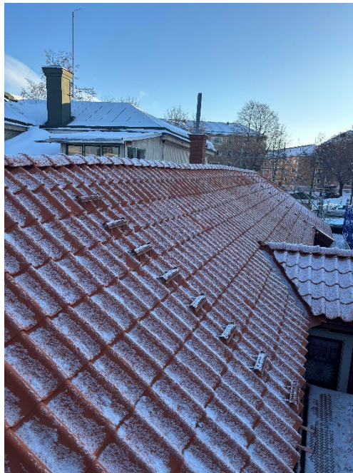
Figur 10 och figur 11. Till vänster visas gaveln på högdelen efter avslutade arbeten. På högdelen är vindskivorna rödfärgade och vindskivebeslagen är av röd plåt. Till höger syns bostadsdelens lågdelen efter avslutade arbeten. På lågdelen har takstegen återmonterats i samma läge som innan. Nockarna är täckta mednocktegel. Foto: Ulrika Olsson, 2026-01-13 och 2026-02-02.
