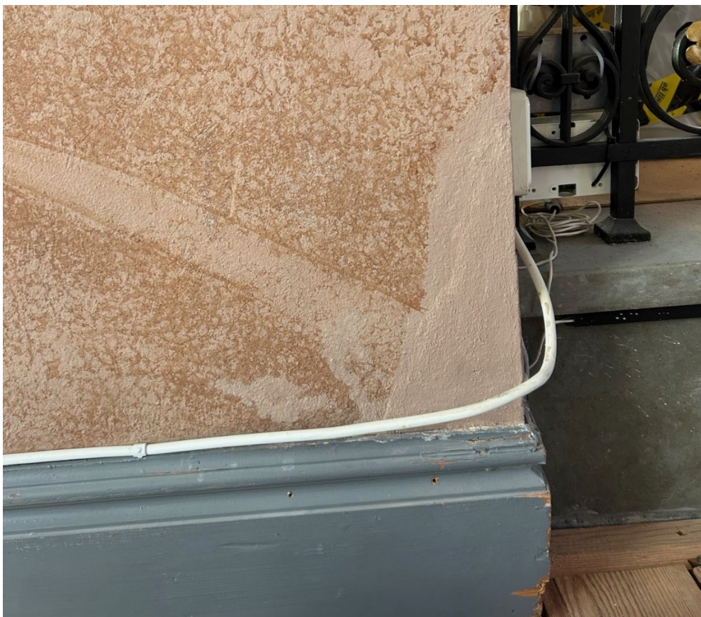
Figur 32. Under pågående arbeten. Ett urslag i en av pilastrarna i anslutning till koret är lagat. Foto: Gästrike Färgverkstad, vintern 2025.
