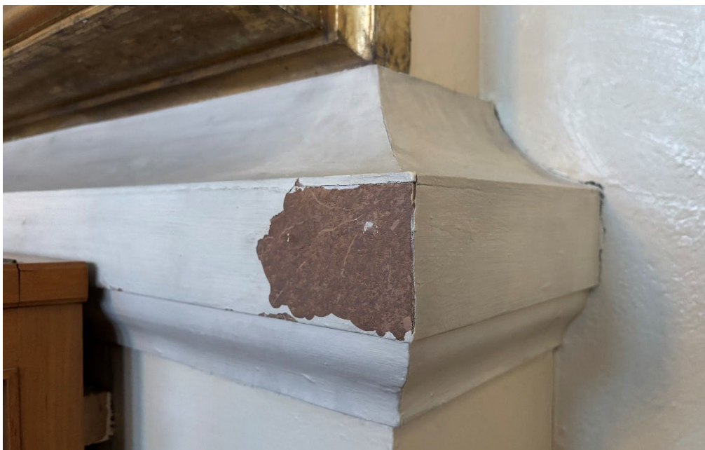
Figur 37. Kvarstående arbete. Listen under altartavlan på den östra långbusväggen har underliggande marmoreringsmålveri i samma stil som pilastrarnas marmorering. Marmoreringen ska tas fram och eventuella skador ska retuscheras. Foto: Ulrika Olsson, 2026-02-11.
