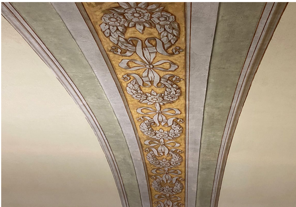
Figur 25. Rengjord yta i dekormåleriet i långhusets valv. De ljusa guldfärgade fälten är nymålade. Foto: Ulrika Olsson, 2025-03-27.
