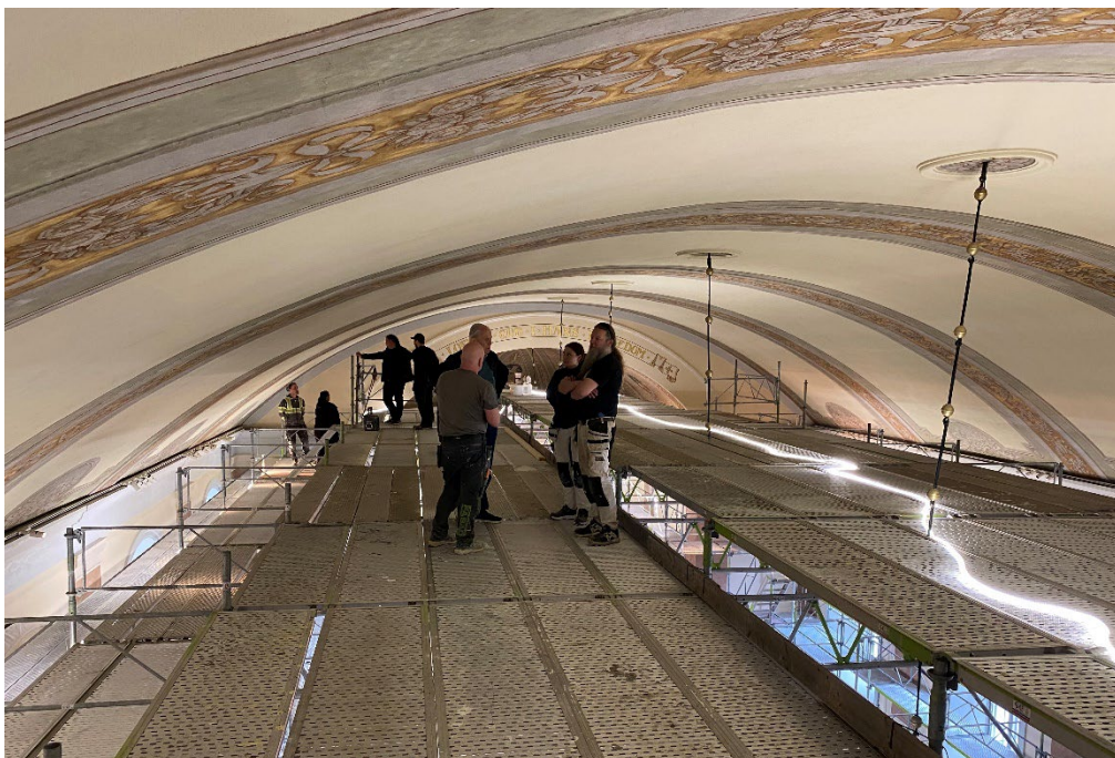
Figur 24. Vid slutbesiktningen av långhusets tak var arbetena i stort sett färdiga, dock återstod några delar i retuschering av lagningar. Foto: Ulrika Olsson, 2025-03-27.
