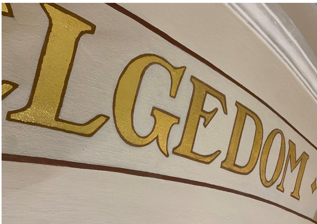
Figur 27. Del av inskriptionen efter avslutade arbeten. Ytan, inklusive de förgyllda bokstäverna ...GUD I HANS HELG... är återskapade med de gamla ytorna som förlaga. Foto: Ulrika Olsson, 2025-03-27.
