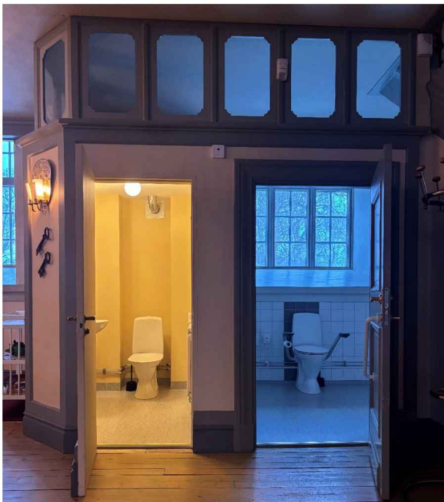
Figur 20. I det västra rummet under läktaren har det tidigare förberedelserummet byggts om till en RWC. Den tidigare dörren från utrymmet in till den intilliggande toaletten har satts igen. En ny dörr har tagits upp till toaletten till vänster om dörren in till RWC:n. Foto: Ulrika Olsson, 2026-02-11.
