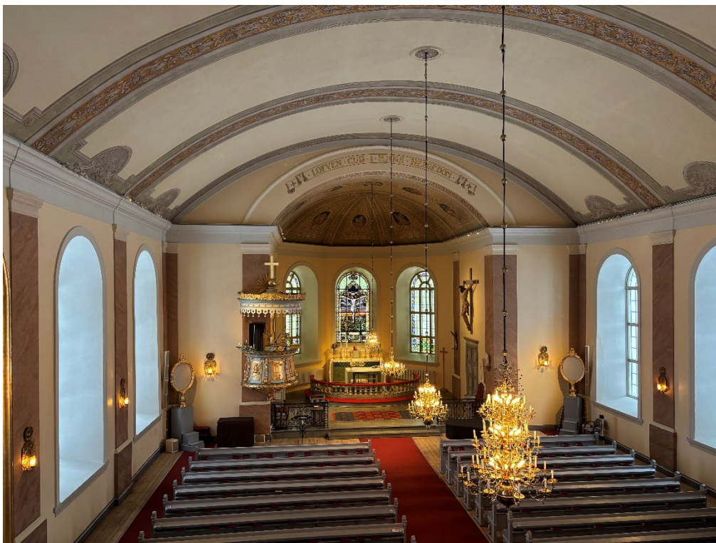
Figur 31. Kyrkorummet sett mot koret efter avslutade arbeten. De ljusa gula fälten i såväl väggar som valv är ommålade inom detta projekt. Foto: Ulrika Olsson, 2026-02-11.
