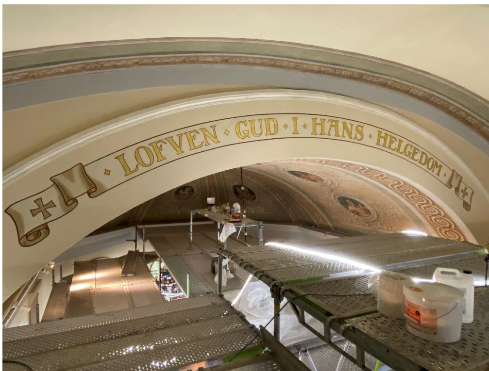
Figur 28. Den horisontella sprickan som löpte genom delar av inskriptionen är lagad. Ytorna har målats in likt omkringliggande ytor. Bokstäver i inskriptionen som är helt nya och förgyllda är ... GUD I HANS HELG... Vid slutbesiktningen kvarstod ännu inmålning av den vita listan över inskriptionen. Foto: Ulrika Olsson, 2025-03-27.
