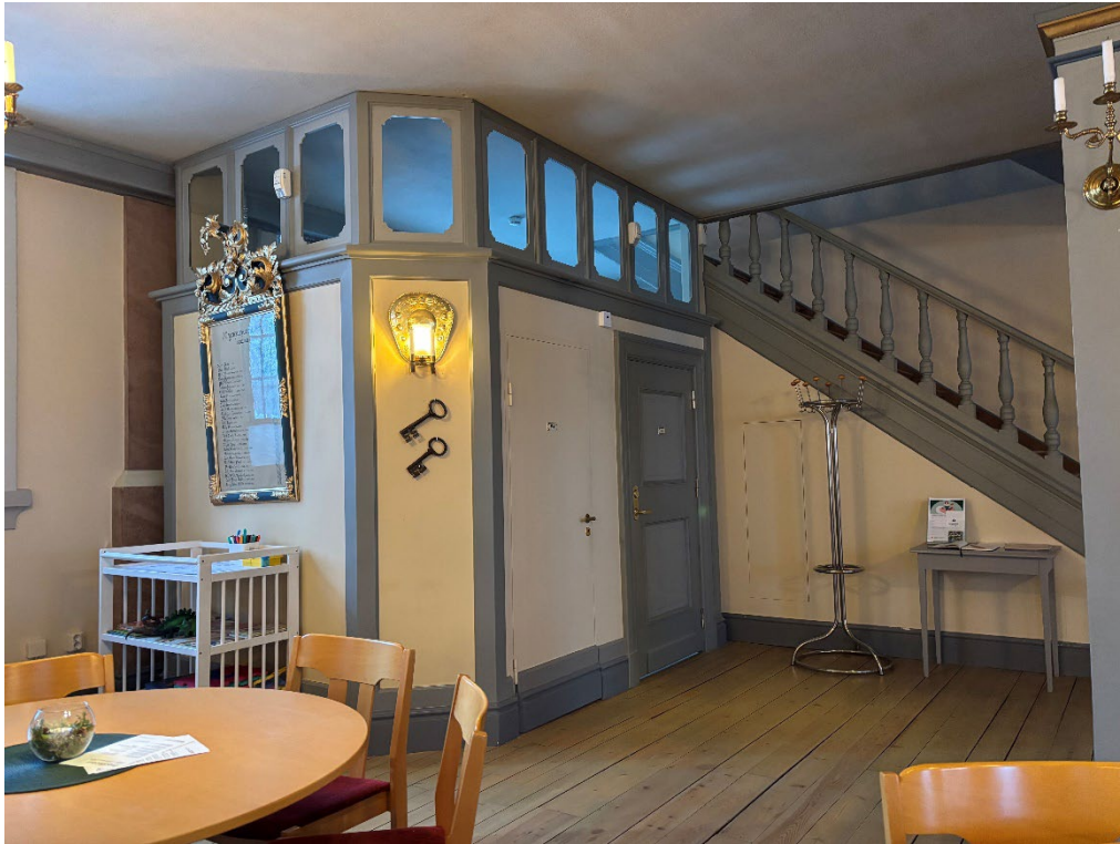
Figur 21. Den nya dörren in till toaletten är utformad som en blinddörr. Det samma gäller för den nya dörren in till förrådet under trappan. Båda dörrarna är inmålade likt omkringliggande ytor och smälter in i ytorna. Foto: Ulrika Olsson, 2026-02-11.
