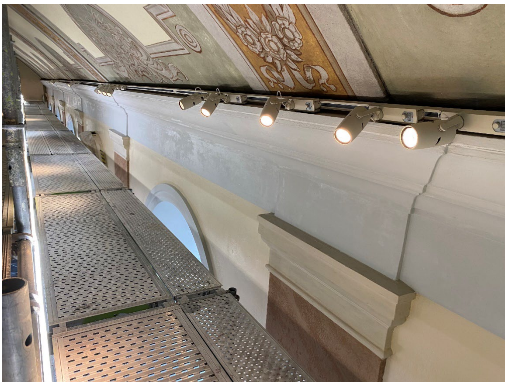
Figur 26. Efter avslutade arbeten. Taklisten i kyrkorummet har målats om. Foto: Ulrika Olsson, 2025-03-27.
