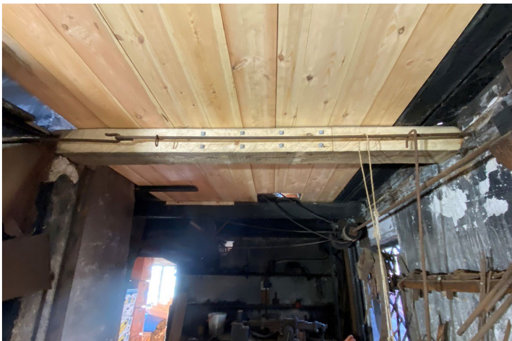
Figur 19. Under pågående arbeten. Från smedjan syns den bytta bjälken. Foto: Ulrika Olsson, 2024-11-12.
