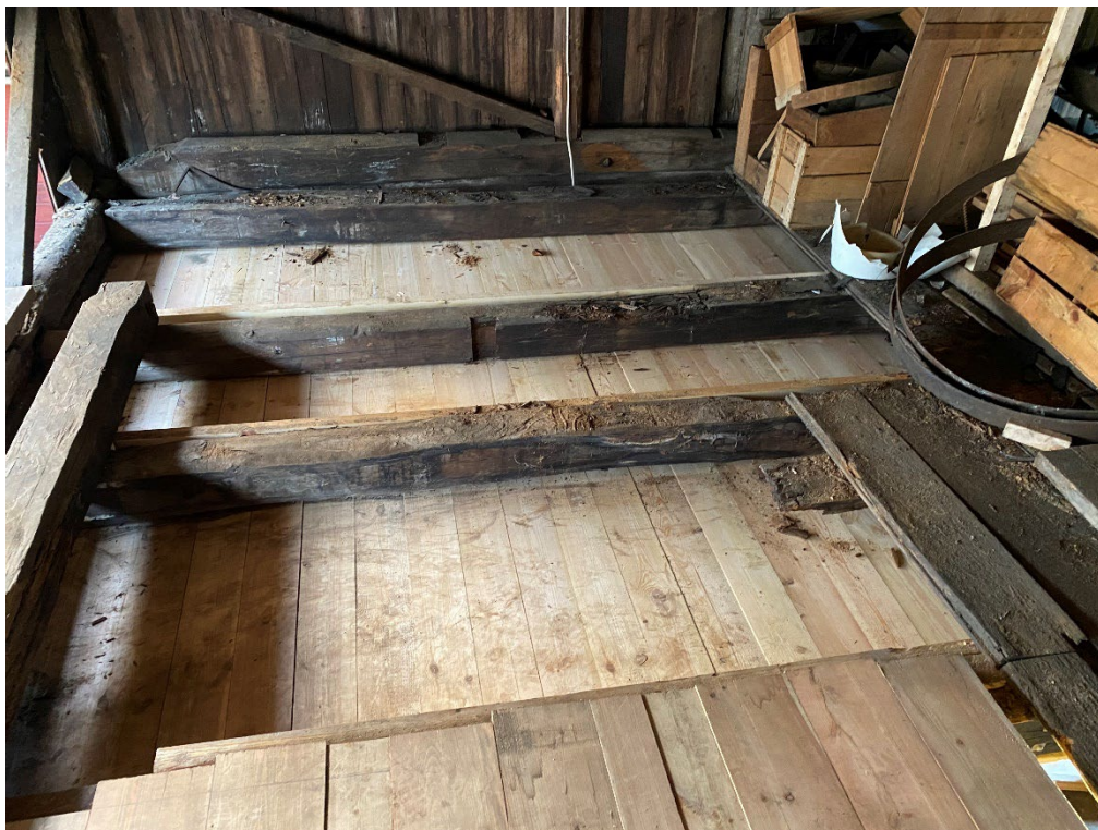
Figur 18. Under pågående arbeten med bjälklaget ovanför smedjan. Två bjälkar har förstärkts och den närmaste, som döljs under brädgolvet kant, har lagats i med nytt virke. Foto: Ulrika Olsson, 2024-11-12.
