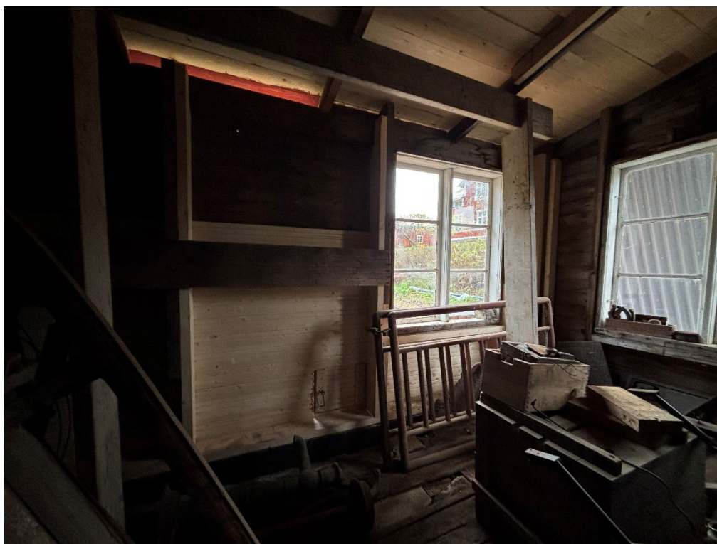
Figur 25. Inifrån skostallet syns de två nya reglarna och den nya panelen. Foto: Ulrika Olsson, 2025-10-28.
