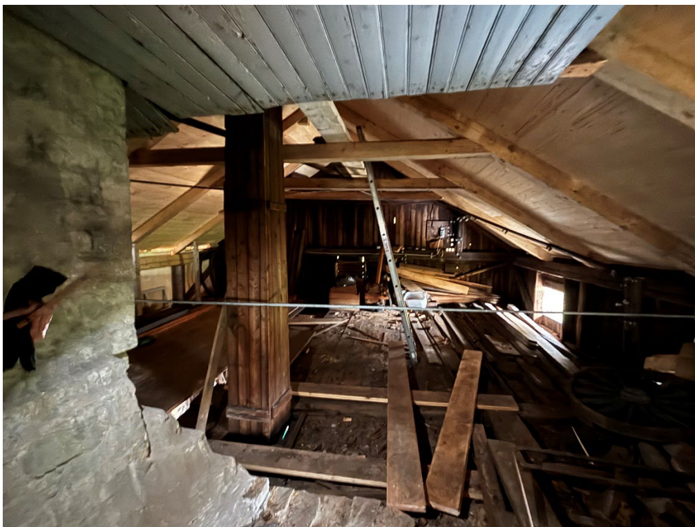
Figur 9. De flesta takbjälkar är bytta. Råsponten är bytt. Foto mot norr. Längst bort till vänster syns de lagade delarna i den västra väggen. Foto: Ulrika Olsson, 2025-10-28.
