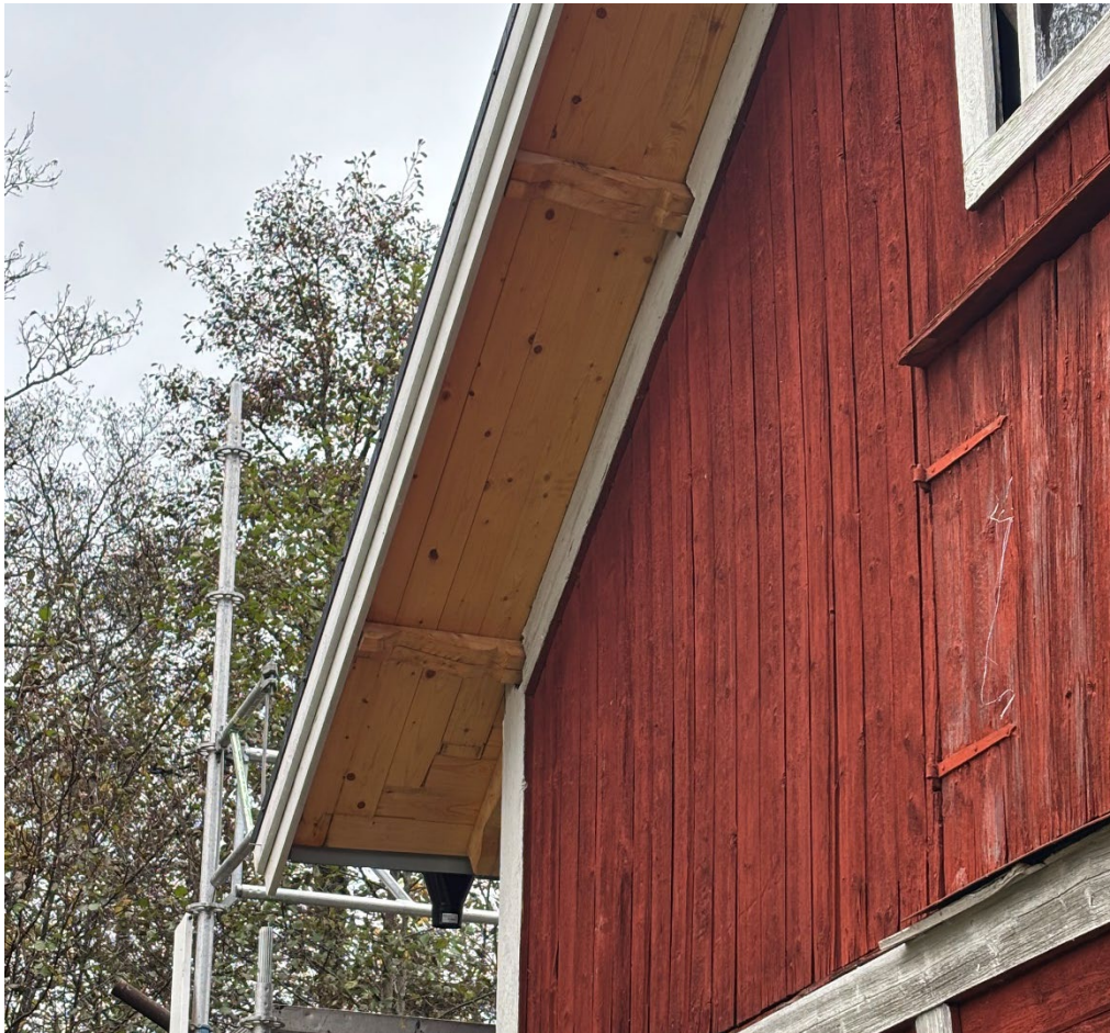
Figur 11. Några taktassar har nytillverkats med de gamla som förlaga. Vid slutbesiktningen 2025-10-28 kvarstod ännu inmålning av det nya virket. Foto: Ulrika Olsson, 2025-10-28.
