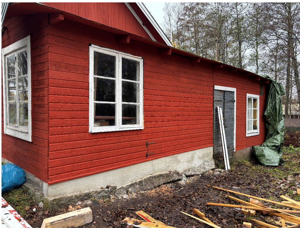
Figur 24. En ny betongsula har gjutits efter tillbyggnadens långsida, från det västra hörnet och fram till dörren. Notera att den lilla luckan snett nedanför fönstret, har återskapats i den nya panelen. Foto: Ulrika Olsson, 2025-10-28.
