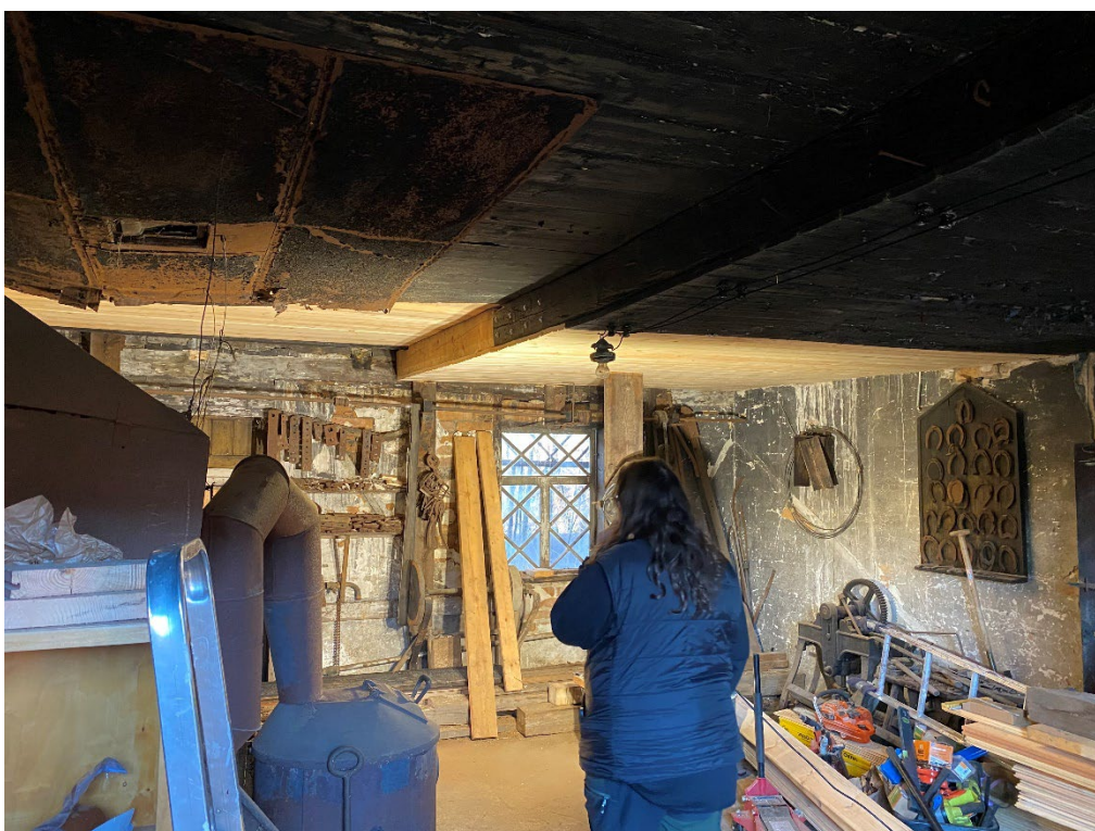
Figur 20. Under pågående arbeten. Från smedjan syns de ilagade bjälkarna och delar av den nya takpanelen. Foto: Ulrika Olsson, 2024-11-12.
