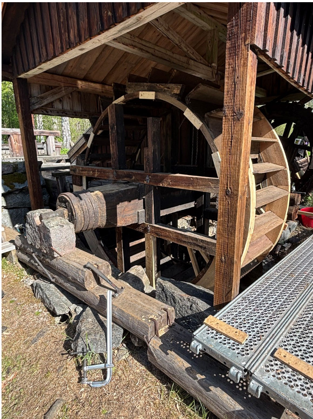
Figur 7. Under pågående träarbeten på vattenhjulet. Foto: Ulrika Olsson, 2025-05-15.
