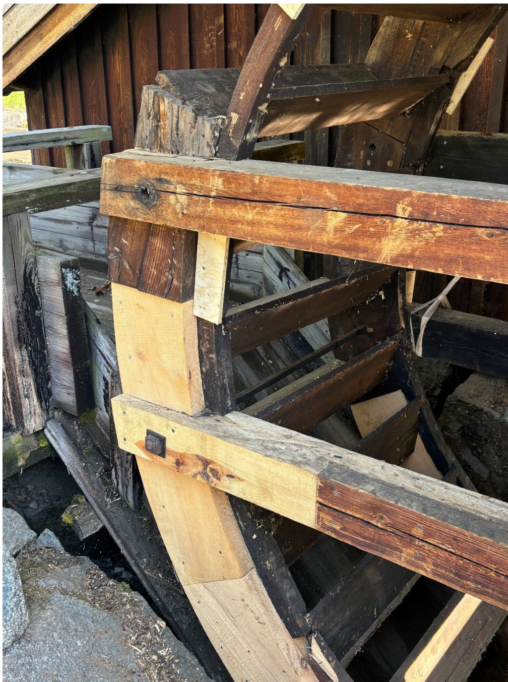
Figur 8. Under pågående arbeten med vattenhjulet. Närbild på lagad eker och lagad del i löten/hjulringen. Foto: Ulrika Olsson, 2025-05-15.
