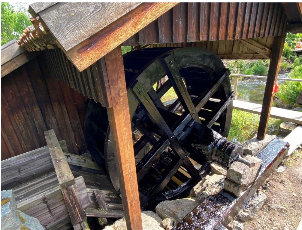
Figur 10. Det färdigrenoverade och justerade vattenhjulet, inklusive de nya stödpallarna. Allt trävirke inklusive smidesdelar har behandlats med varm trätjära. Foto: Ulrika Olsson, 2025-06-10.
