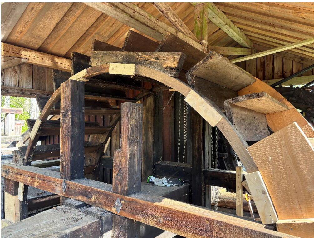
Figur 6. Under pågående arbeten med vattenhjulet. Foto: Ulrika Olsson, 2025-05-15.
