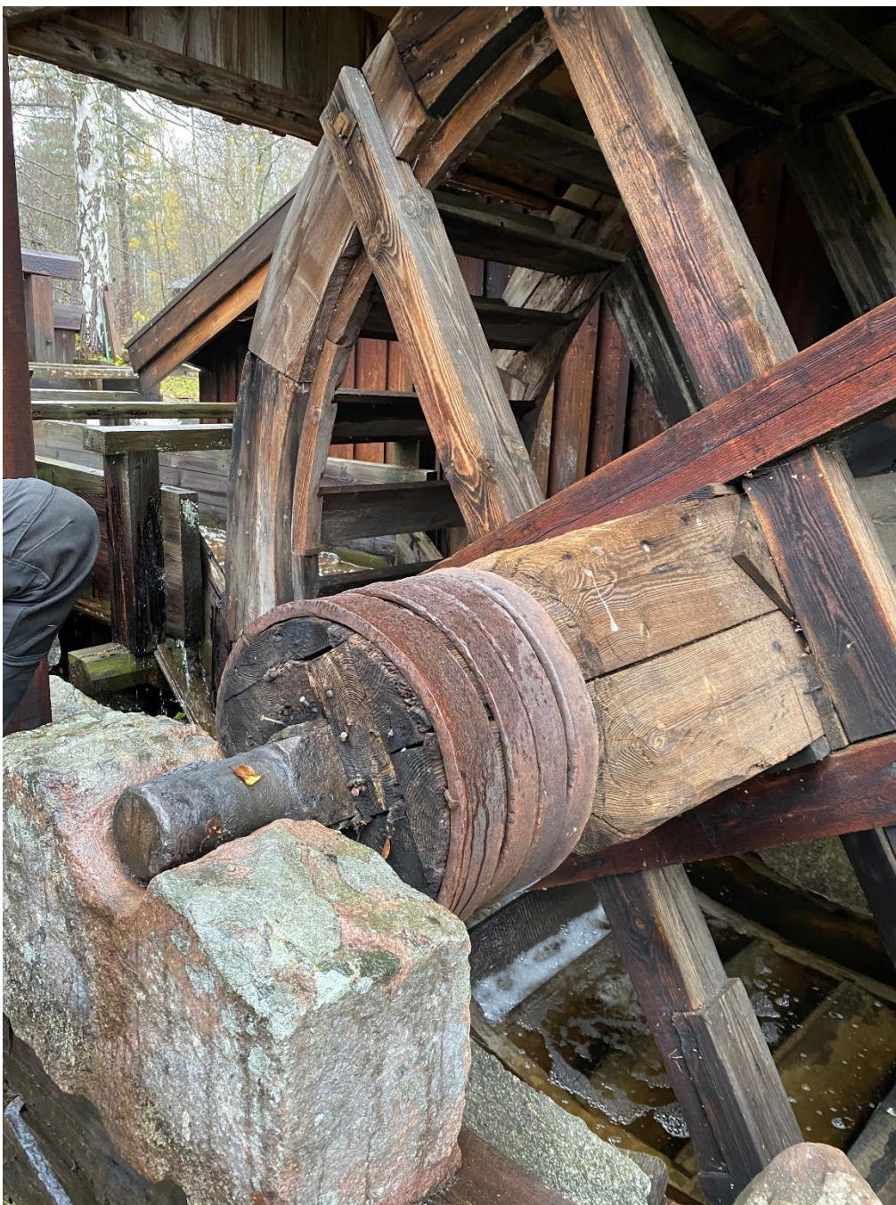
Figur 4. Inledningsvis befarades skador i hjulstocken och stödaxeln. Foto: Ulrika Olsson, 2023-11-08.
