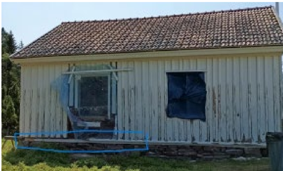
Figur 8. Under pågående arbeten. Den rötskadade panelen under det östra fönstret på den norra fasaden är borttagen och lagningen av den markerade offerbrädan har påbörjats. Foto: Kossan och Kalven Bygg AB, juni 2025.
