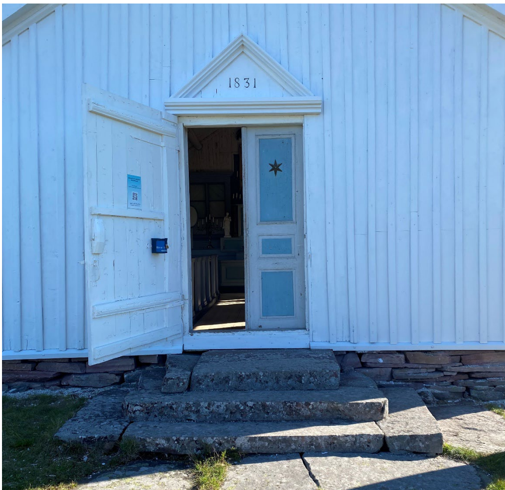
Figur 17. Efter avslutade arbeten. Den över dörren liggande listen har bytts ut till en ny list inom detta projekt. Jämför med figur 5. Foto: Ulrika Olsson, 2025-09-22.
