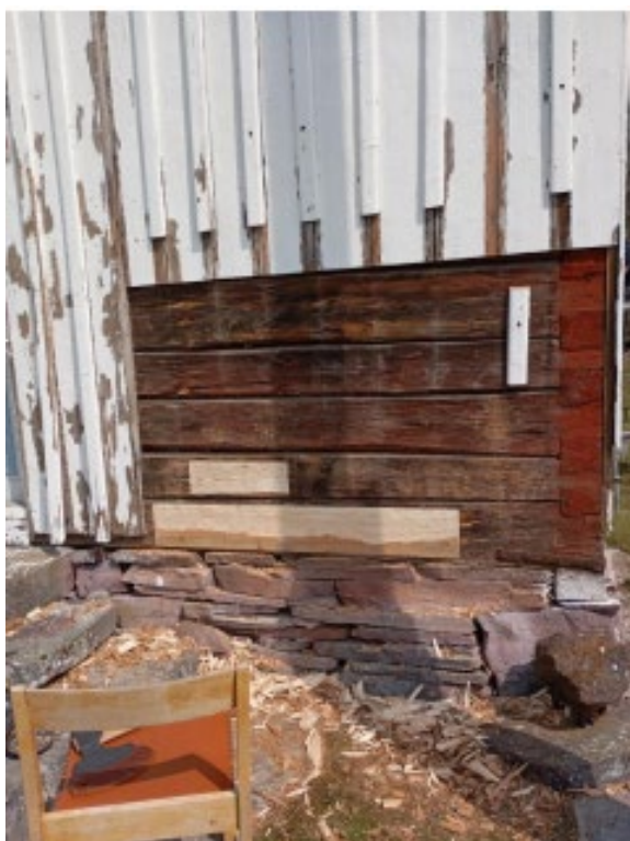
Figur 9. Under pågående arbeten. Rötskadad panel på entrégaveln är bortriven och rötskadade delar i timmerstommen har lagats i. Nästa moment som väntar är montering av den nya locklistpanelen.
