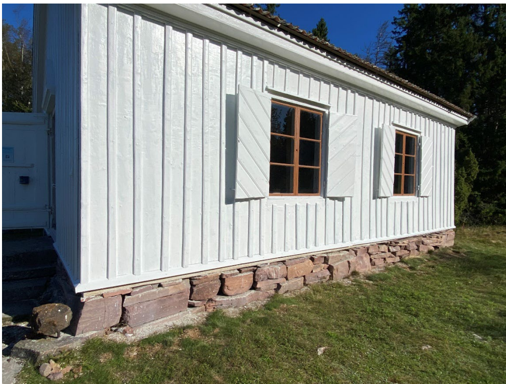
Figur 15. Efter avslutade arbeten. Alla trätytor, inklusive fönsterbågarna, har renoverats inom detta projekt. Foto: Ulrika Olsson, 2025-09-22.
