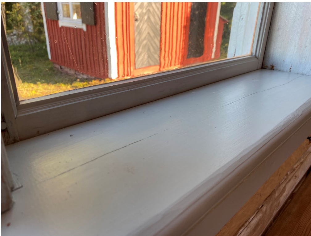
Figur 12. Efter avslutade arbeten. Fönsterbrädan i det östra fönstret på den norra sidan är nytillverkad, liksom bågbottnestyckena och delar av mittposten i denna fönsterenhet. Foto: Ulrika Olsson, 2025-09-22.
