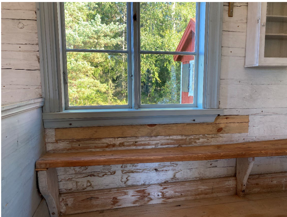
Figur 10. Efter avslutade arbeten. Den rötskadade delen i stocken under det östra fönstret mot norr, har lagats i med nytt virke och fönsterbrädan är nytillverkad. Den profilerade listen under fönsterbrädan är återanvänd. Målning av timret kvarstår. Foto: Ulrika Olsson, 2025-09-22.
