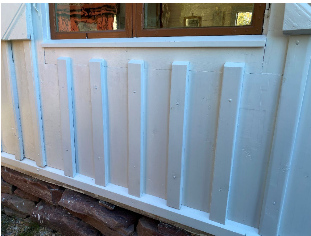
Figur 13. Efter avslutade arbeten. Ny panel, vattbräda och offerbräda under det östra fönstret på den norra fasaden. Foto: Ulrika Olsson, 2025-09-22.
