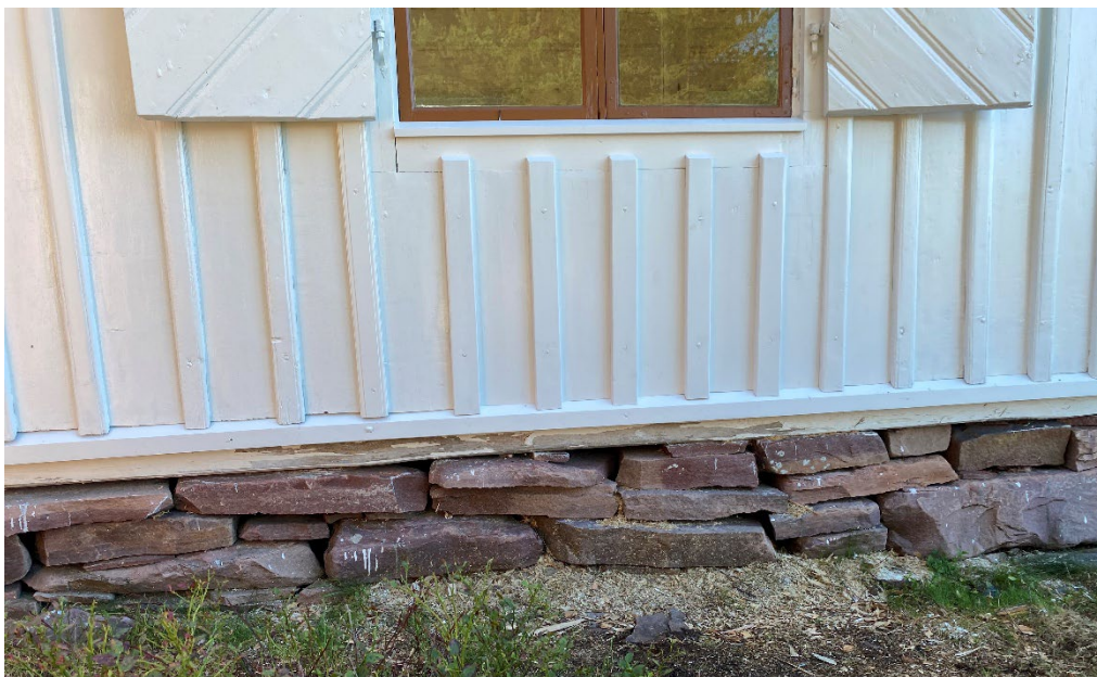
Figur 19. Efter avslutade arbeten. Där syllen syns bör den målas in i vitt, likt övriga fasadytor. Foto: Ulrika Olsson, 2025-09-22.
