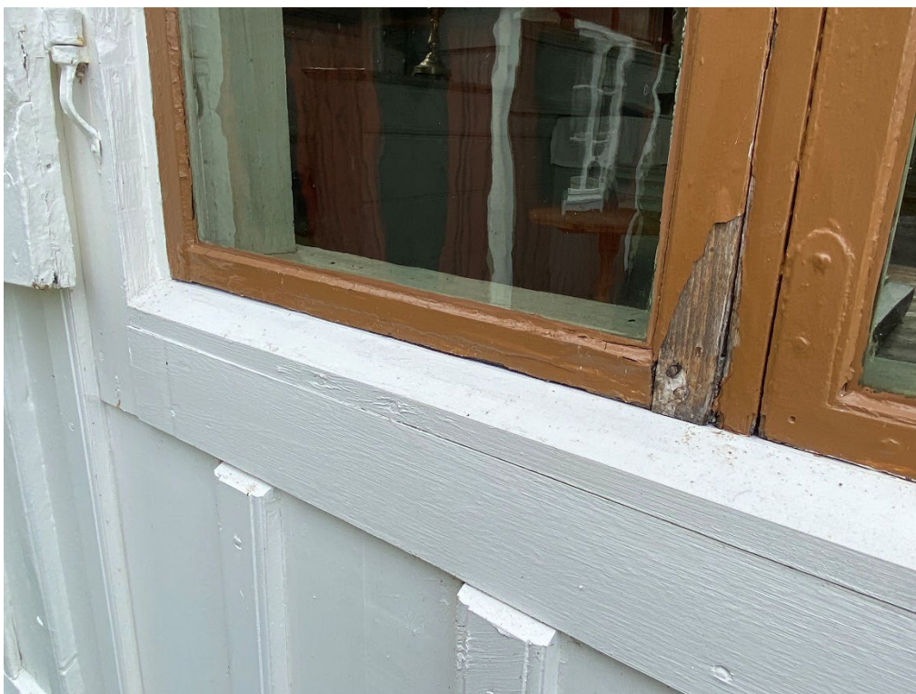
Figur 4. Innan påbörjade arbeten. Omfattningen kring det östra fönstret på den norra långsidan tycktes vara tillkommet i sen tid. Det var innanför detta fönster som det fanns svampangrepp. Foto: Ulrika Olsson, 2024-07-05.
