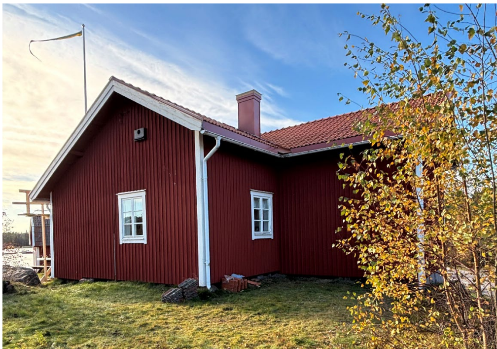
Figur 11. Skärså samlingslokal sedd från nordöst vid slutbesiktningen. Foto: Ulrika Olsson, 2025-10-16.
