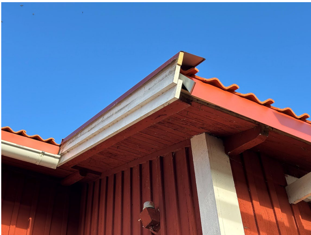
Figur 13. Skärså samlingslokal vid slutbesiktningen. På det södra takfallet har vindskivorna varit nödvändiga att höja lite eftersom en puckel på takfallet har rätats ut genom shimsning. De nya trädelarna ska målas vita så snart vädret tillåter. Notera den nytillkomna fotbrädan i plåt till höger. Foto: Ulrika Olsson, 2025-10-16
