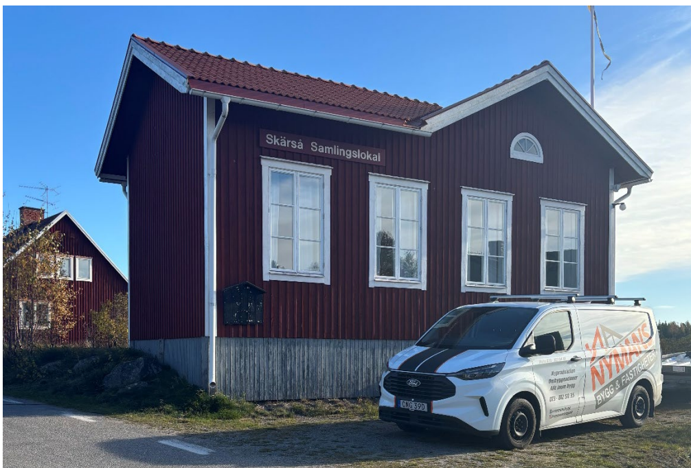
Figur 1. Skärså samlingslokal sedd från väster efter avslutade arbeten. Foto: Ulrika Olsson, 2025-10-16.
