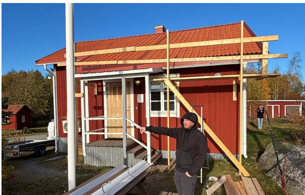
Figur 12. Skärså samlingslokal sedd från söder vid slutbesiktningen. Montering av plåtar kring entrépartiet pågick och skulle färdigställas senare samma dag. Foto: Ulrika Olsson, 2025-10-16.
