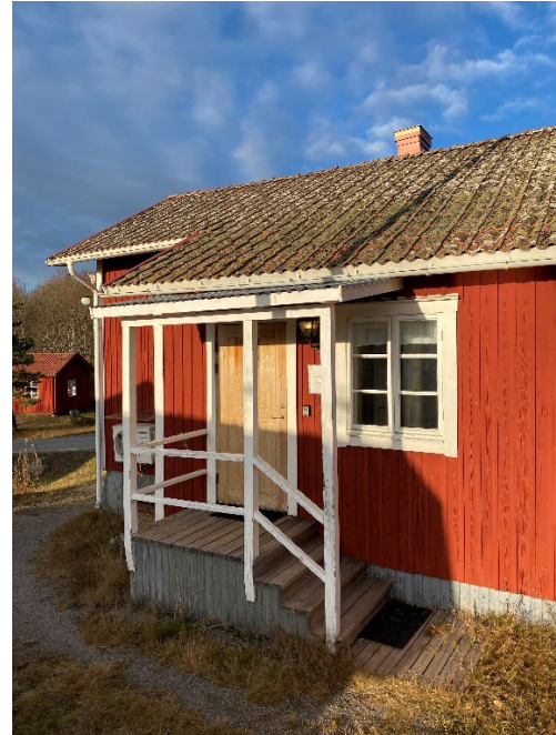
Figur 6 och figur 7. Samlingslokalen i Skärså innan påbörjade arbeten. Till vänster sedd från väster och till höger sedd från söder. Takets lertegel och underliggande läkt var uttjänt. Foto: Ulrika Olsson, 2025-08-27 och 2024-11-18.
