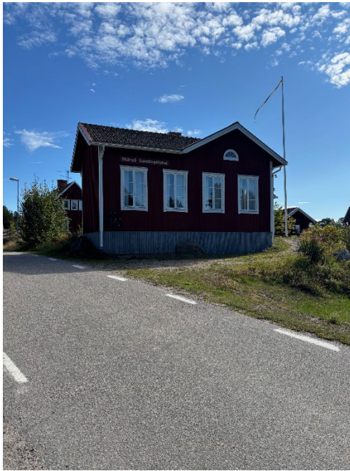
Figur 6 och figur 7. Samlingslokalen i Skärså innan påbörjade arbeten. Till vänster sedd från väster och till höger sedd från söder. Takets lertegel och underliggande läkt var uttjänt. Foto: Ulrika Olsson, 2025-08-27 och 2024-11-18.
