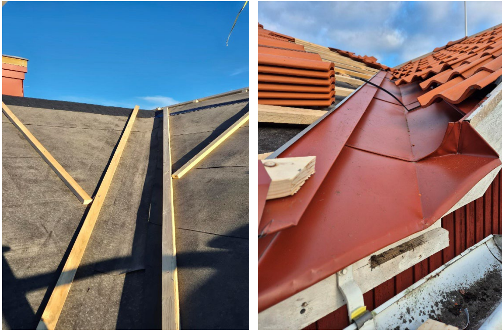
Figur 8 och figur 9. Under pågående arbeten. Ny papp har lagts på oljehärdad board. På denna ligger läkten på vilken det nya tvåkupiga lerteglet har monterats. Ränndalarna är nytillverkade i röd plåt. Foto: Michael Wernerson, K-Bygg, 2025-09-22 och 2025-10-03.
